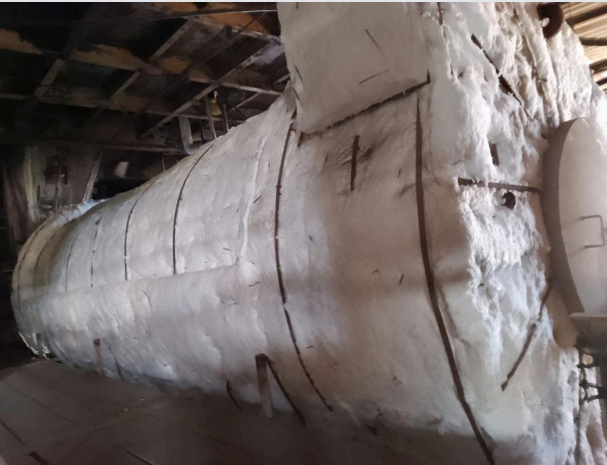
Finalização da proteção mecânica do isolamento do tubulão
