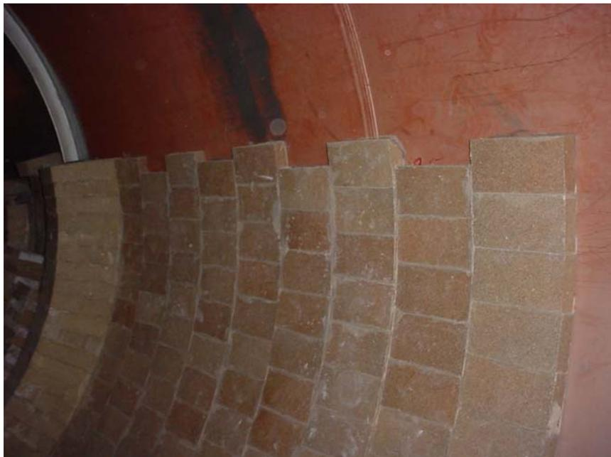
Na montagem deste trecho devido a irregularidades na carcaça metálica (deformações, parafusos inox salientes e cordões de solda acentuados tanto circunferencial quanto longitudinalmente), os tijolos refratários apresentaram ressaltos acima de 4,5 mm.
