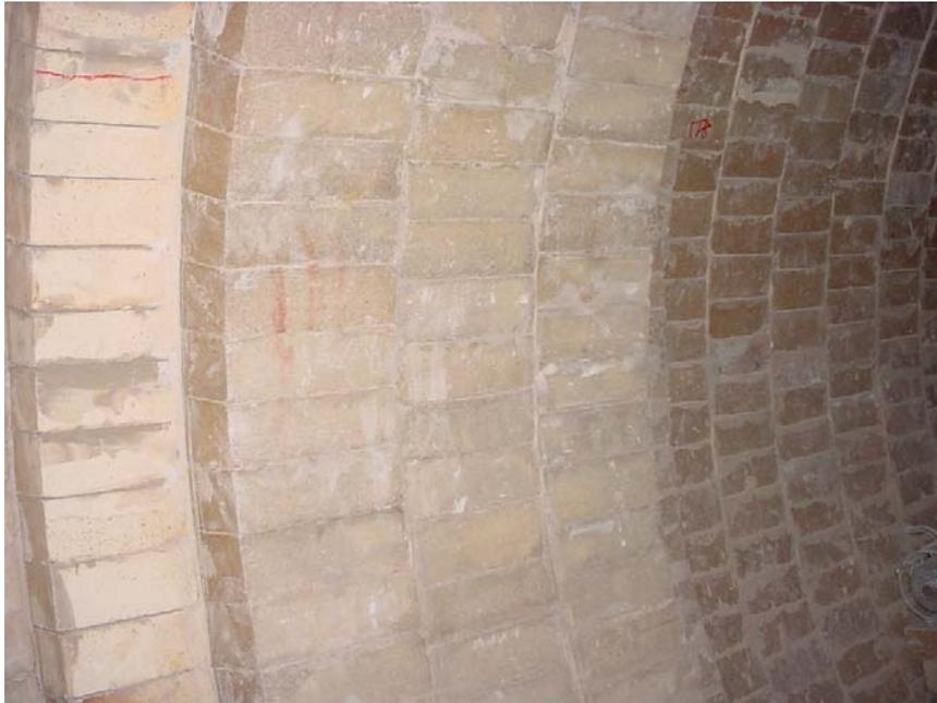
Com a conclusão da montagem dos tijolos na zona de queima, foi iniciada uma nova marcação e montagem dos tijolos antiácidos na zona de calcinação, sendo uma fiada de plaquetas e outra de tijolos antiácidos.
