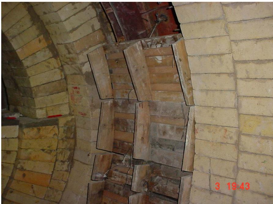
Posteriormente foi feita a acidificação de todas as juntas circunferenciais e longitudinais na região antiácida, fechamento das BV's do forno e a liberação para a curva de aquecimento do Calcinador.
