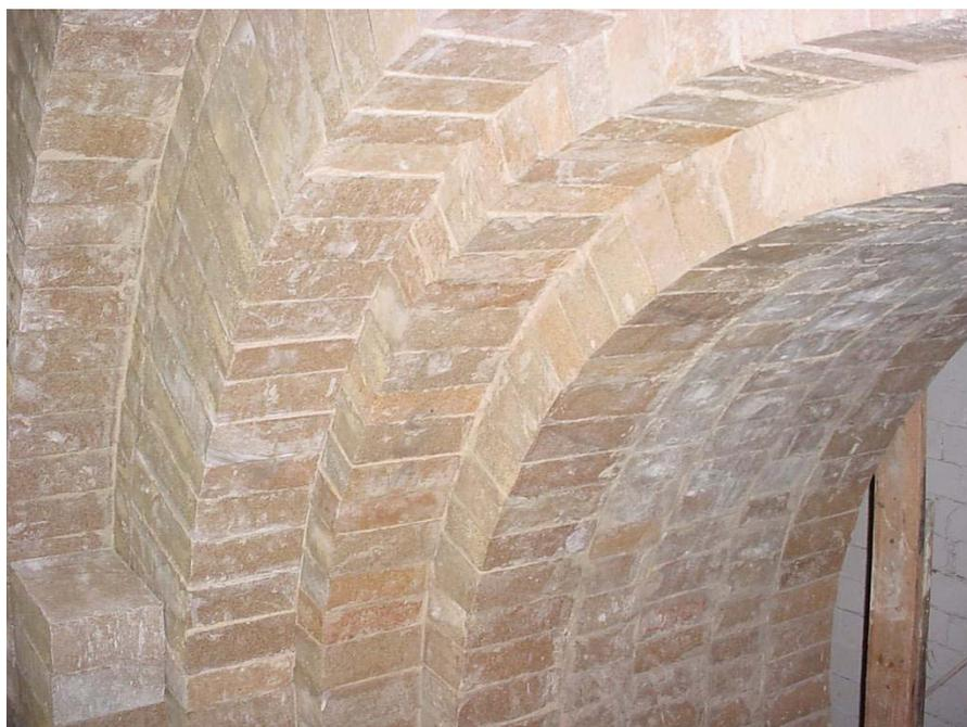
Em virtude do desenho TB-B11-50-1-00402 ter sido revisado e incluído mais uma barragem, foram necessários ajustes nas composições dos anéis do castelo de entrada, ocasionando inúmeros cortes nos tijolos antiácidos, retardando a conclusão do mesmo.
