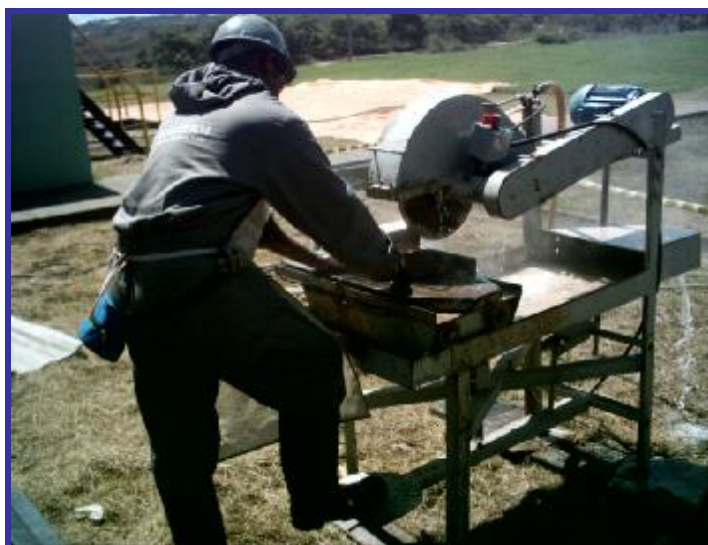
Foto 03- Corte do tijolo refratário
