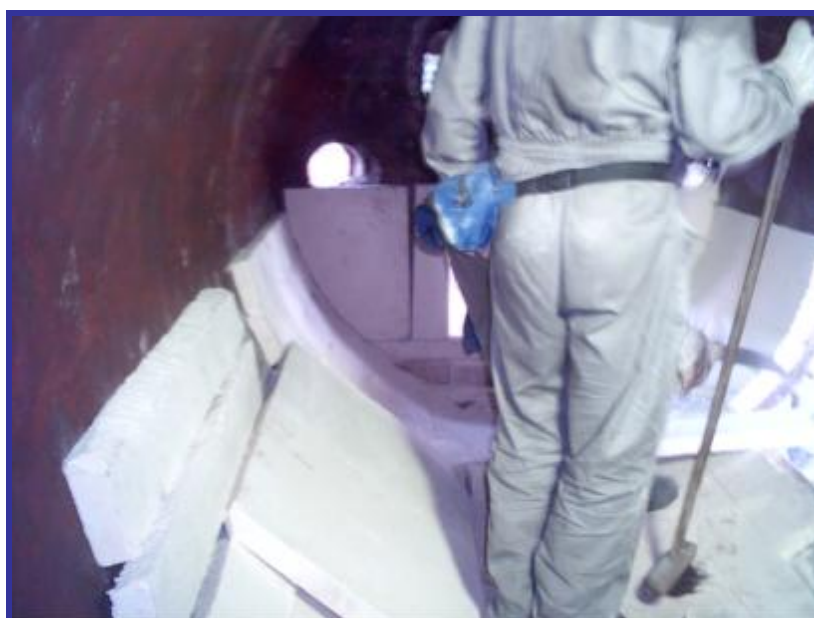
Foto 02 - Aplicação da Fibra Cerâmica (Duraboard RK)
