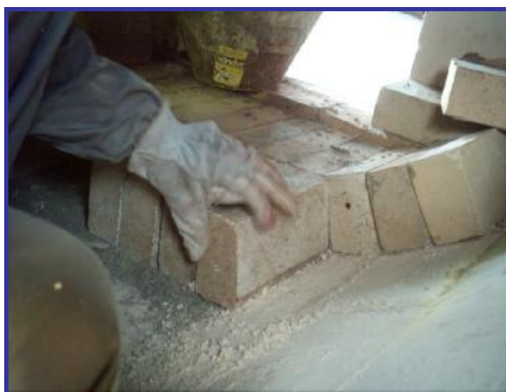
Foto 04 - Assentamento do tijolo refratário
