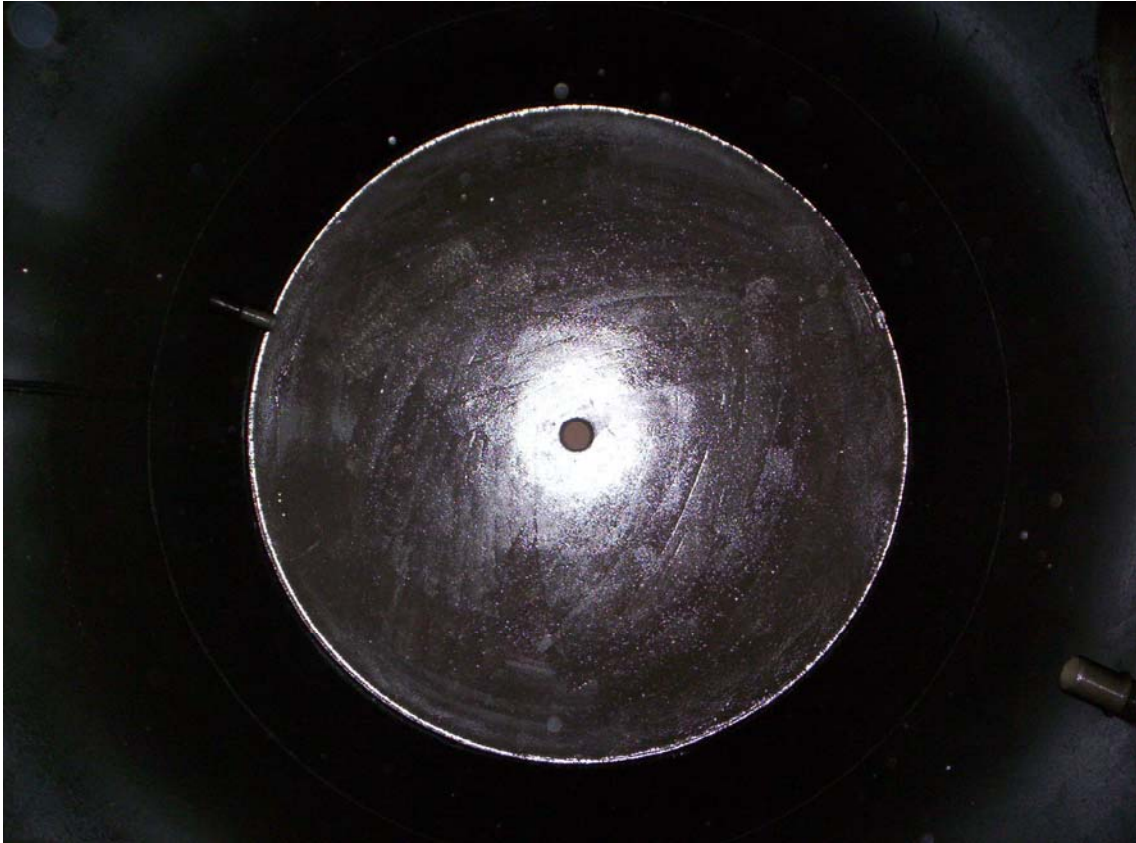
Aplicação do primer de aderência com a utilização da resina DERAKANE 8084
