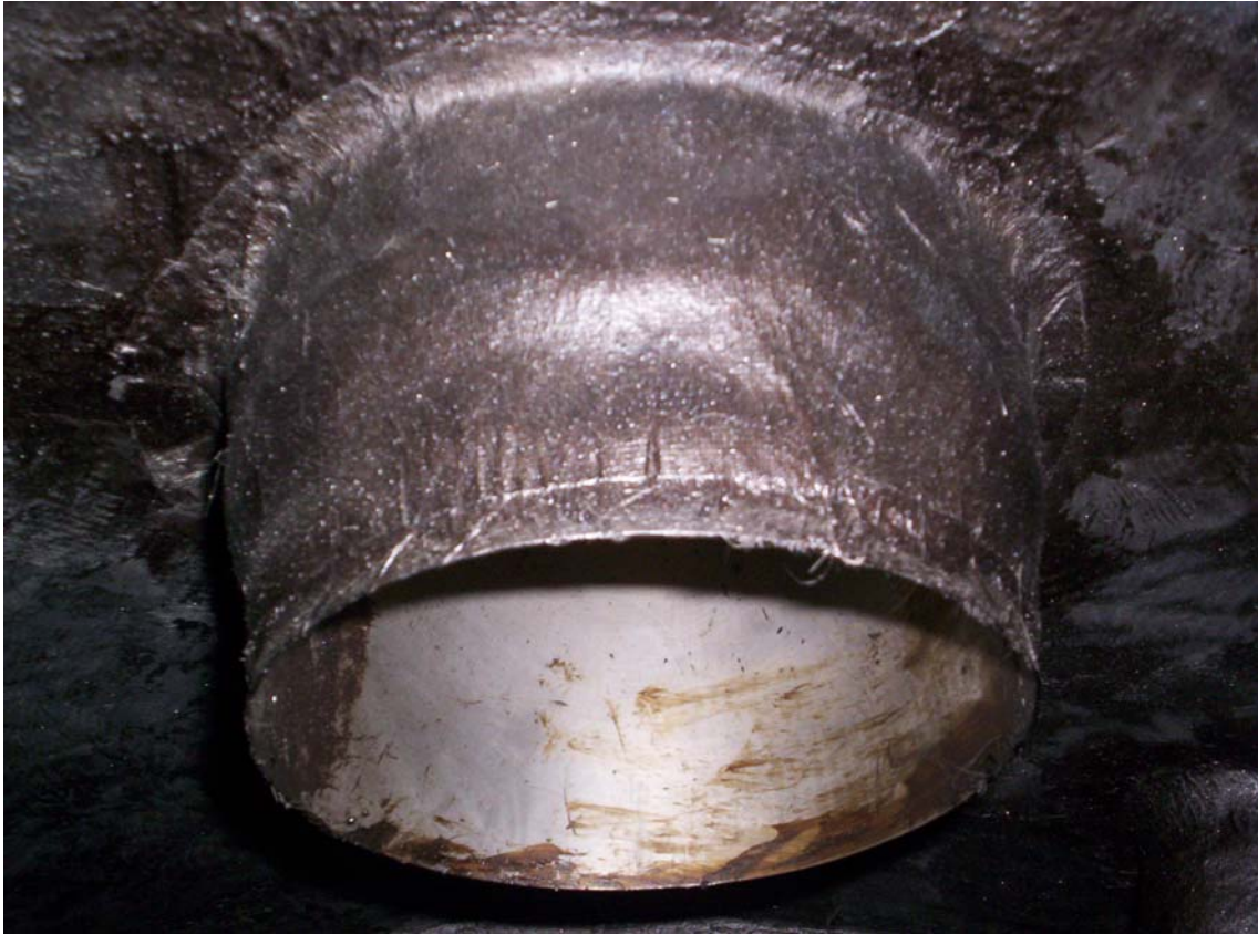
Selagem dos bocais com revestimento em PRFV
