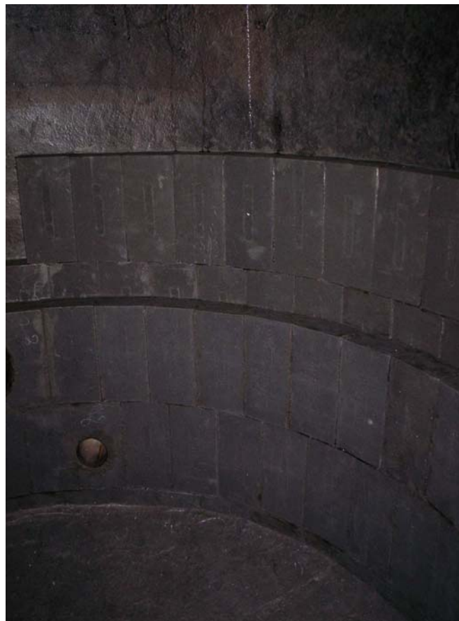
Detalhe na montagem dos tijolos de carbono sobre o revestimento em PRFV
