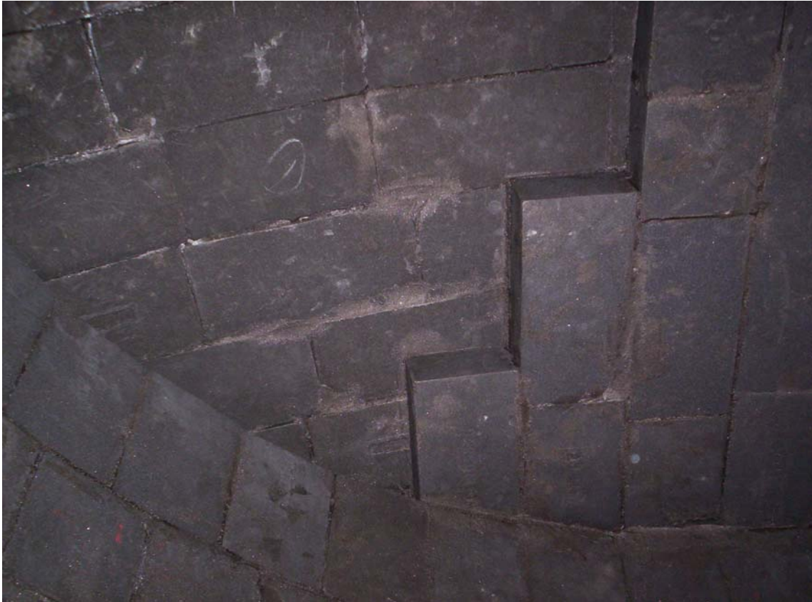
Detalhe da aplicação dos tijolos de carbono no teto do V-1915
