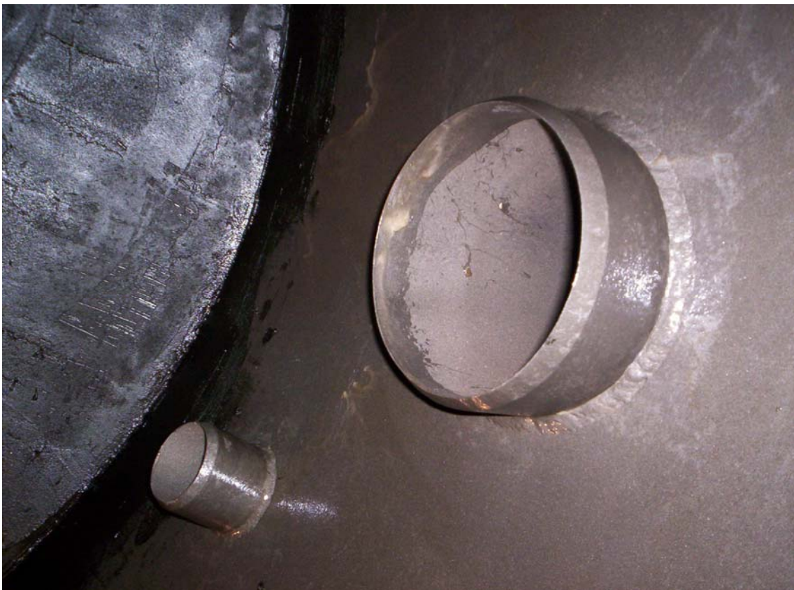
Chanfro realizado nos bocais e na boca de visita do V-1915
