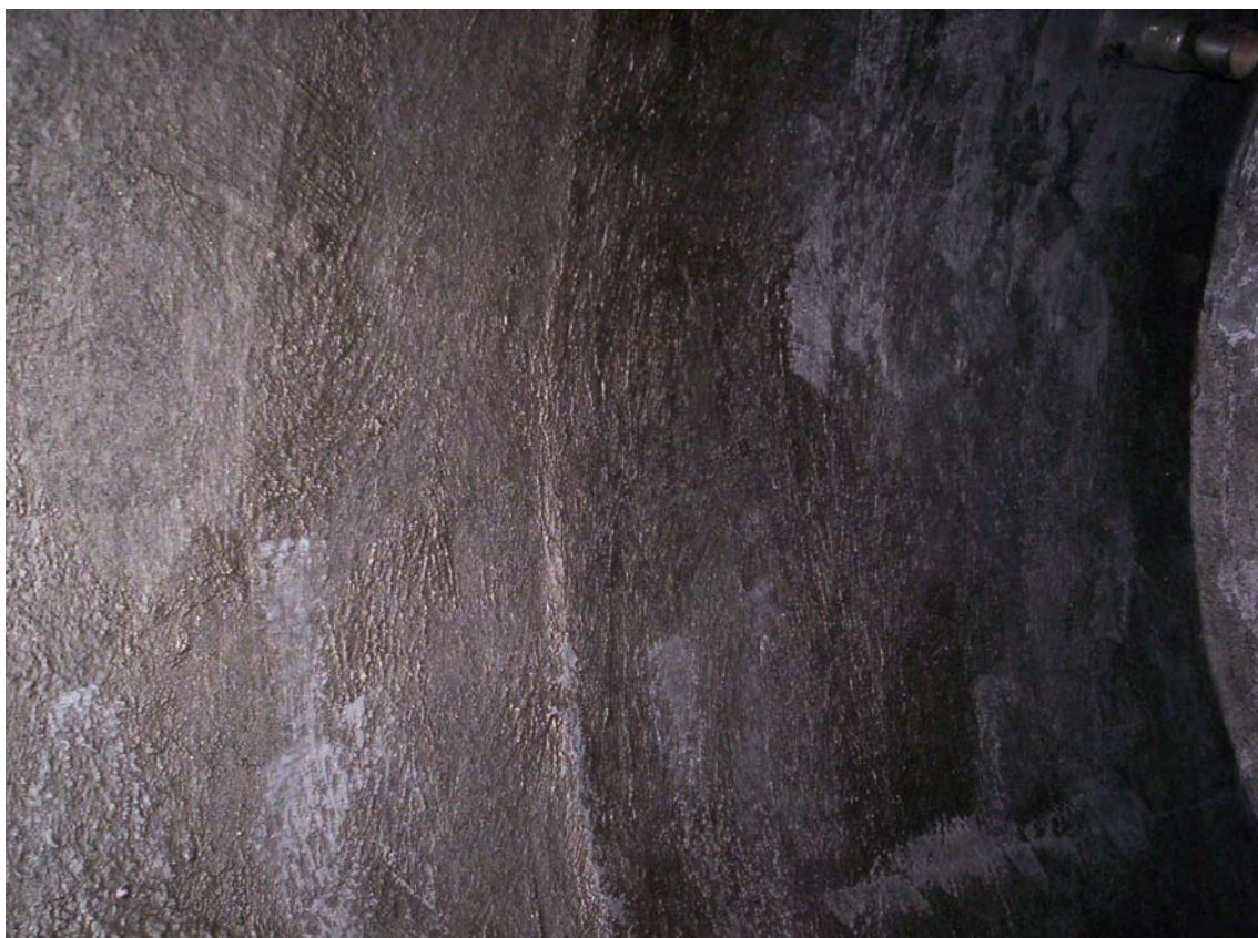
Detalhe final após a aplicação das camadas de manta de fibra de vidro com resina furânica
