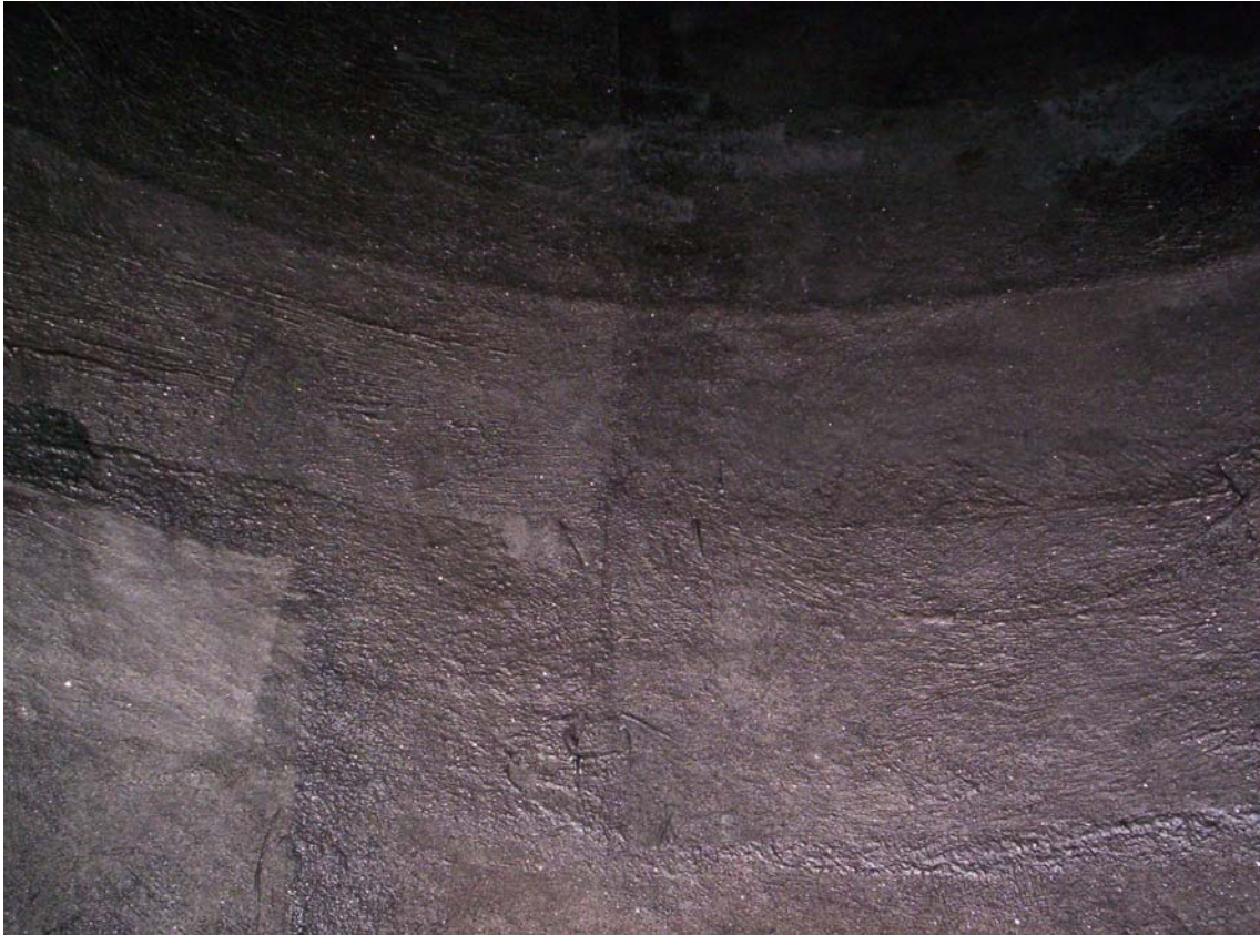
Resultado da aplicação final do revestimento em PRFV
