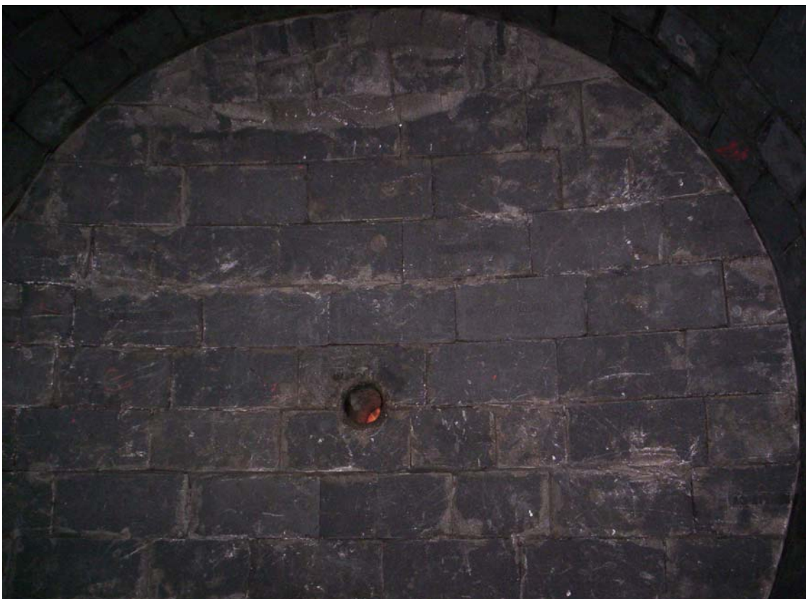
Resultado da aplicação dos tijolos de carbono no teto do V-1915
