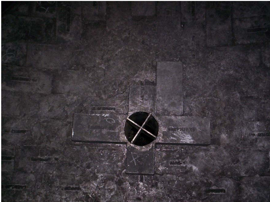
Detalhe da 2ª camada de tijolos de carbono no piso do V-1915
