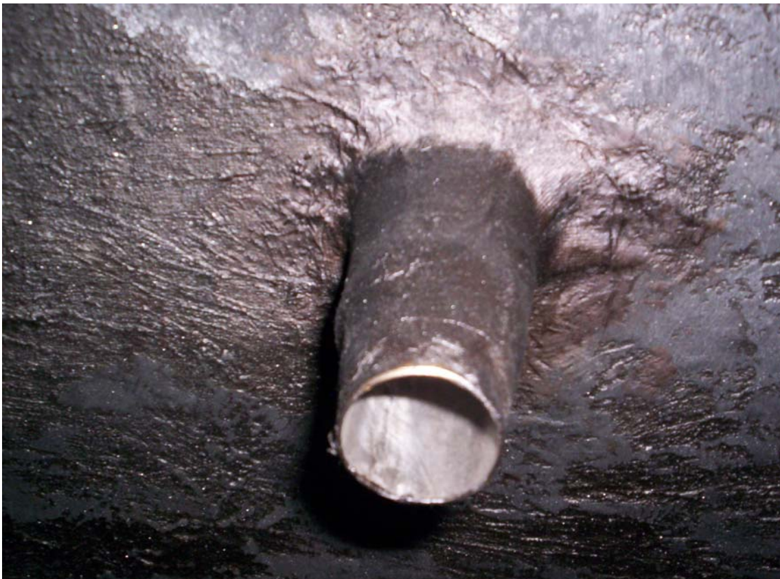
Selagem dos bocais com revestimento em PRFV
