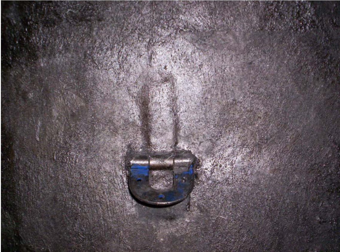
Teste de aderência da resina éster vinílica DERA KANE 8084
