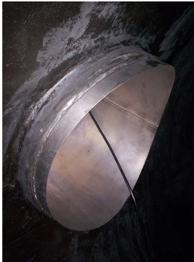
Detalhe das pestanas de titânio inseridas nos bocais do V-1915
