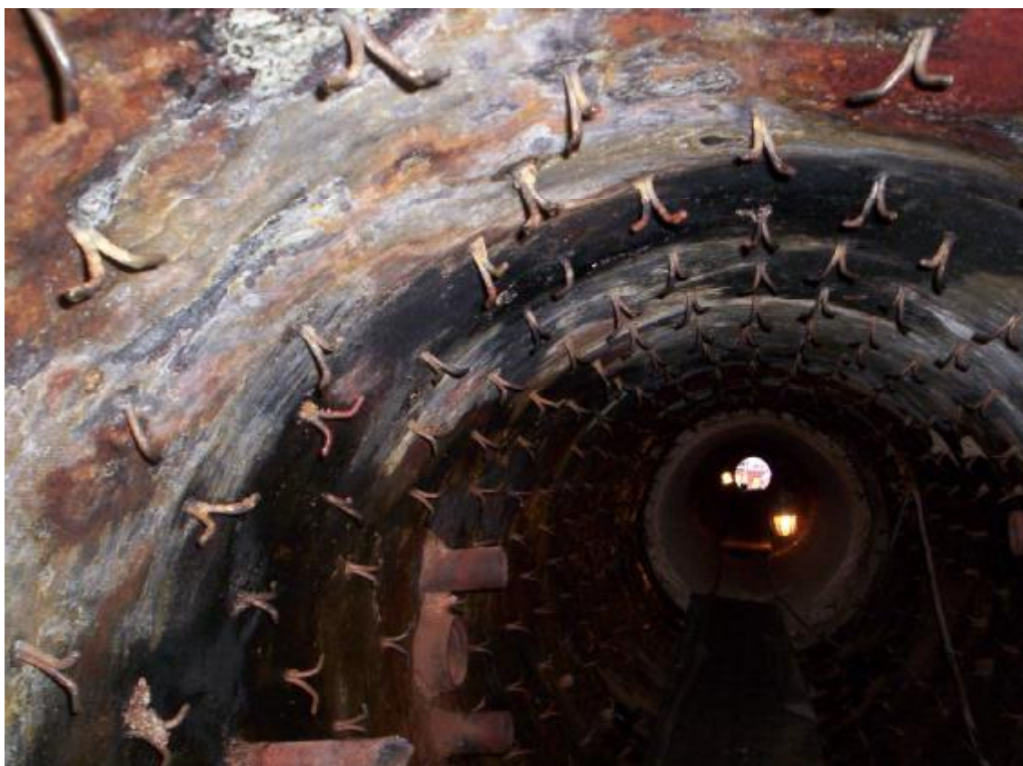
Foto 07 – Remoção do concreto Isolante da Chaminé.
