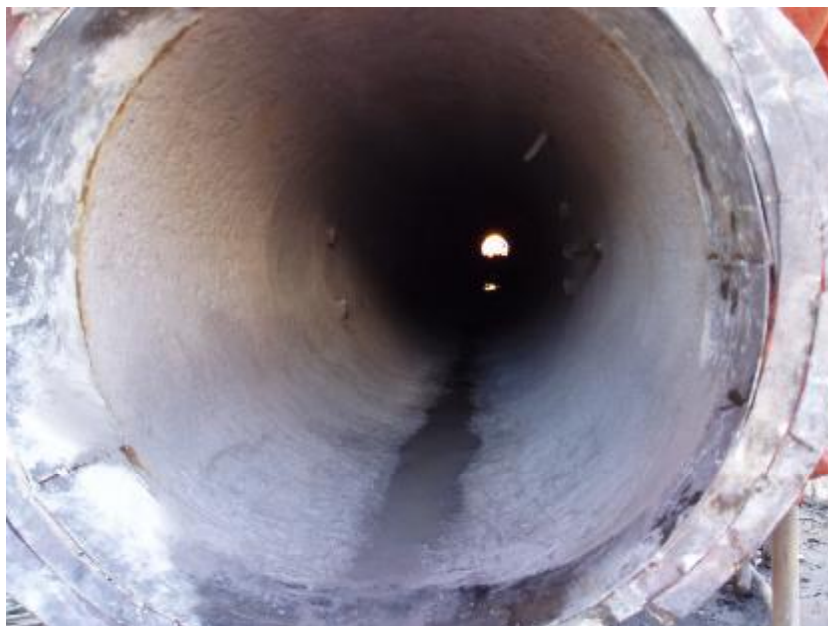
Foto 08 – Aplicação de concreto isolante.
