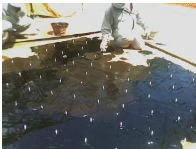
Foto 02 – Aplicação de Massa Anti-corrosiva.
