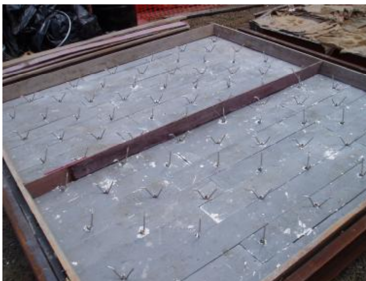
Foto 05 – Painel da Radiação pronto para concretagem.
