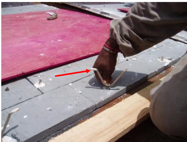
Foto 04 – Colocação da parte “V” dos Grampos
