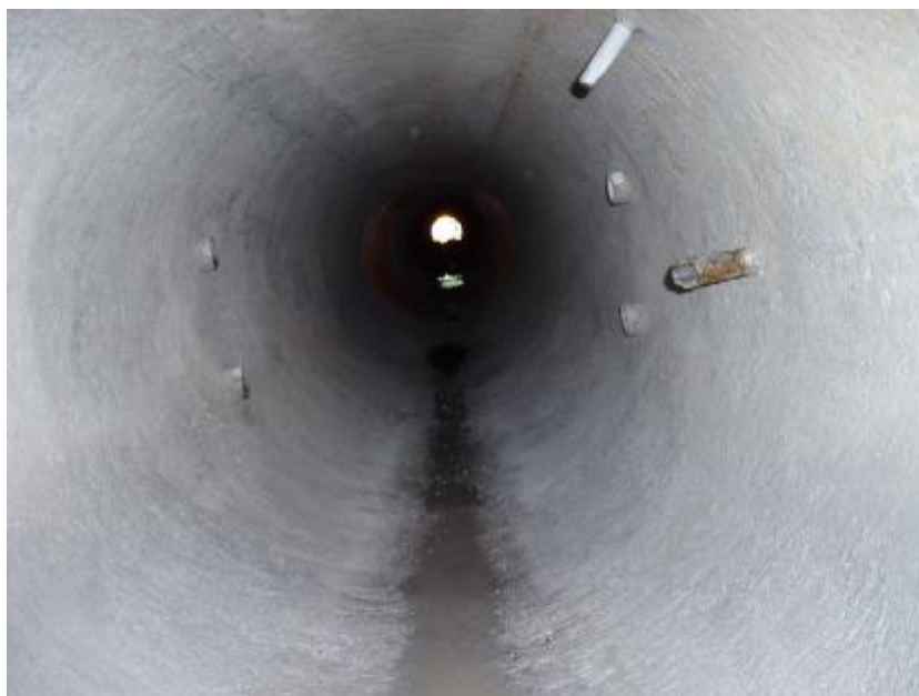
Foto 09 – Cura do concreto Isolante da Chaminé.
