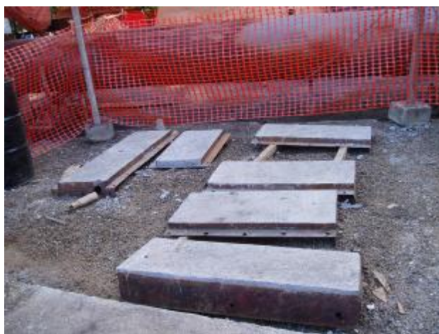
Foto 11 – Cura do concreto Antiácido.
