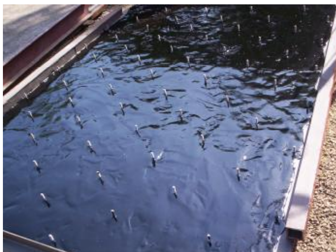
Foto 03 – Cura da Massa Anti-corrosiva.
