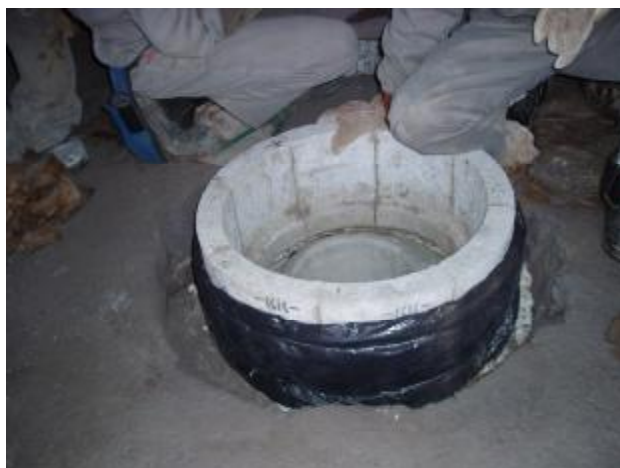
Foto 12 – Aplicação de concreto Isolante e Montagem dos Blocos Secundários.
