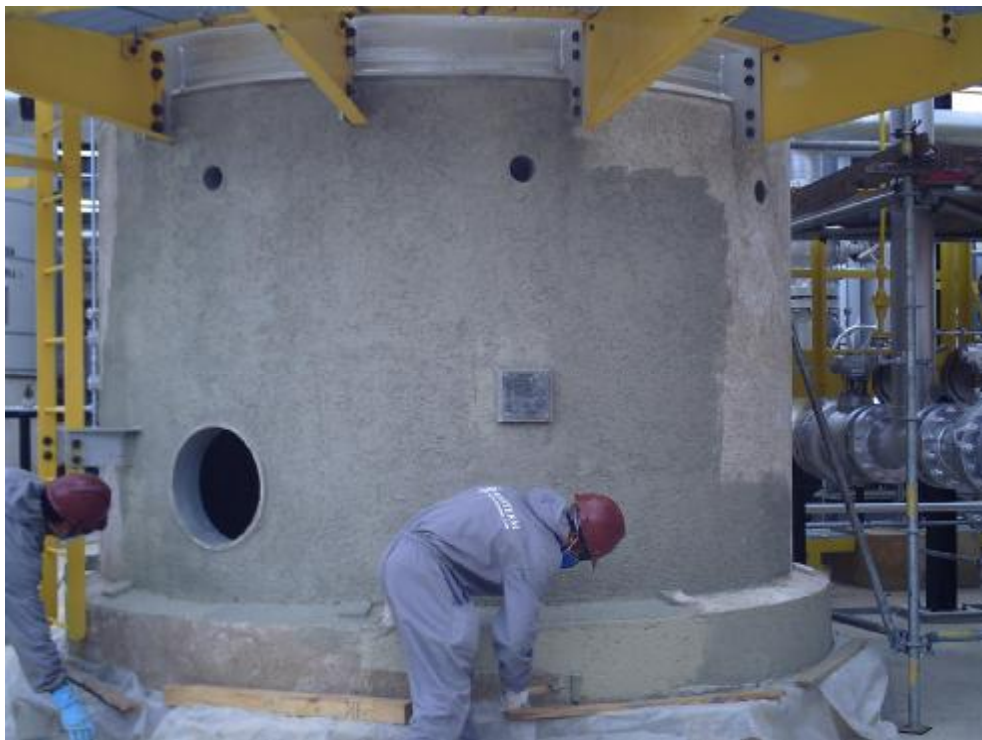
APLICAÇÃO DO IMPERMEABILIZANTE SUMACRIL ACRÍLICO S/B CONCRETO
