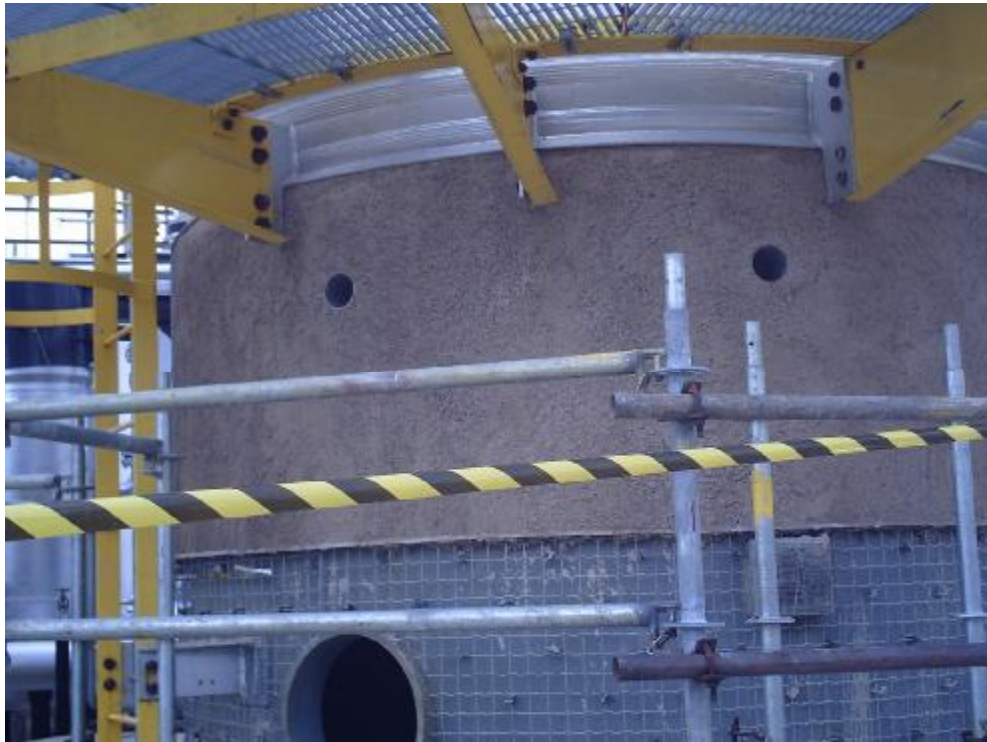
DETALHES DA APLICAÇÃO DO CONCRETO ISOLANTE EXTERNAMENTE E INTERNAMENTE
