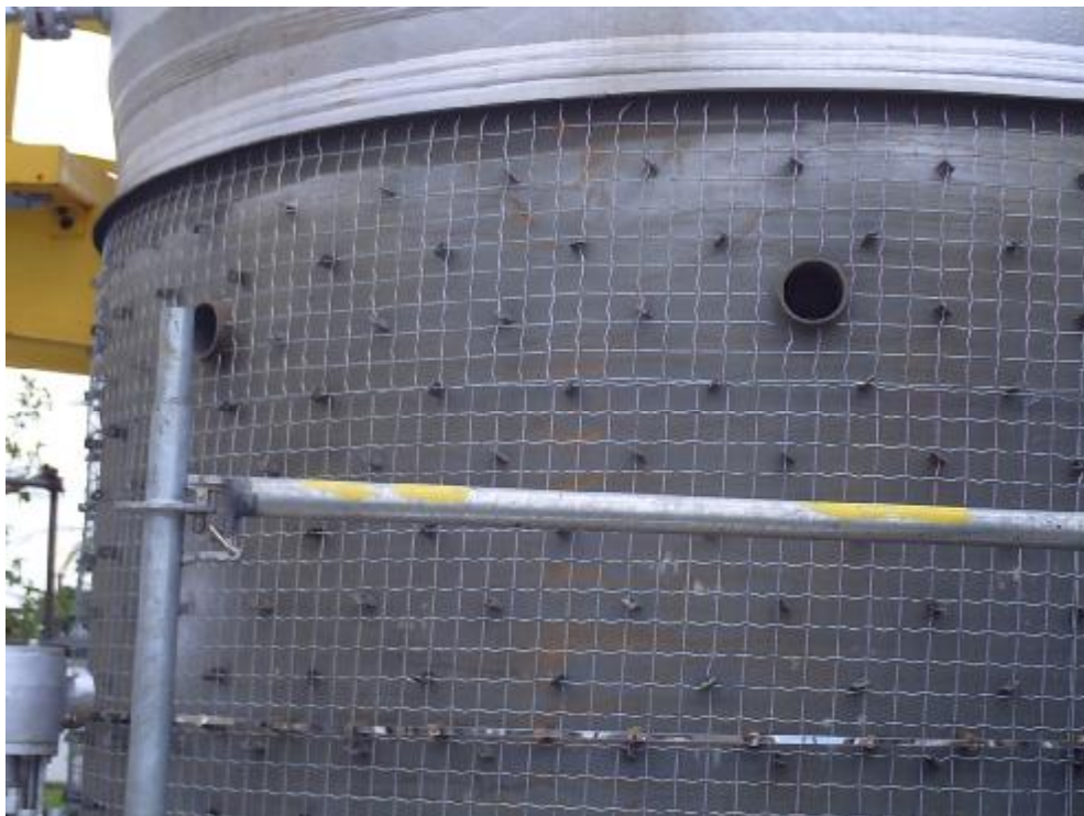
DETALHES DO DISPOSITIVO DE ANCORAGEM
