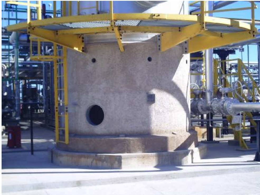
CONCLUSÃO DA APLICAÇÃO DO CONCRETO ISOLANTE
