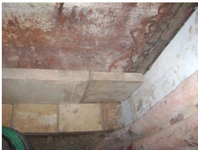
FOTO 05 - Detalhe da junta dilatação da lateral esquerda da parede.
