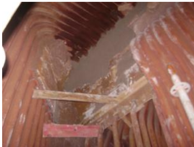
FOTO 06 - Reparos no refratário da parte superior do tubulão de vapor traseiro.
