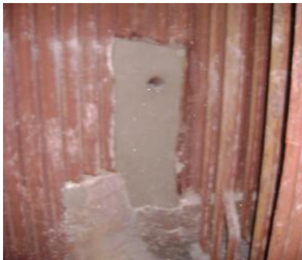
FOTO 08 - Detalhe da vista frontal do visor traseiro
