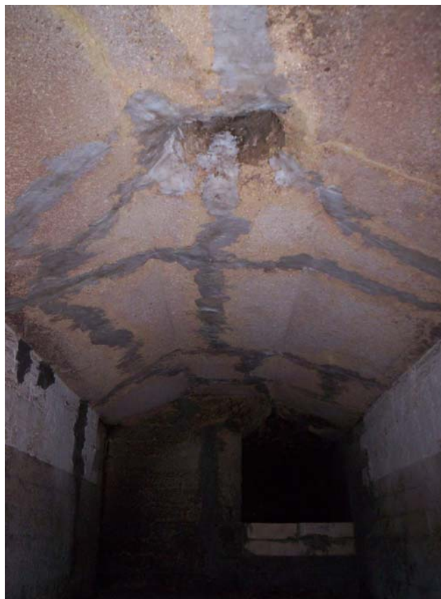
APLICAÇÃO DE MASSA MOLDÁVEL LDS NO TETO DO CREMATÓRIO
