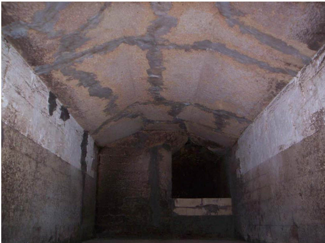
APLICAÇÃO DE MASSA MOLDÁVEL LDS NO TETO DO CREMATÓRIO
