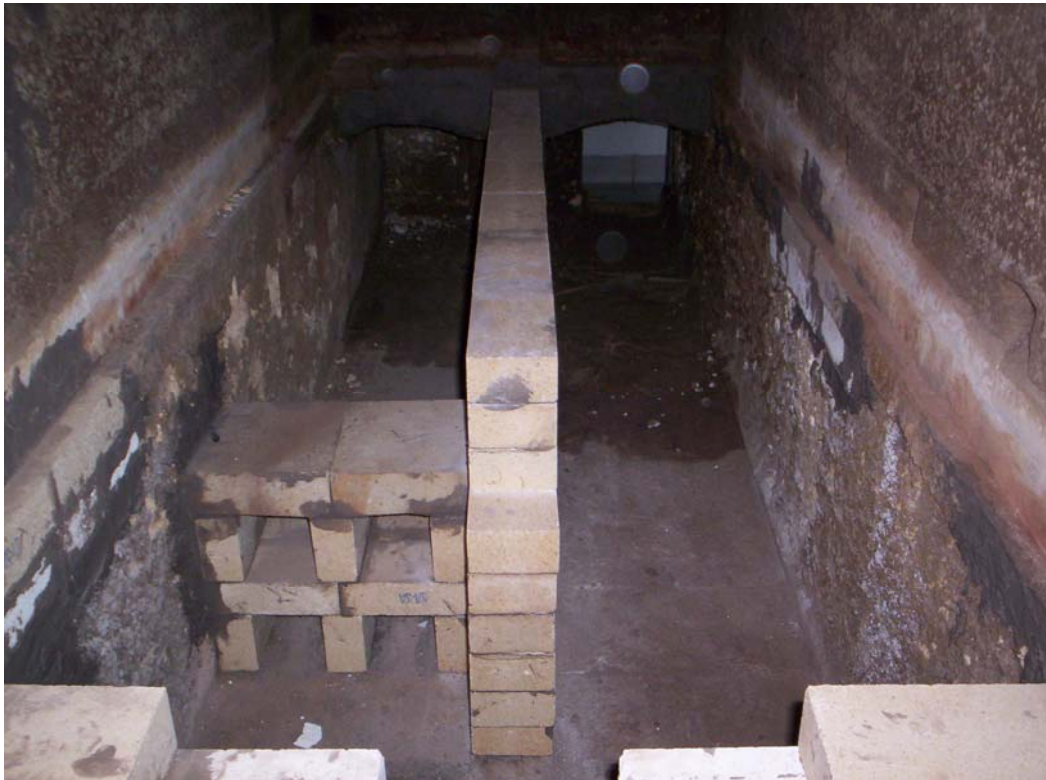
APLICAÇÃO DOS TIJOLOS REFRAATÁRIOS NO BAFLE E PAREDE INFERIOR INTERMEDIÁRIA
