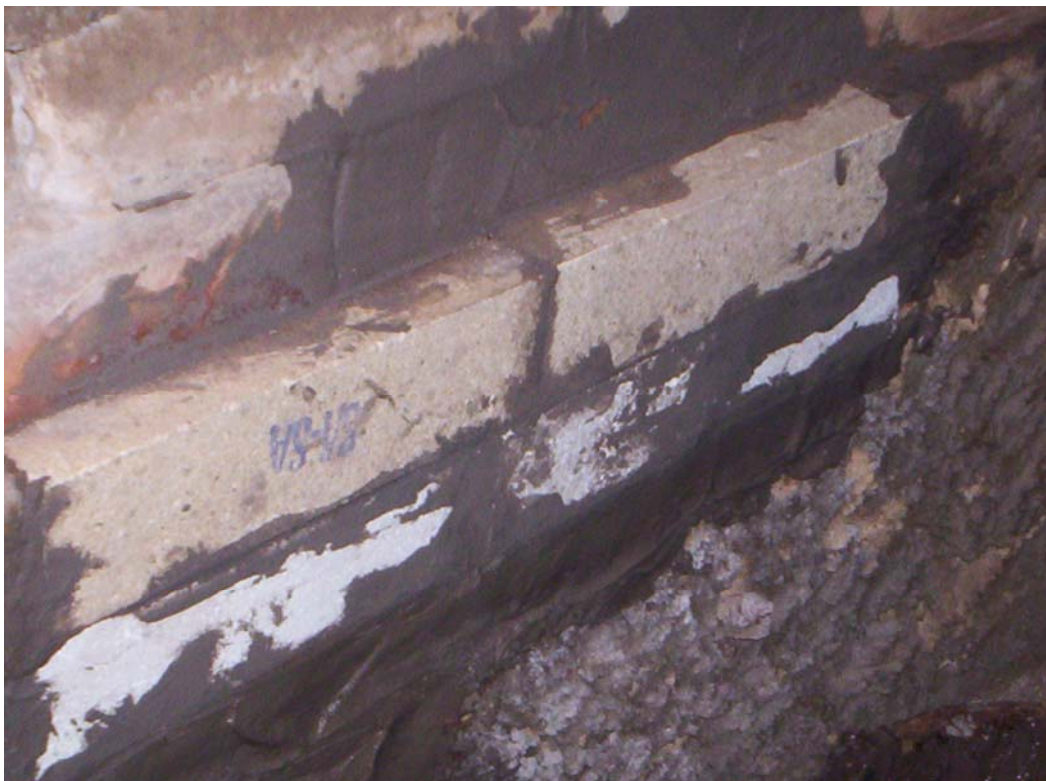
APLICAÇÃO DOS TIJOLOS REFRAATÁRIOS NO BAFLE E PAREDE INFERIOR INTERMEDIÁRIA
