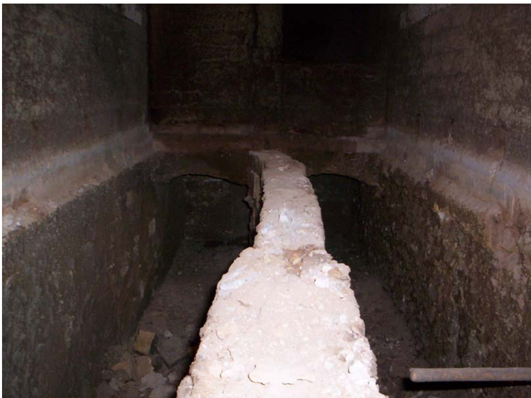
SITUAÇÃO ENCONTRADA DAS CÂMARAS INFERIORES APÓS A RETIRADA DAS LAJOTAS
