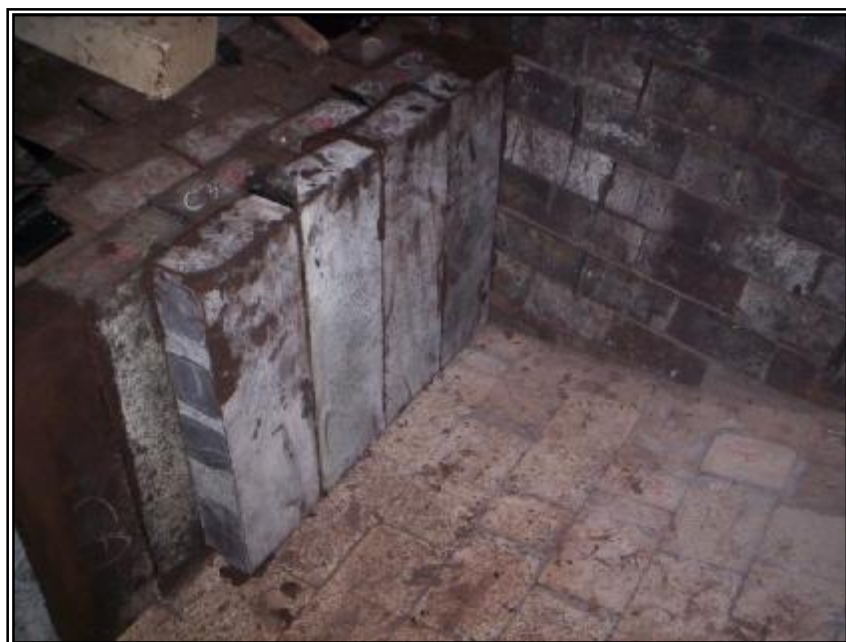
FOTO 15 – Detalhamento do assentamento dos tijolos do cilindro.
