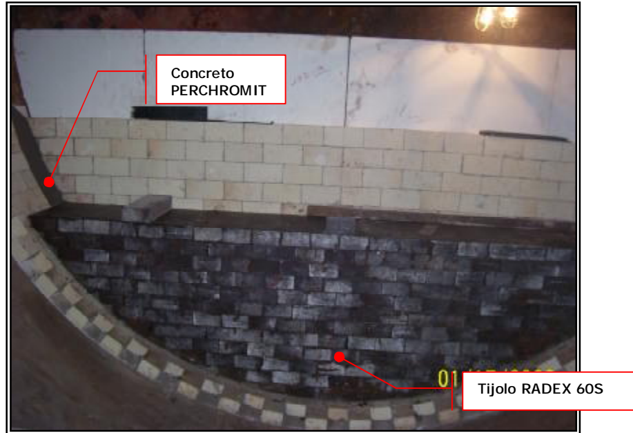
Foto 04 – Aplicação da 2ª Camada de Tijolo.
