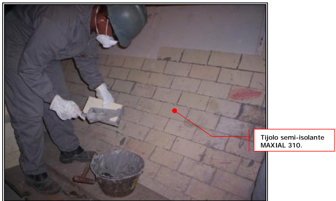
FOTO 09 – Assentamento dos tijolos MAXIAL 310 no cilindro.
