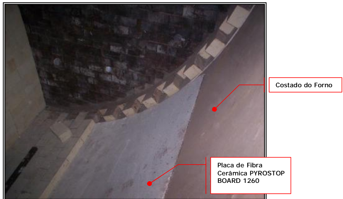
FOTO 08 – Aplicação da placa de fibra cerâmica PYROSTOP BOARD no cilindro.
