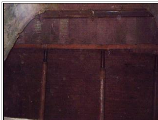
FOTO 10 – Colocação dos Tirantes.
