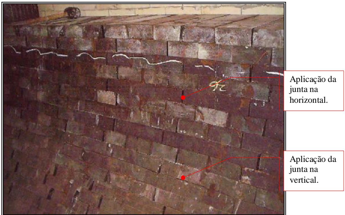
FOTO 11 – Detalhamento das juntas.
