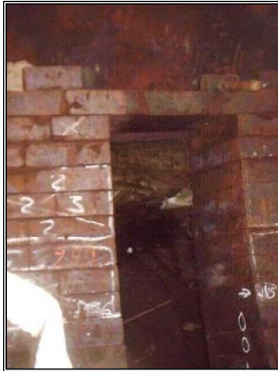
FOTO 12 – Assentamento dos tijolos na região da ventaneira.
