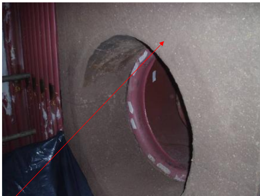
Detalhe dos cortes feitos nos blocos queimadores
