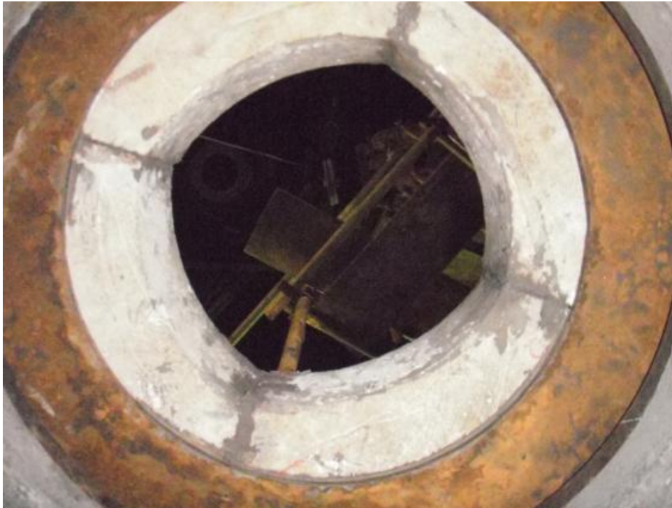
FOTO 21: Vista dos tijolos do funil já assentados .
