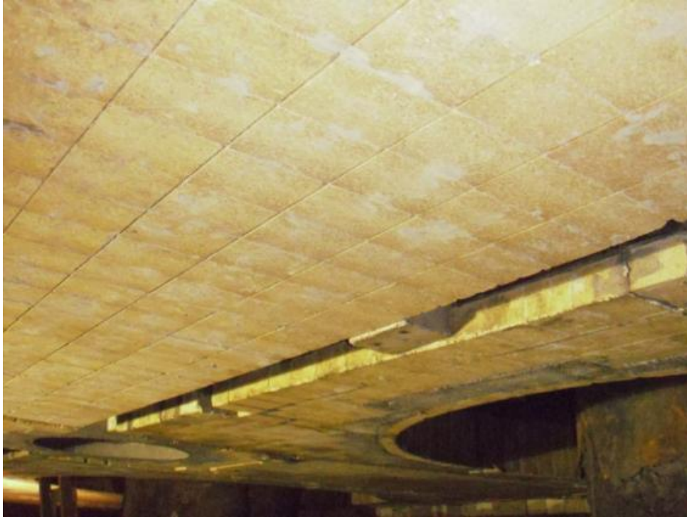
FOTO 27: Detalhe para o refratário dos elementos refrigerados que tiveram reparos.
