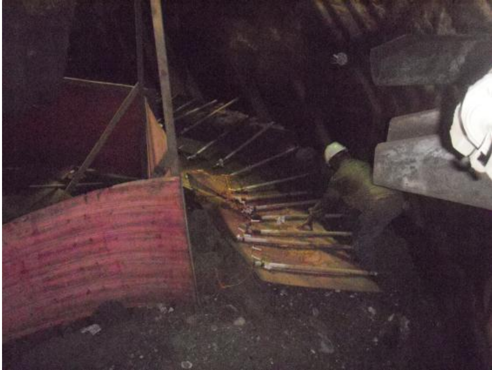
FOTO 03: Preparação para detonação da soleira
