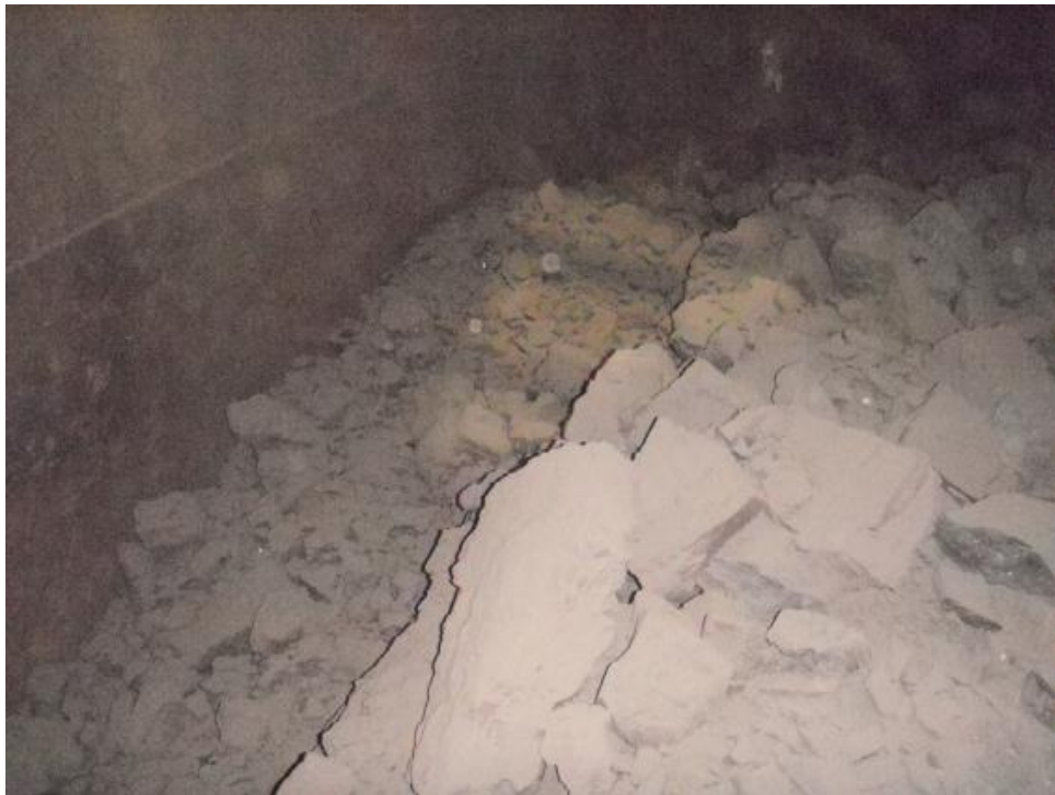
FOTO 04: Condição da soleira após a ultima detonação.
