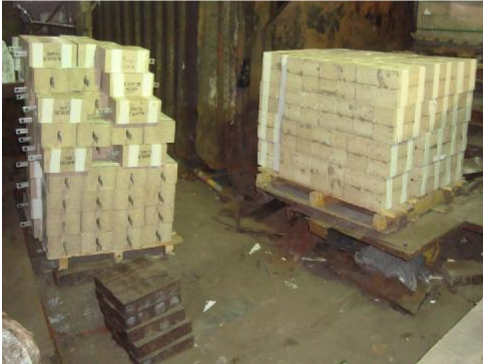
FOTO 13: Tijolos argamassados e envolvidos com fita crepe dois a dois.
