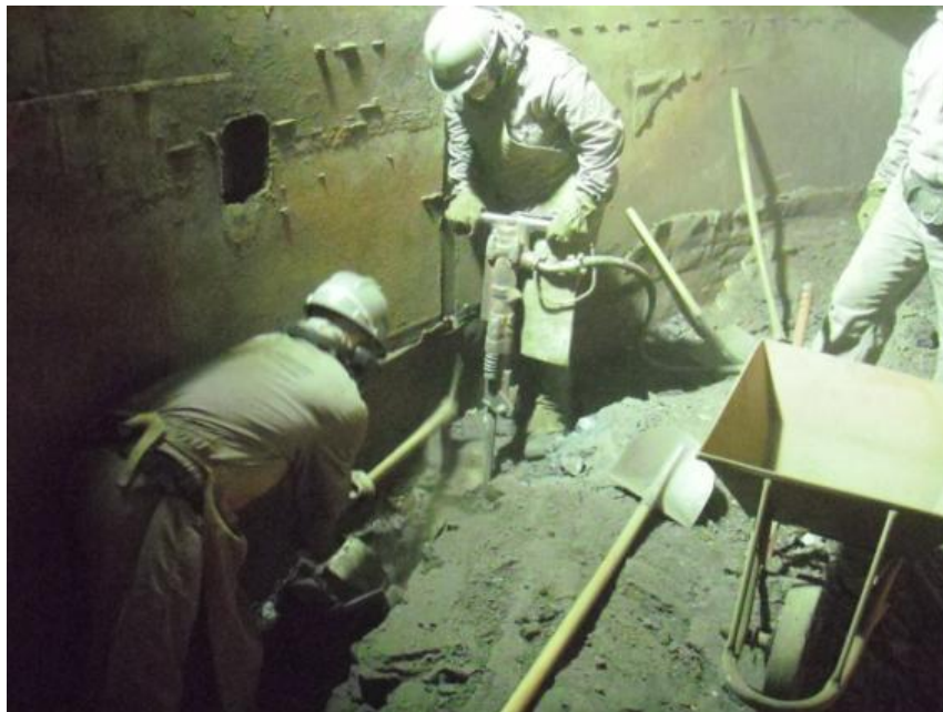
FOTO 05: Acerto da soleira com a utilização de martelotes pneumáticos com ponteiros e talhadeiras.
