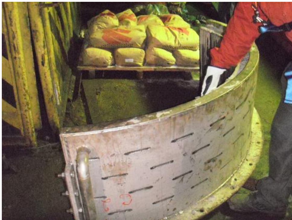
FOTO 25: Detalhe para uma das peças já concretadas.
