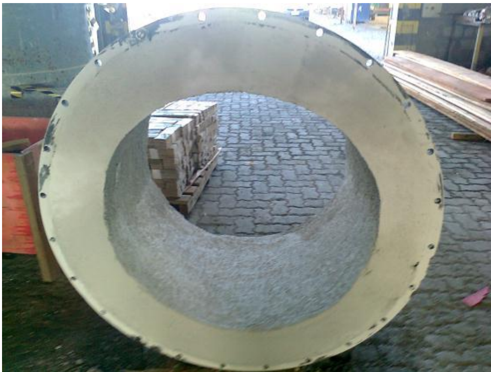
FOTO 20: Seção já concretada de umas das partes da chaminé.
