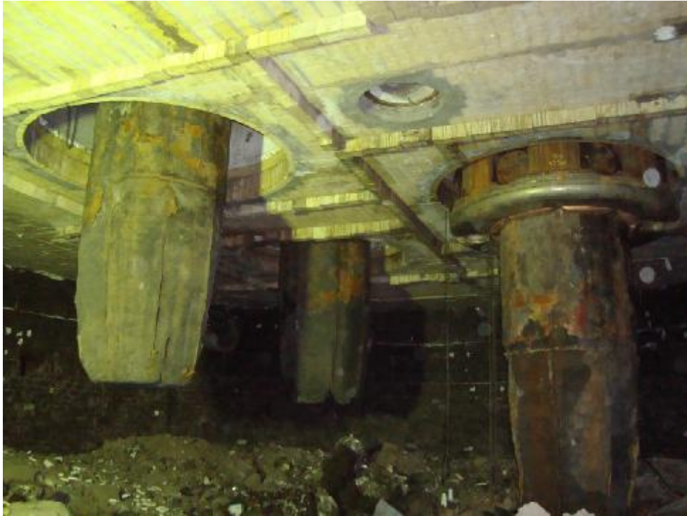
FOTO 33: Vista interna do forno concluído.
