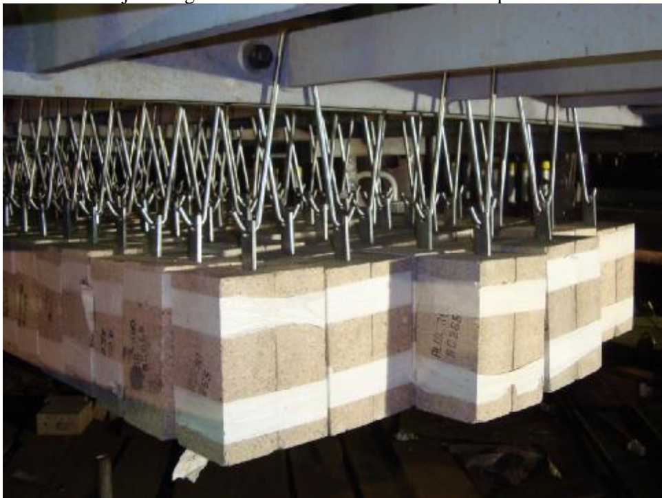
FOTO 14: Ancoragens tipo gancho colocadas nas grades da abóbada.
