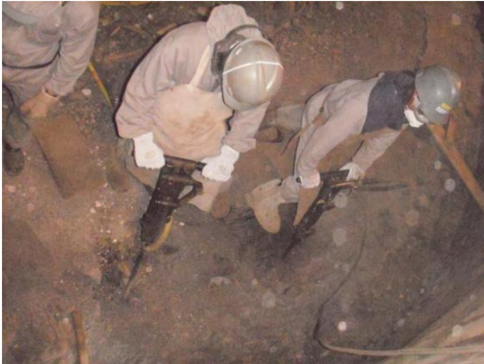
FOTO 01: Etapa de perfuração dos furos para detonação
