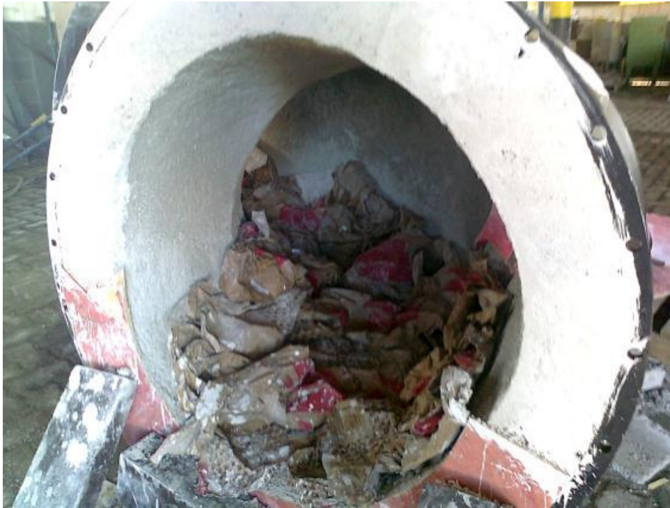
FOTO 19: Concretagem de uma das partes da chaminé.
