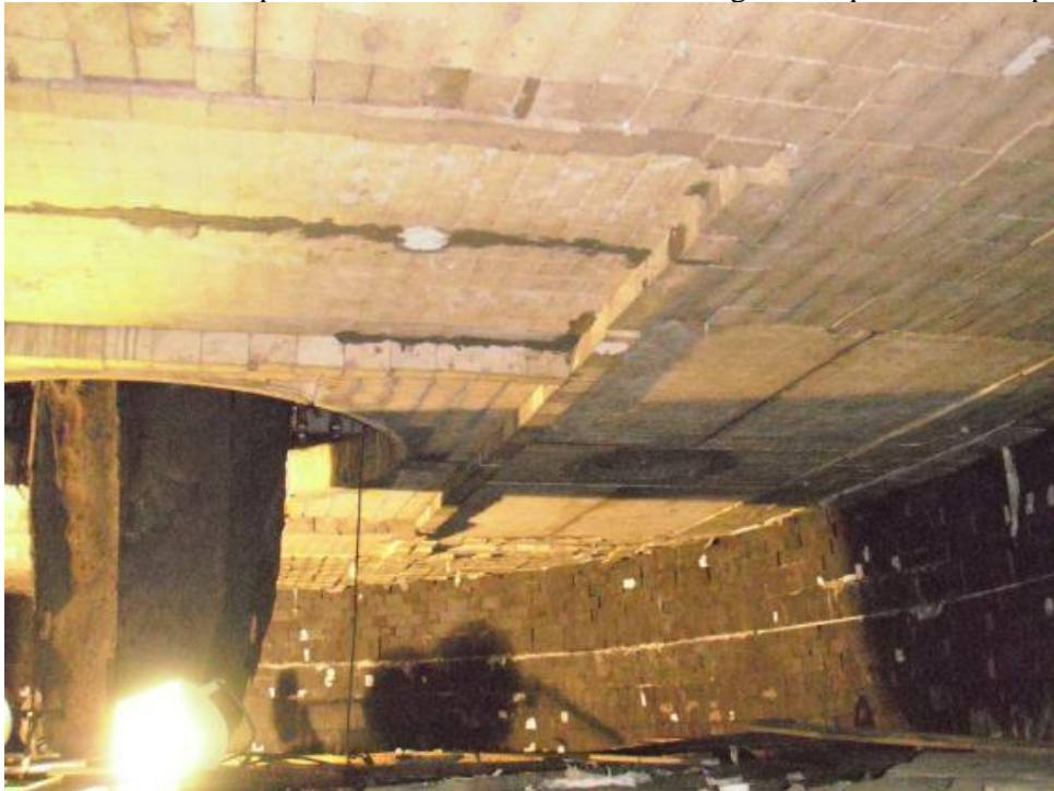
FOTO 28: Abobada e costada concluídos
