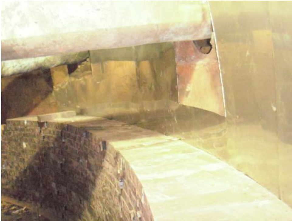
FOTO 09: Continuação da montagem dos tijolos de encosto.
