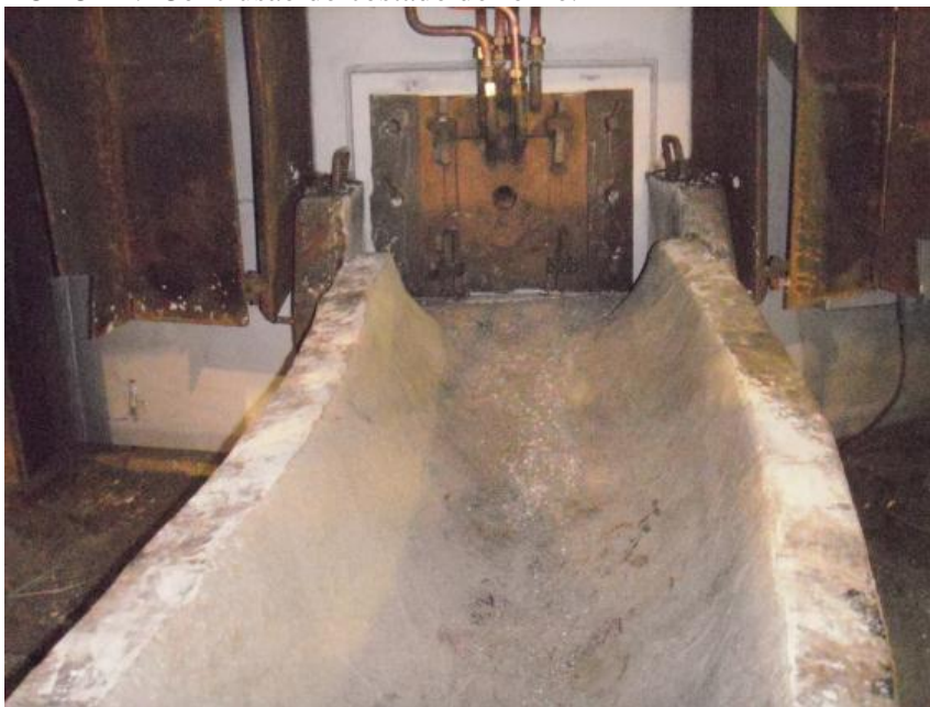
FOTO 12: Detalhe para fura de corrida.
