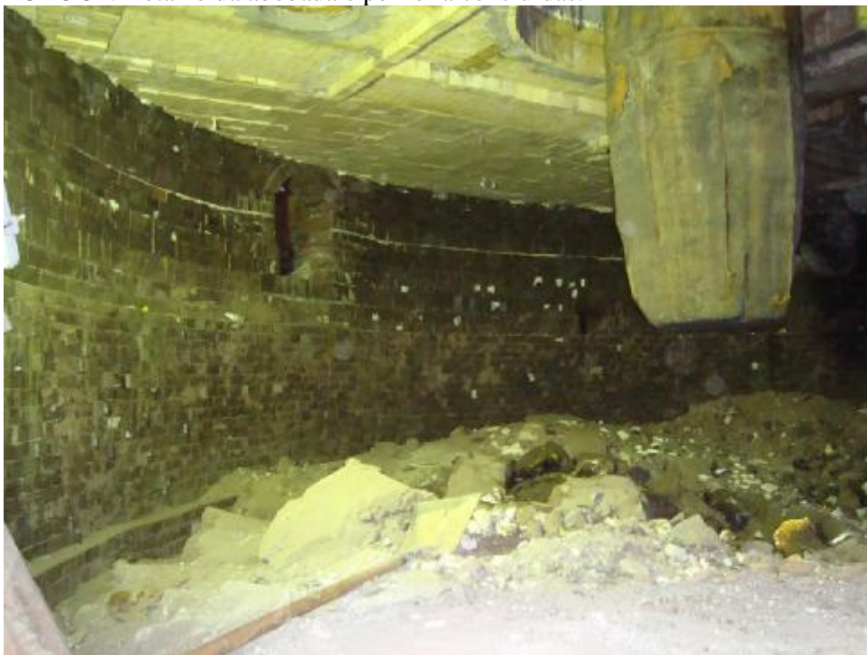
FOTO 32: Vista interna do forno concluído.
