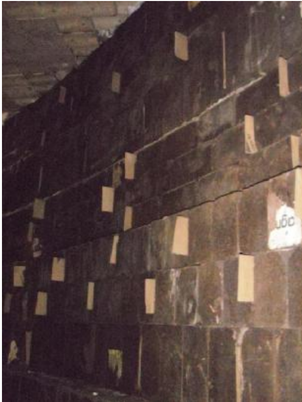
FOTO 11: Conclusão do costado do forno.
