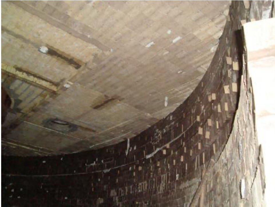
FOTO 31: Detalhe da abobada e periferia concluídas.
