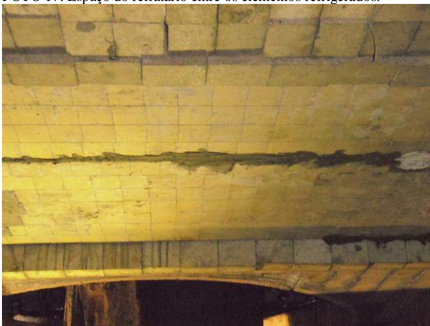
FOTO 18: Vista dos elementos refrigerados com refratário entre eles.
