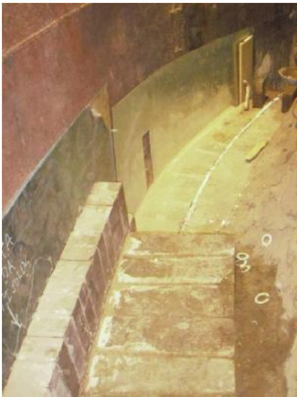
FOTO 07: Início da montagem dos tijolos de encosto.
