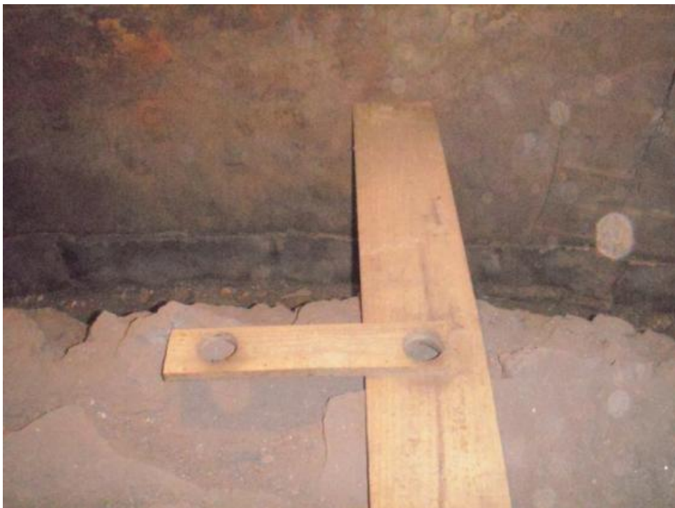
FOTO 02: Gabarito utilizado para marcação dos furos.
