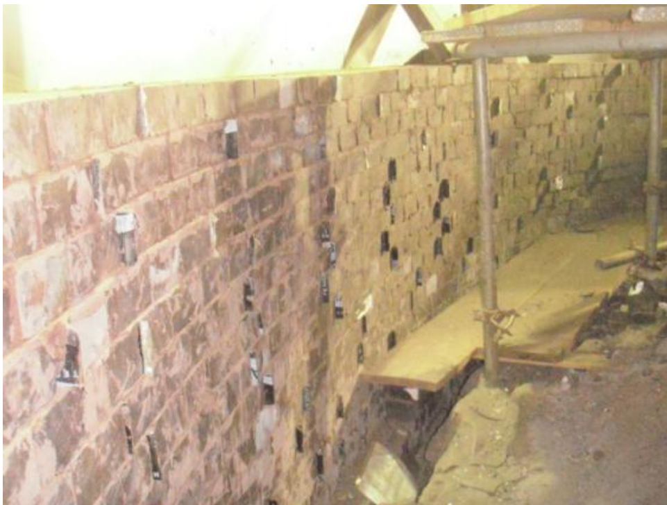
FOTO 10: Continuação da montagem dos tijolos de encosto.
