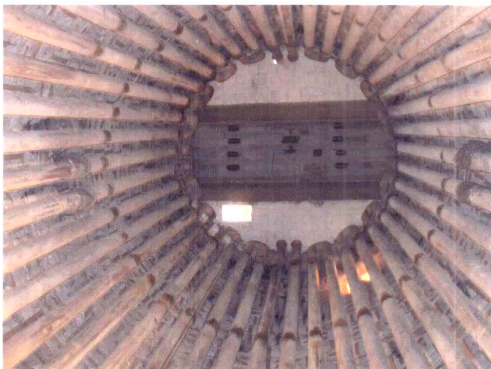
Resultado final da aplicação dos módulos de fibra cerâmica cimentados e ancorados na zona de radiação.
