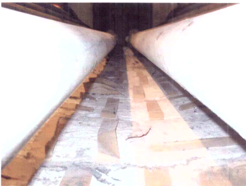
Resultado final da aplicação dos módulos de fibra cerâmica cimentados na zona de radiação.
