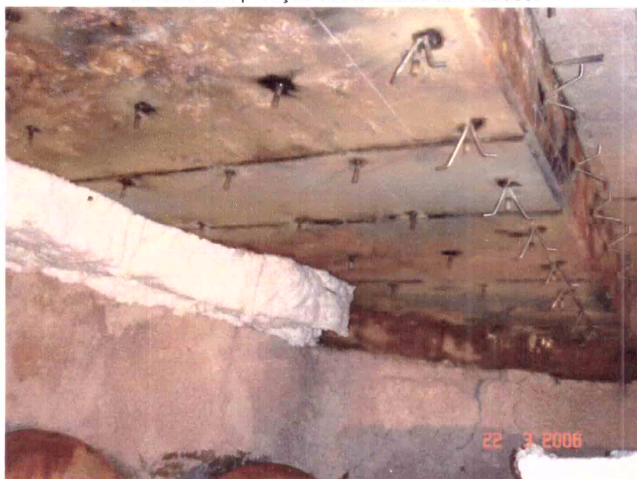
Detalhe dos pinos rosqueados no teto da radiação.
