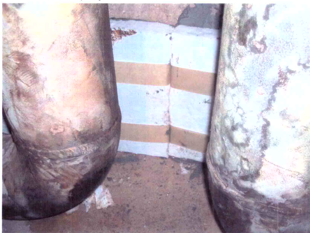
Início da aplicação dos módulos de fibra cerâmica cimentados.
