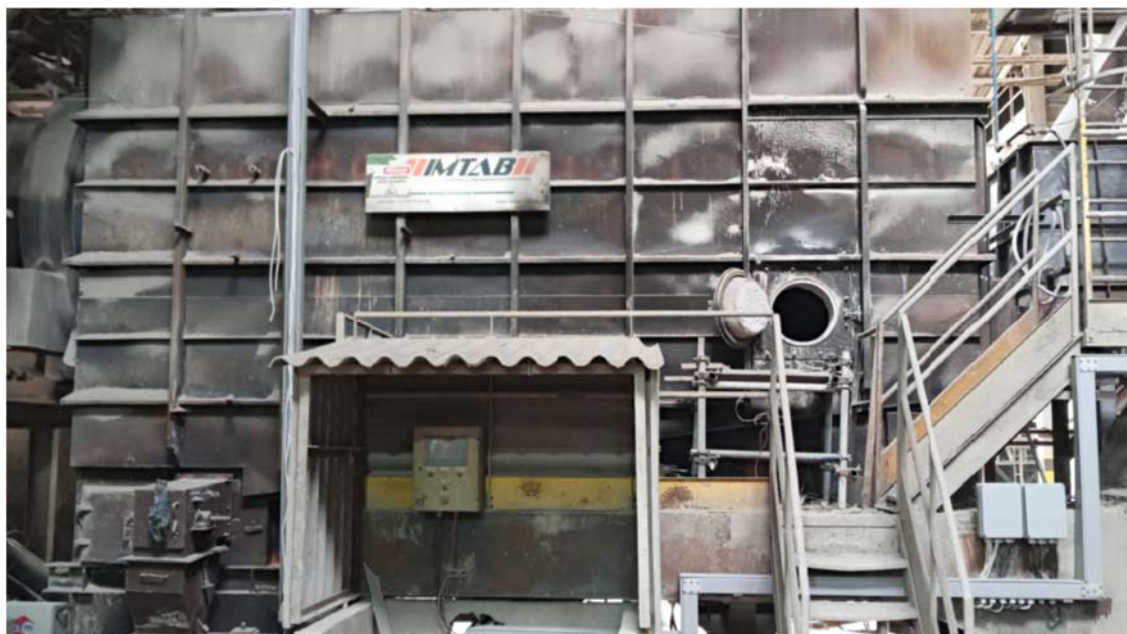
FOTO 05 BV DE ACESSO DA FORNALHA
