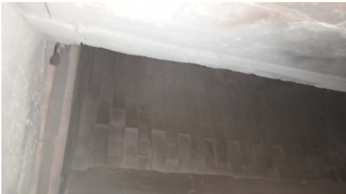
FOTO 07 MELHORIAS TÉCNICAS NO INTERIOR DA FORNALHA
