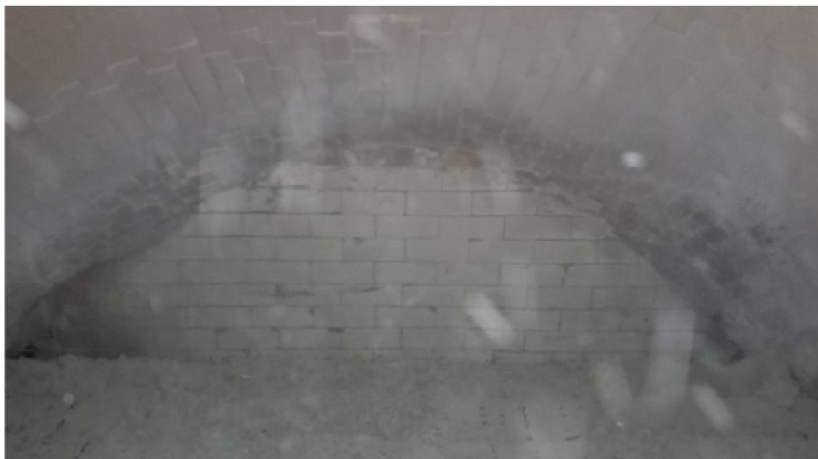
FOTO 08 MELHORIAS TÉCNICAS NO INTERIOR DA FORNALHA.
