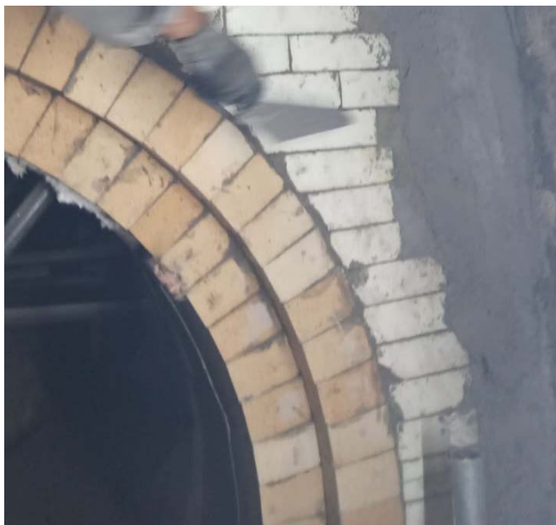
FOTO 02 REVESTIMENTO REFRAATÓRIO NA PAREDE FRONTAL
