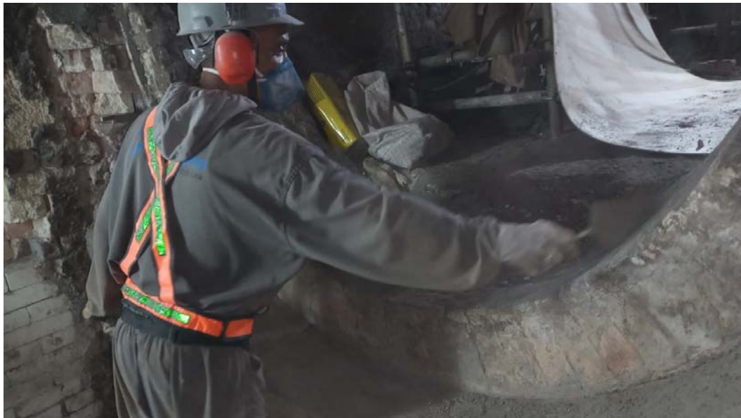
FOTO 03 INSTALAÇÃO DE CONCRETO NA REGIÃO DO PISO.
