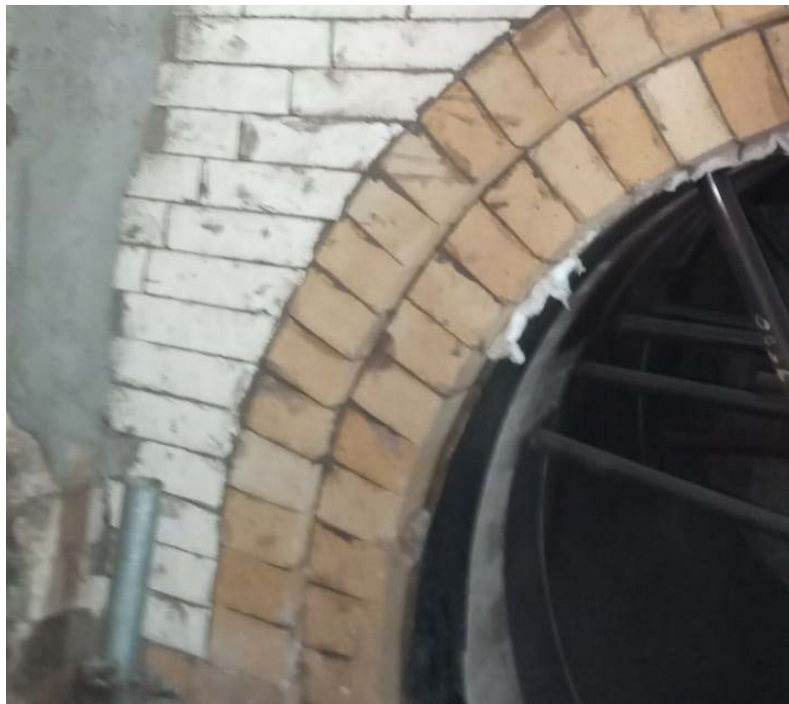
FOTO 01 REVESTIMENTO REFRAATÓRIO NA PAREDE FRONTAL
