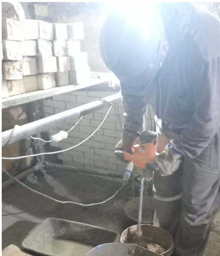
FOTO 04 HOMOGENEIZAÇÃO DA ARGAMASSA PARA APLICAÇÃO.
