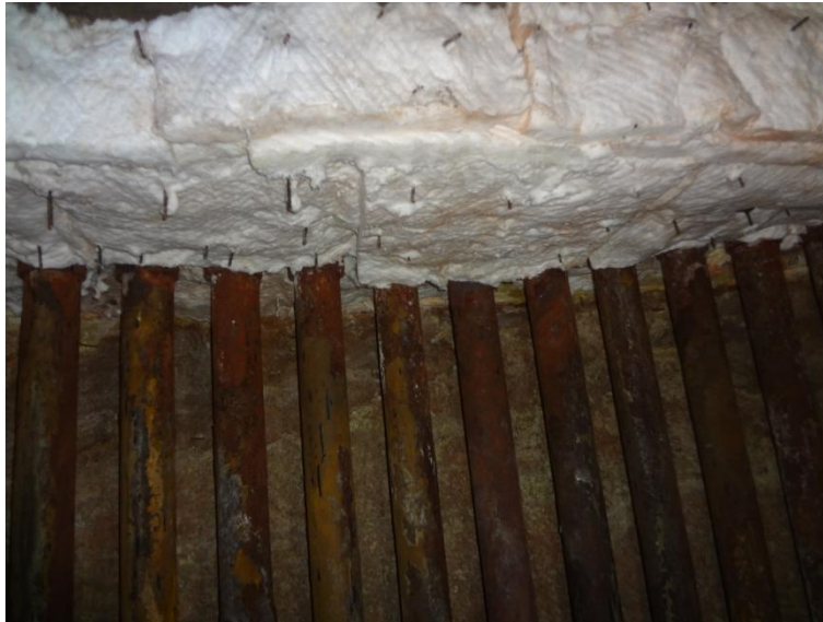
Imagem 15 - Detalhe da instalação de manta de fibra cerâmica no teto.
