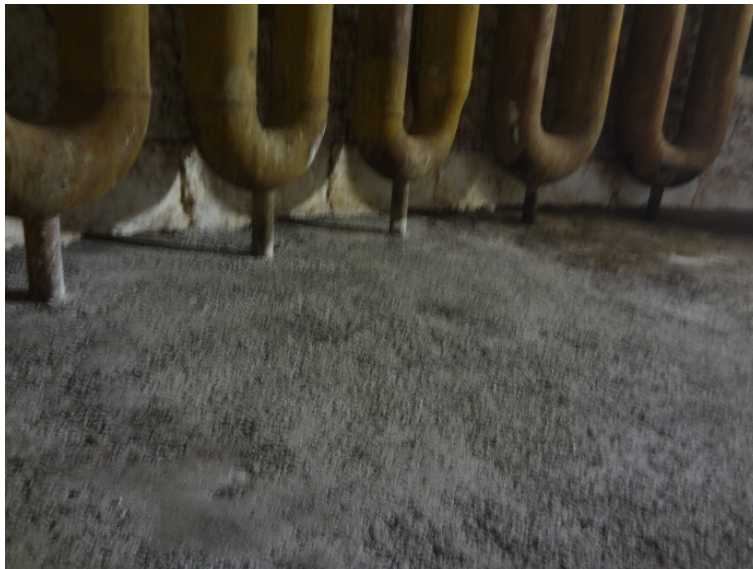
Imagem 3 - Piso do forno com aplicação de concreto isolante Thermbreak 403-G.
