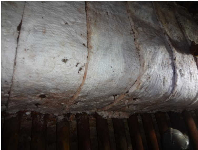
Imagem 16 - Detalhe da instalação de manta de fibra cerâmica no teto.
