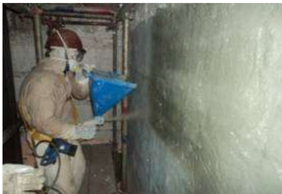
► Aplicação por Spray – sobre módulos de fibra cerâmica Anchor Loc ®
