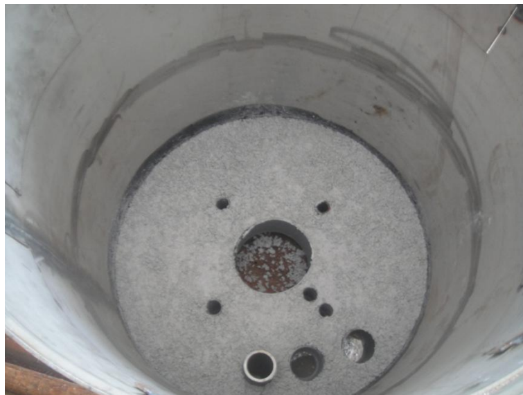
Imagem 11 - Detalhe da aplicação do concreto denso nos queimadores.
