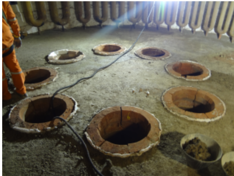
Imagem 1 - Piso do forno com aplicação de concreto isolante Thermbreak 403-G.
