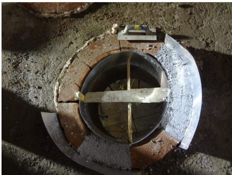
Imagem 9 - Detalhe da execução das juntas com fibra cerâmica e reparo nos tijolos com concreto denso Thermbond 6-L.
