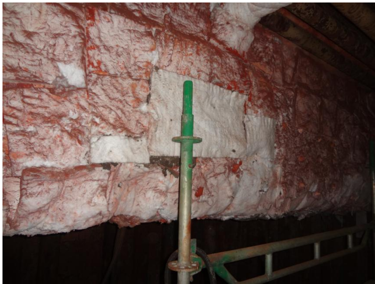
Imagem 13 - Detalhe da instalação de manta de fibra cerâmica no teto para complemento de espessura.
