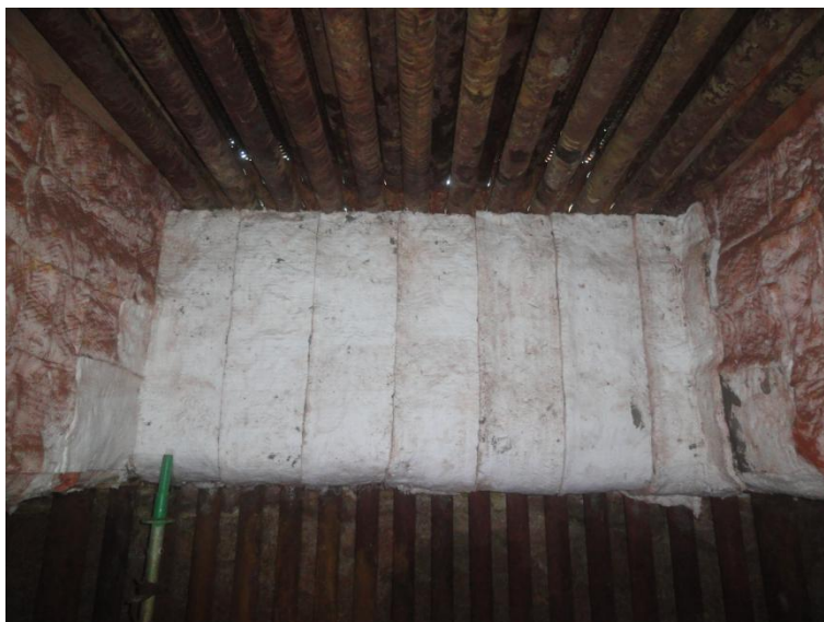
Imagem 21 - Detalhe da instalação de manta de fibra cerâmica na transição.
