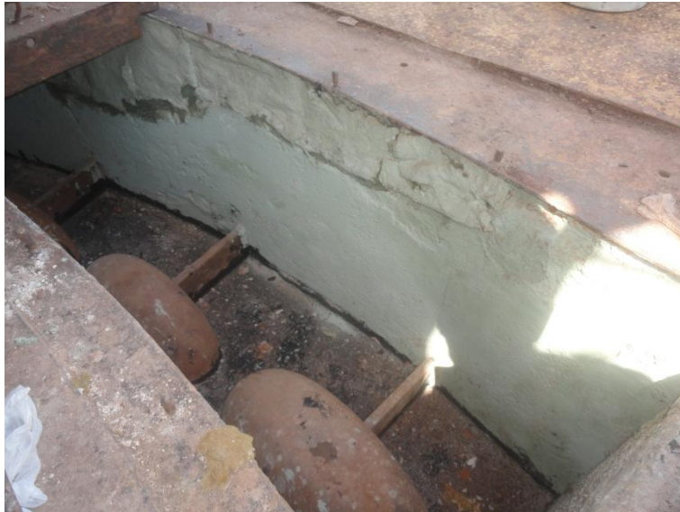
Imagem 27 - Detalhe da recuperação do revestimento com concreto isolante Thermbreak 403-G.
