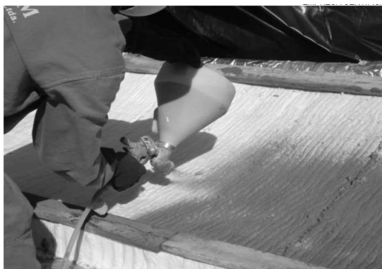
► Aplicação por Spray – sobre módulos de fibra cerâmica Anchor Loc ®
