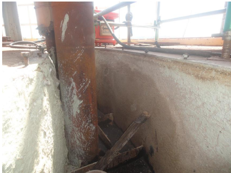
Imagem 26 - Detalhe da recuperação do revestimento com concreto isolante.
