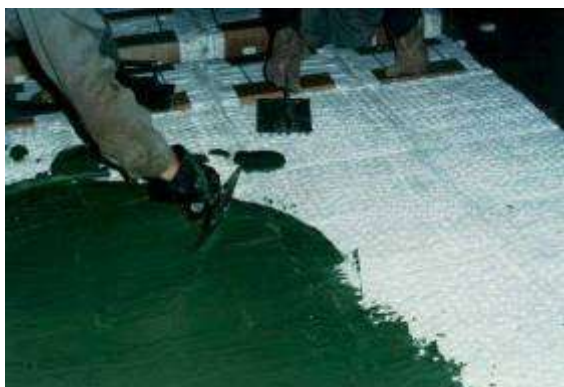
► Aplicação Manual – sobre módulos de fibra cerâmica Anchor Loc ®
