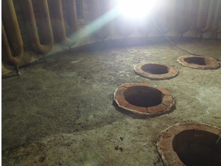
Imagem 2 - Piso do forno com aplicação de concreto isolante Thermbreak 403-G.
