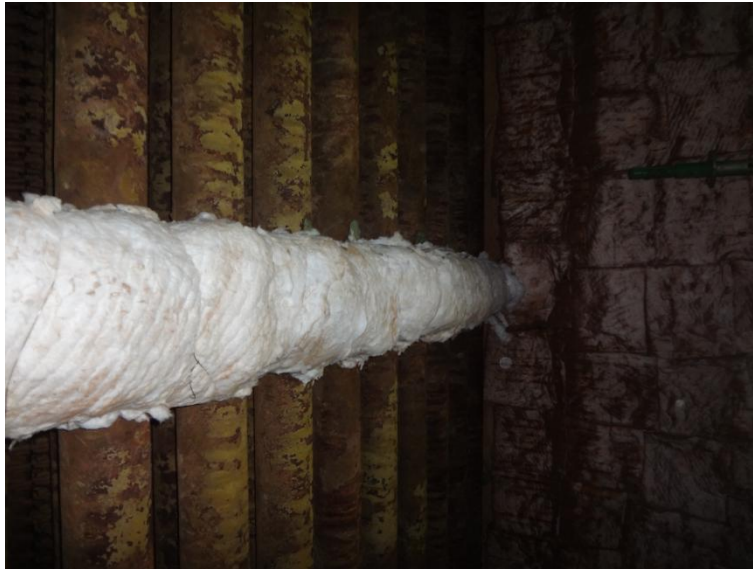
Imagem 17 - Detalhe da instalação do isolamento do suporte da serpentina do teto com manta de fibra cerâmica.
