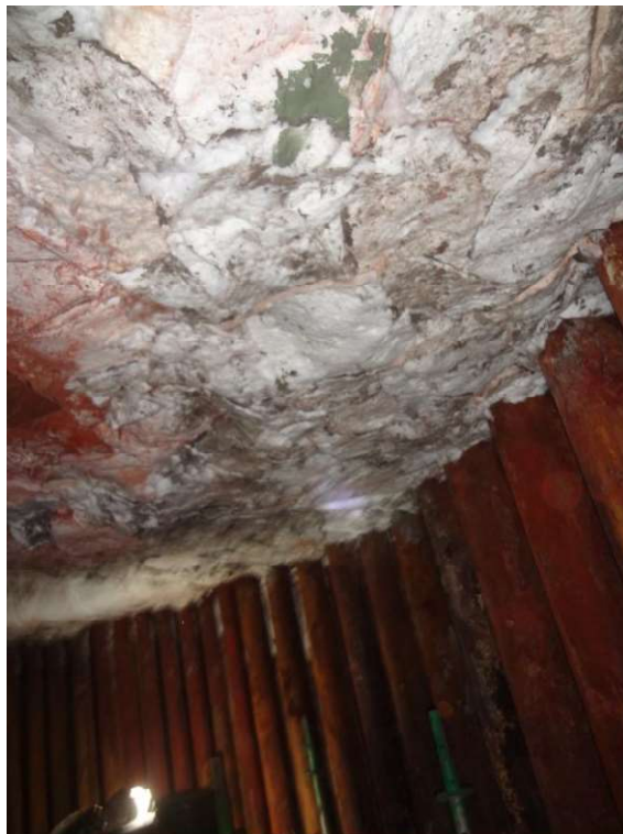
Imagem 14 - Detalhe da instalação de manta de fibra cerâmica no teto para complemento de espessura.
