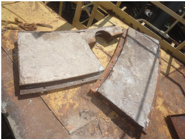
Imagem 30 - Detalhe das tampas das caixas de curva com concreto isolante.
