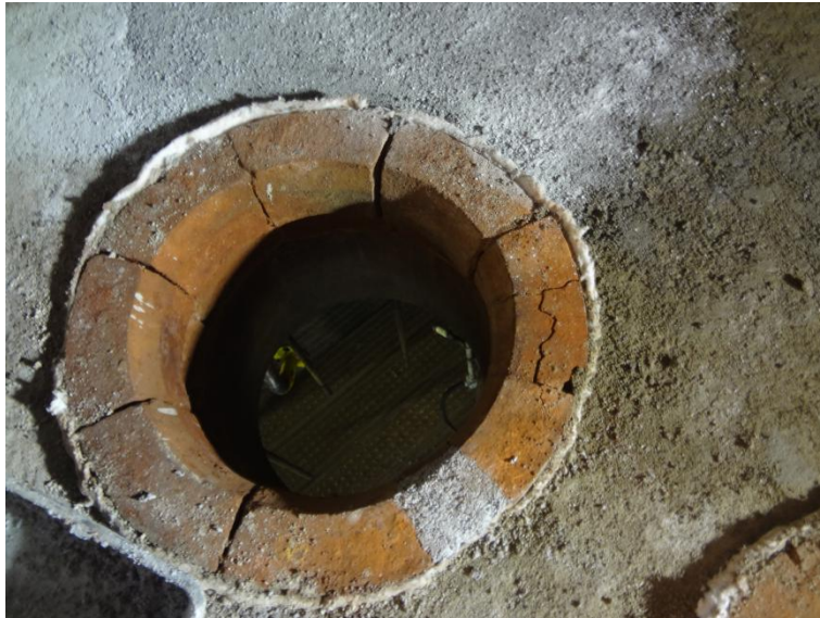
Imagem 8 - Reparo no blocos dos queimadores com concreto denso Thermbond 6-L e execução da junta com fibra cerâmica.
