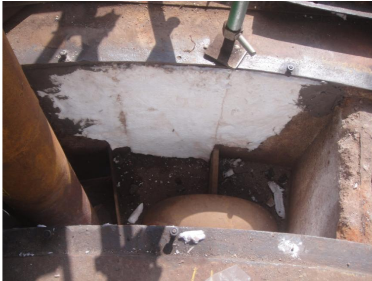
Imagem 29 - Detalhe da aplicação parcial de manta de fibra cerâmica nas caixas de curva.
