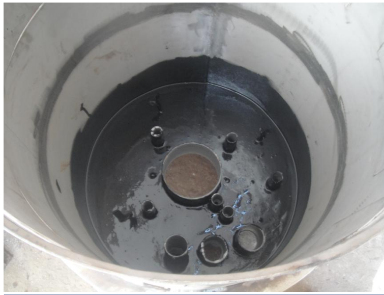
Imagem 10 - Detalhe da aplicação de massa anticorrosiva nos queimadores.
