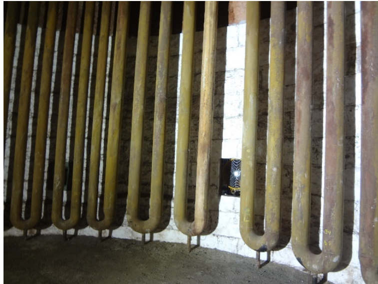
Imagem 5 - Parede com instalação de manta de fibra cerâmica.
