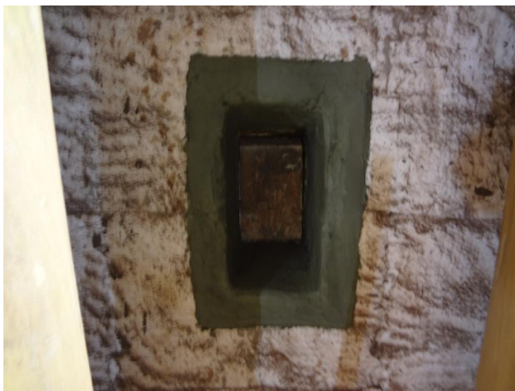
Imagem 23 - Detalhe dos visores de inspeção após recomposição.
