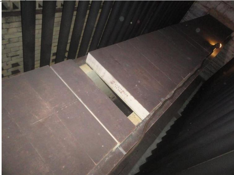
Imagem 5 - Região do piso central a ser instalada a placa de concreto.
