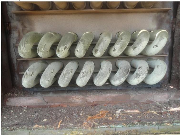
Imagem 10 - Caixas de curva a serem isoladas com manta de fibra cerâmica de densidade 96 kg/m<sup>3</sup>.
