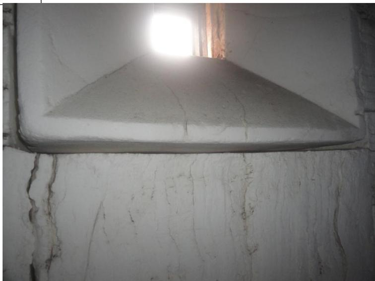
Imagem 7 - Região dos visores de inspeção a ser embrechada com manta de fibra cerâmica de densidade 96 kg/m<sup>3</sup>.
