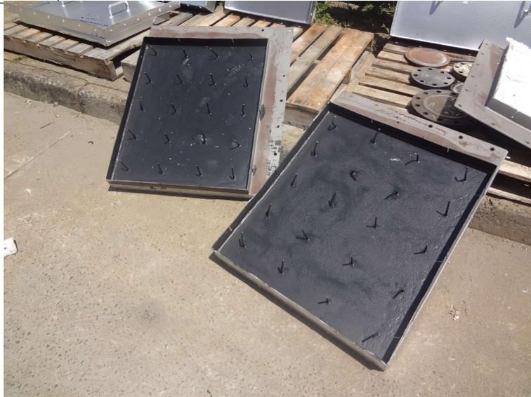
Imagem 1 - Aplicação da massa anticorrosiva nas tampas das caixas de curva.
