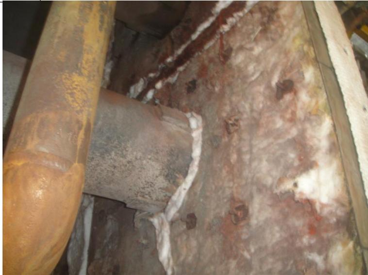
Imagem 12 - Vedação de tubos das caixas de curva com manta de fibra cerâmica de densidade 96 kg/m<sup>3</sup>.
