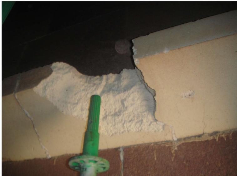
Imagem 13 - Placa lateral de piso a ser reparada com concreto denso Thermbond 6-L.
