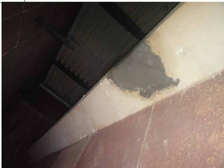
Imagem 14 - Reparo executado na placa lateral do piso com concreto denso Thermbond 6-L.
