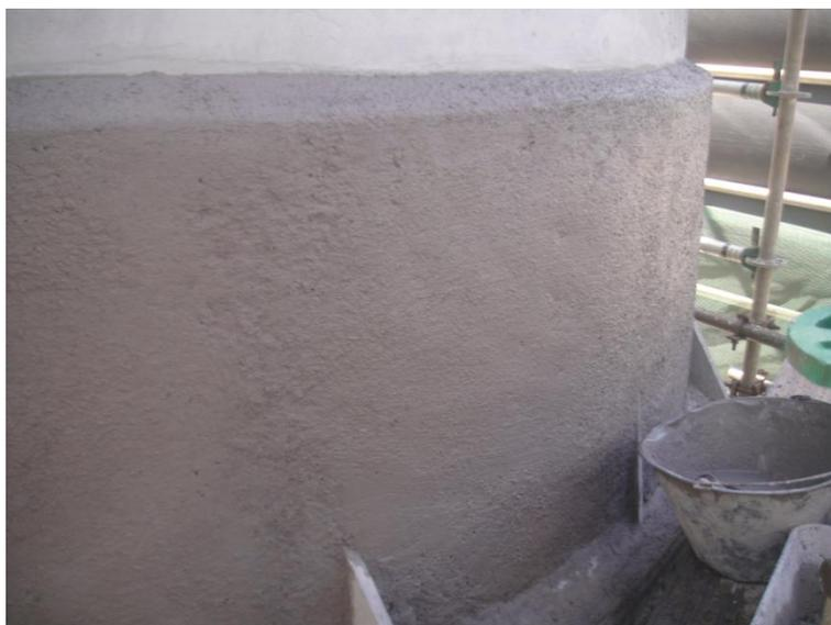
Imagem 16 - Recomposição do revestimento de proteção passiva contra incêndio (fireproofing) em concreto isolante PLW 41 da chaminé e tela de aço inox de malha quadrada 50x50 mm.
