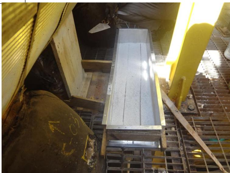
Imagem 3 - Fôrma montada para moldagem da placa do piso da região central.
