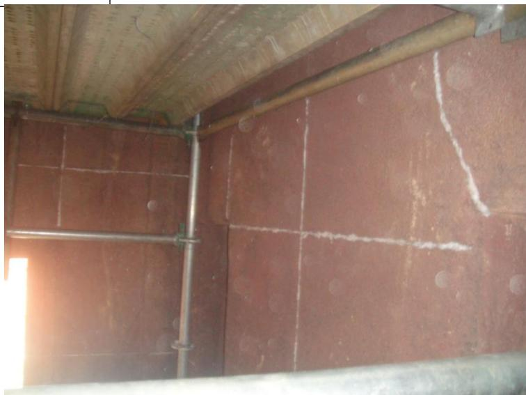
Imagem 9 - Embrechamento de trincas com manta de fibra cerâmica de densidade de 96 kg/m<sup>3</sup>.
