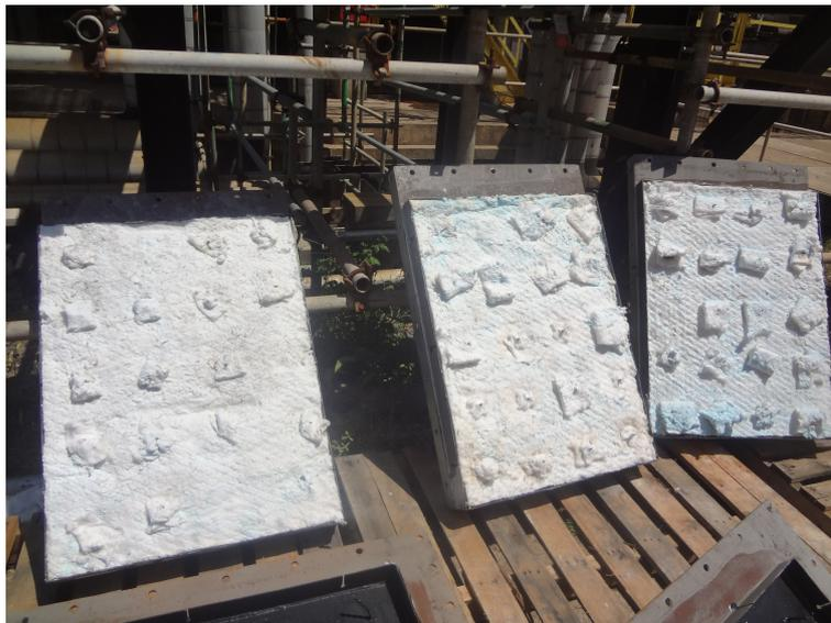
Imagem 2 - Isolamento das tampas das caixas de curva e proteção dos pinos de ancoragem com manta de fibra cerâmica de densidade 128 kg/m<sup>3</sup>.
