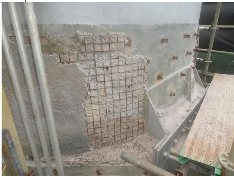
Imagem 15 - Demolição de revestimento de proteção passiva contra incêndio (fireproofing) em concreto isolante PLW 41 da chaminé e tela de aço inox de malha quadrada 50x50 mm.
