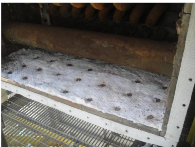
Imagem 11 - Isolamento das caixas de curva com manta de fibra cerâmica de densidade 96 kg/m<sup>3</sup>.
