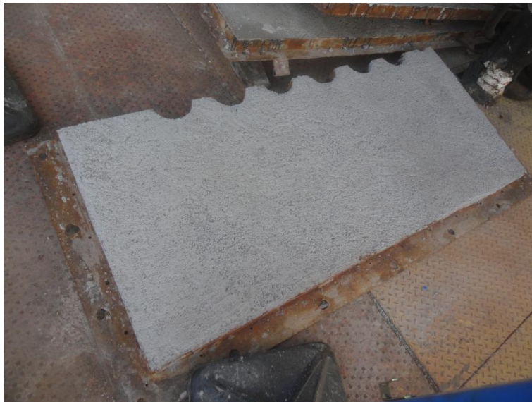
Imagem 18 - Tampa da caixa de curva da convecção após aplicação do concreto.
