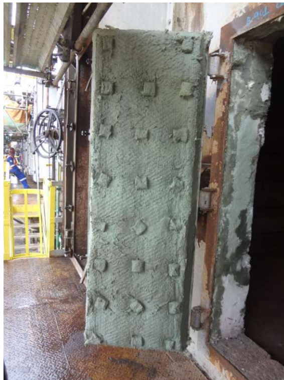
Imagem 2 - Porta de acesso após aplicação do Coat.
