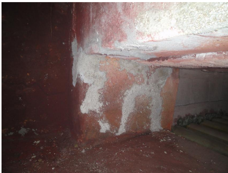
Imagem 16 - Aplicação de concreto isolante Castibar PLW 41 em viga da transição.
