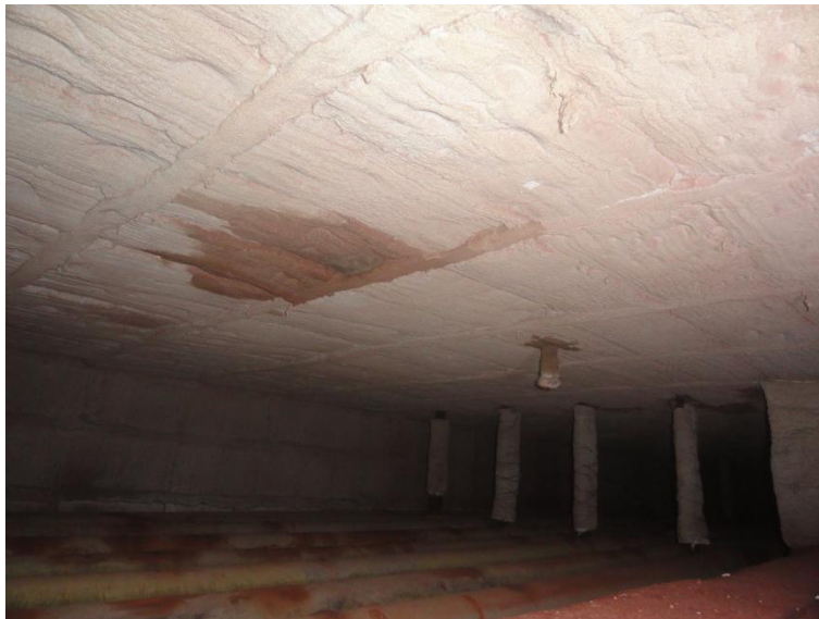
Imagem 13 - Recomposição com módulos de fibra cerâmica no teto da transição.
