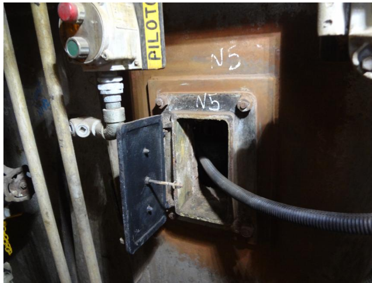
Imagem 22 - Aplicação de massa anticorrosiva nos visores de inspeção.
