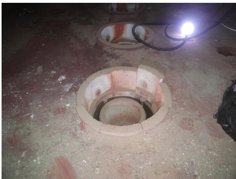
Imagem 11 - Alinhamento dos tijolos dos blocos secundários dos queimadores.
