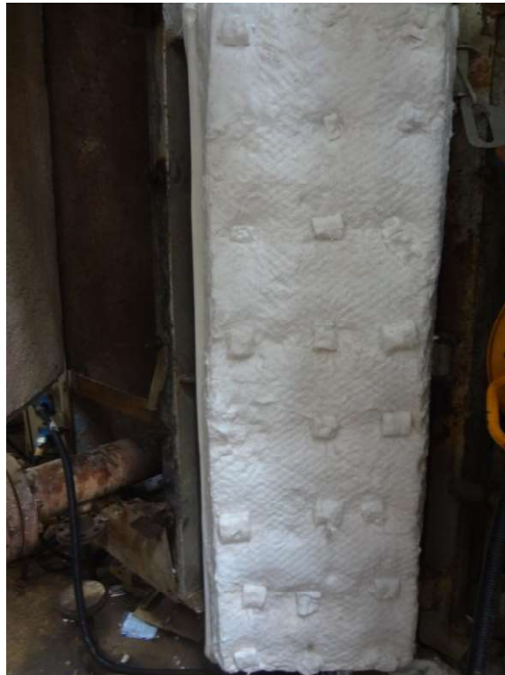
Imagem 1 - Porta de acesso após instalação da manta e proteção dos pinos.
