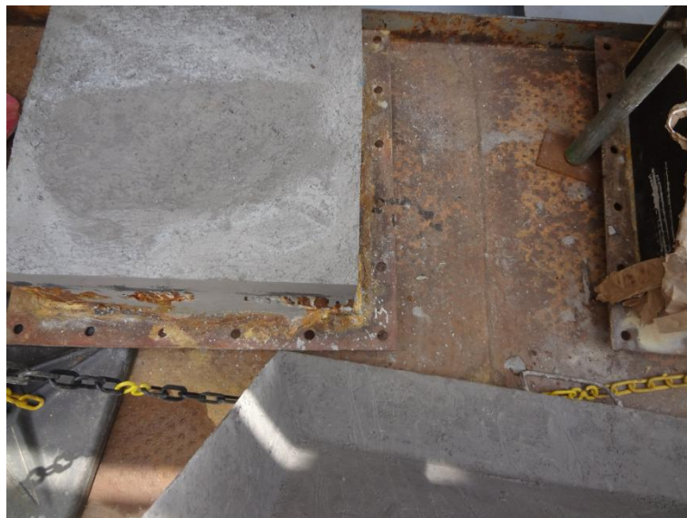
Imagem 26 - Substituição do concreto refratário da tampa da caixa de explosão.
