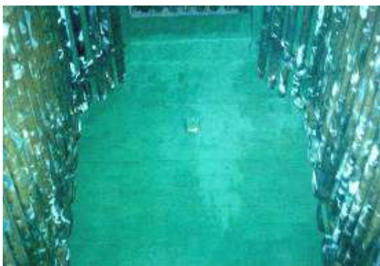
► Aplicação Manual – sobre módulos de fibra cerâmica Anchor Loc ®
