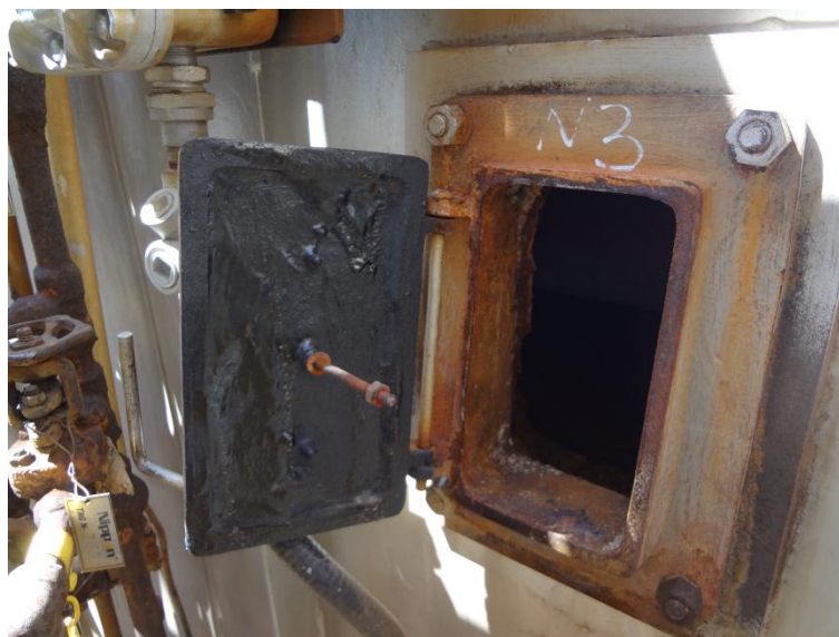
Imagem 21 - Aplicação de massa anticorrosiva nos visores de inspeção.
