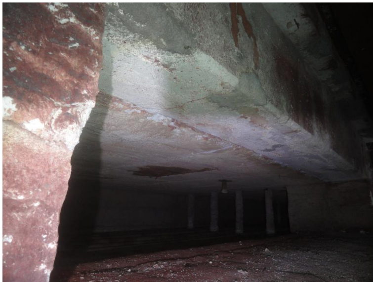
Imagem 15 - Recomposição dos módulos de fibra cerâmica no teto da transição.
