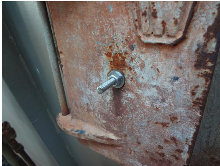
Imagem 23 - Barras roscadas de fixação do tijolo refratário fornecidas e instaladas nas portas dos visores de inspeção.
