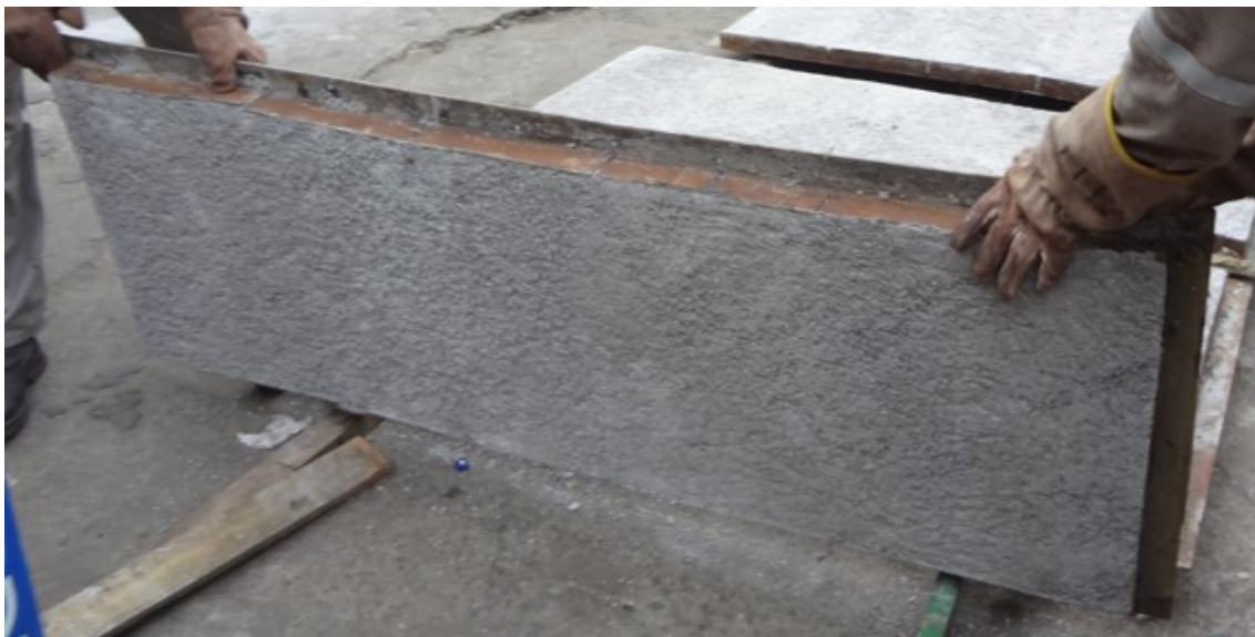
Imagem 6 - Tampa da caixa de curva da radiação após aplicação do refratário.
