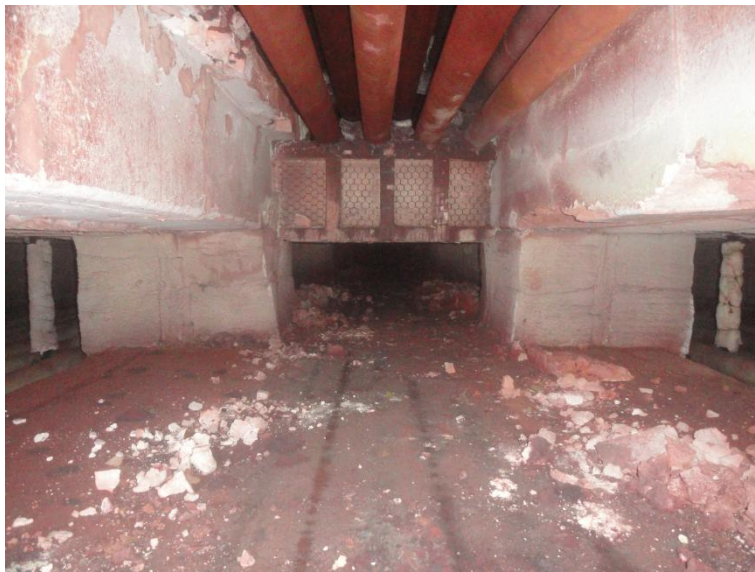
Imagem 14 - Recomposição dos módulos de fibra cerâmica no teto da transição.
