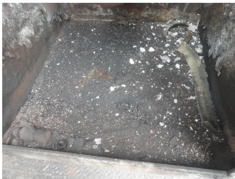
Imagem 19 - Massa anticorrosiva aplicada na caixa de fumaça.
