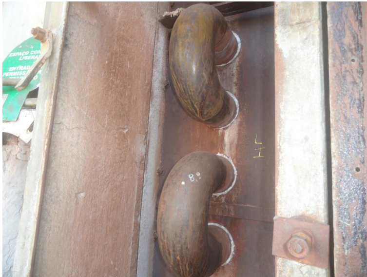
Imagem 4 - Vedação das caixas de curva da radiação.
