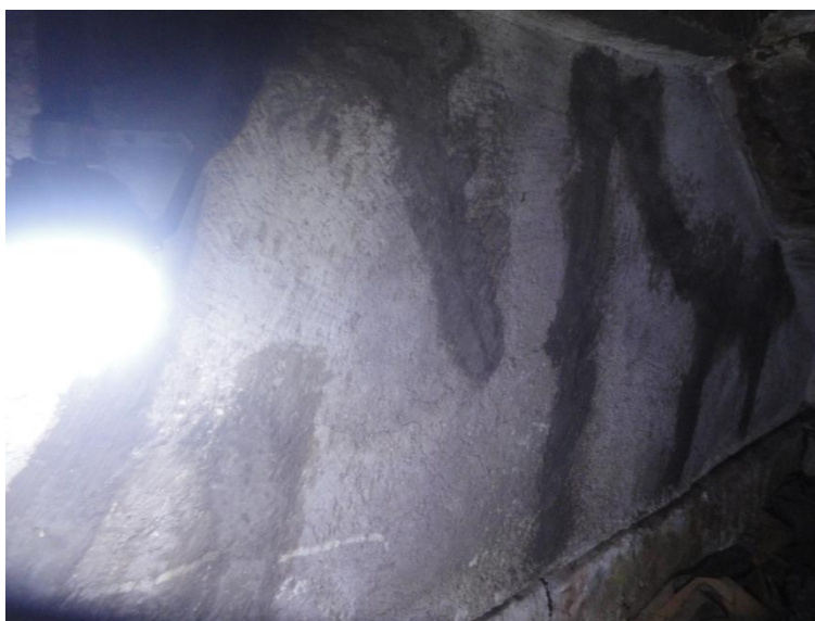
Imagem 12 - Recomposição de refratário na caixa de fumaça.
