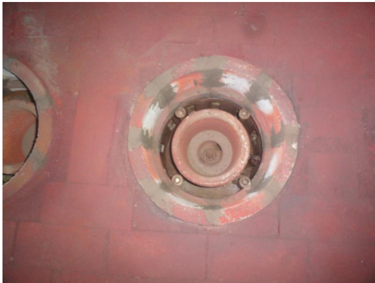
Imagem 8 - Alinhamento dos tijolos dos blocos secundários dos queimadores.
