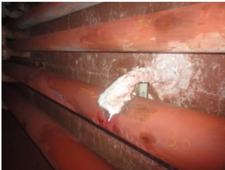
Imagem 6 - Isolamento dos skin points com fibra cerâmica.
