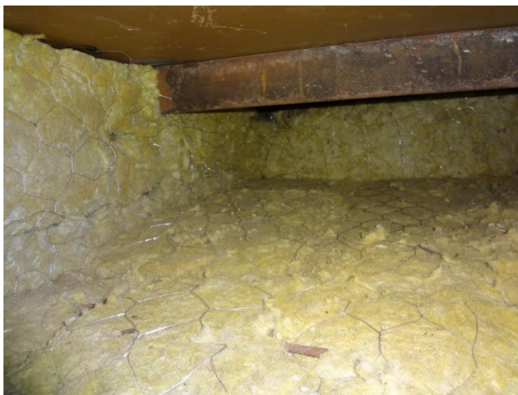
Imagem 13 - Lã de rocha telada no plenum dos queimadores.
