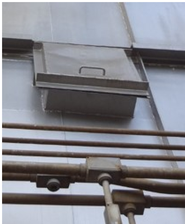
Imagem 18 - Caixa de explosão finalizada com embrechamento de manta de fibra cerâmica.
