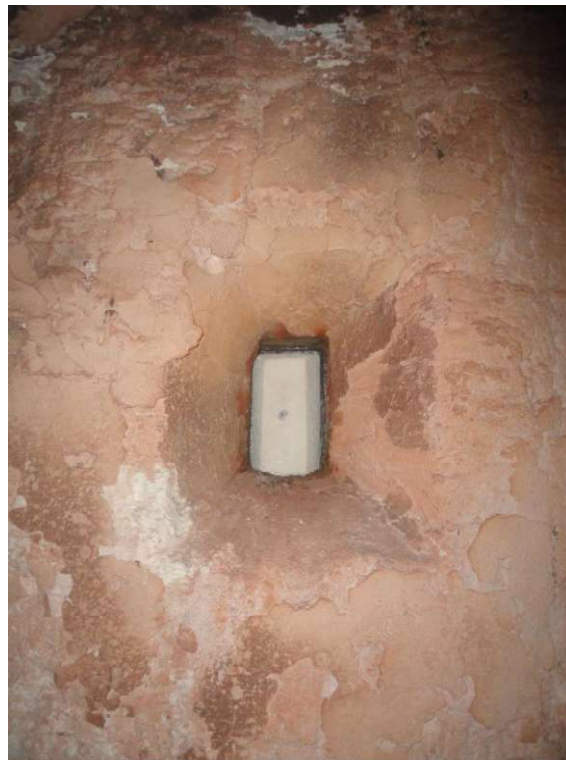
Imagem 16 - Vista interna da janela de explosão com tijolo refratário.
