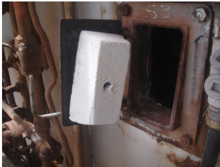
Imagem 15 - Janela de inspeção com tijolo refratário.
