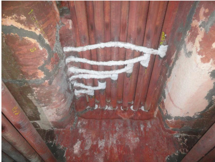
Imagem 5 - Isolamento dos skin points com fibra cerâmica e detalhe da recuperação da transição.
