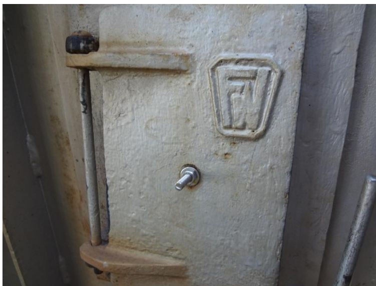
Imagem 14 - Barras roscadas de fixação de tijolo refratário fornecidas e instaladas nas portas dos visores de inspeção.
