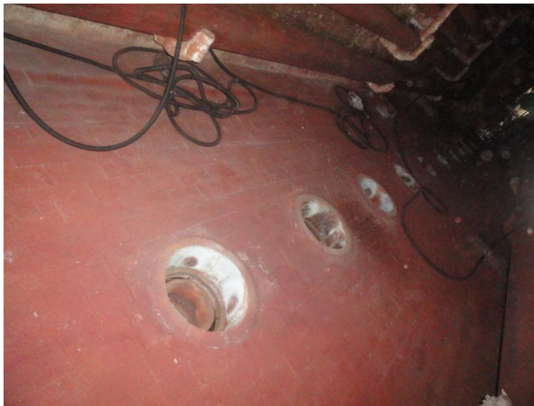
Imagem 7 - Alinhamento dos tijolos dos blocos secundários dos queimadores.
