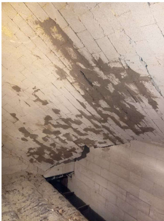
Imagem 24 - Reparo do revestimento refratário na área de retenção de cinzas.
