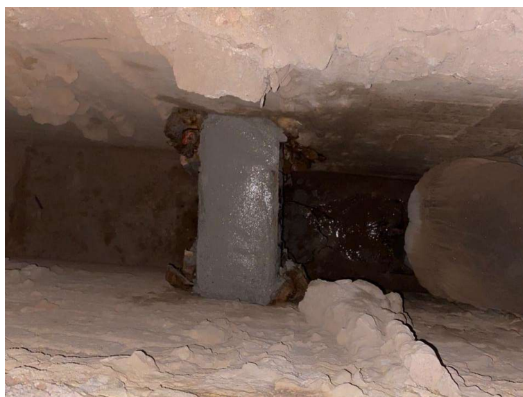
Imagem 26 - Reparo de invólucro refratário de viga de sustentação da fornalha.
