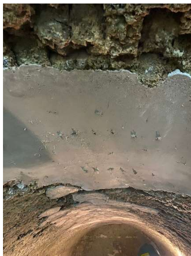
Imagem 19 - Fechamento da chaminé seccionada na região do teto da fornalha com concreto em substituição aos tijolos refratários.
