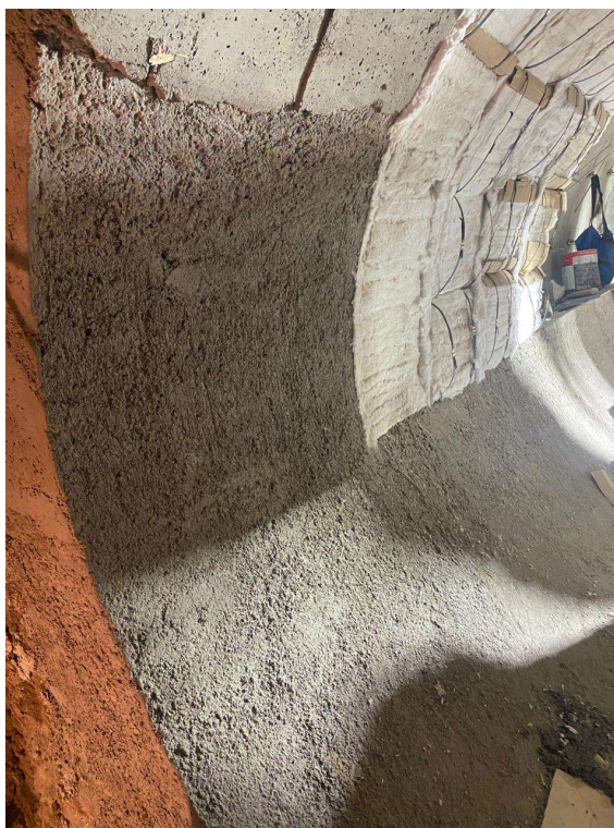
Imagem 10 - Concretagem na transição.
