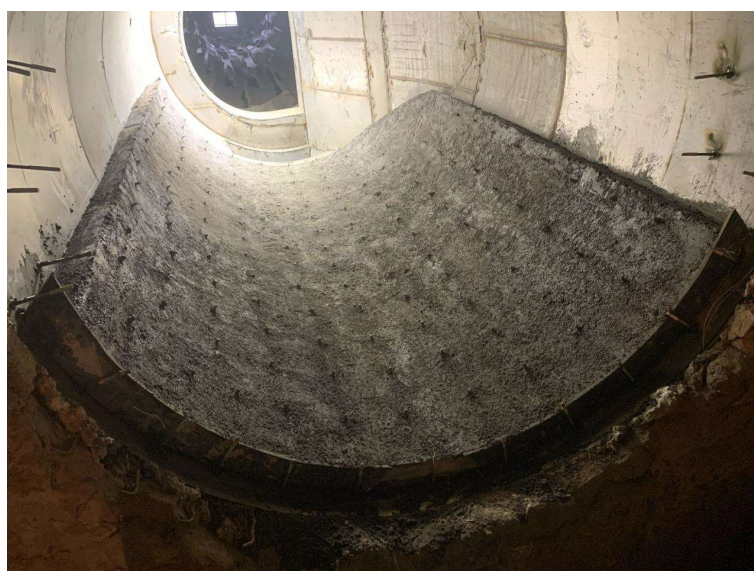
Imagem 8 - Concretagem na transição.
