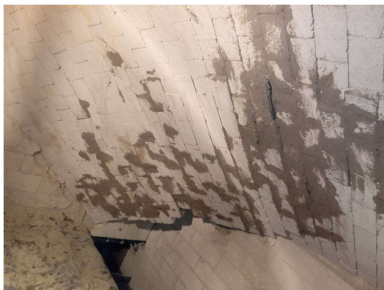
Imagem 23 - Reparo do revestimento refratário na área de retenção de cinzas.
