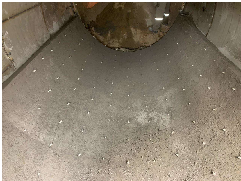
Imagem 4 - Concretagem na transição.
