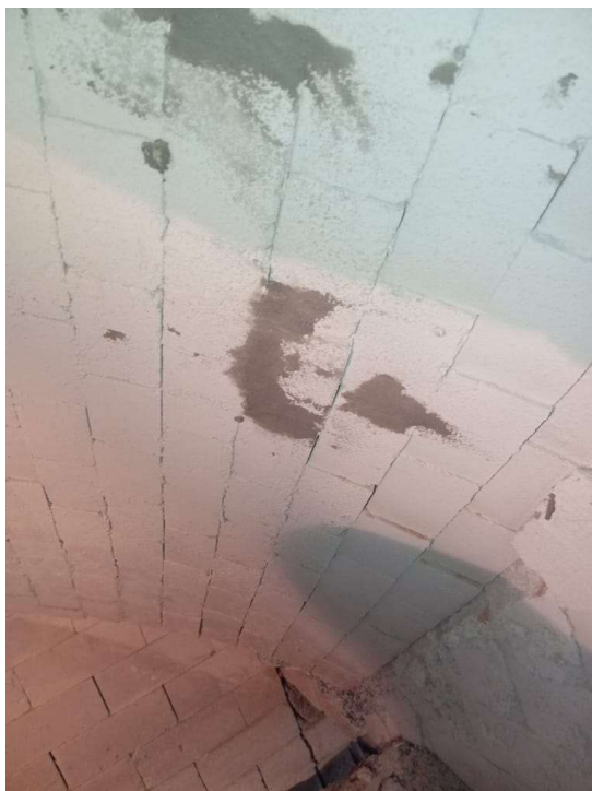
Imagem 25 - Reparo do revestimento refratário na área de retenção de cinzas.
