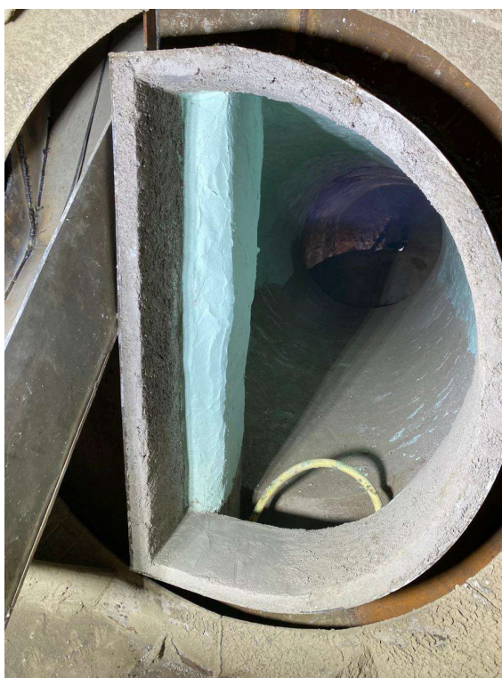
Imagem 16 - Aplicação de massa Silplate na transição e concretagem na meia lua.
