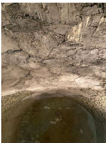
Imagem 20 - Reparo de regiões do teto com perda de espessura com Thermbond 6-P.
