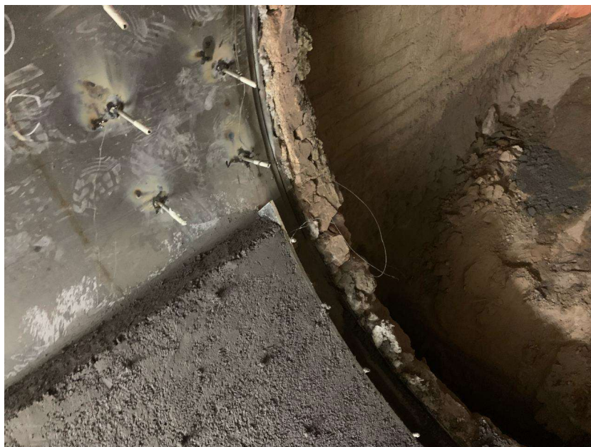
Imagem 6 - Concretagem na transição.
