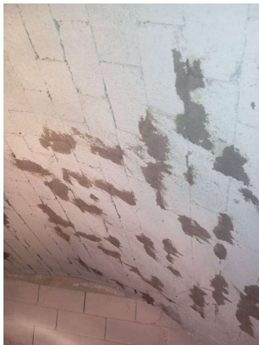
Imagem 22 - Reparo do revestimento refratário na área de retenção de cinzas.
