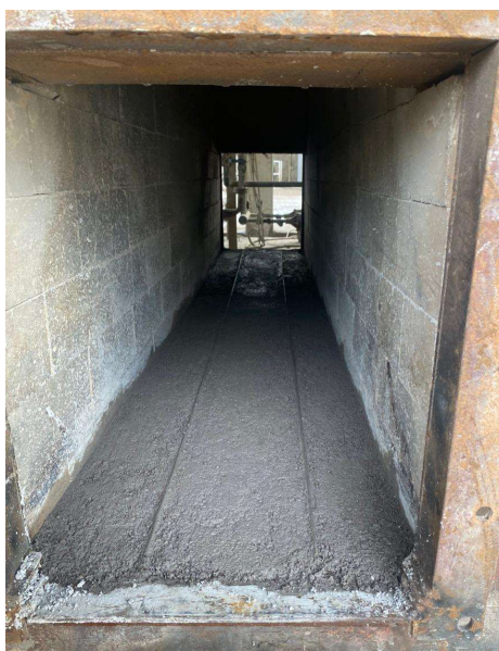
Imagem 29 - Concretagem do trilho do header entre a fornalha e o duto.
