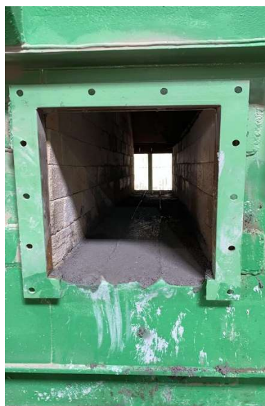
Imagem 30 - Concretagem do trilho do header na fornalha.
