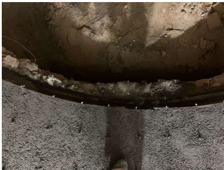
Imagem 7 – Concretagem na transição.
