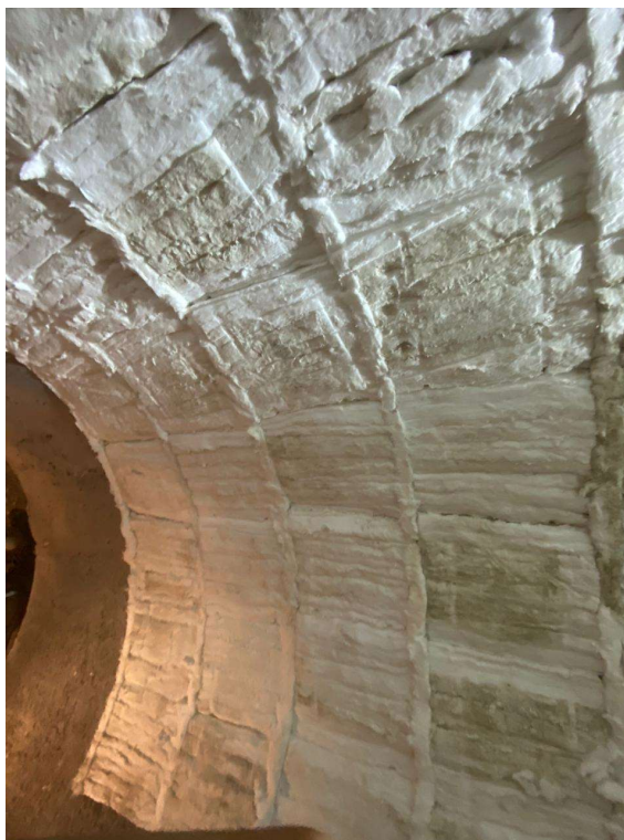
Imagem 13 - Aplicação de módulos na transição.
