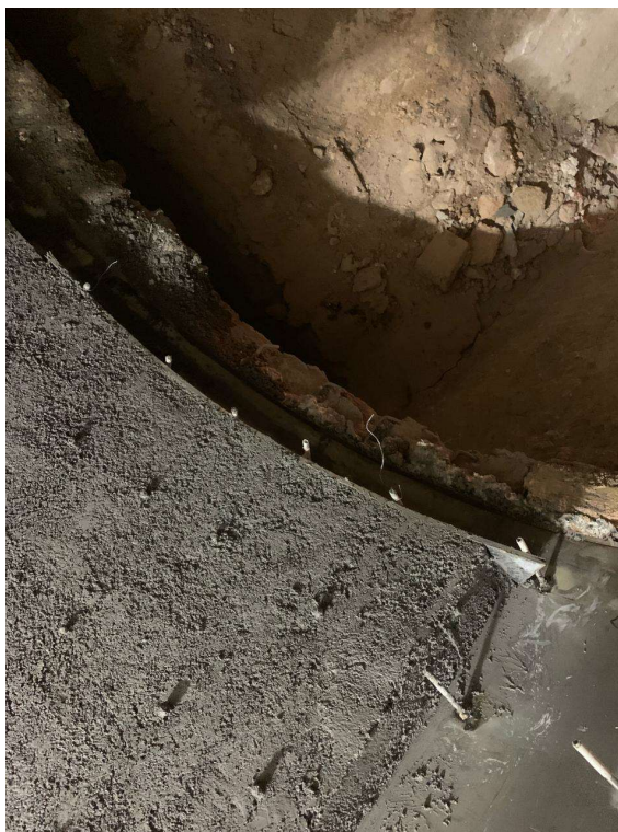
Imagem 3 - Concretagem na transição.
