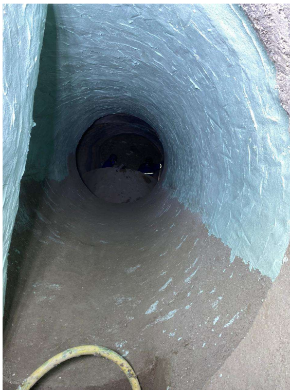
Imagem 15 - Aplicação de massa Silplate na transição.
