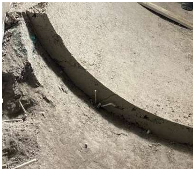
Imagem 9 - Detalhe da concretagem da segunda camada de concreto com o pino de ancoragem utilizado na transição.
