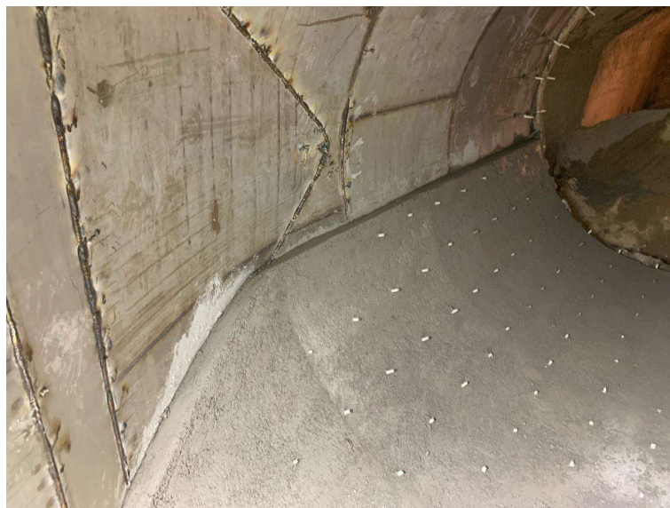
Imagem 5 - Concretagem na transição.
