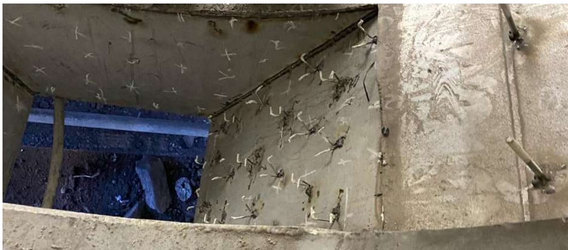
Imagem 17 - Detalhe das ancoragens aplicadas na junta entre a transição e a fornalha para aplicação de Castibar N.
