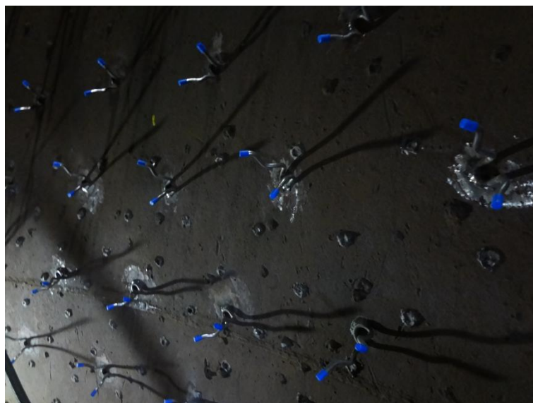
Imagem 6 - Proteção dos novos pinos de ancoragem com caps plásticos para receber o preenchimento de concreto isolante agulhado.
