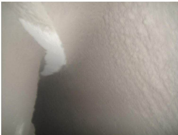
Imagem 16 - Calota superior após a projeção do concreto isolante agulhado.
