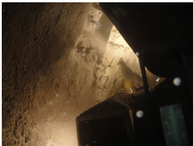
Imagem 15 - Refratário na região interna da calota superior antes da demolição e projeção do concreto agulhado.
