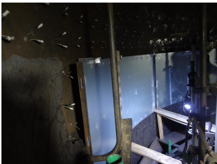
Imagem 10 - Montagem das fôrmas para delimitar os níveis ou "anéis" de derramamento do concreto agulhado no corpo cilíndrico e garantir a espessura correta do revestimento.
