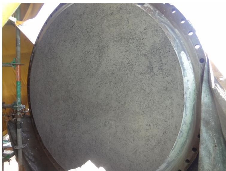
Imagem 21 - Tampa da BV de 74" do regenerador após recomposição do refratário com concreto isolante PLW-41.
