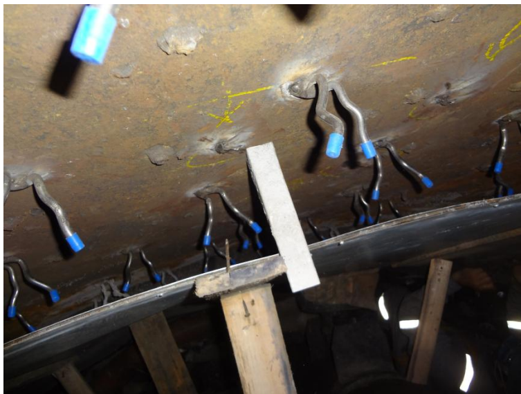
Imagem 9 - Montagem das fôrmas para delimitar os níveis ou "anéis" de derramamento do concreto agulhado no corpo cilíndrico e garantir a espessura correta do revestimento.
