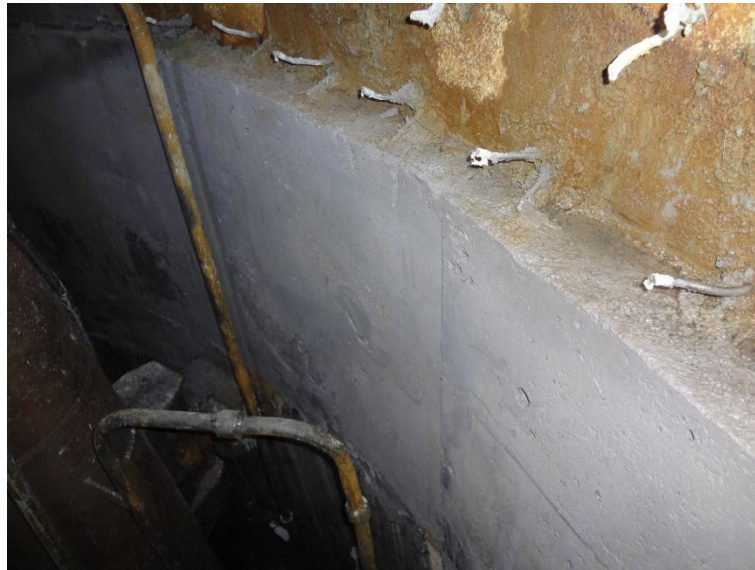
Imagem 13 - Anel de concreto agulhado após ter a fôrma removida e passar pelo processo de cura.
