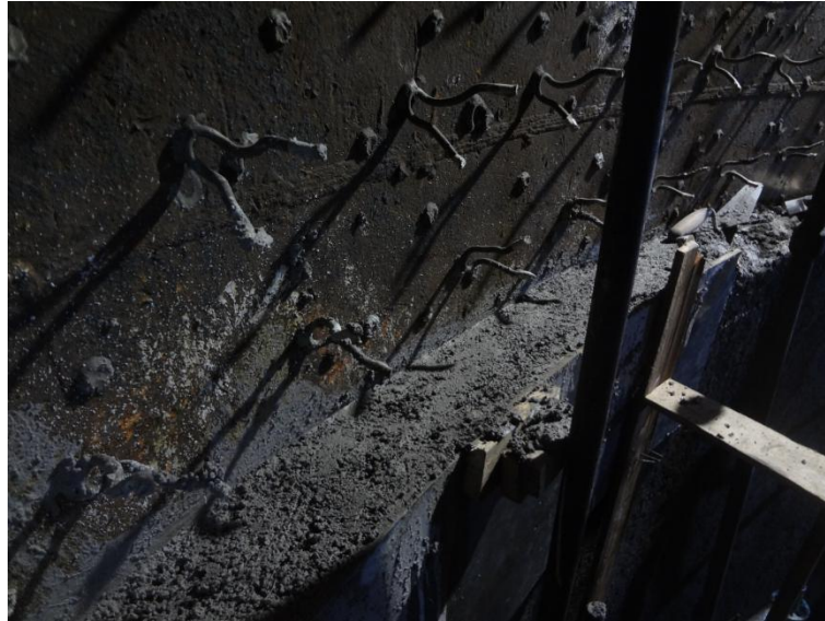
Imagem 11 - Concreto agulhado derramado nas fôrmas.
