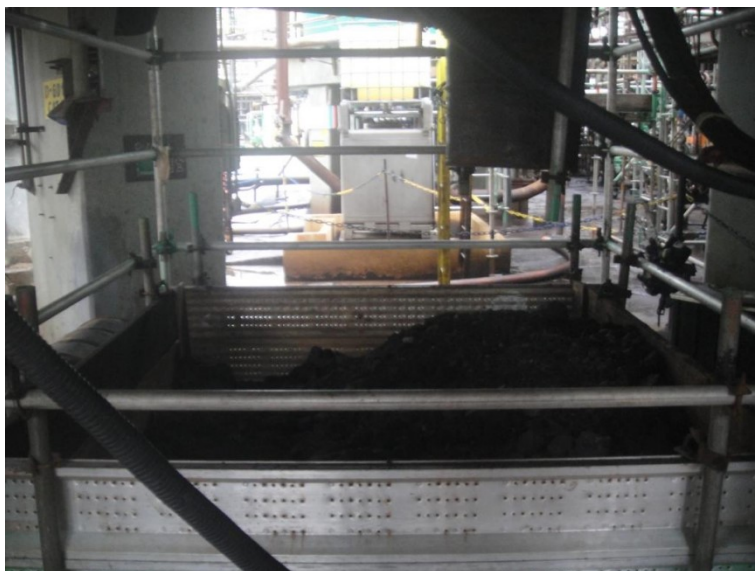
Imagem 5 - Caixa montada com material de andaime para acomodação de resíduos de demolição.
