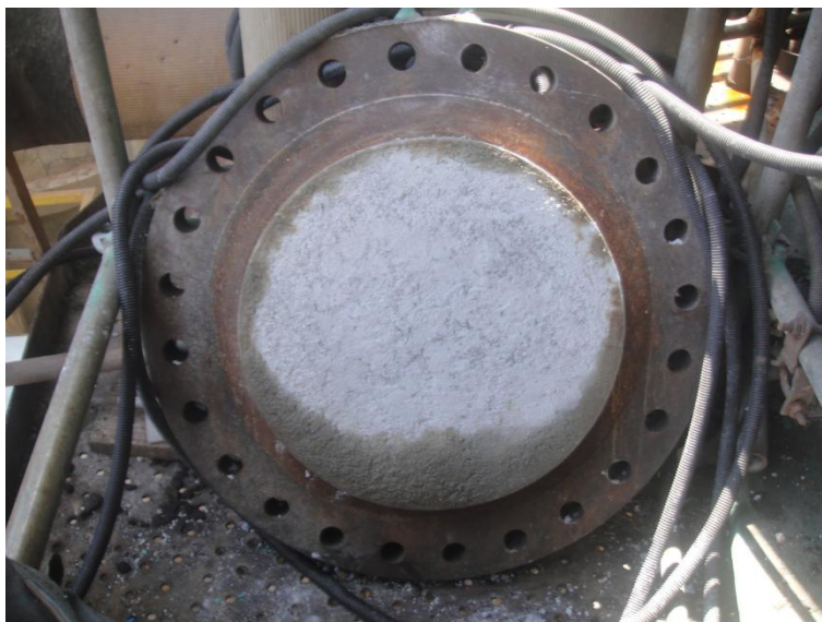
Imagem 17 - Tampa da BV de 24" do conversor após aplicação de concreto denso Thermbond 6-L.
