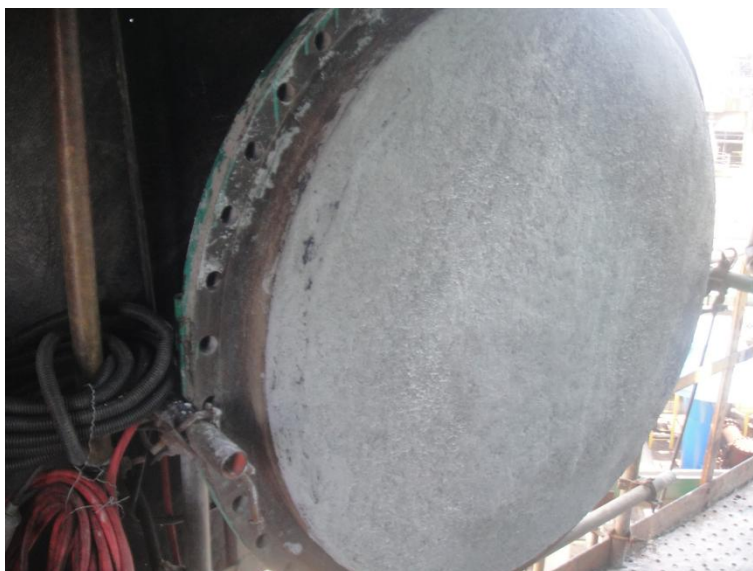
Imagem 19 - Refratário da tampa da BV de 54" do conversor após a restauração com concreto isolante PLW-41.
