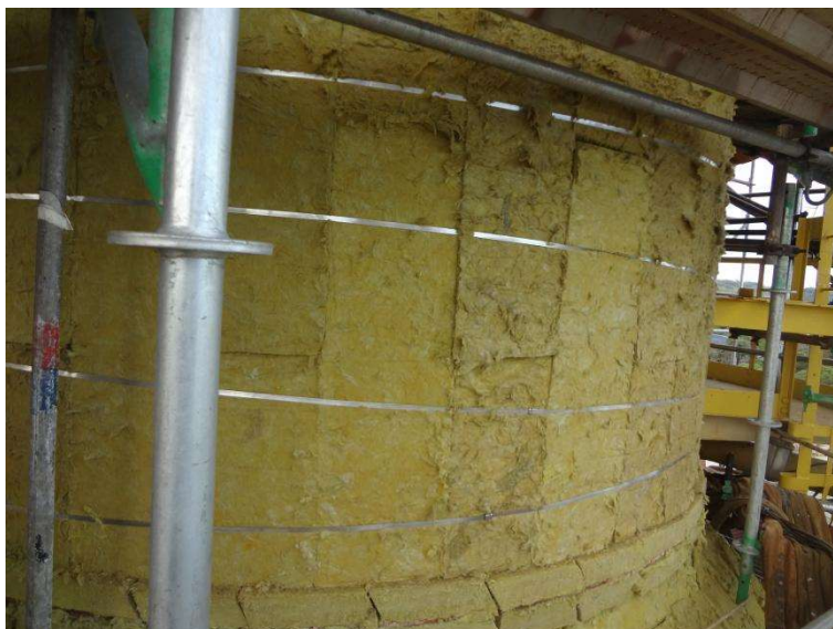
Imagem 3 - Isolamento em lã de rocha com fixação por cinta de aço inoxidável de 19 mm.
