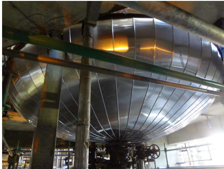
Imagem 5 - Jaqueta de proteção do isolamento com chapa de alumínio liso de 1 mm no boleado inferior.
