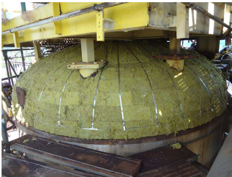
Imagem 4 - Isolamento em lã de rocha com fixação por cinta de aço inoxidável de 19 mm.
