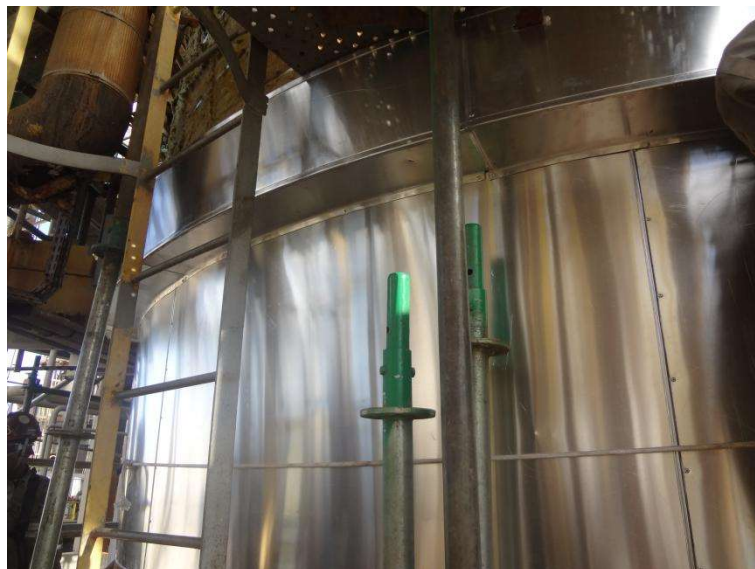
Imagem 6 - Jaqueta de proteção do isolamento com chapa de alumínio liso de 1 mm no costado.
