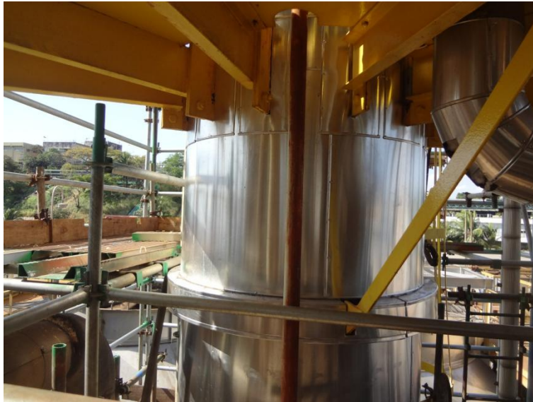
Imagem 6 - Região do costado e anel de vácuo onde houve recomposição com painéis de lã de rocha e chapas de alumínio liso conforme definição da inspeção.
