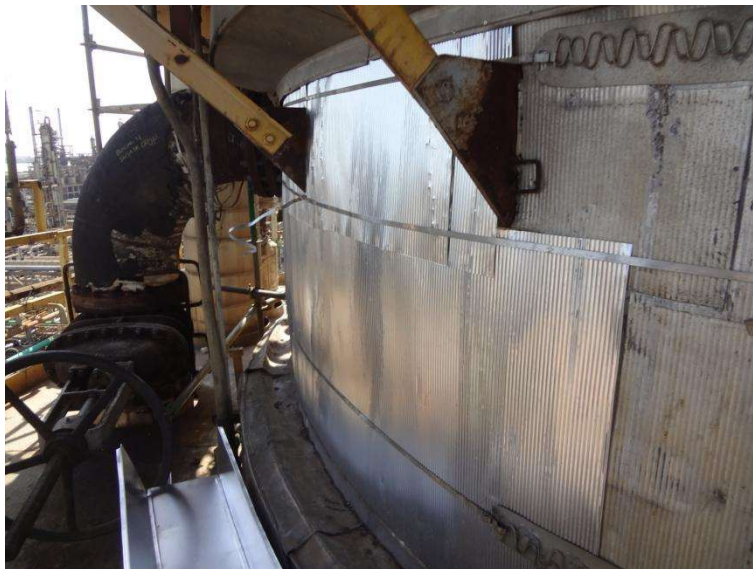
Imagem 5 - Região do costado após sobreposição da jaqueta de proteção com chapa de alumínio corrugado.
