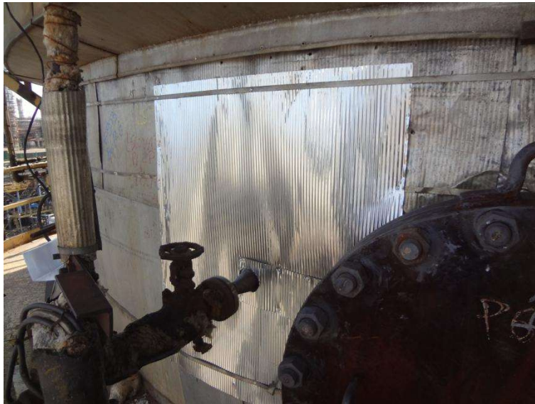
Imagem 4 - Região do costado após sobreposição da jaqueta de proteção com chapa de alumínio corrugado.
