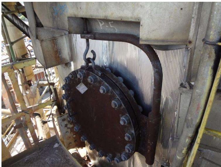
Imagem 7 - Região do costado em volta de BV após sobreposição na jaqueta de proteção com chapa de alumínio corrugado.
