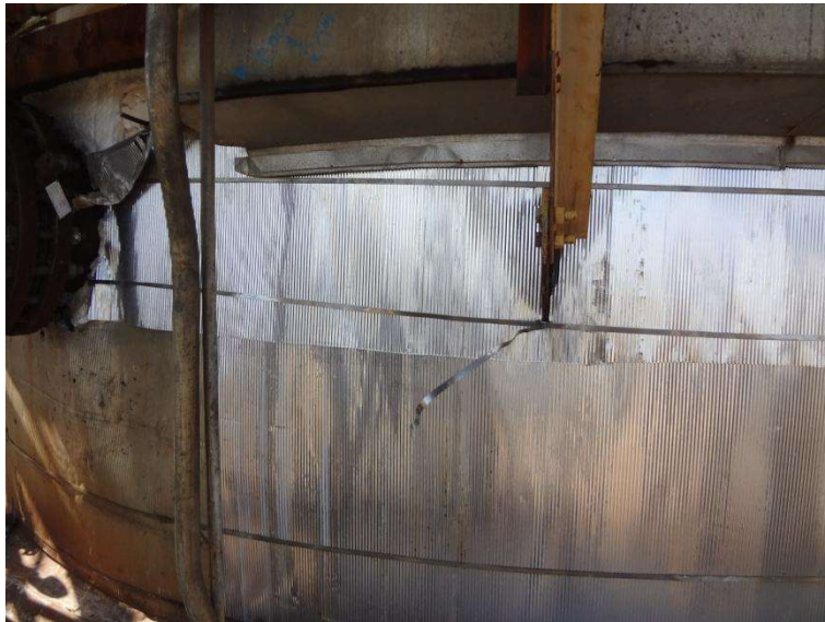
Imagem 6 - Região do costado após sobreposição da jaqueta de proteção com chapa de alumínio corrugado.
