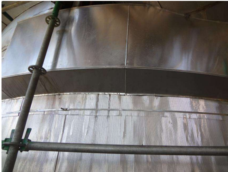
Imagem 2 - Região do costado e anel de vácuo após instalação da jaqueta de proteção com chapa de alumínio corrugado e liso.
