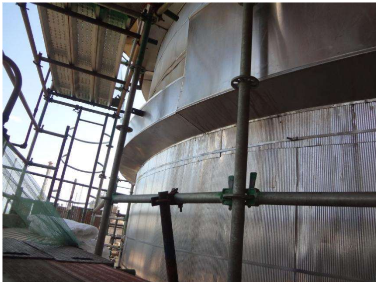
Imagem 3 - Região do costado e anel de vácuo após instalação da jaqueta de proteção com chapa de alumínio corrugado e liso.
