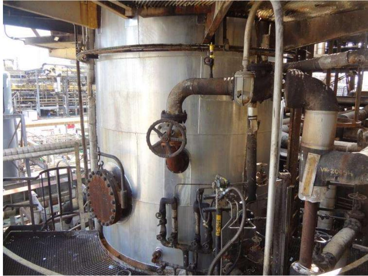
Imagem 2 - Recomposição do costado da torre E-906 A/B com manta de fibra cerâmica e finalização com chapa de alumínio liso.
