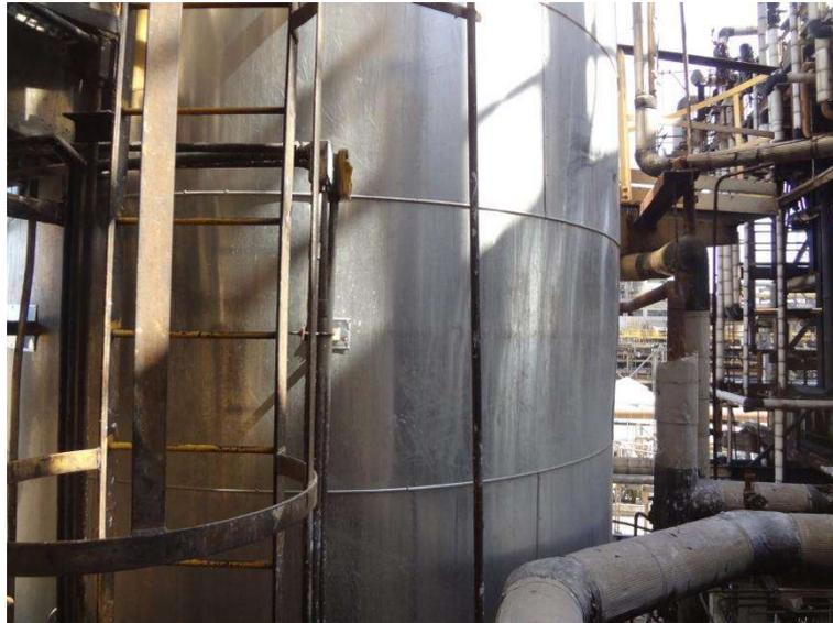
Imagem 4 - Recomposição do costado da torre E-906 A/B com manta de fibra cerâmica e finalização com chapa de alumínio liso.
