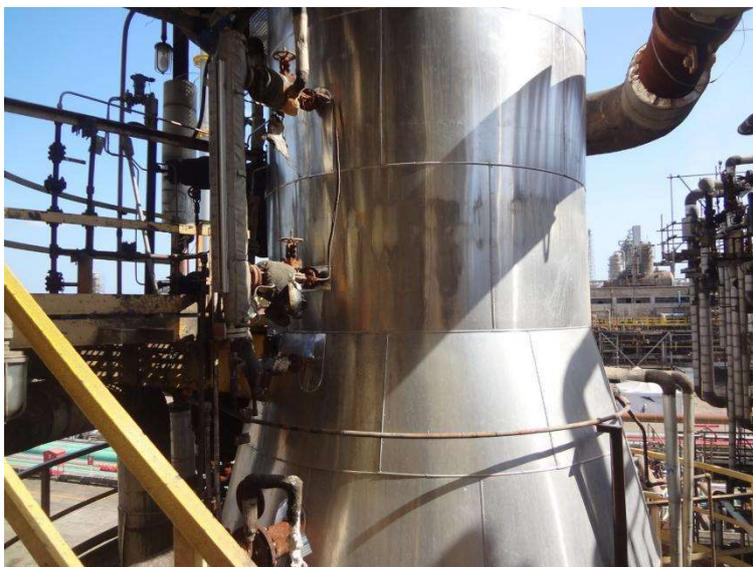
Imagem 6 - Recomposição do costado da torre E-906 A/B com manta de fibra cerâmica e finalização com chapa de alumínio liso.
