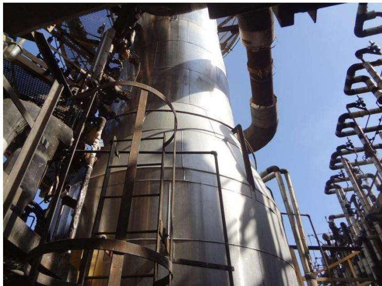
Imagem 3 - Recomposição do costado da torre E-906 A/B com manta de fibra cerâmica e finalização com chapa de alumínio liso.
