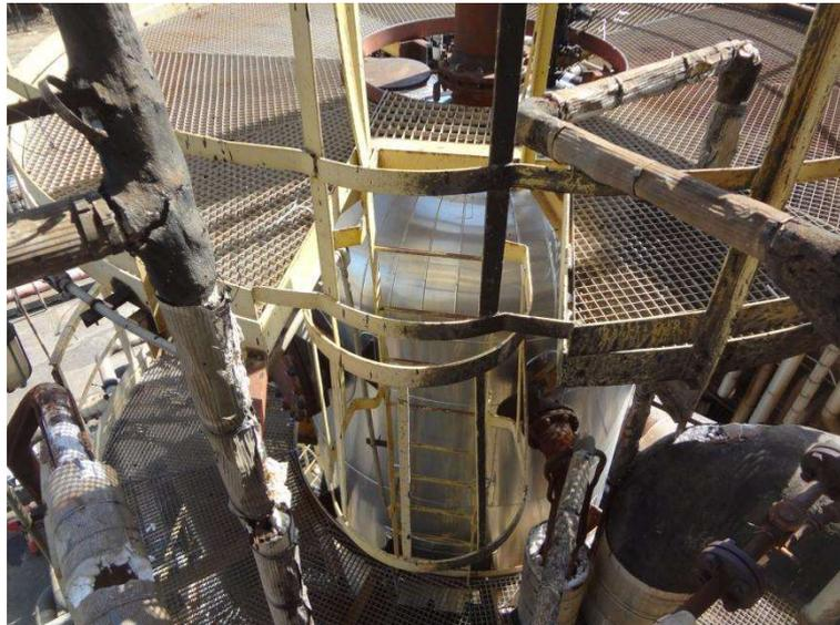
Imagem 5 - Recomposição do costado da torre E-906 A/B com manta de fibra cerâmica e finalização com chapa de alumínio liso.
