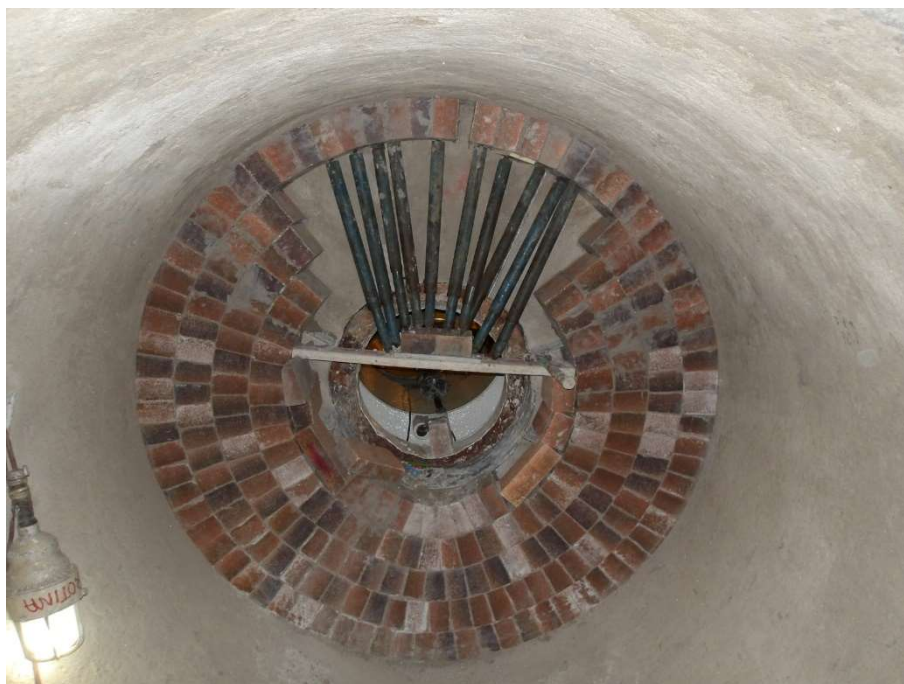
Figura 29 – Utilização de macacos para escoramento dos tijolos Alumibar 95 ES na parede do queimador.
