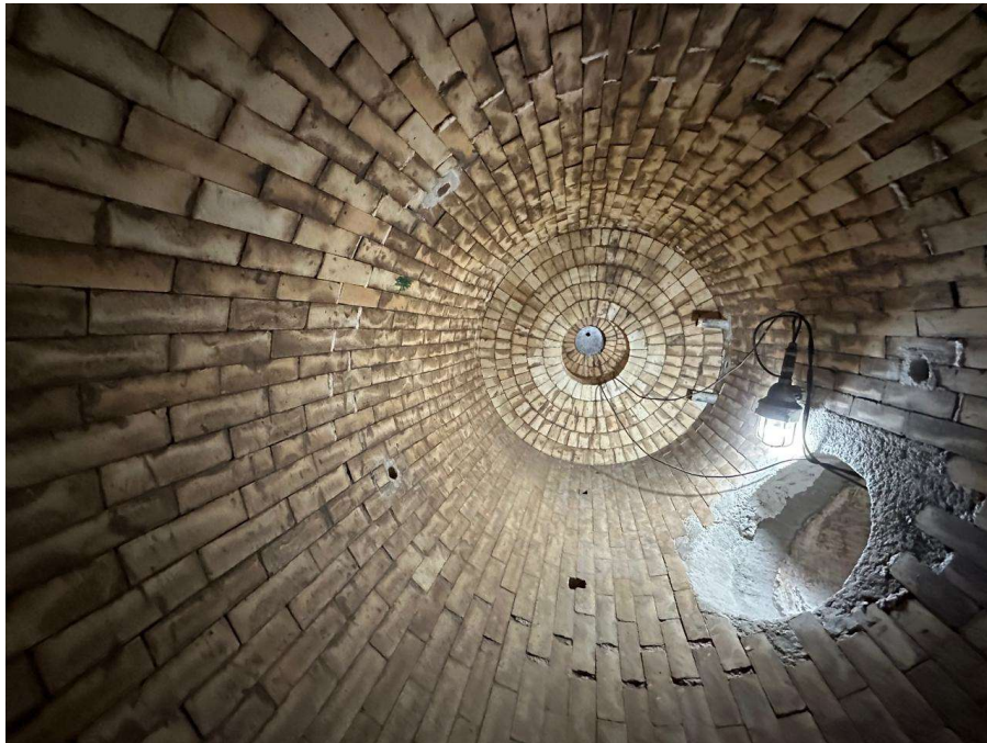
Figura 47 – Vista do vaso incinerador com a redução para a chaminé ao fundo após a conclusão da instalação do refratário conformado.
