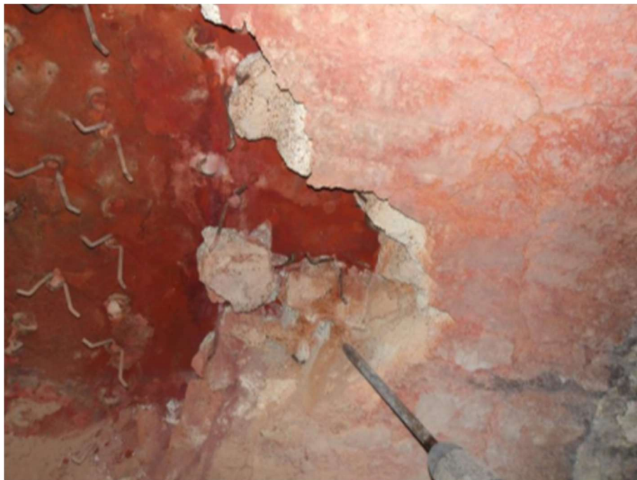
Figura 5 – Demolição do concreto refratário do vaso incinerador com martetele elétrico.
