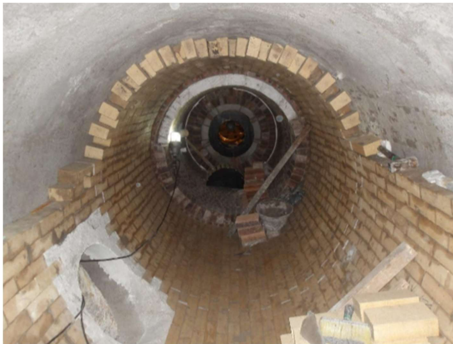
Figura 38 – Instalação dos tijolos Alumibar 70.
