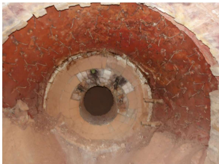
Figura 3 - Remoção dos tijolos e demolição do concreto refratário na região da redução do vaso incinerador.
