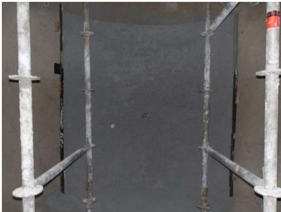
Figura 65 – Região da camada de 189 mm após concretagem com antierosivo classe C.
