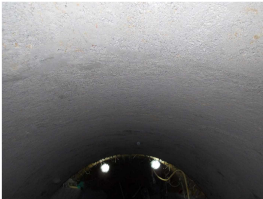
Figura 19 - Aplicação de concreto isolante Castibar PLW 41.
