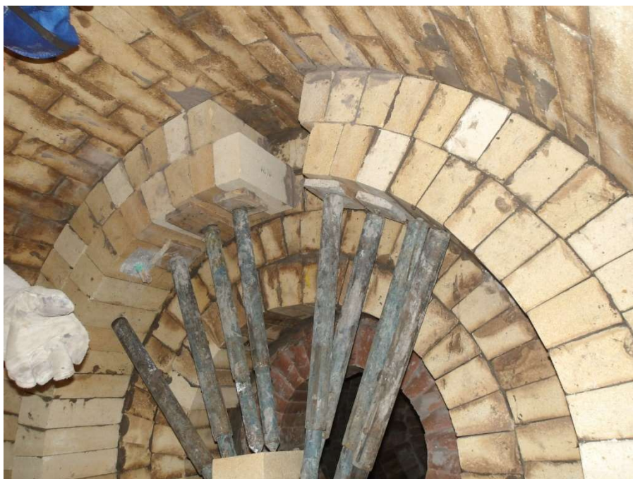
Figura 42 – Utilização de escoramento com pontalotes na instalação da geratriz superior nas paredes de contenção na redução próximo à chaminé.
