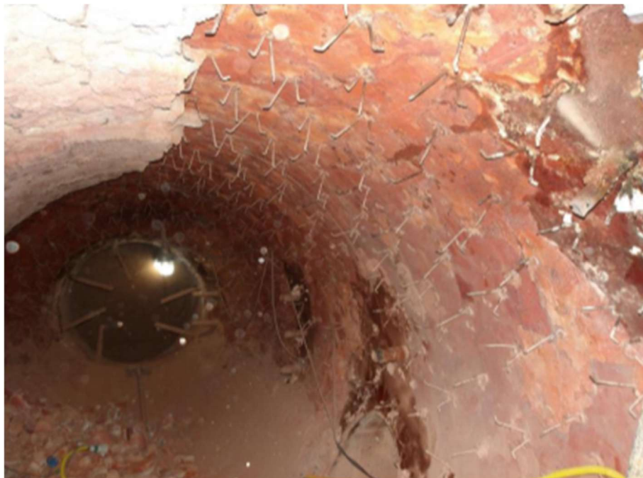
Figura 6 - Situação do costado durante a demolição do concreto refratário do vaso incinerador.
