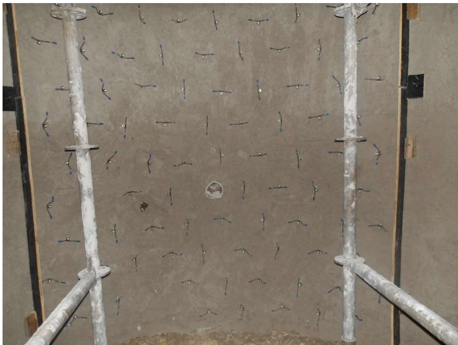
Figura 58 – Grampos “Y” na região de camada de 189 mm com as mestras posicionadas para a concretagem com o concreto antierosivo classe C.
