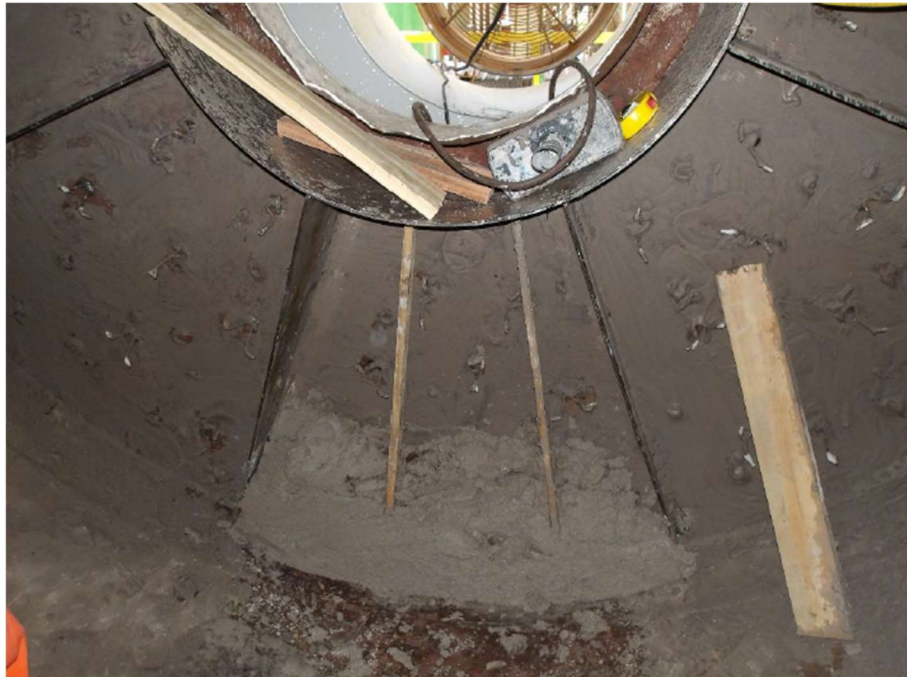
Figura 12 – Início da concretagem da parede do queimador.
