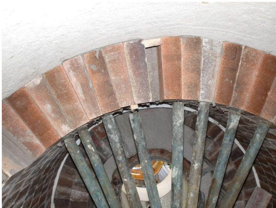
Figura 30 – Detalhe da utilização do escoramento nos tijolos Alumibar 95 ES.
