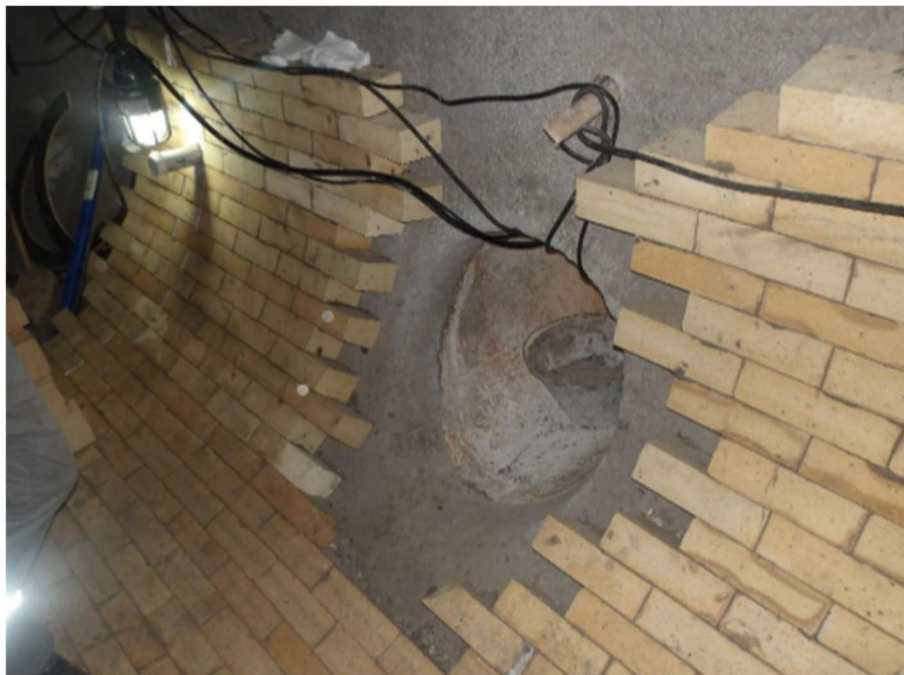
Figura 37 – Instalação dos tijolos Alumibar 70 na região da BV.
