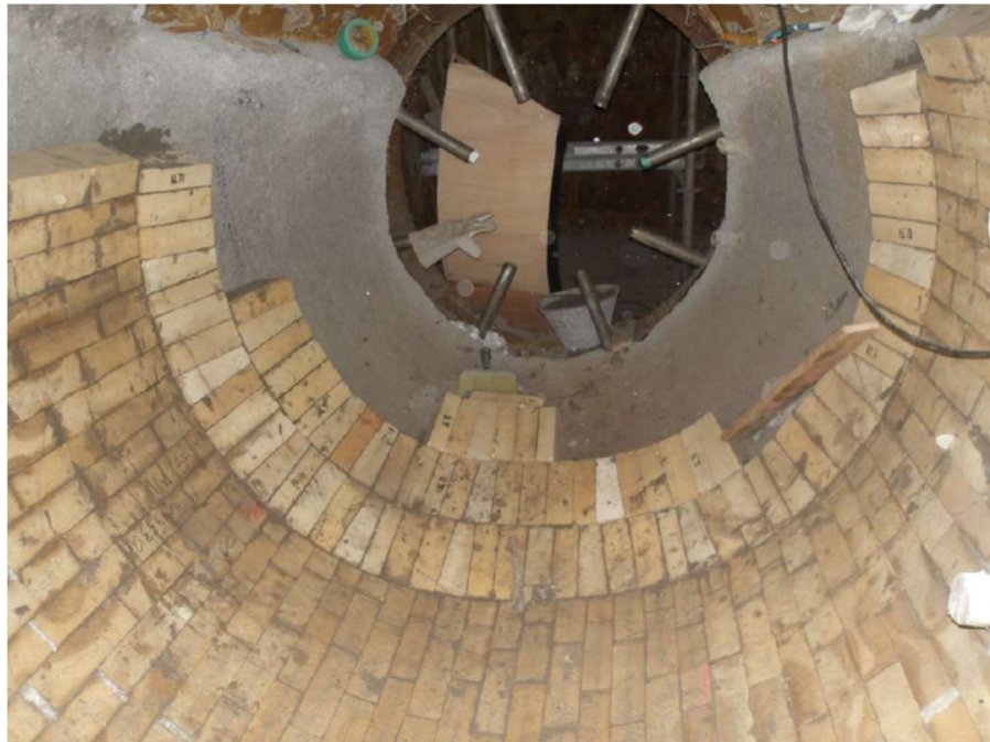
Figura 40 – Instalação dos tijolos Alumibar 70 na redução.
