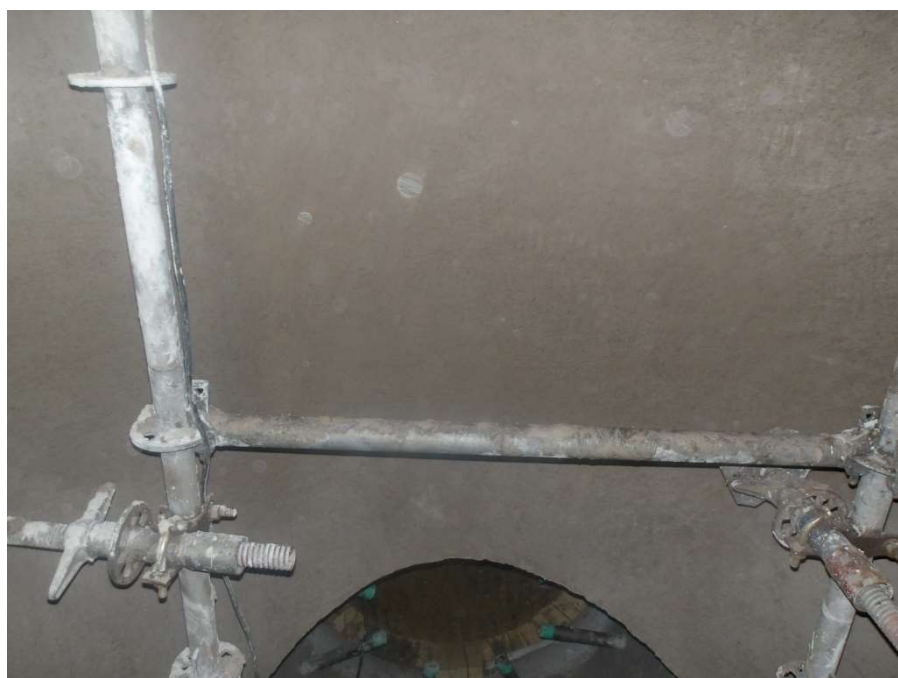
Figura 63 – Concretagem da chaminé com anti-erosivo na região da saída do duto de interligação com o vaso incinerador.
