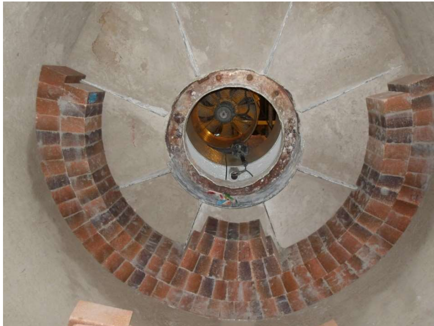
Figura 25 – Sequência de instalação das camadas da primeira fiada de tijolo Alumibar 95 ES.
