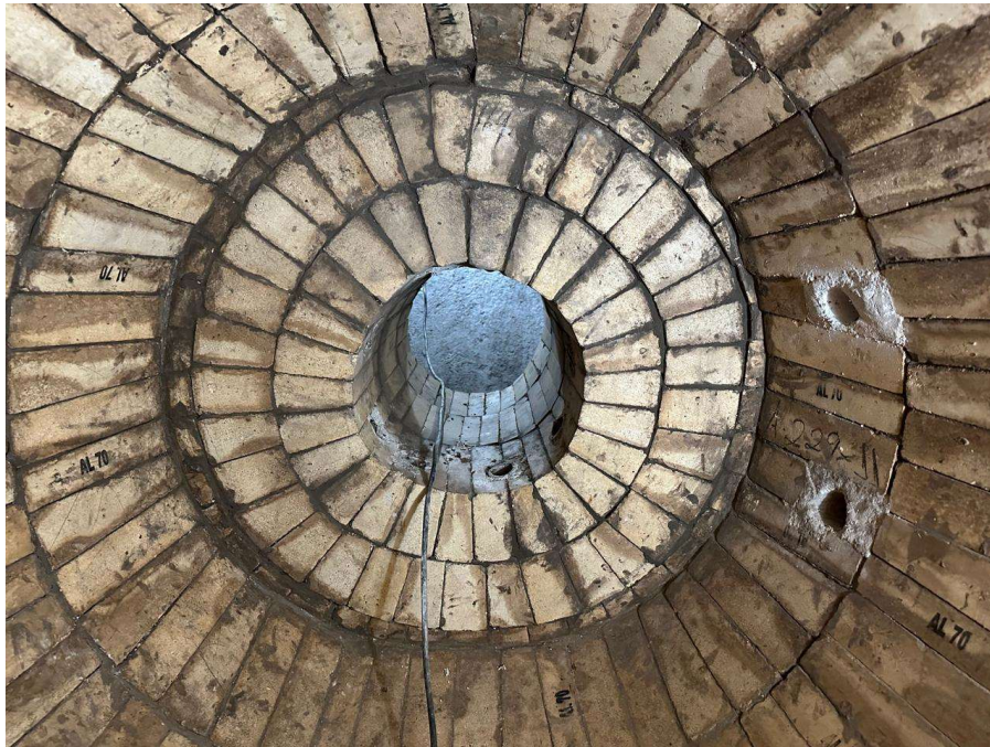
Figura 45 - Conclusão da montagem dos tijolos Alumibar 70 na região da redução.
