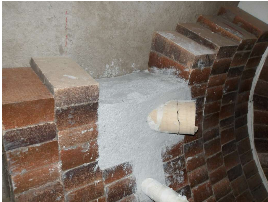
Figura 32 – Aplicação de concreto antierosivo classe B (Castibar PAB) nos bocais para instrumentação.
