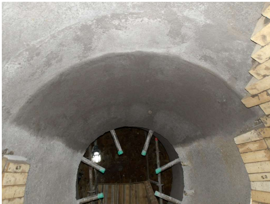
Figura 22 – Conclusão da aplicação de PLW 41 no vaso incinerador.
