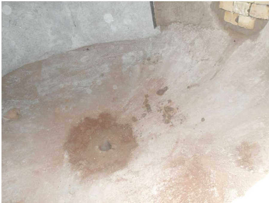
Figura 67 - Piso da chaminé após a retirada dos andaimes.
