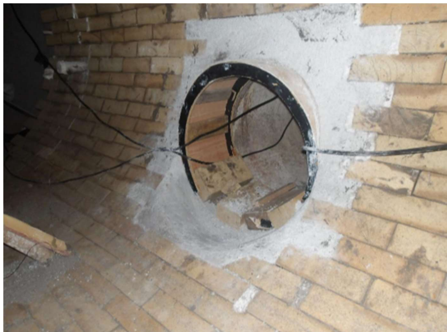
Figura 44 - Aplicação do concreto Castibar PAB na região da BV.
