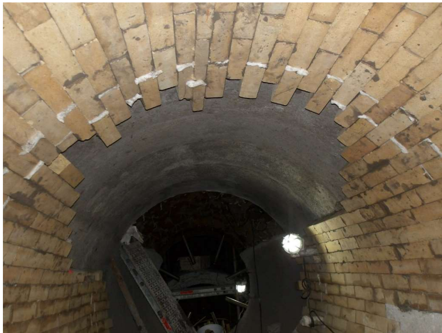
Figura 36 – Aplicação da junta de dilatação nos tijolos em arco Alumibar 70.
