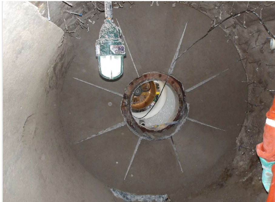
Figura 13 – Concretagem da parede do queimador e adjacências.
