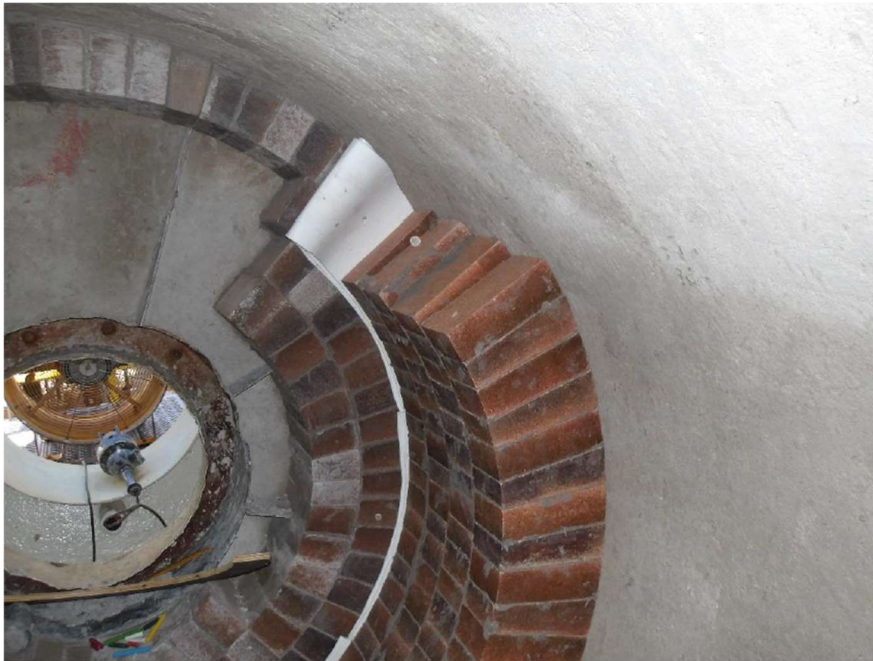
Figura 27 – Instalação da junta de dilatação com placa de fibra cerâmica.
