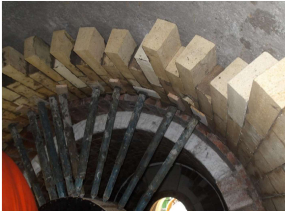
Figura 35 – Detalhe da utilização do escoramento nos tijolos Alumibar 70.
