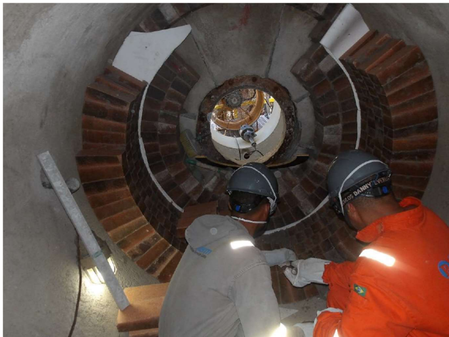
Figura 28 – Instalação da junta de dilatação com placa de fibra cerâmica.
