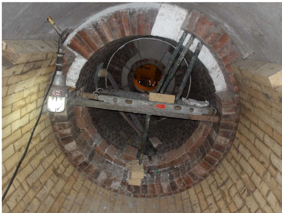
Figura 34 – Instalação dos tijolos Alumibar 70.
