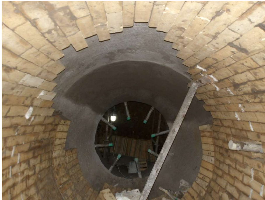
Figura 39 - Instalação dos tijolos Alumibar 70.
