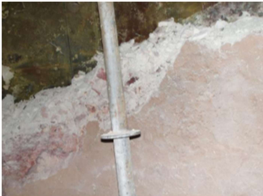
Figura 7 – Demolição do concreto refratário na chaminé.
