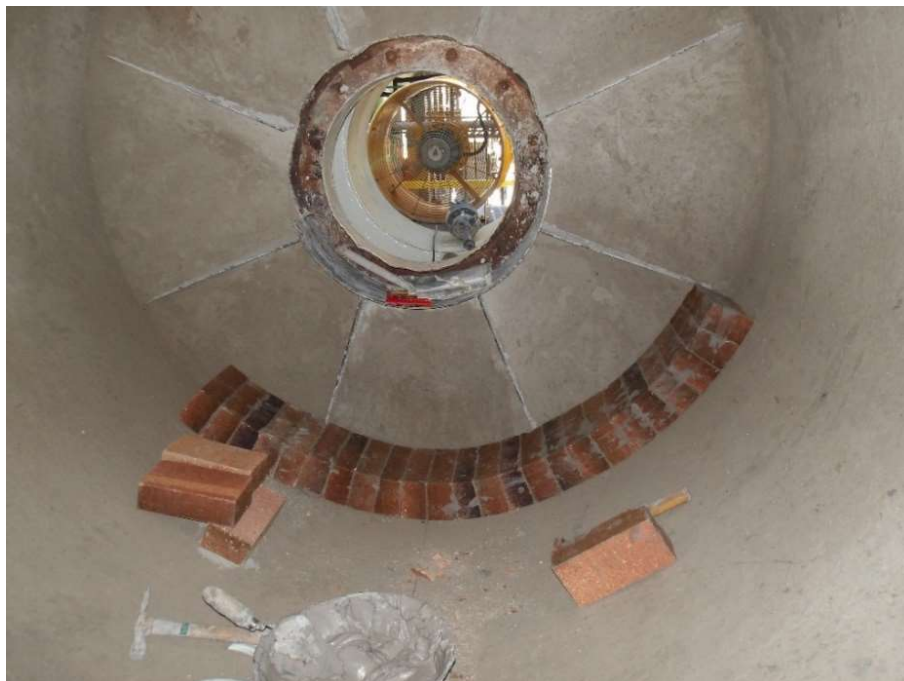
Figura 24 – Início da montagem do refratário conformado Alumibar 95 ES tipo arco.
