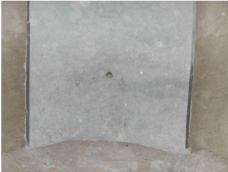
Figura 66 – Região da camada de 189 mm após a retirada dos andaimes.
