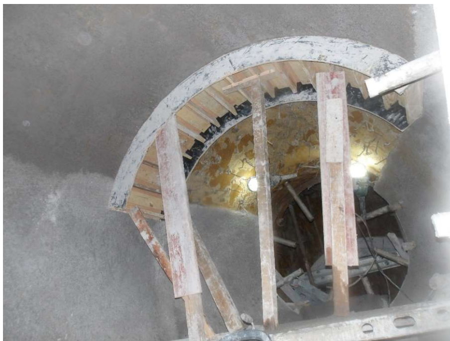
Figura 17 – Detalhe da utilização de cambota para concretagem na geratriz superior do costado.
