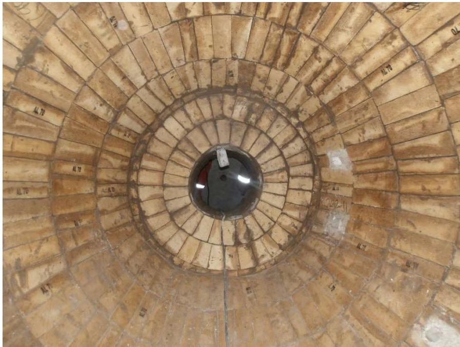
Figura 46 – Paredes de contenção próximas à redução finalizadas.
