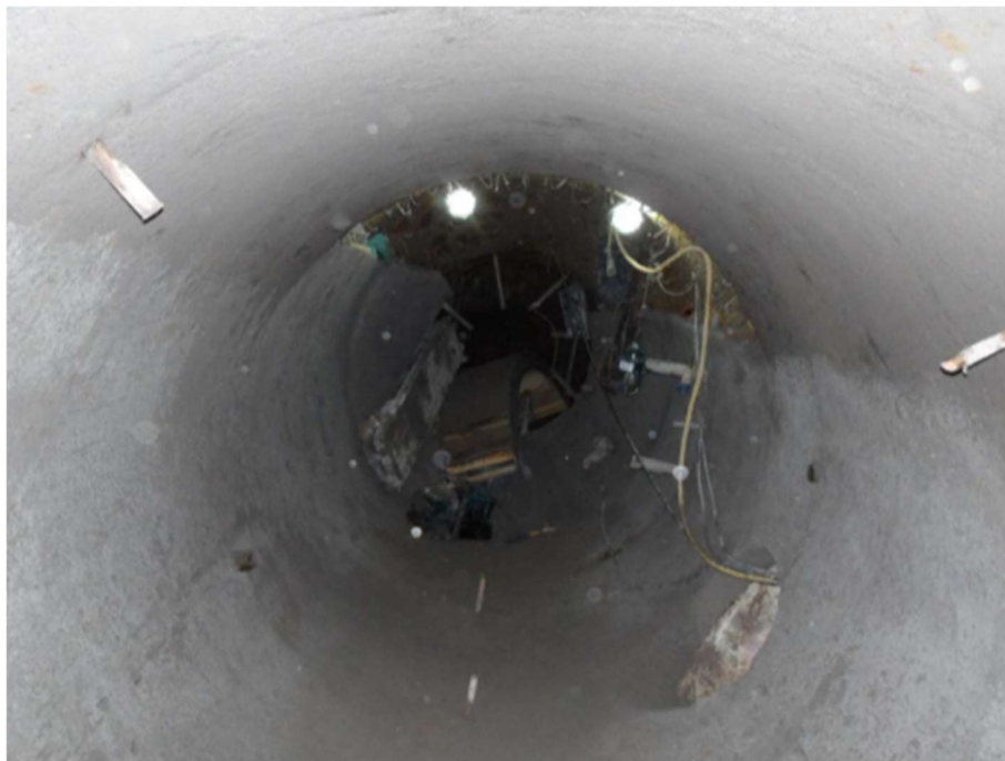
Figura 18 - Aplicação de concreto isolante Catibar PLW 41.
