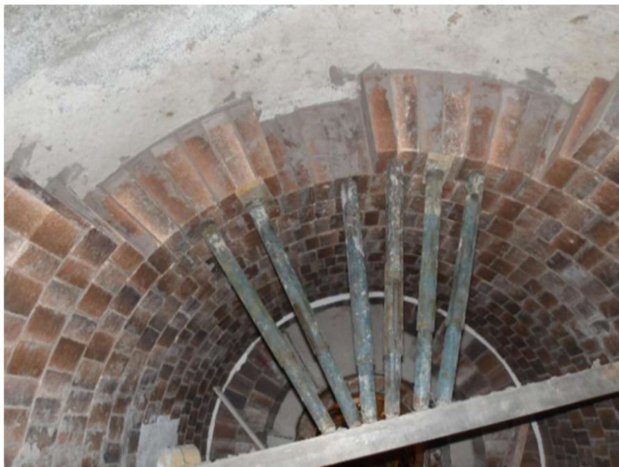
Figura 31 - Detalhe da utilização do escoramento nos tijolos Alumibar 95 ES.
