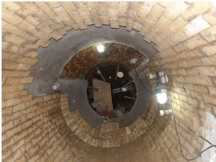
Figura 43 – Instalação dos tijolos Alumibar 70 na redução.
