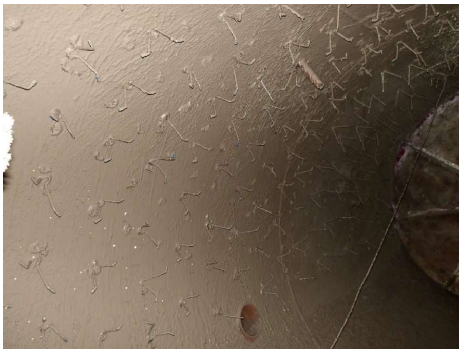
Figura 9 – Instalação das ancoragens com CAPS em suas extremidades e preparação da superfície do equipamento com Placibar SG para concretagem.
