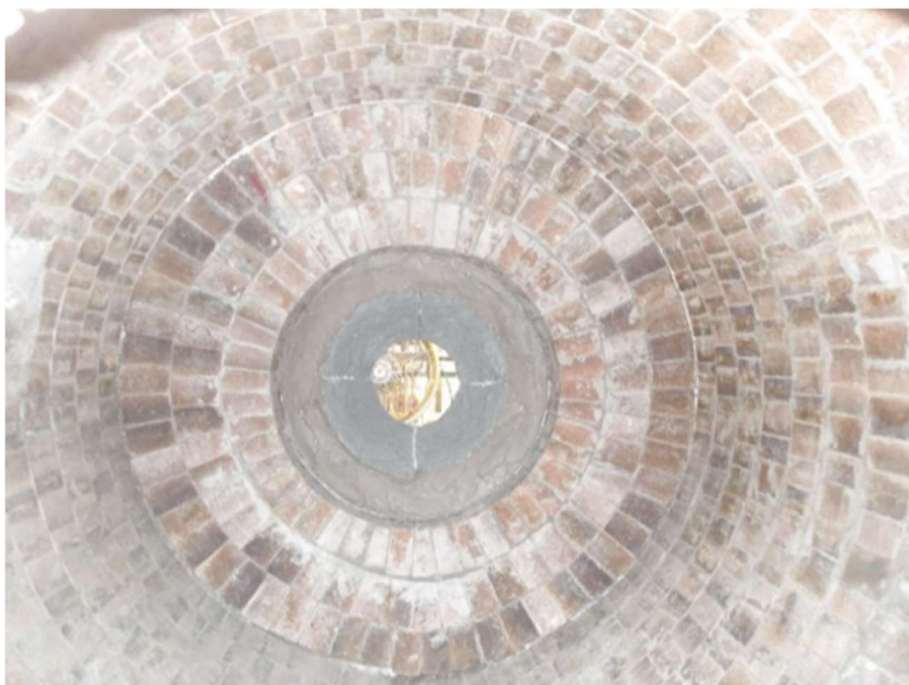
Figura 51 - Região do queimador após a montagem do refratário conformado com destaque para a recomposição dos blocos do queimador/difusor.
