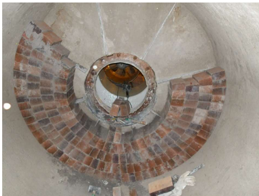
Figura 26 - Sequência de instalação das camadas da primeira fiada de tijolo Alumibar 95 ES.
