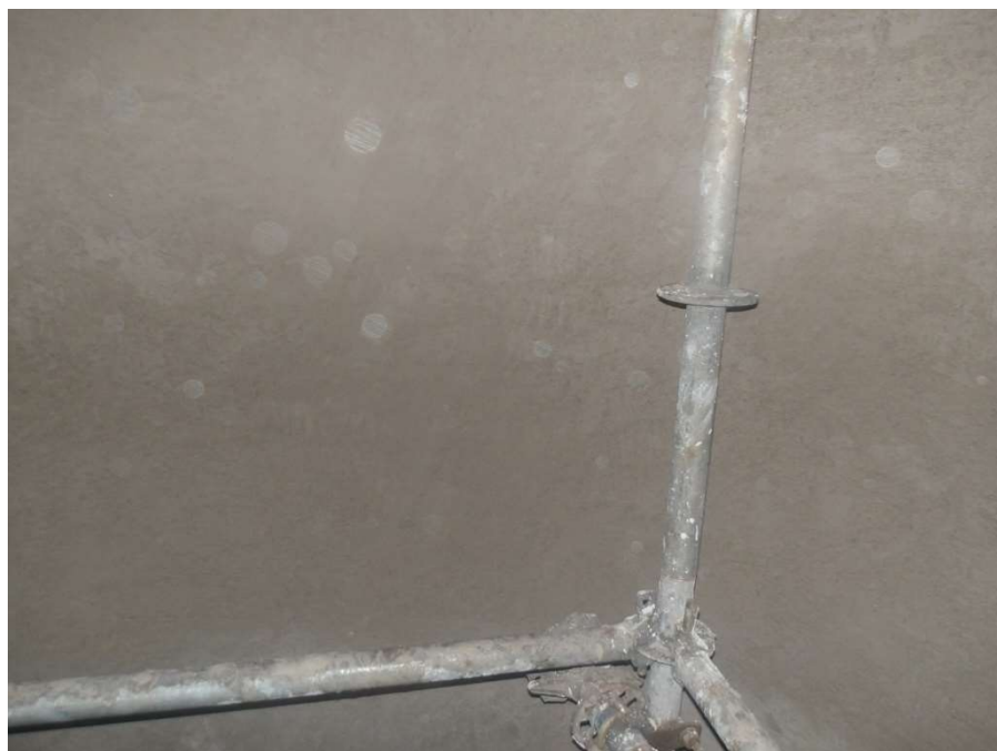
Figura 62 - Concretagem da chaminé com semi-isolante.
