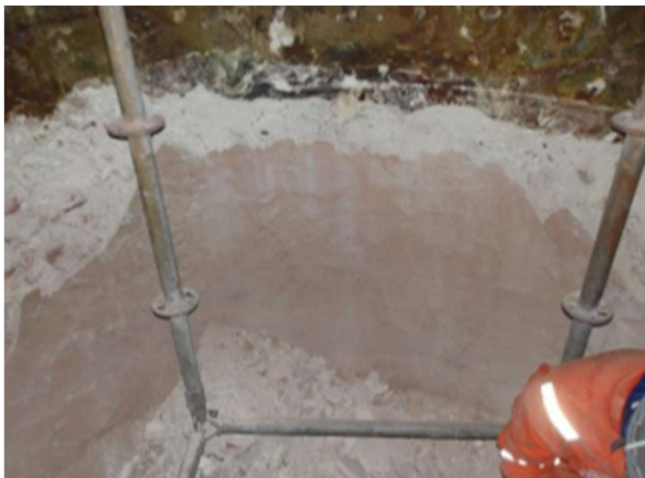
Figura 8 - Demolição do concreto refratário na chaminé.
