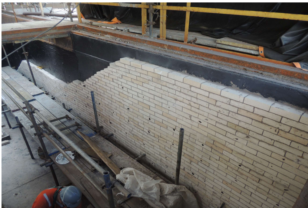
FOTO 07: APLICAÇÃO DOS TIJOLOS REFRAATÁRIOS ANTIÁCIDOS
