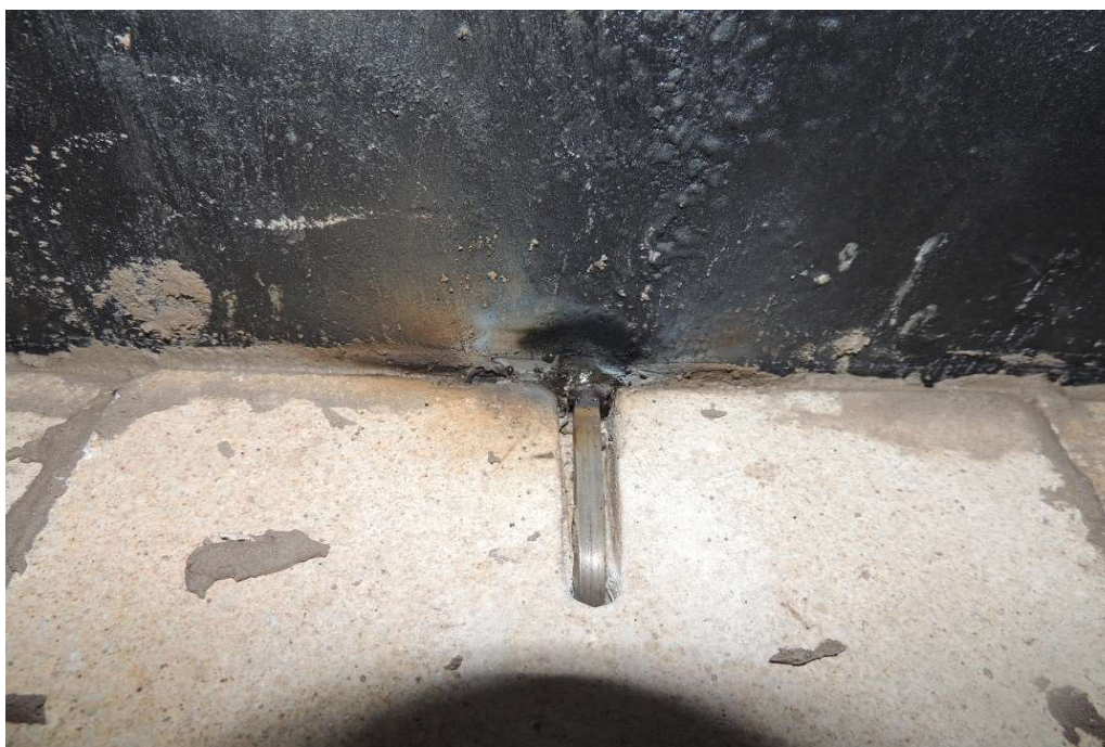
FOTO 06: INSTALAÇÃO DOS GRAMPOS DE ANCORAGENS
