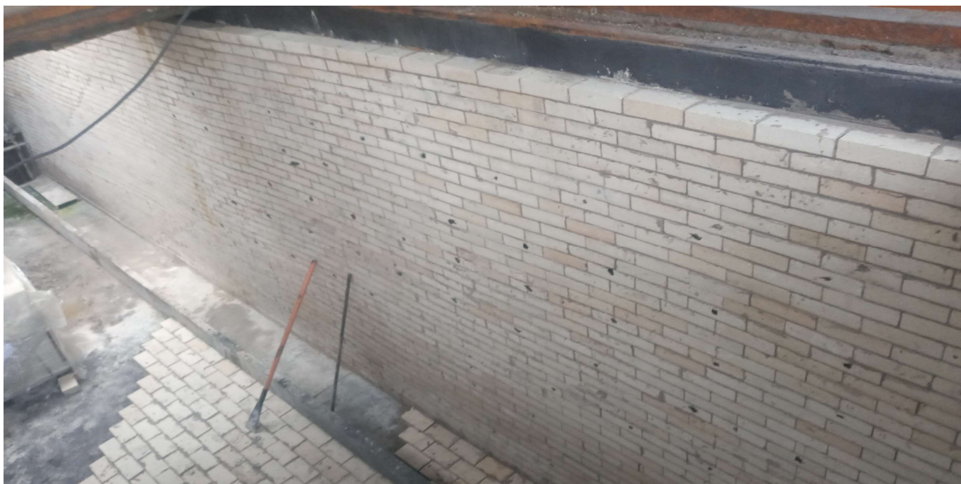
FOTO 09: APLICAÇÃO DOS TIJOLOS REFRACTÁRIOS ANTIÁCIDOS
