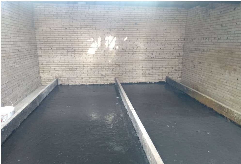
FOTO 04: APLICAÇÃO DE MASSA ANTICORROSIVA DO TIPO KOTIBAR AC
