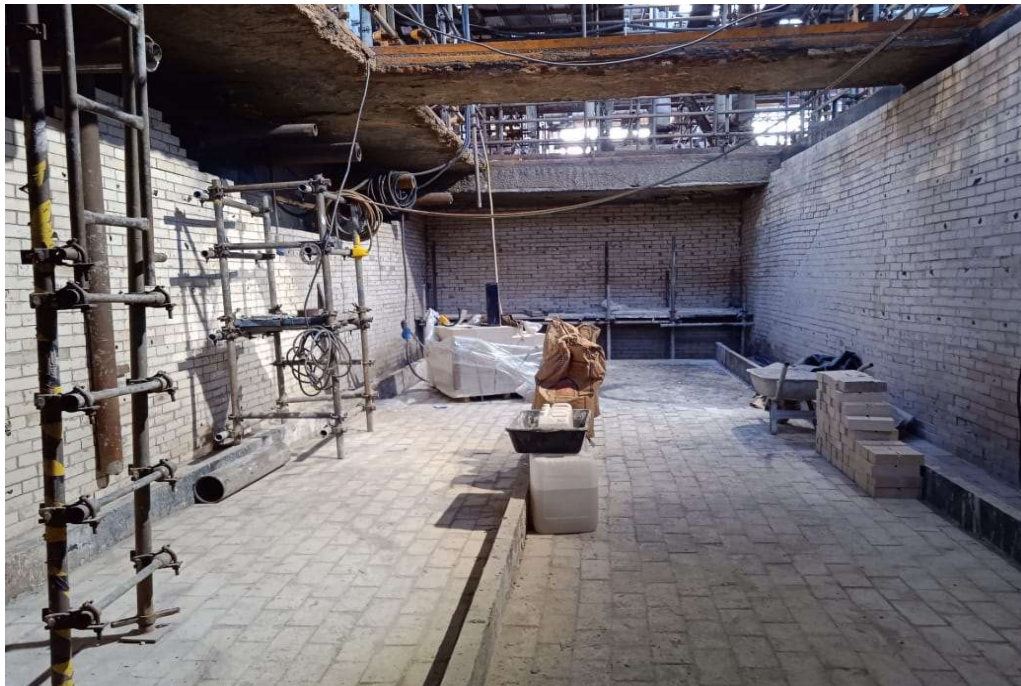
FOTO 11: APLICAÇÃO DOS TIJOLOS REFRAATÁRIOS ANTIÁCIDOS
