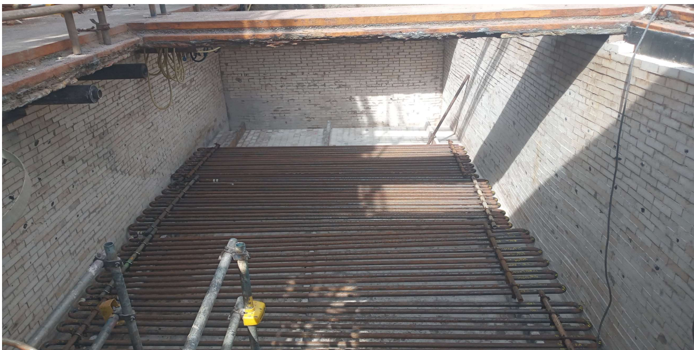
FOTO 12: APLICAÇÃO DOS TIJOLOS REFRAATÁRIOS ANTIÁCIDOS
