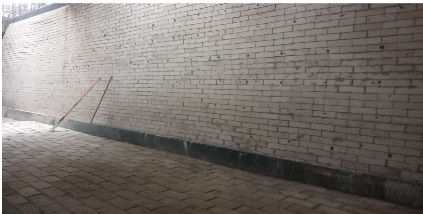
FOTO 10: APLICAÇÃO DOS TIJOLOS REFRACTÁRIOS ANTIÁCIDOS
