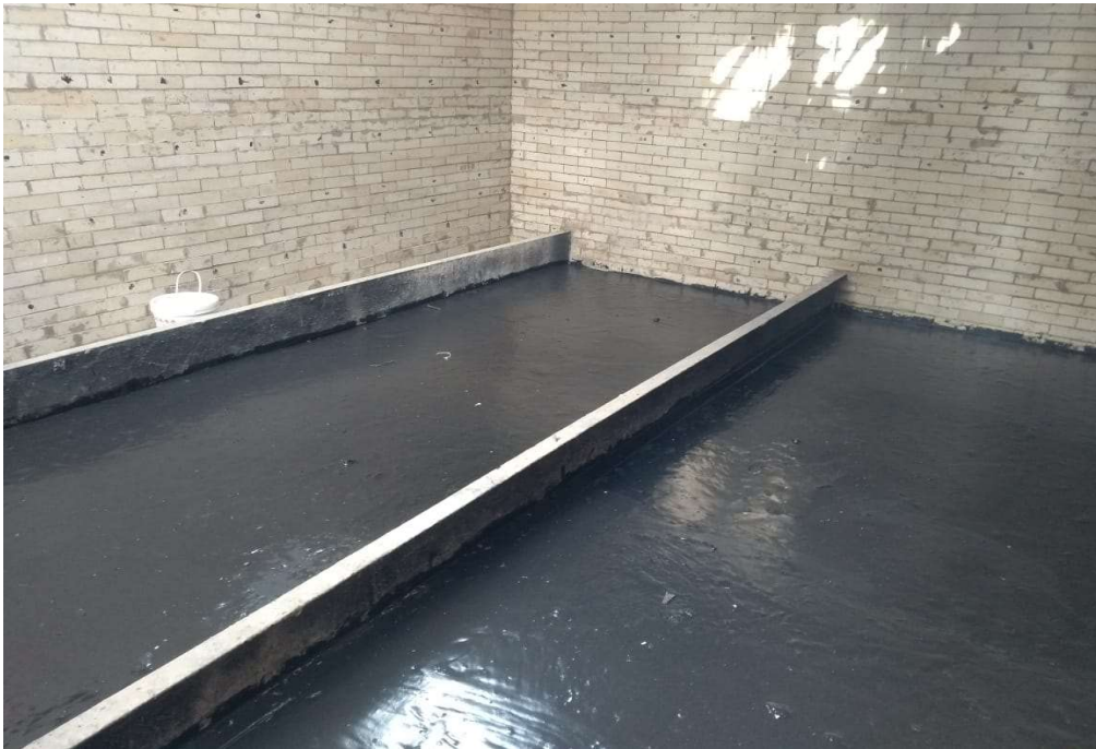
FOTO 03: APLICAÇÃO DE MASSA ANTICORROSIVA DO TIPO KOTIBAR AC
