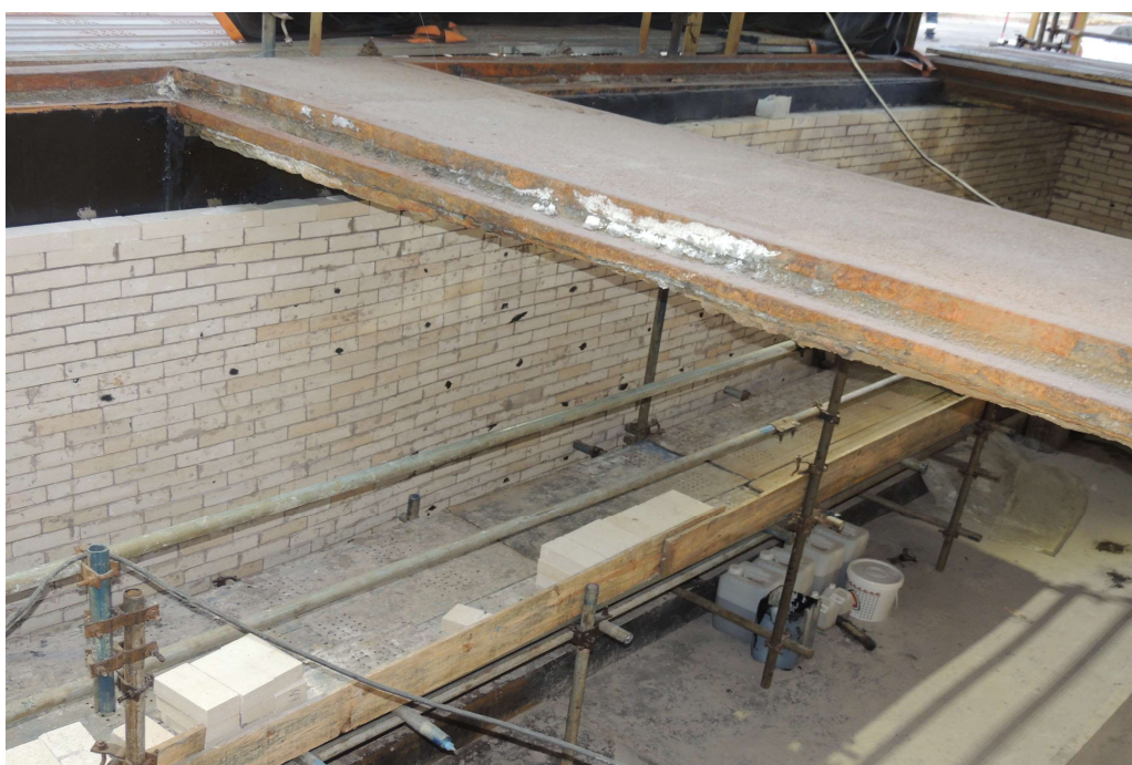
FOTO 08: APLICAÇÃO DOS TIJOLOS REFRAATÁRIOS ANTIÁCIDOS
