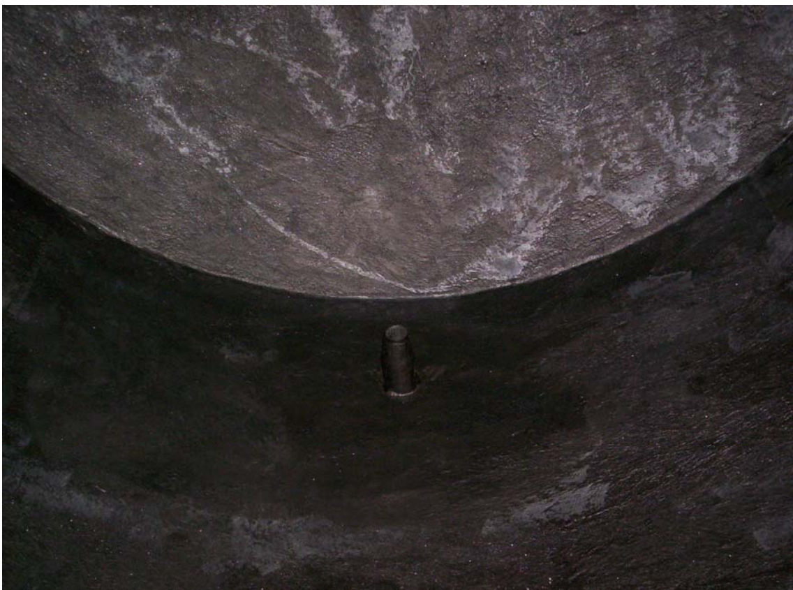
Detalhe após aplicação da camada espatulada do V-1915
