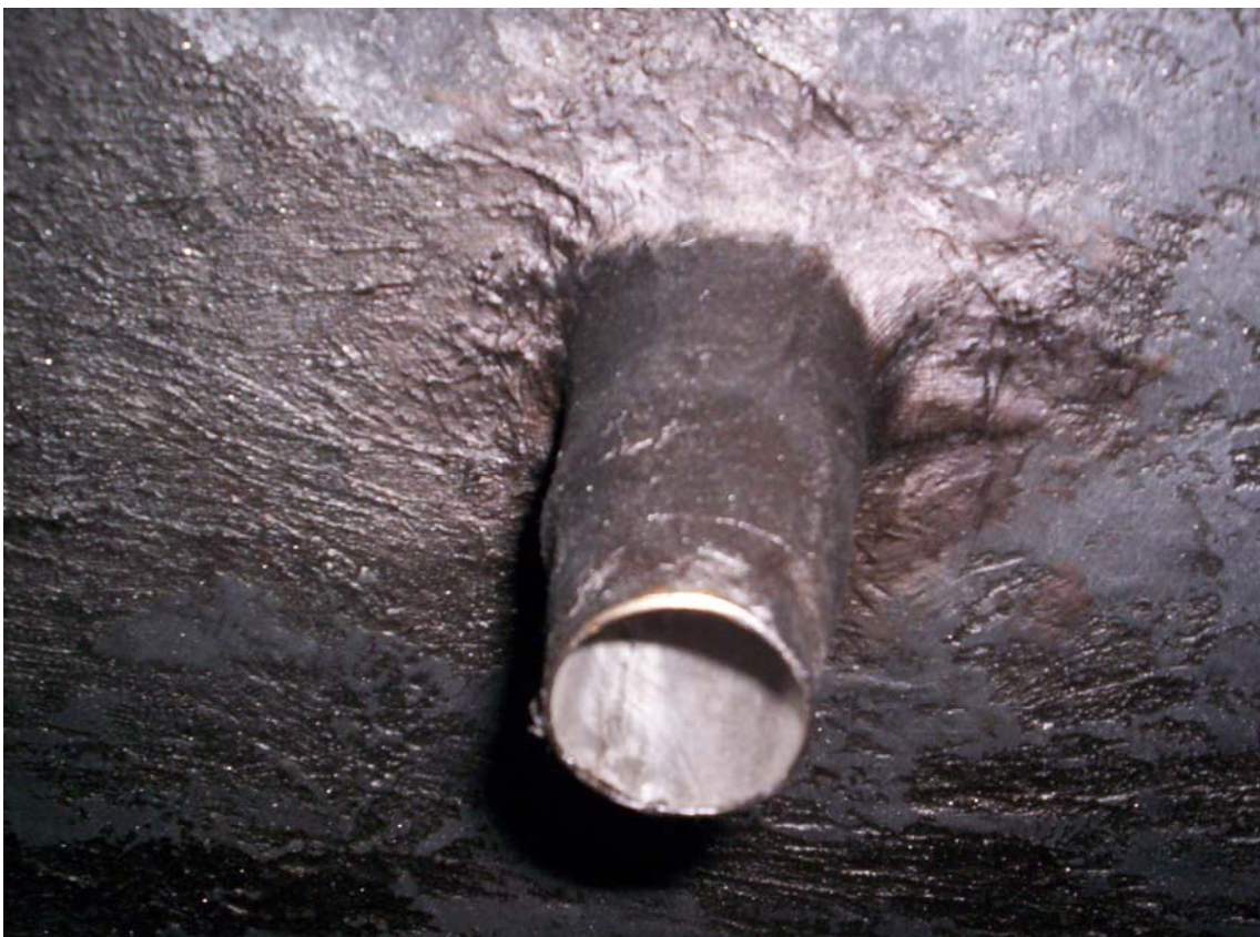
Selagem dos bocais com revestimento em PRFV
