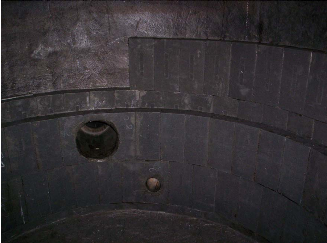
Detalhe na montagem dos tijolos de carbono sobre o revestimento em PRFV
