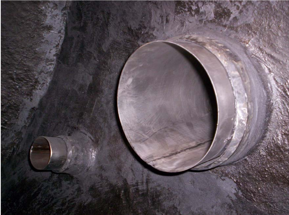
Detalhe das pestanas de titânio inseridas nos bocais do V-1915
