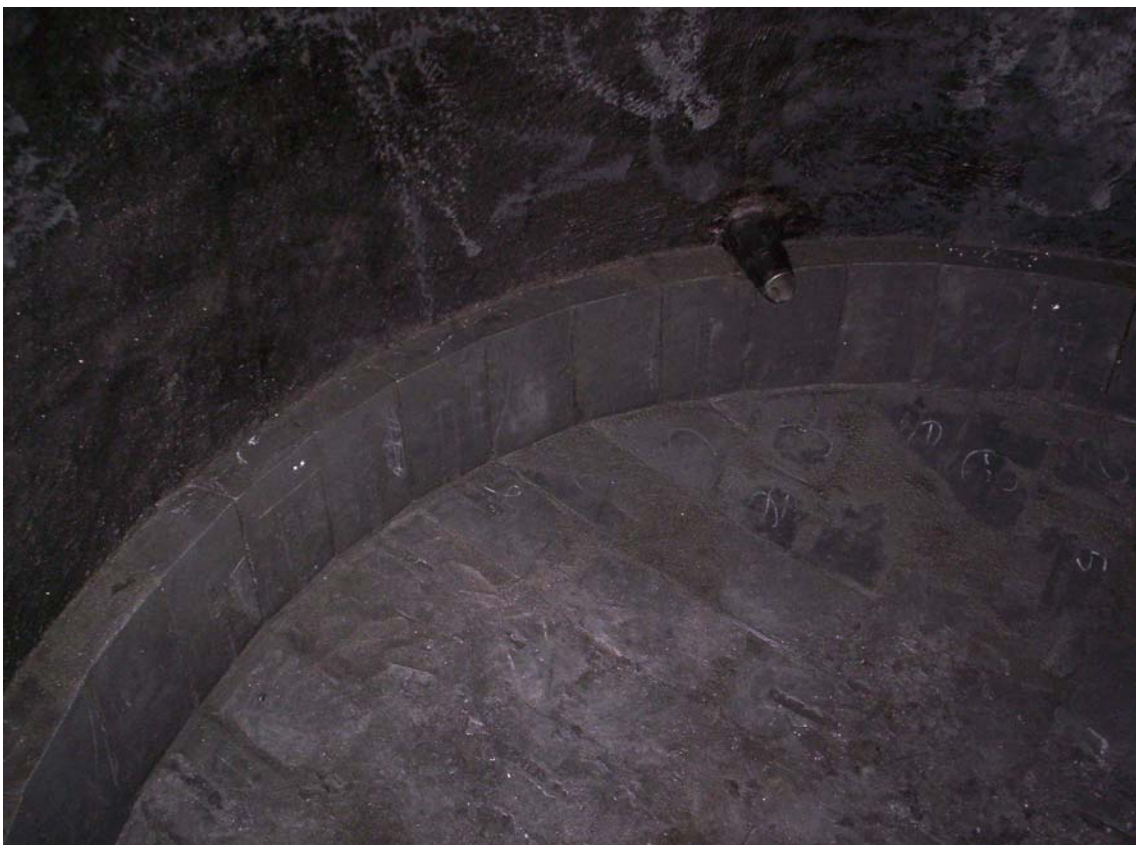
Detalhe na aplicação dos tijolos de carbono no piso do V-1915
