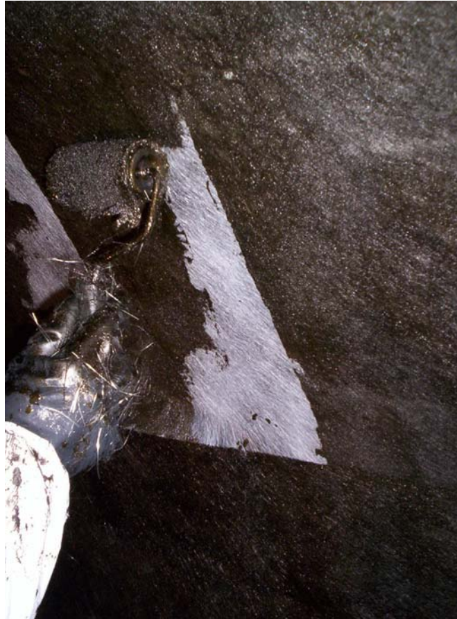
Aplicação das camadas de manta de fibra de vidro com resina furânica
