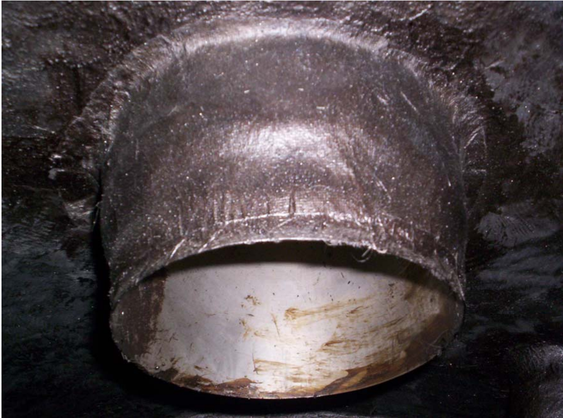
Selagem dos bocais com revestimento em PRFV
