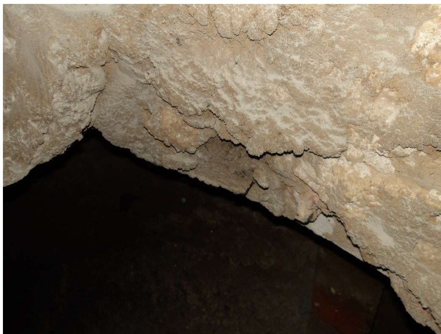
Figura 5 – Verificação dos defeitos do revestimento refratário na meia lua do tubulão de ligação com o secador.
