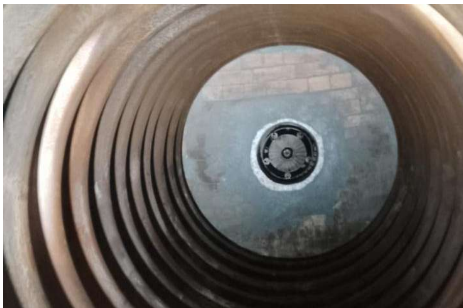
Figura 29 – Reposicionamento dos tijolos íntegros e aplicação de concreto de pega química.
