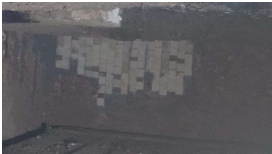
Figura 20 – Tijolos ajustados e aplicação de concreto Engecast N na parede norte.
