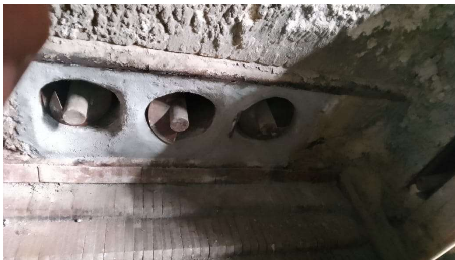
Figura 24 – Invólucro dos queimadores após aplicação do concreto denso.
