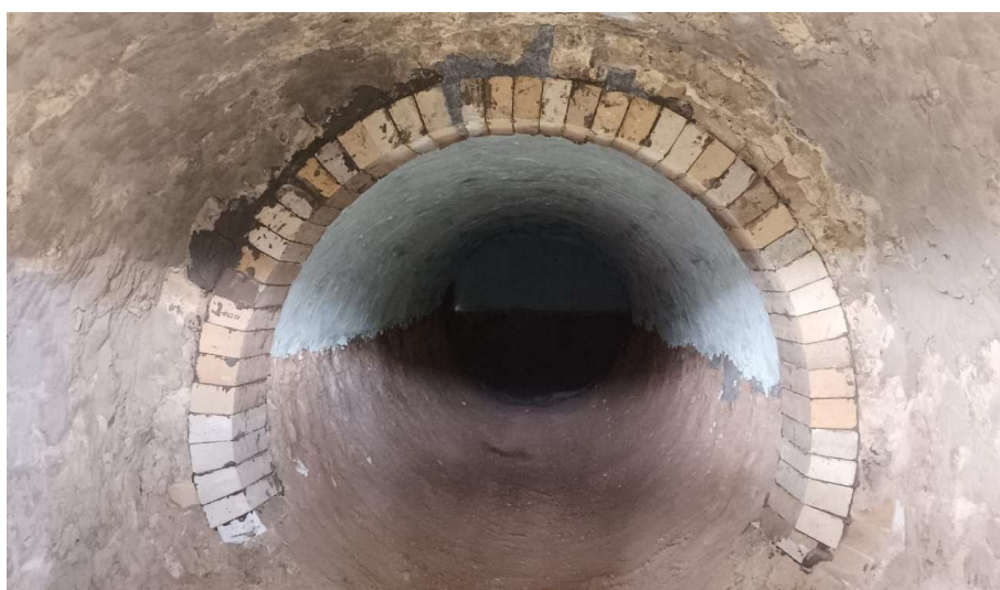
Figura 18 – Conclusão do assentamento dos tijolos tipo arco.
