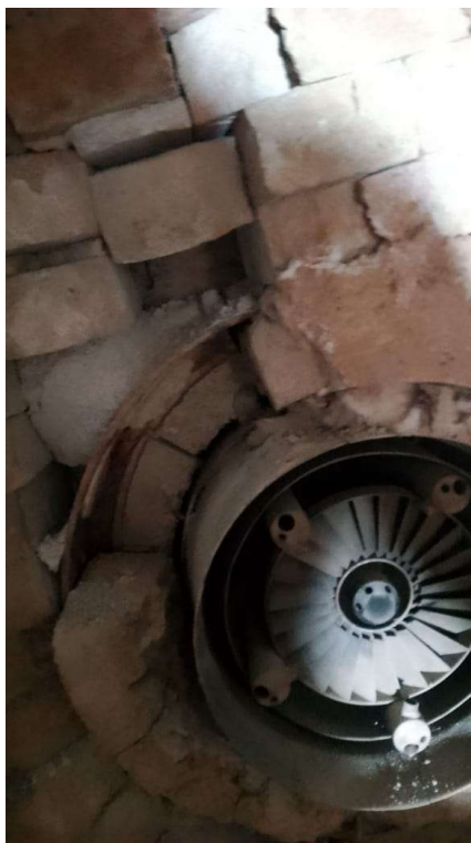
Figura 28 – Verificação das camadas de tijolo refratário e blocos do queimador.
