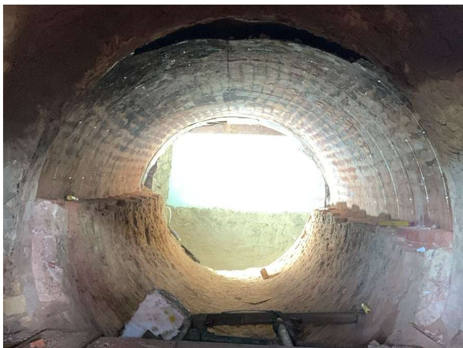
Figura 13 – Duto de ligação com o tubulão após limpeza dos resíduos de demolição da geratriz superior.
