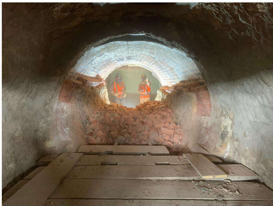
Figura 12 – Demolição do revestimento de tijolos da geratriz superior.
