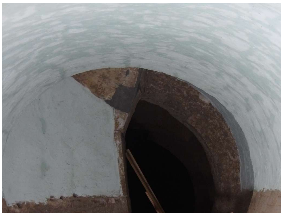
Figura 4 - Geratriz superior após aplicação da massa silplate.
