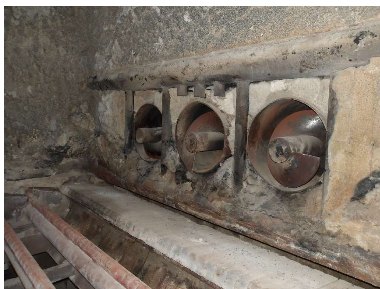
Figura 23 – Situação encontrada no revestimento refratário do invólucro dos queimadores.
