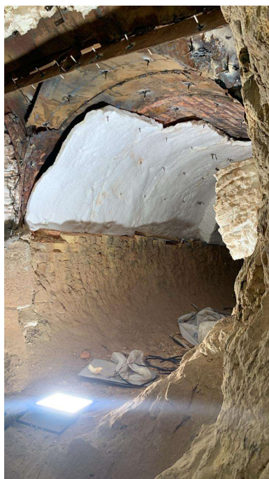
Figura 14 – Pinos de ancoragem soldados e início da instalação da manta de sacrifício para os módulos de Fibra Cerâmica.
