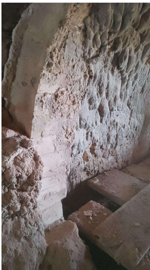
Figura 16 – Disposição dos tijolos reassentados na última fiada do duto de ligação com a capela metálica.
