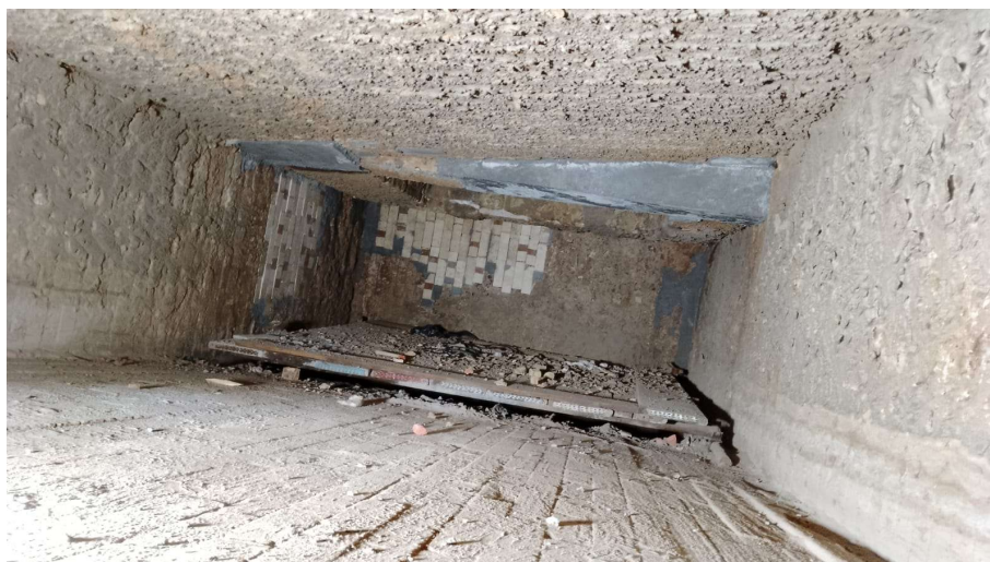
Figura 21 – Visão geral dos ajustes de tijolos e aplicação de concreto Engecast N nas paredes norte, leste e oeste no interior da fornalha e das vigas de sustentação.
