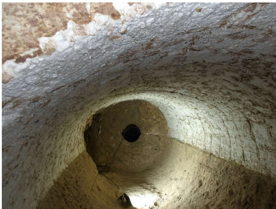
Figura 2 – Isolamento da geratriz superior do tubulão após limpeza superficial.
