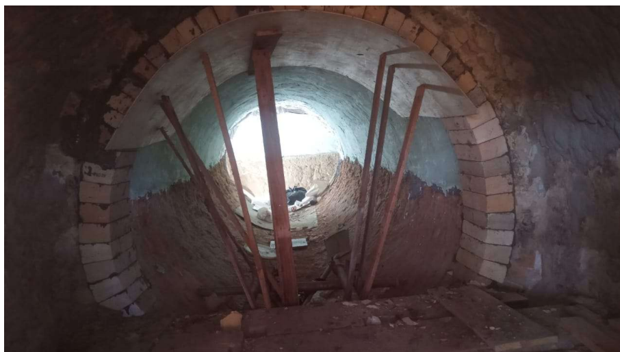
Figura 17 – Assentamento dos tijolos tipo arco.
