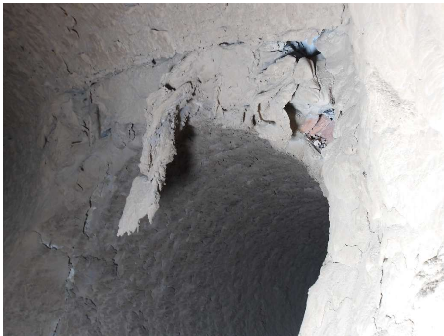
Figura 7 – Verificação da condição inicial do revestimento entre tubulões.
