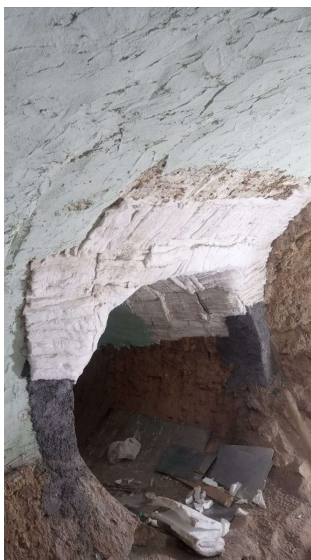
Figura 10 – Região entre tubulões após substituição do revestimento interno.
