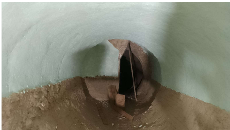
Figura 3 – Geratriz superior após aplicação da massa silplate.
