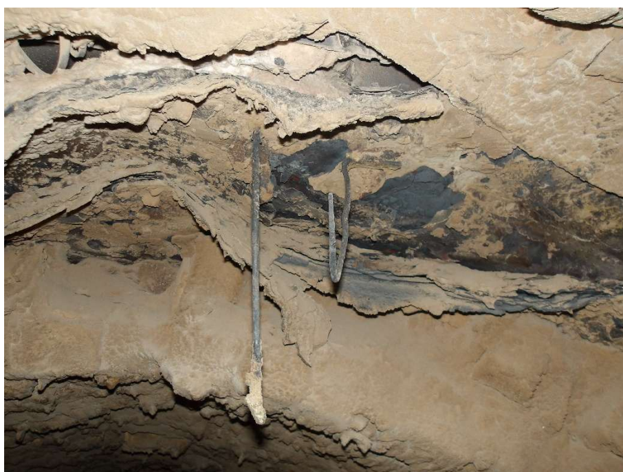
Figura 8 – Verificação da chapa do costado após demolição do refratário entre tubulões.
