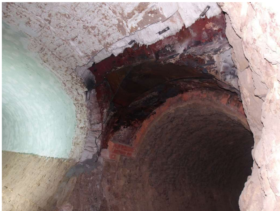
Figura 9 – Demolição do revestimento da região entre tubulões para troca de chapa do costado pela caldeiraria e posterior recomposição do refratário.
