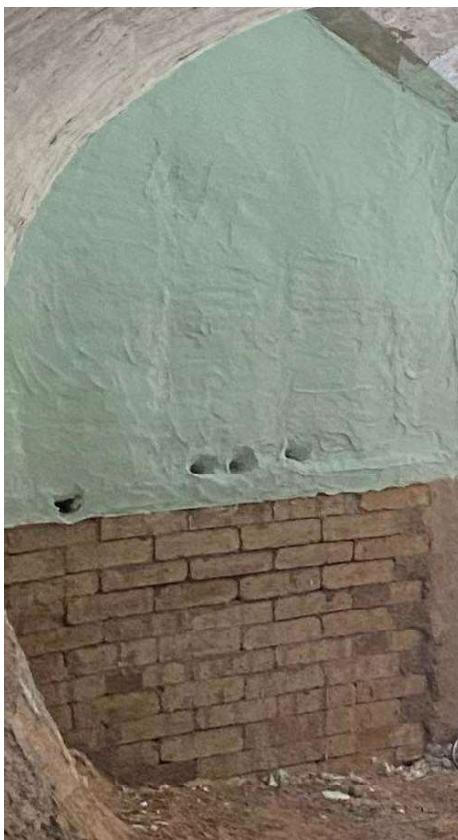
Imagem 23 - Detalhe da recomposição da mureta de tijolos na região da meia lua no interno do tubulão.
