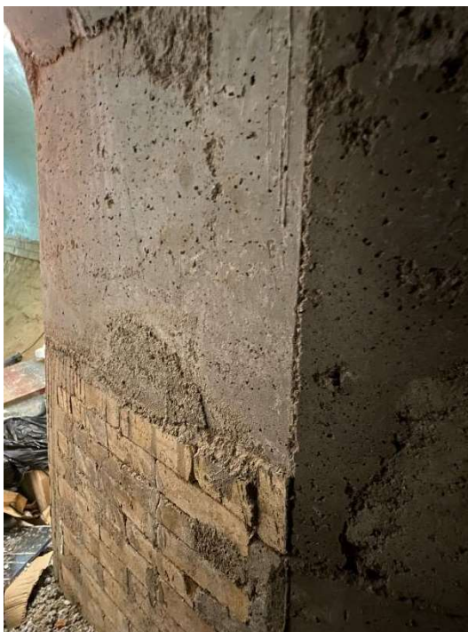
Imagem 21 - Detalhe da região de meia parede do tubulão após recomposição do revestimento refratário.
