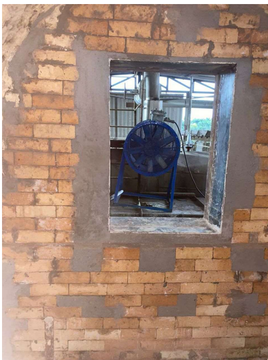
Imagem 40 - Reparo na parede da capela para correção de abaulamento verificado.
