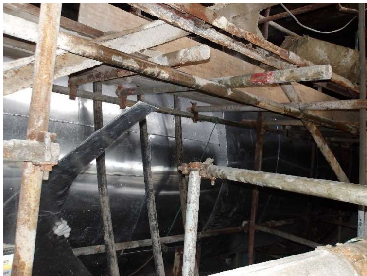
Imagem 11 - Recomposição da chapa de proteção mecânica do isolamento.
