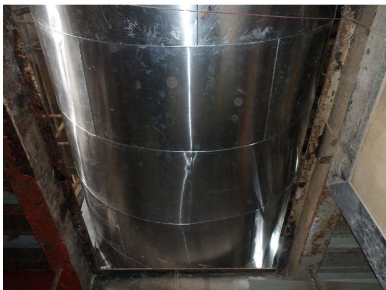
Imagem 13 - Recomposição da chapa de proteção mecânica do isolamento.
