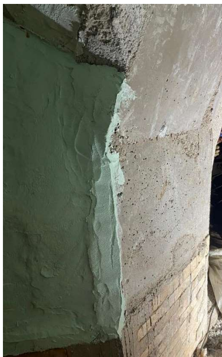
Imagem 25 - Detalhe da recomposição da região da transição entre tubulões e área com instalação de módulos cerâmicos e aplicação de Silplate.
