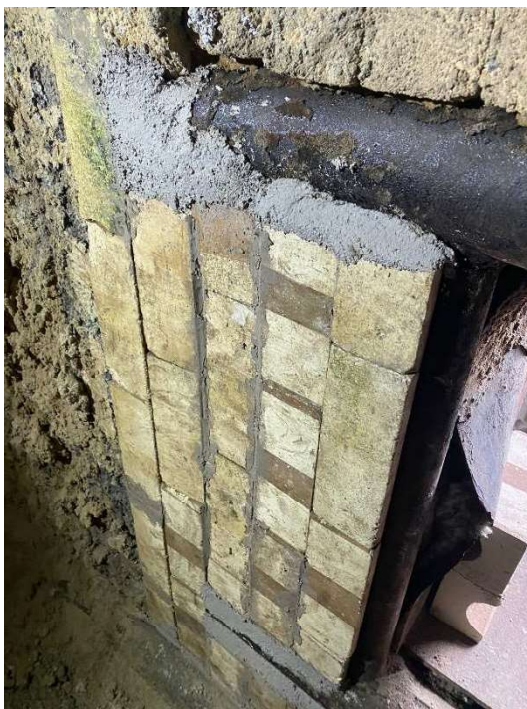
Imagem 36 - Tijolos tubulares instalados na parede oeste da câmara de combustão e encunhamento com Castibar N.
