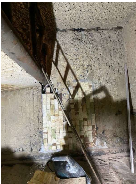
Imagem 35 - Instalação de tijolo tubular na parede leste da câmara de combustão.
