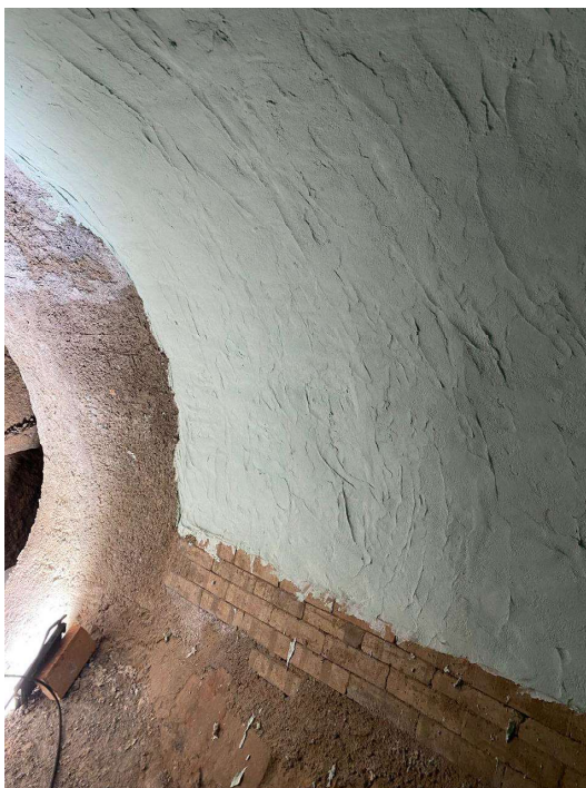
Imagem 24 - Região interna do tubulão com instalação dos módulos cerâmicos e aplicação de Silplate.
