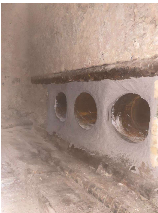
Imagem 34 - Parede sul da câmara de combustão após instalação dos tijolos tubulares e revestimento com Castibar N.
