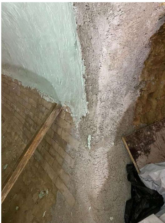
Imagem 42 - Detalhe da região de junção entre tubulões após recomposição do revestimento refratário.
