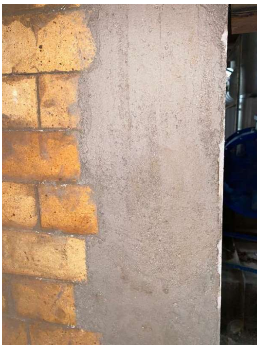
Imagem 41 - Reparo na parede da capela para correção de abaulamento verificado.
