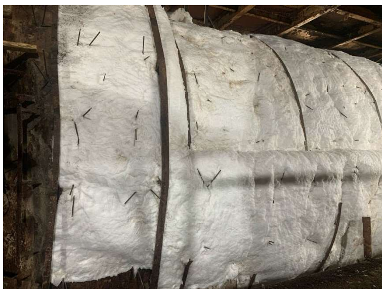
Imagem 5 - Recomposição do isolamento no tubulão.
