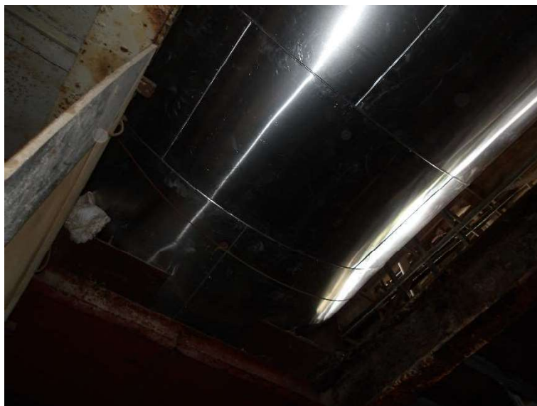
Imagem 12 - Recomposição da chapa de proteção mecânica do isolamento.
