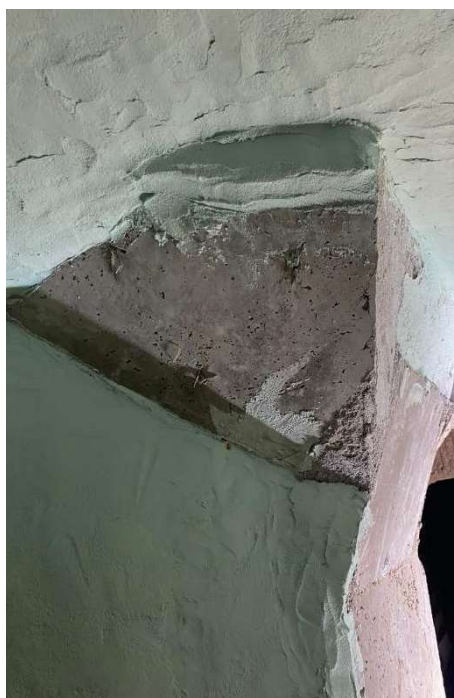
Imagem 26 - Detalhe da recomposição da região da transição entre tubulões e área com instalação de módulos cerâmicos e aplicação de Silplate.
