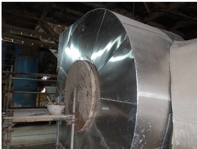
Imagem 10 - Recomposição da chapa de proteção mecânica do isolamento.
