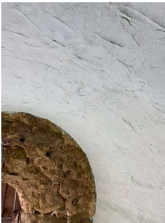
Imagem 19 - Detalhe da região da entrada do tubulão com aplicação de revestimento de módulo cerâmico e aplicação de massa Silplate.
