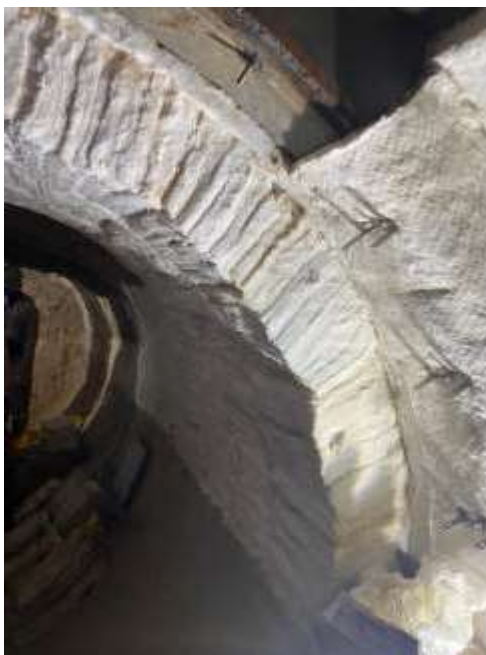
Imagem 17 - Recomposição do revestimento com módulos de fibra cerâmica.
