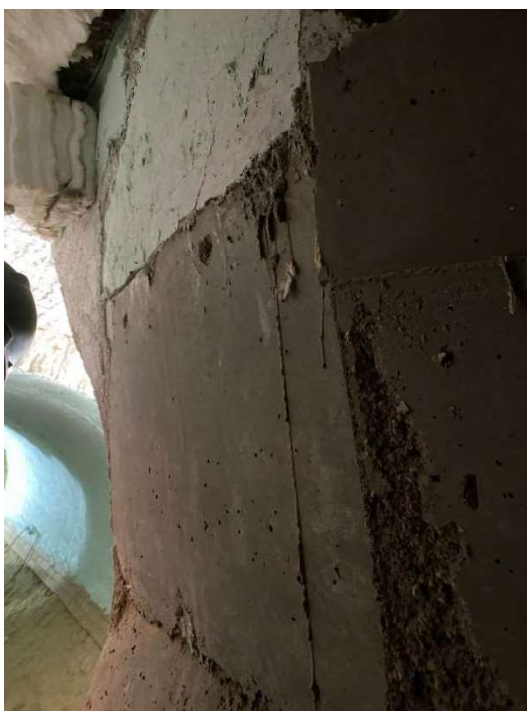
Imagem 22 - Detalhe da região de meia parede do tubulão após recomposição do revestimento refratário.
