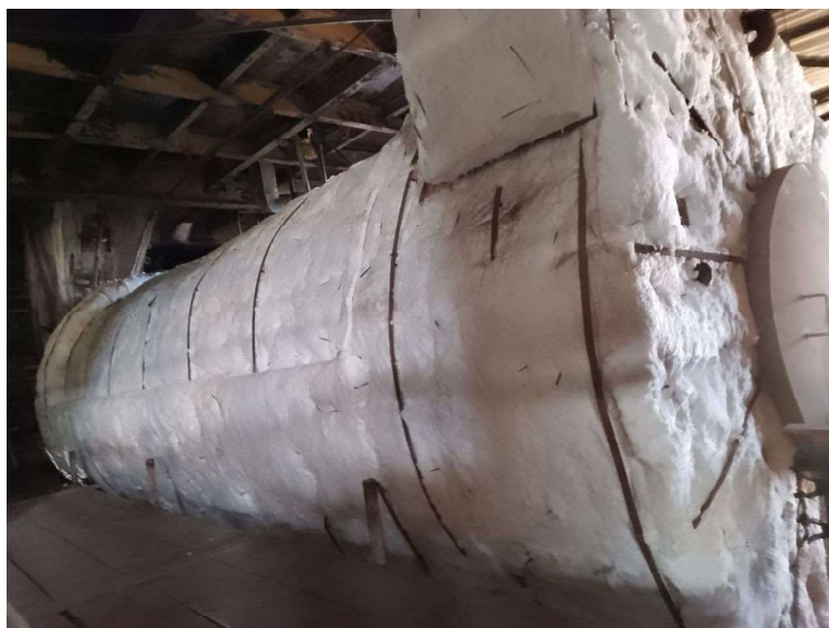
Imagem 6 - Recomposição do isolamento no tubulão.
