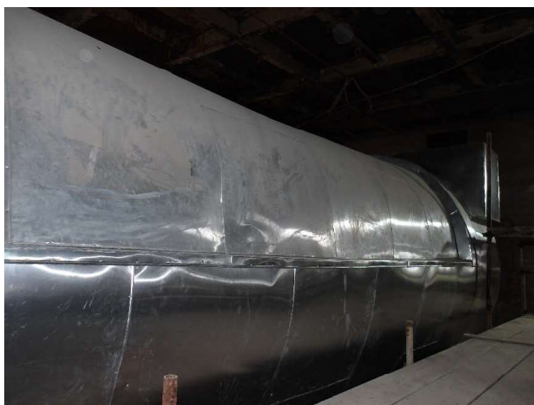
Imagem 15 - Recomposição da chapa de proteção mecânica do isolamento.
