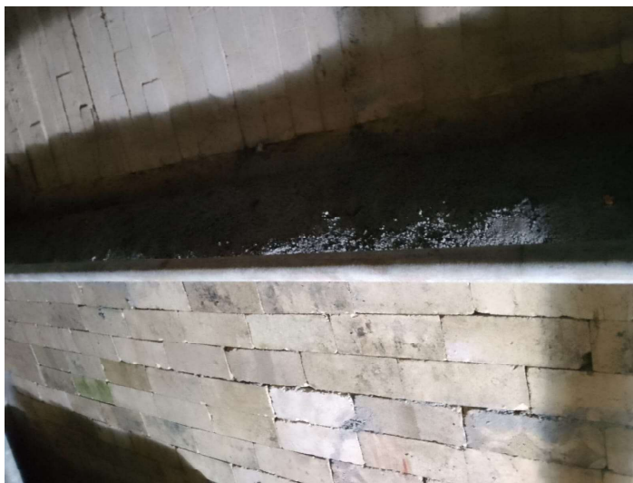
Imagem 38 - Pareda do fosso após recomposição de refratário.
