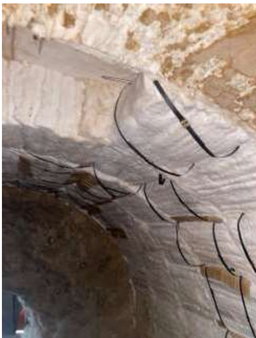
Imagem 18 - Recomposição do revestimento com módulos de fibra cerâmica.
