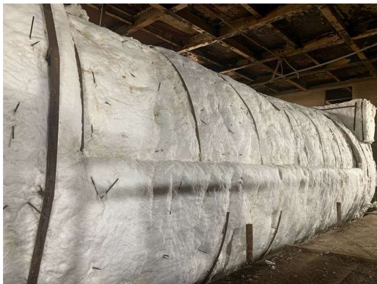
Imagem 4 – Recomposição do isolamento no tubulão.
