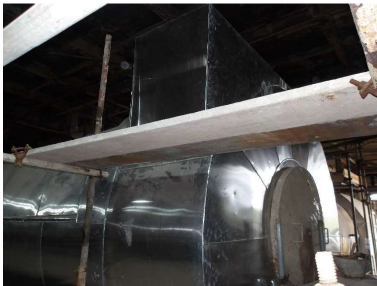
Imagem 8 - Recomposição da chapa de proteção mecânica do isolamento.
