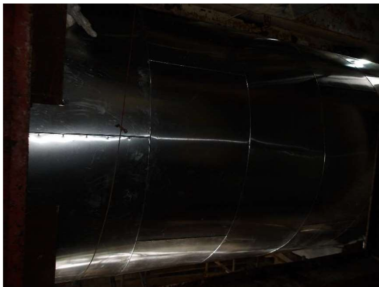
Imagem 14 - Recomposição da chapa de proteção mecânica do isolamento.
