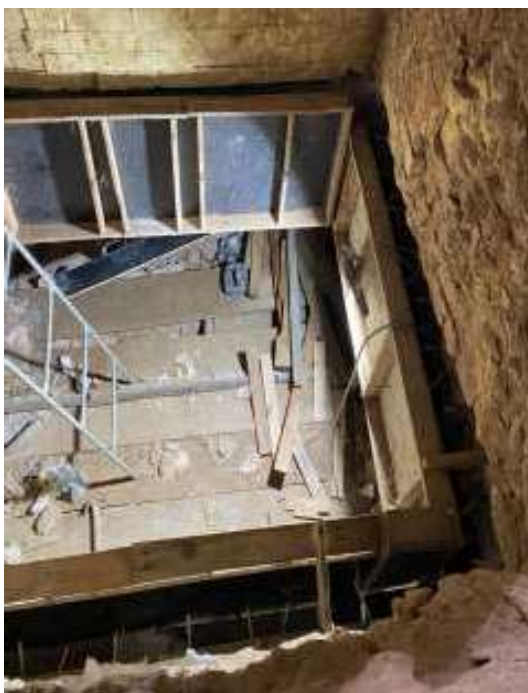
Imagem 28 - Montagem e disposição das fôrmas nas vigas de sustentação da capela.
