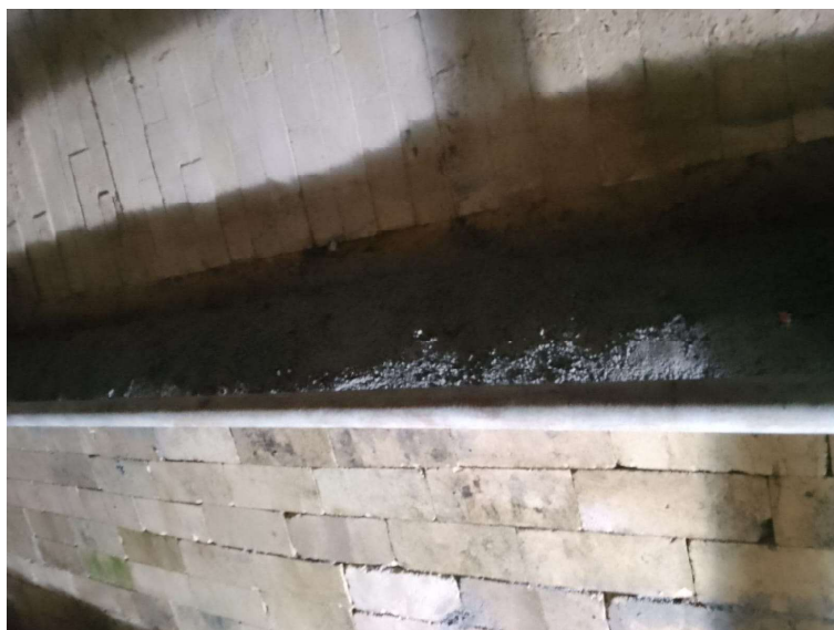
Imagem 39 - Pareda do fosso após recomposição de refratário.
