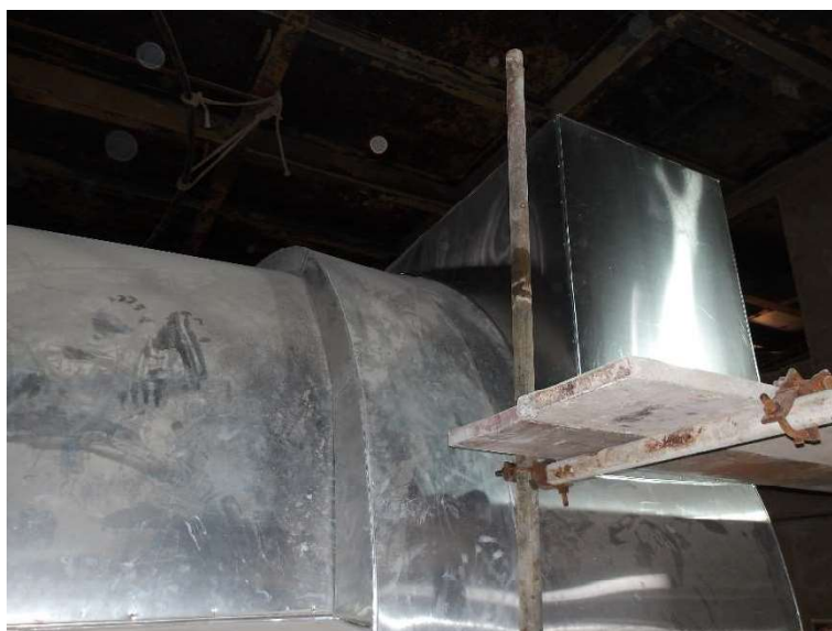
Imagem 7 - Recomposição da chapa de proteção mecânica do isolamento.
