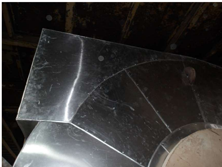
Imagem 9 - Recomposição da chapa de proteção mecânica do isolamento.
