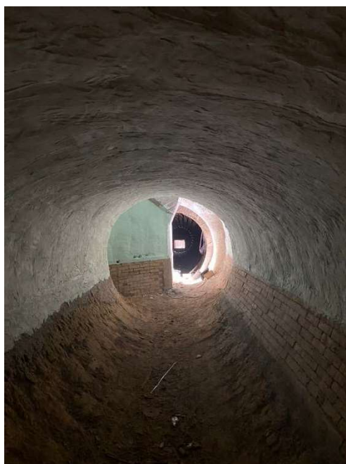
Imagem 20 - Tubulão após aplicação do revestimento com módulo de fibra cerâmica e aplicação de Silplate. Detalhe para os tijolos instalados conforme será descrito na alteração 1 do quadro que consta no item 9.4.
