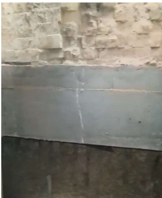
Imagem 29 - Viga de sustentação da capela metálica após concretagem.
