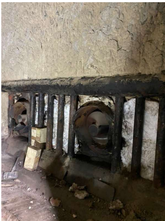
Imagem 33 - Instalação de tijolo tubular na parede sul da câmara de combustão.
