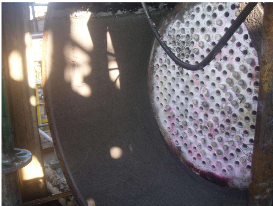
Imagem 16 - Área de aplicação manual do concreto PLW 41
