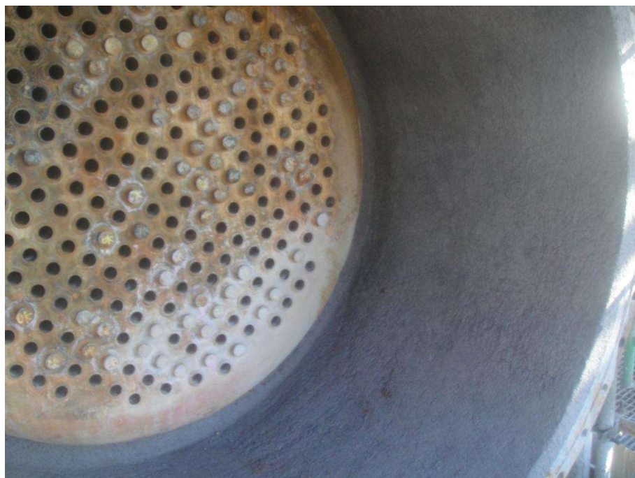
Imagem 20 - Área de aplicação manual do concreto PLW 41
