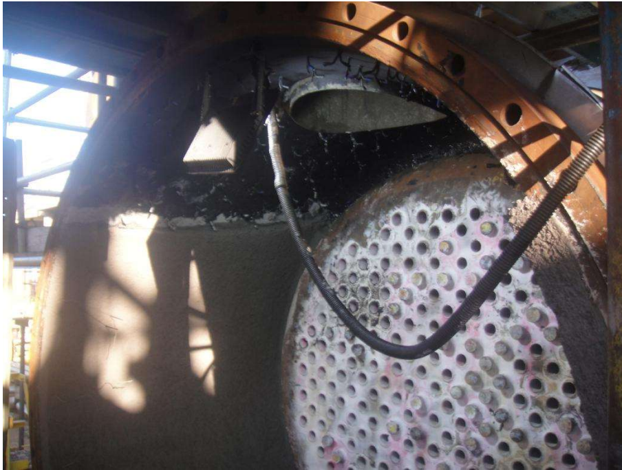
Imagem 17 - Área de aplicação manual do concreto PLW 41
