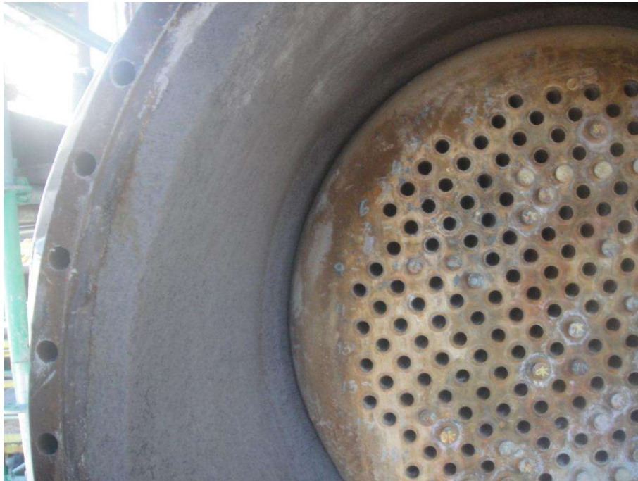
Imagem 21 - Área de aplicação manual do concreto PLW 41
