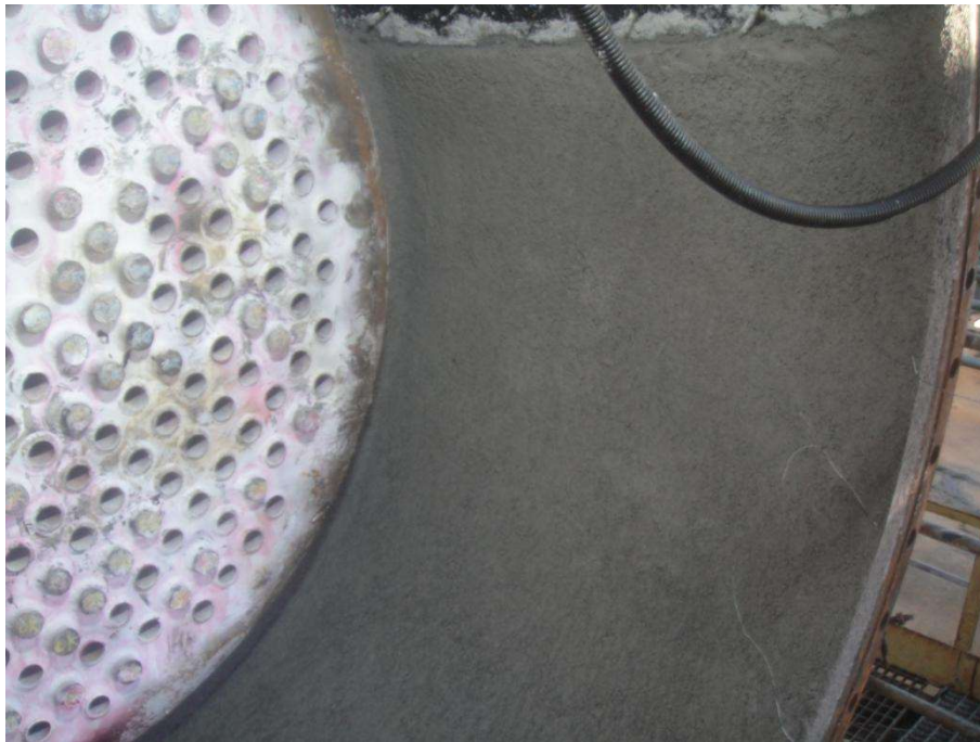
Imagem 19 - Área de aplicação manual do concreto PLW 41
