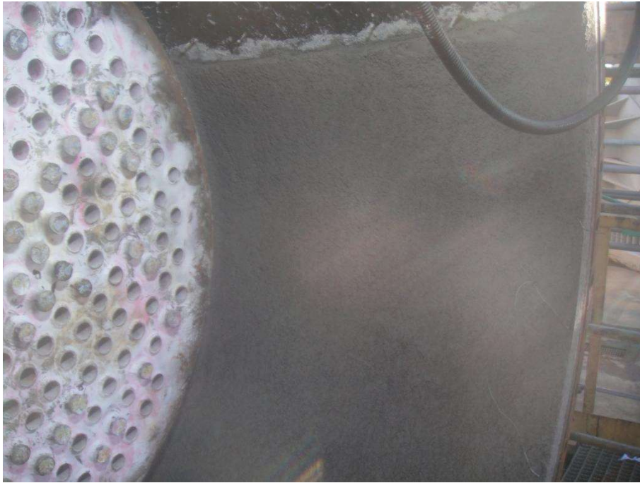
Imagem 15 - Área de aplicação manual do concreto PLW 41
