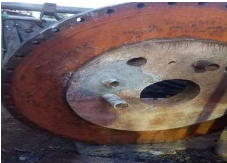
Imagem 32 - Reparo do refratário na tampa do queimador
