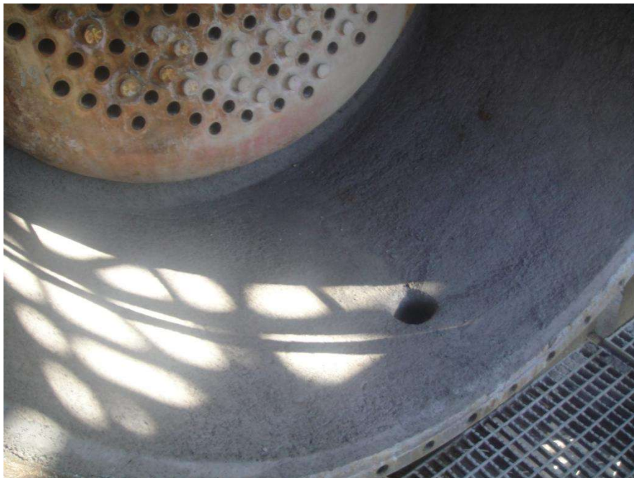
Imagem 22 - Área de aplicação manual do concreto PLW 41
