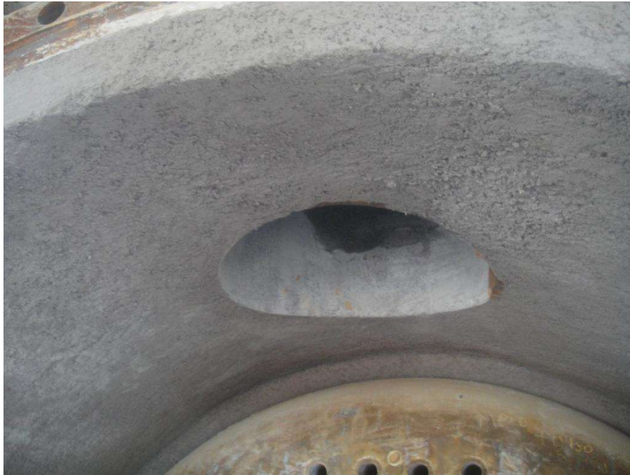
Imagem 23 - Área de projeção do concreto PLW 41
