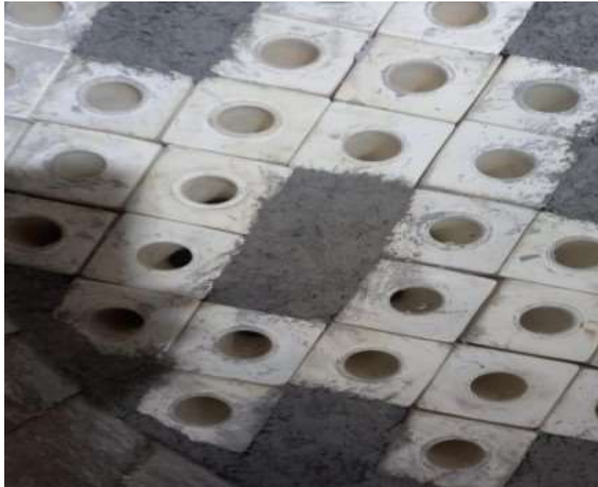
Imagem 29 - Primeira fiada de tijolos e ferrules cerâmicos no B-3601
