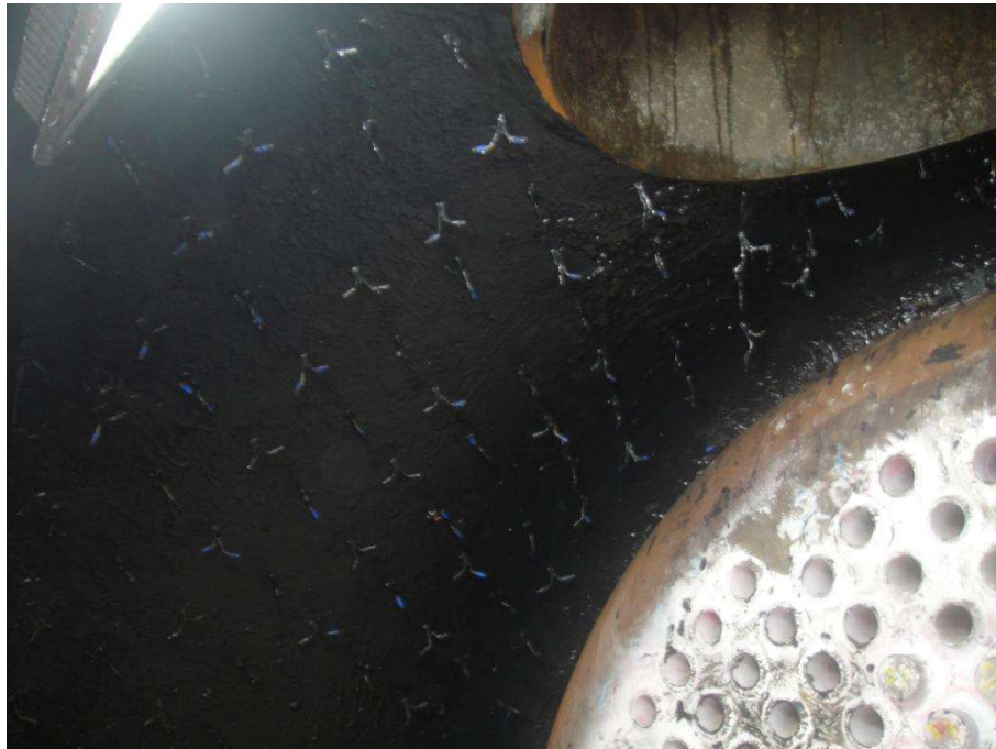
Imagem 8 - Carretel da GV-3601 com massa anticorrosiva
