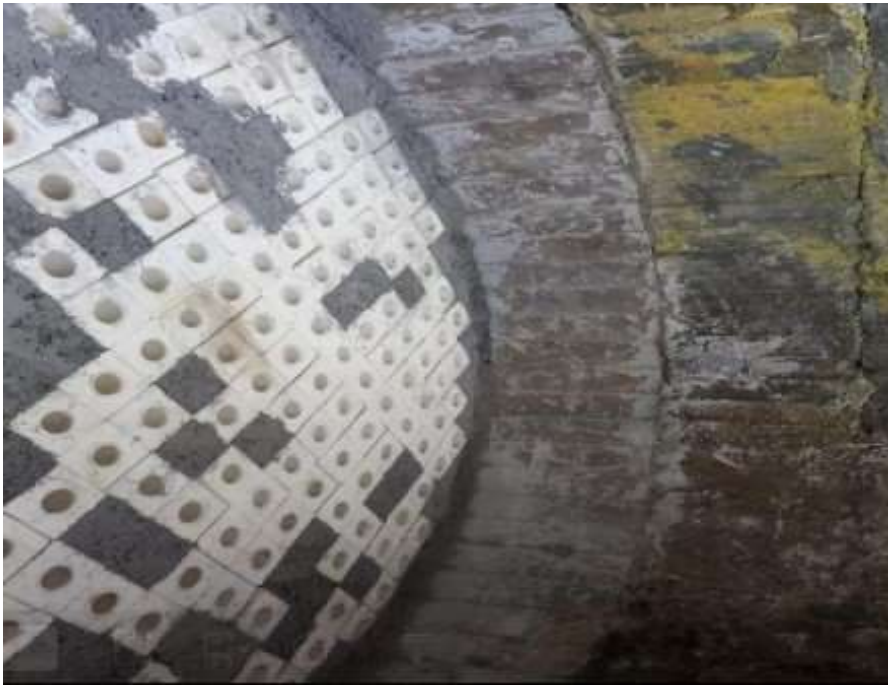
Imagem 27 - Primeira fiada de tijolos e ferrules cerâmicos no B-3601
