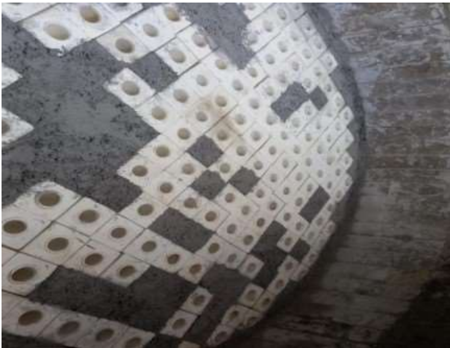
Imagem 28 - Primeira fiada de tijolos e ferrules cerâmicos no B-3601
