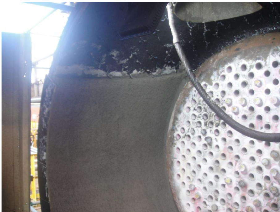
Imagem 12 - Área de aplicação manual do concreto PLW 41
