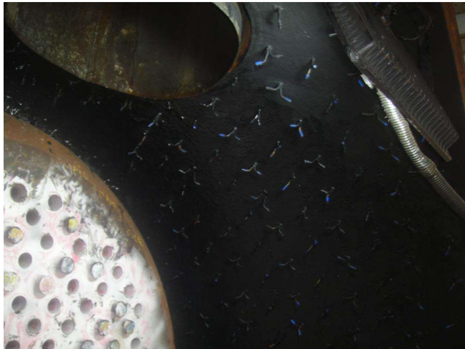
Imagem 10 - Carretel da GV-3601 com massa anticorrosiva
