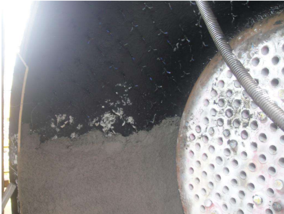
Imagem 11 - Área de aplicação manual do concreto PLW 41
