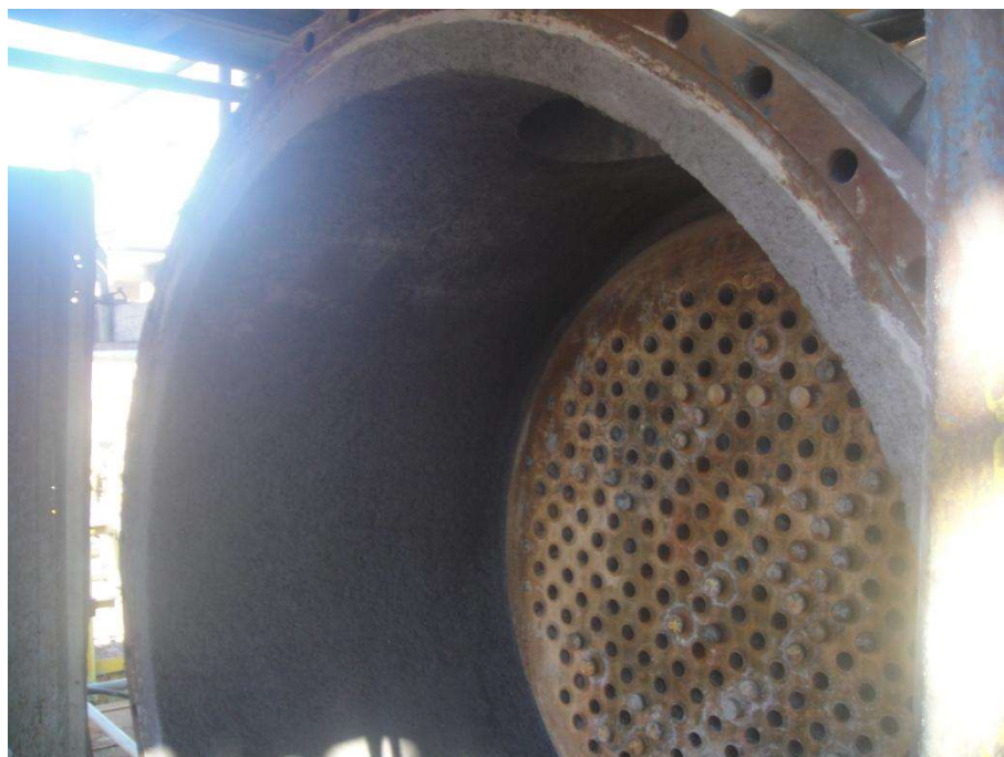
Imagem 24 - Área de projeção do concreto PLW 41
