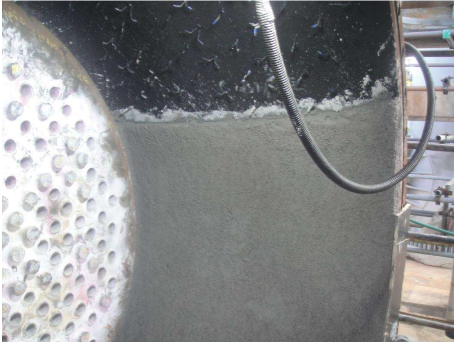
Imagem 13 - Área de aplicação manual do concreto PLW 41
