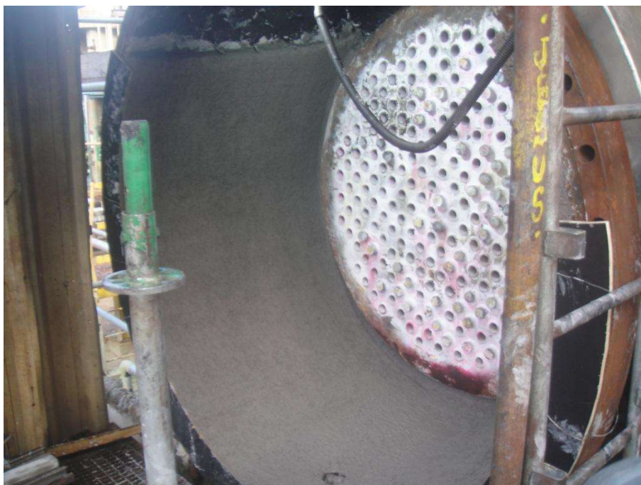
Imagem 14 - Área de aplicação manual do concreto PLW 41
