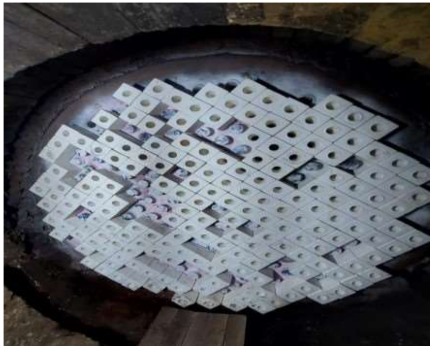
Imagem 30 - Primeira fiada de tijolos e ferrules cerâmicos no B-3601
