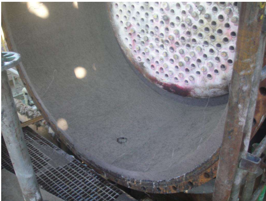
Imagem 18 - Área de aplicação manual do concreto PLW 41
