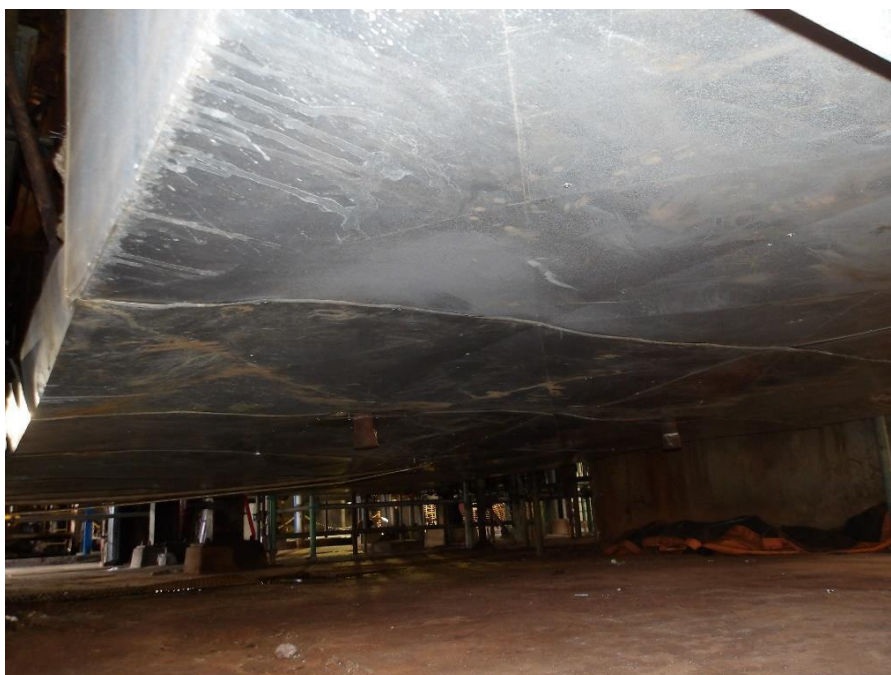
Imagem 10 - Detalhe de aplicação de isolamento térmico na região do fundo da caldeira.
