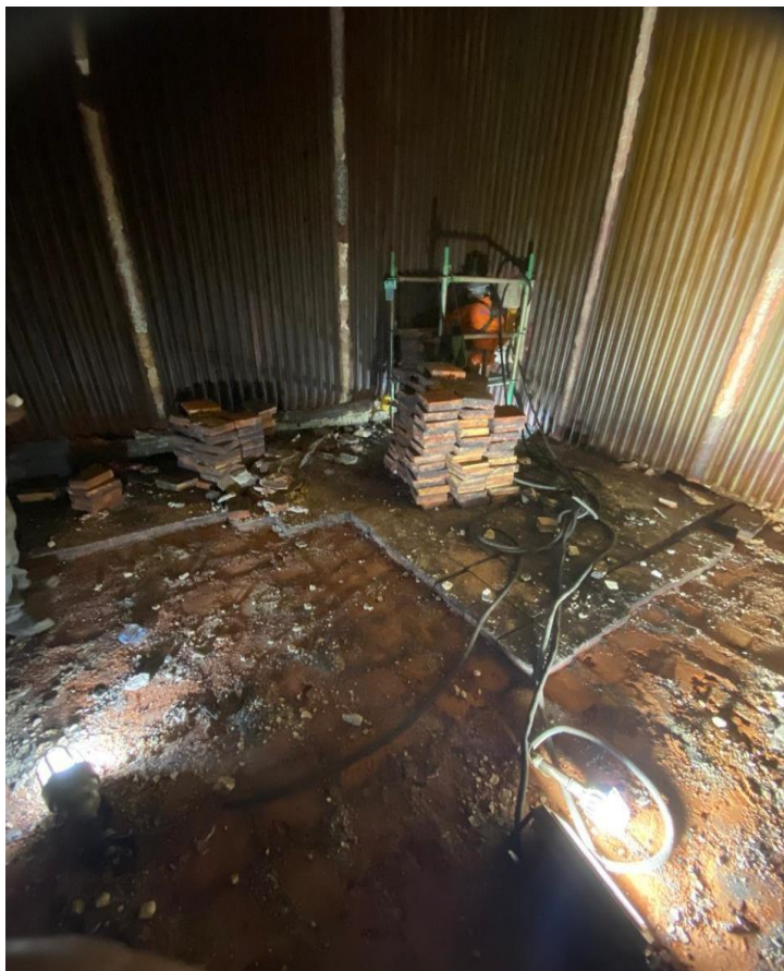
Imagem 13 - Detalhe da demolição do revestimento refratário no piso da fornalha.
