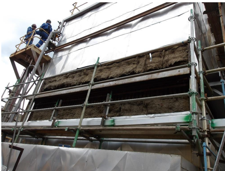
Imagem 01 - Detalhe de remoção de isolamento térmico no buckstay parede sul.
