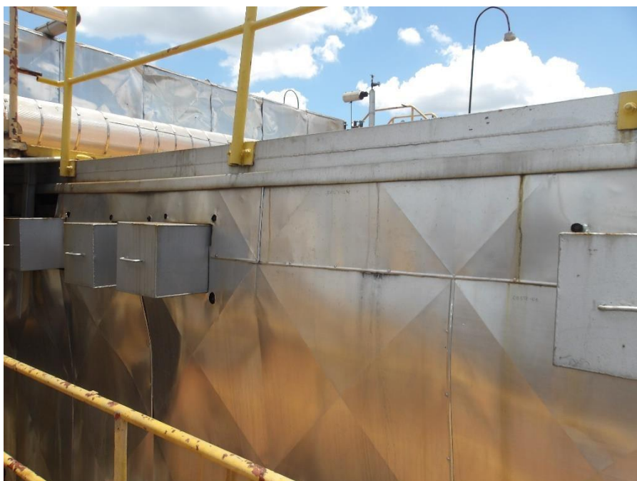
Imagem 08 - Detalhe de aplicação de isolamento térmico nos coletores superiores.
