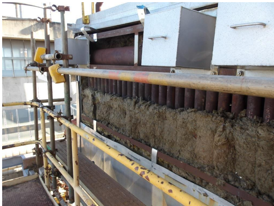
Imagem 07 - Detalhe de remoção de isolamento térmico nos coletores superiores.
