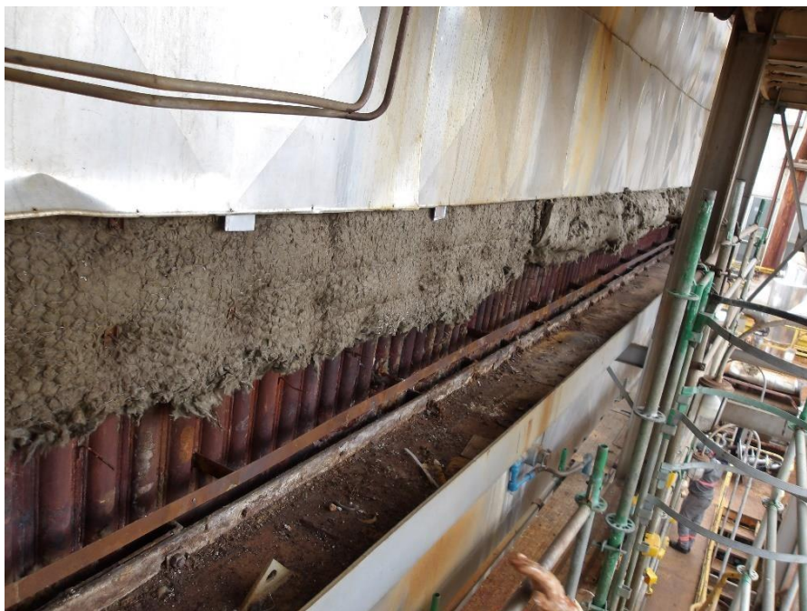
Imagem 05 - Detalhe de remoção de isolamento térmico no buckstay parede oeste.
