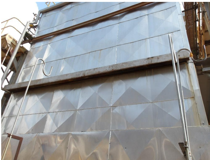
Imagem 02 - Detalhe de aplicação de isolamento térmico na região do Buckstay parede sul.
