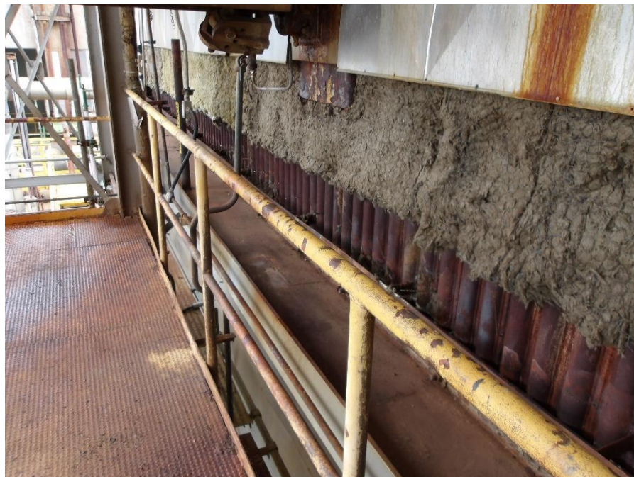
Imagem 03 - Detalhe de remoção de isolamento térmico no buckstaiyl parede leste.
