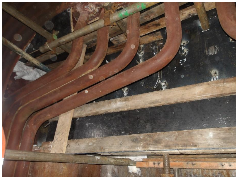
Foto 5 – Instalação das formas para recuperação do refratário
