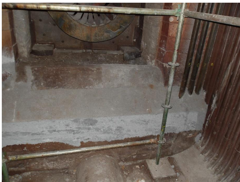
Foto 11 – Recuperação do refratário na região dos blocos do queimador e dos tubos, conforme solicitação
