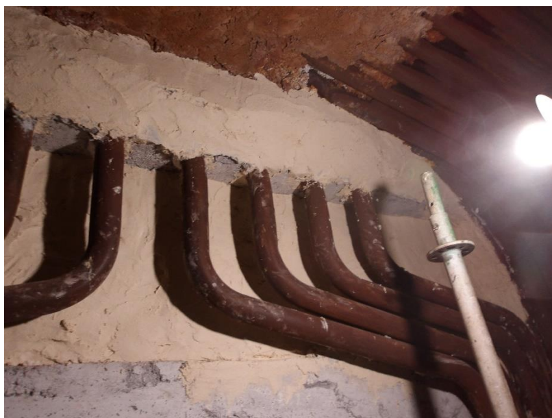
Foto 9 – Aplicação massa refratária Silplate
