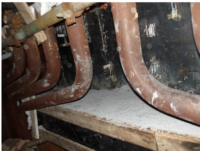
Foto 7 – Aplicação concreto refratário pega química Thermbond 6L
