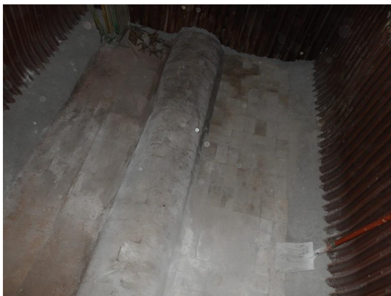
Foto 10 – Recuperação do refratário no piso
