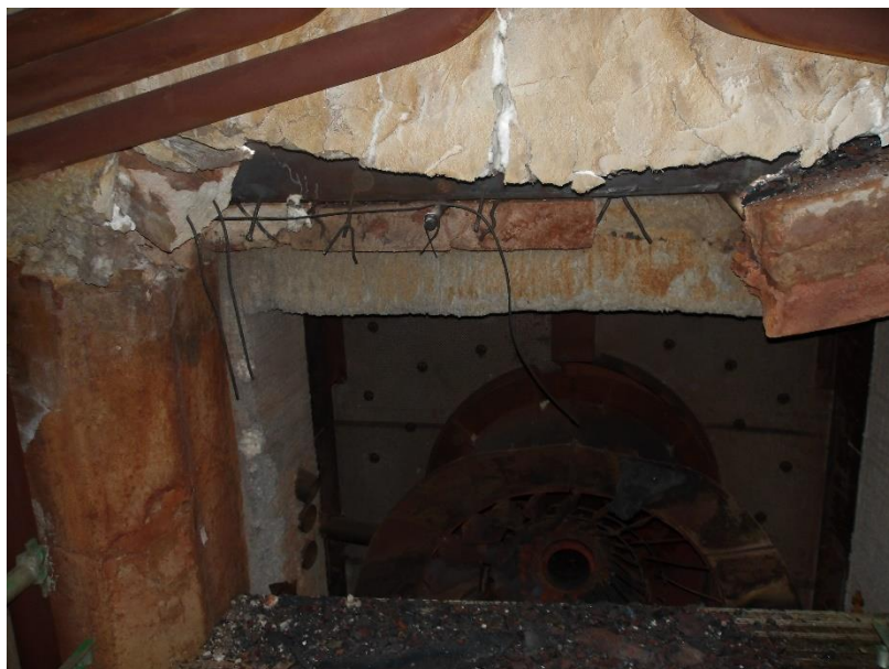
Foto 3 – Detalhe da viga refratária danificada.
