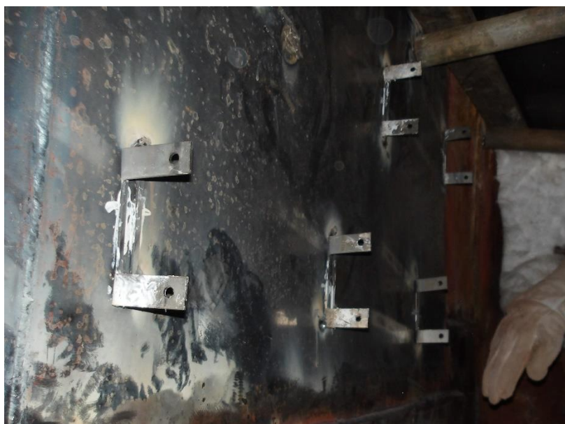
Foto 6 – Instalação das ancoragens para aplicação dos módulos refratários
