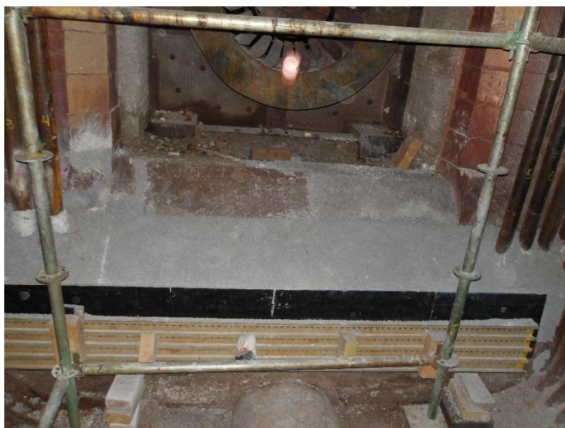
Foto 10 – Recuperação do refratário na região dos blocos do queimador e dos tubos, conforme solicitação
