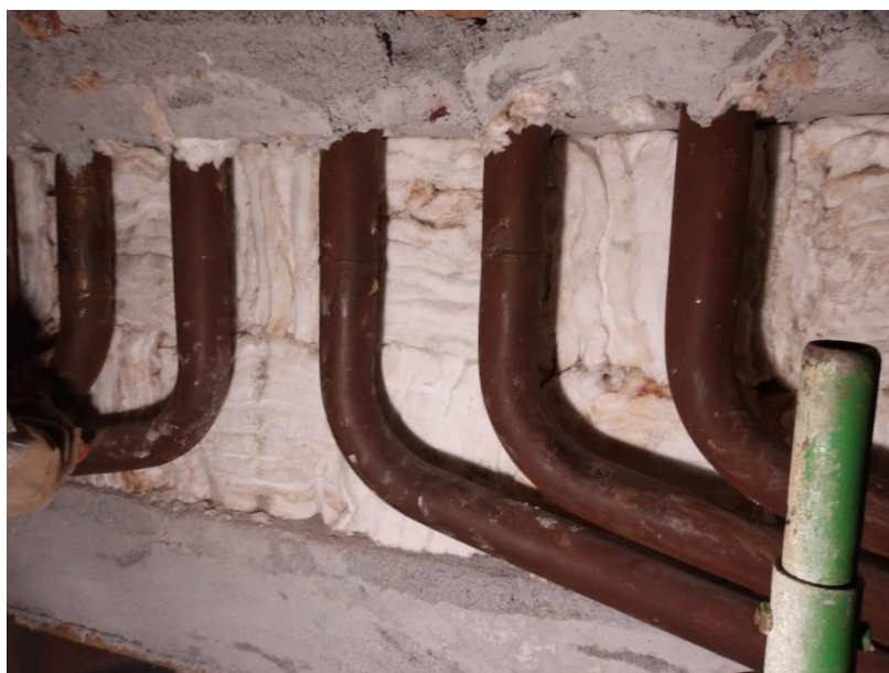
Foto 8 – Aplicação módulos refratários
