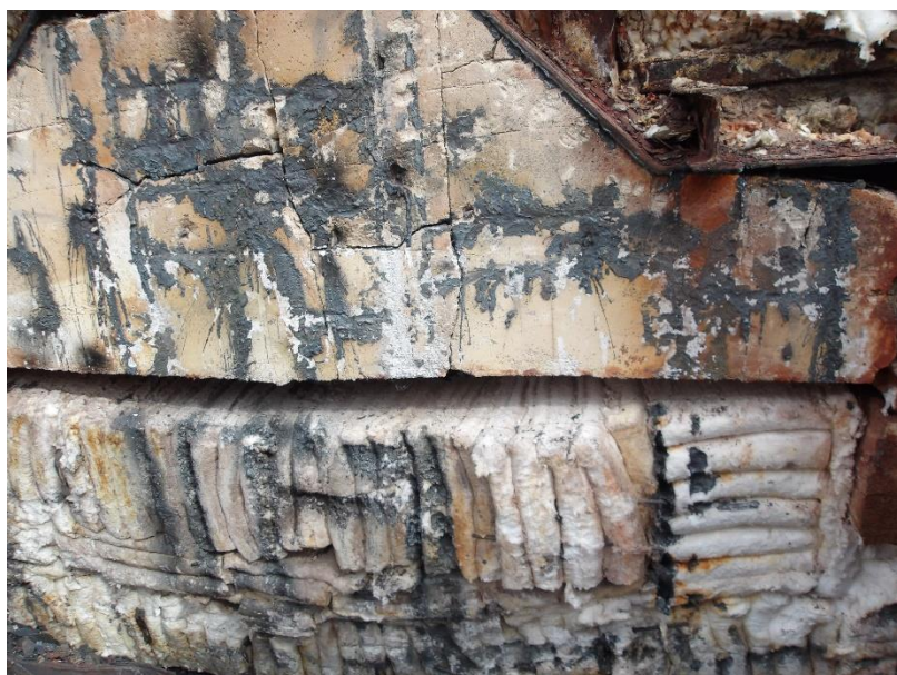
Foto 4 – Refratário acima dos queimadores – lado externo.
