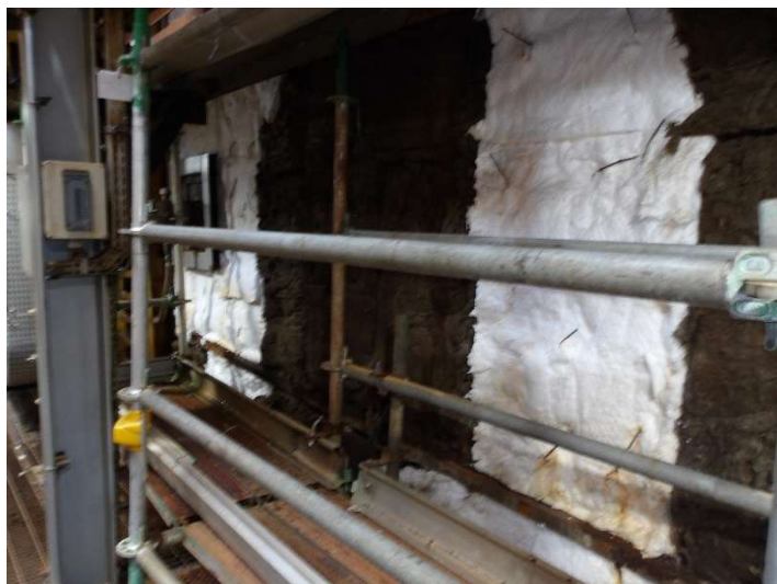
Foto 27 – Isolamento externo.
