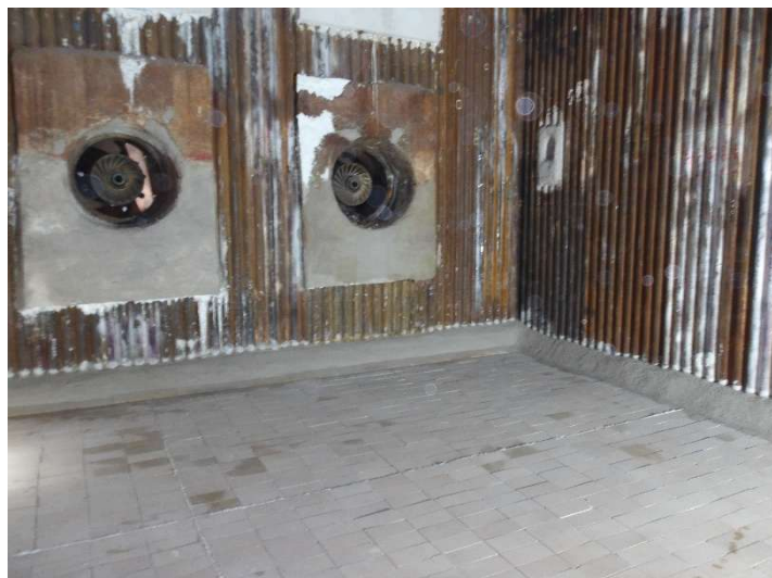
Foto 17 – Reparo do refratário dos queimadores, com o piso e o rodapé.
