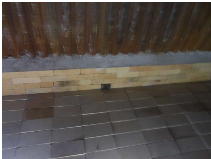
Foto 6 – Piso, rodapé e selagem com tijolos.
