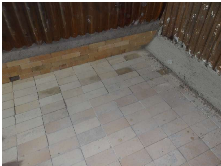
Foto 7 – Piso, rodapé e selagem com tijolos.
