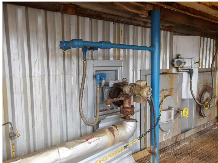
Foto 34 – Proteção mecânica do isolamento.
