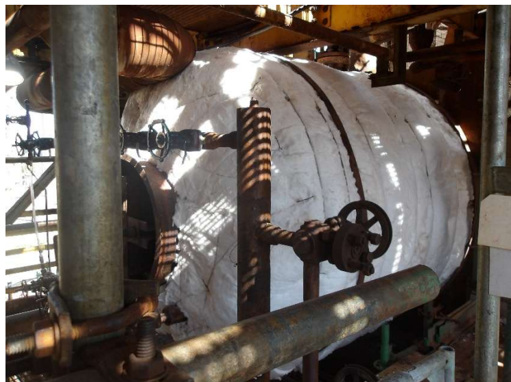
Foto 17 – Isolamento do tubulão.
