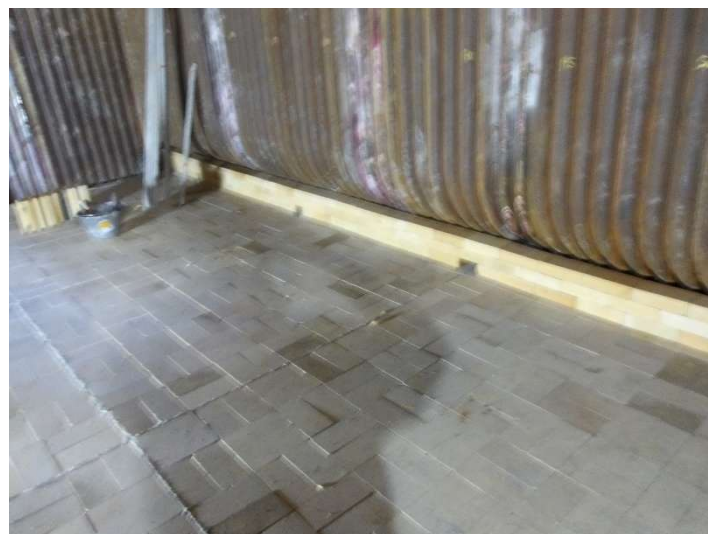
Foto 4 – Piso e rodapé.
