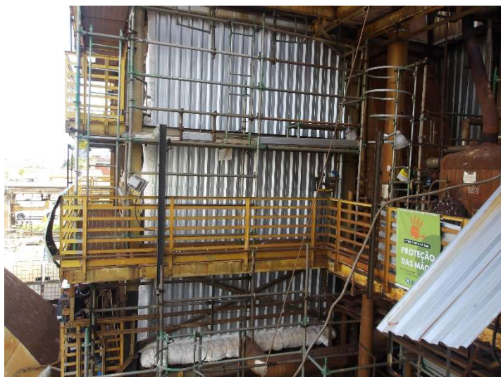
Foto 15 – Proteção mecânica do isolamento térmico.
