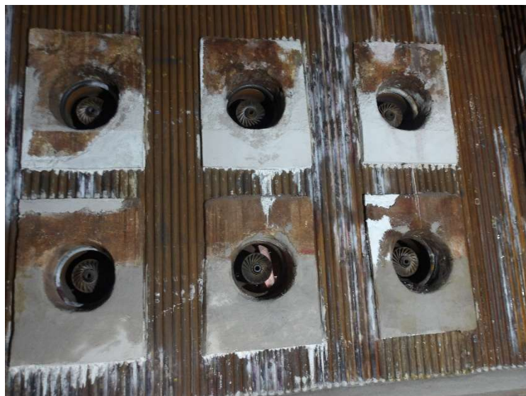
Foto 22 – Reparo no refratário dos queimadores.
