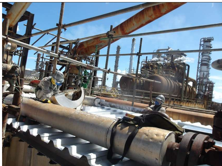
Foto 20 – Instalação da proteção mecânica no teto.
