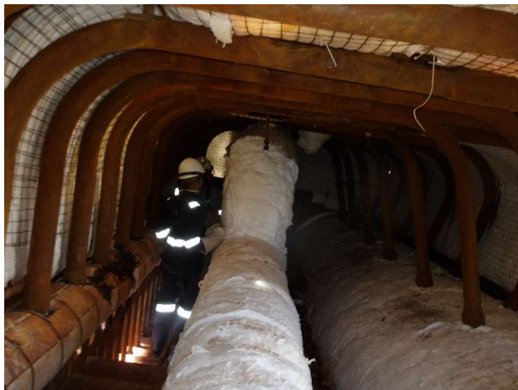
Foto 6 – Isolamento da zona morta.
