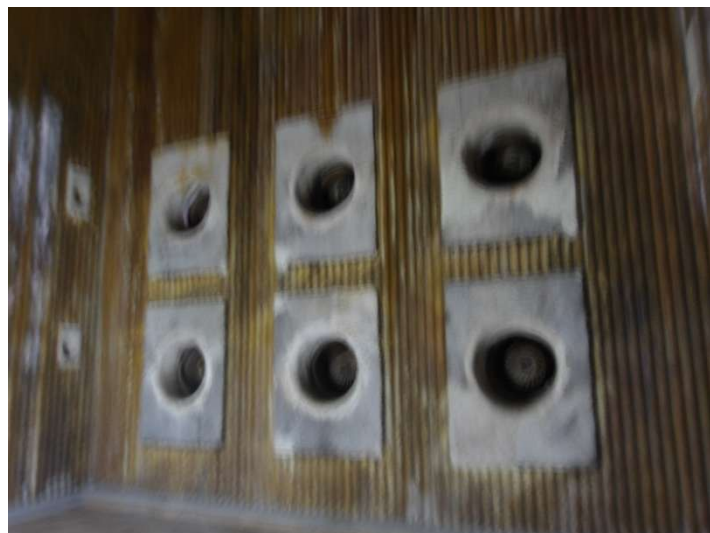
Foto 24 - Reparo no refratário dos queimadores.
