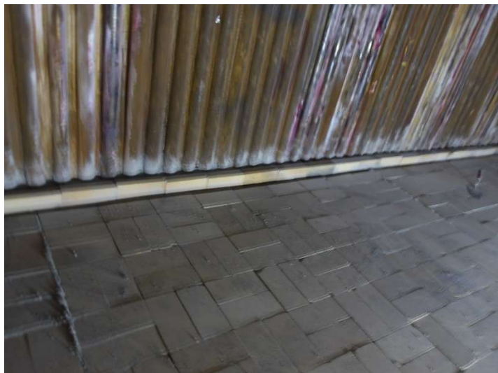
Foto 5 – Piso e rodapé.
