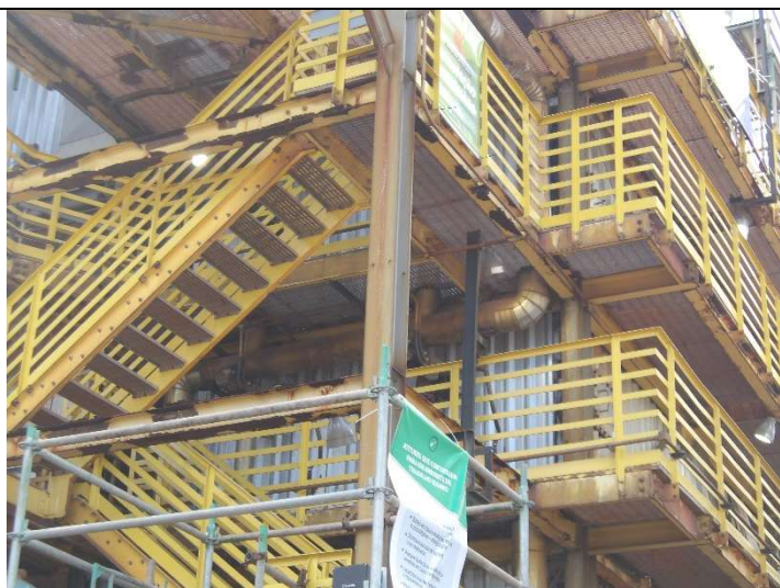
Foto 19 – Proteção mecânica do isolamento.
