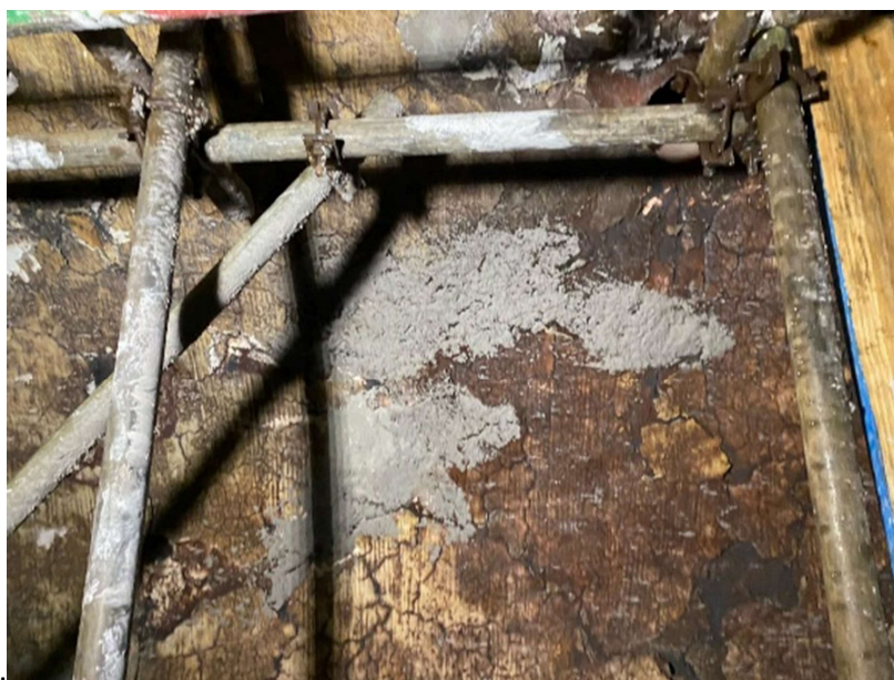
Imagem 44 - Aplicação de concreto Thermbond 6-P na câmara de combustão.
