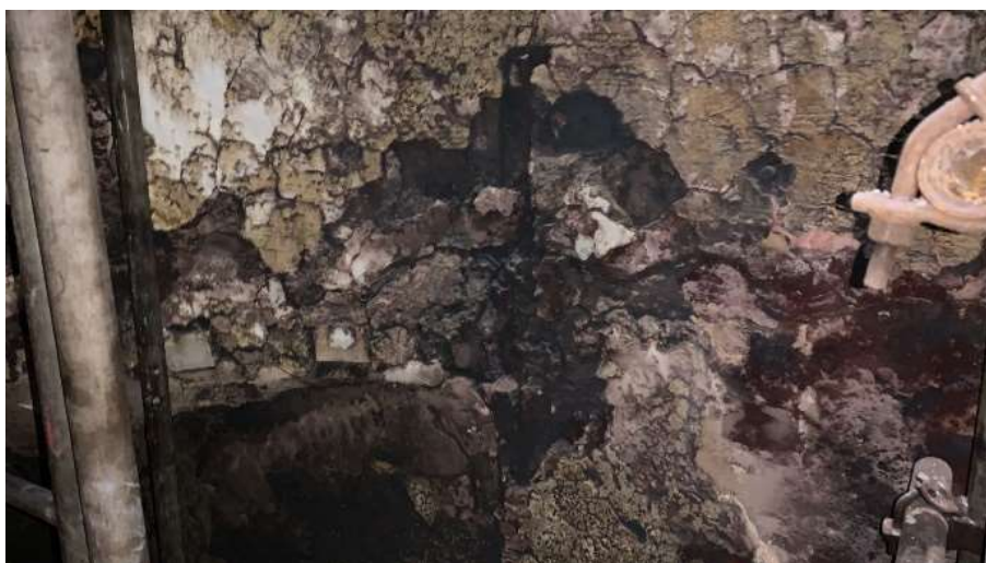
Imagem 8 - Situação do costado da câmara de combustão antes do reparo.
