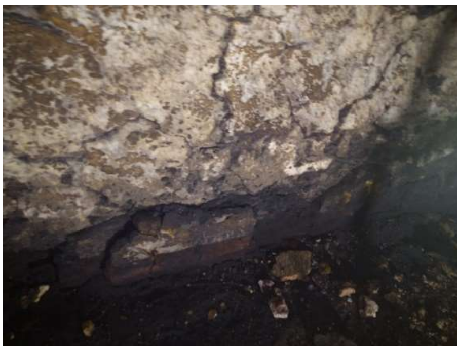
Imagem 4 - Situação do costado da câmara de combustão antes do reparo.
