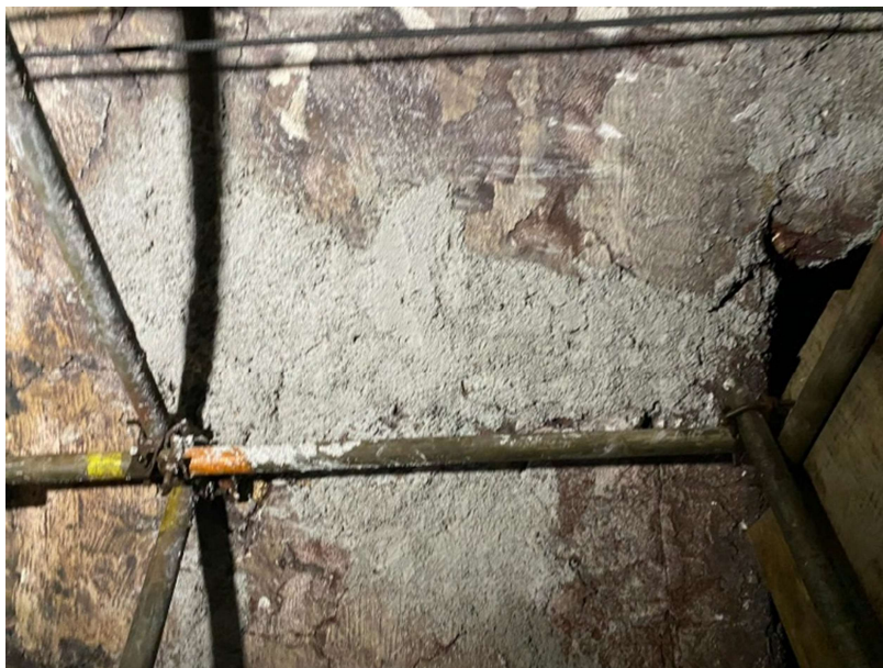
Imagem 43 - Aplicação de concreto Thermbond 6-P na câmara de combustão.
