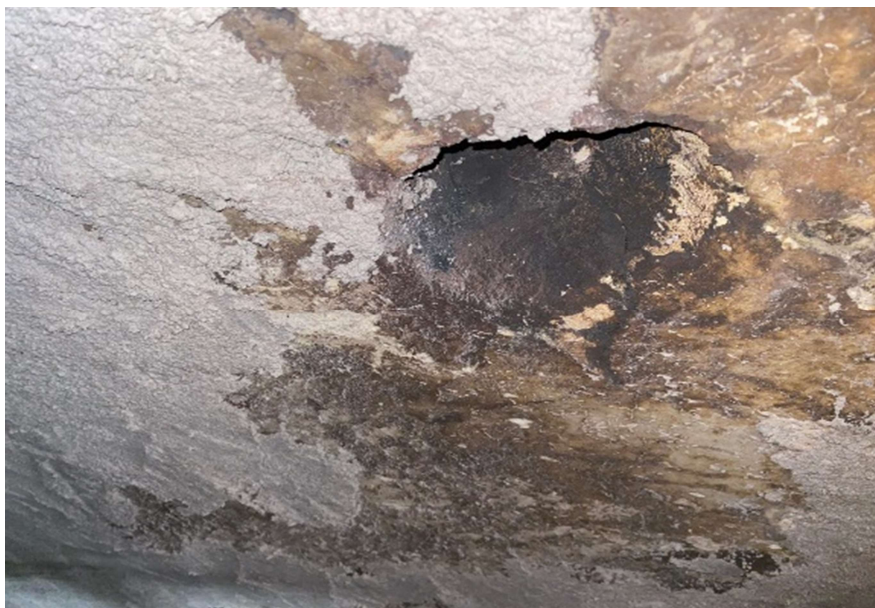
Imagem 35 - Aplicação de concreto Thermbond 6-P na câmara de combustão.
