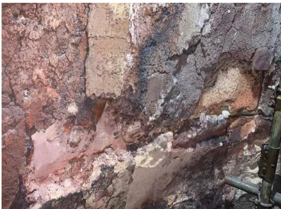
Imagem 18 - Situação do costado da câmara de combustão antes do reparo.
