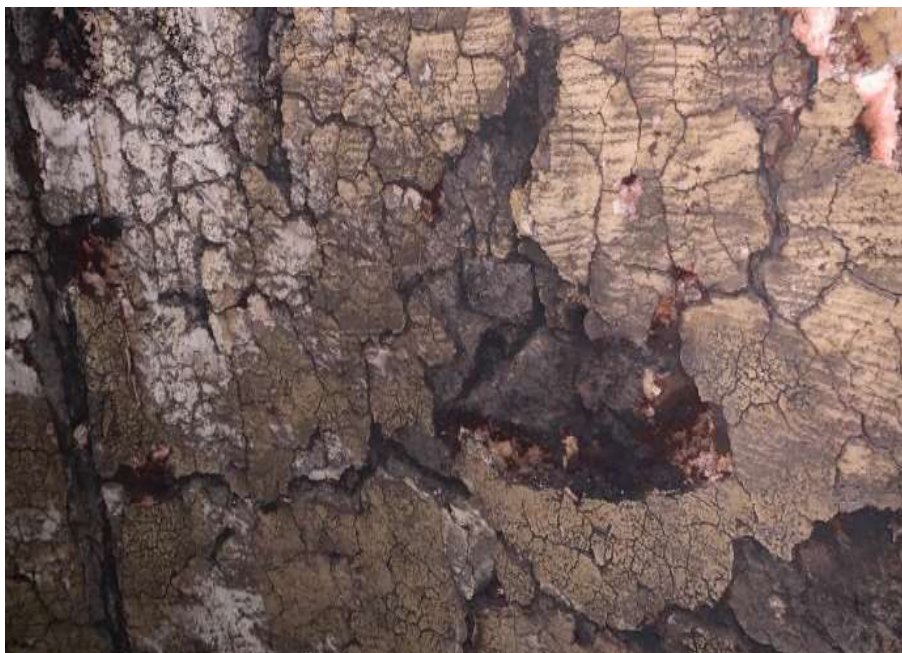
Imagem 14 - Situação do costado da câmara de combustão antes do reparo.
