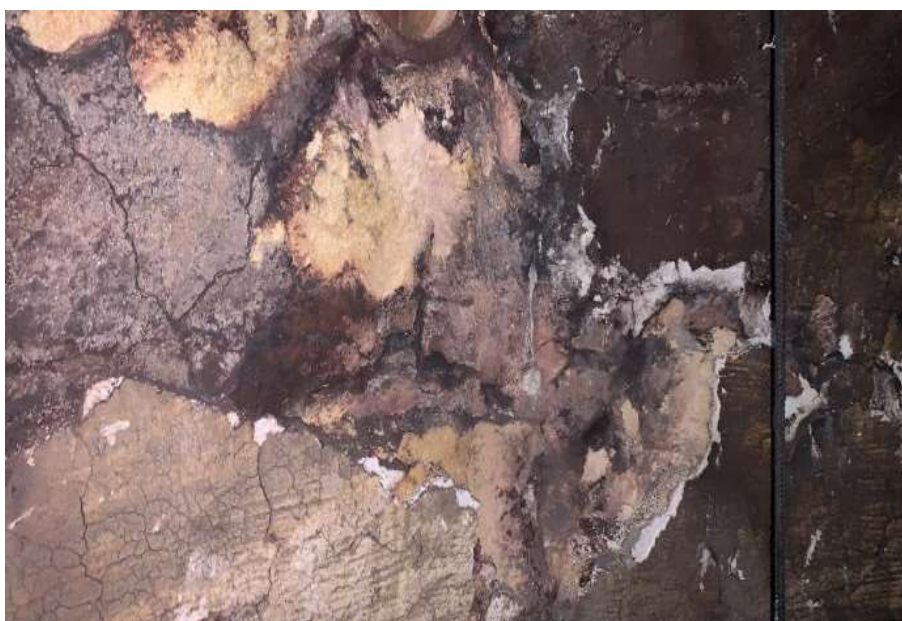
Imagem 16 - Situação do costado da câmara de combustão antes do reparo.
