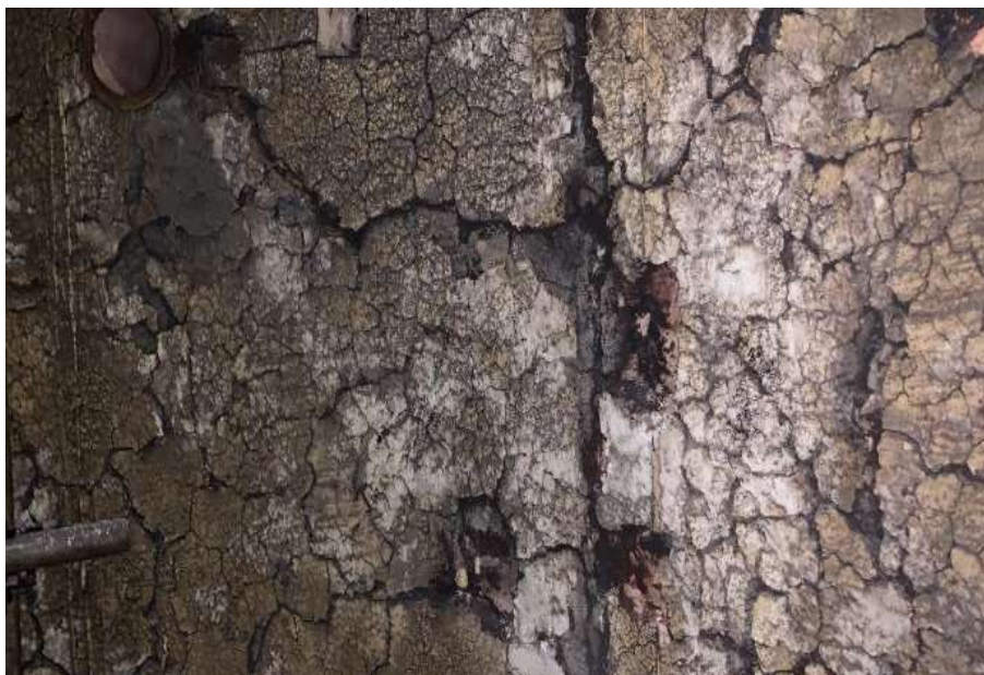
Imagem 13 Situação do costado da câmara de combustão antes do reparo.
