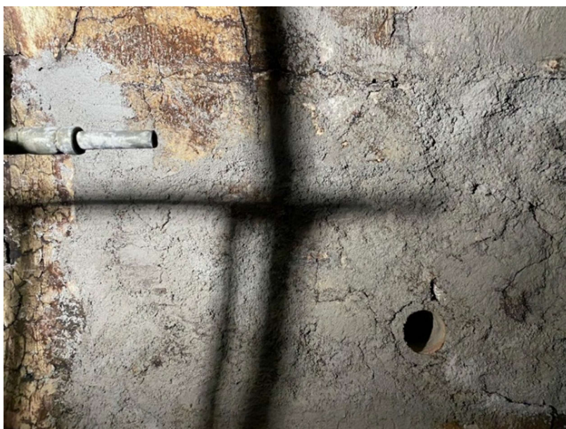
Imagem 42 - Aplicação de concreto ThermoBond 6-P na câmara de combustão.
