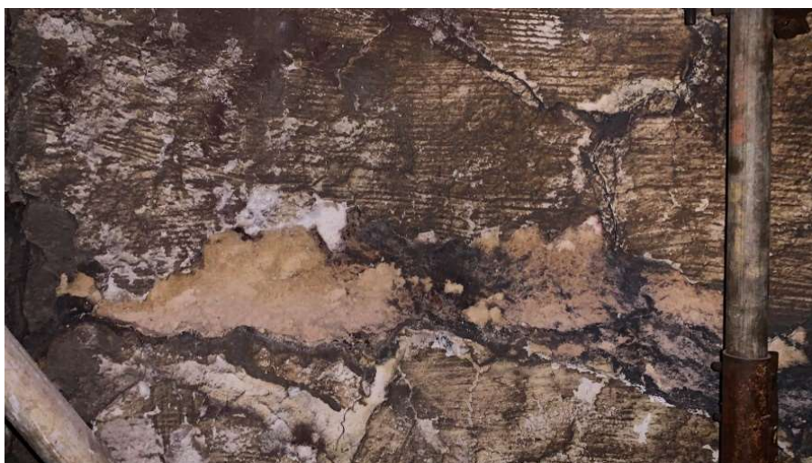
Imagem 12 - Situação do costado da câmara de combustão antes do reparo.
