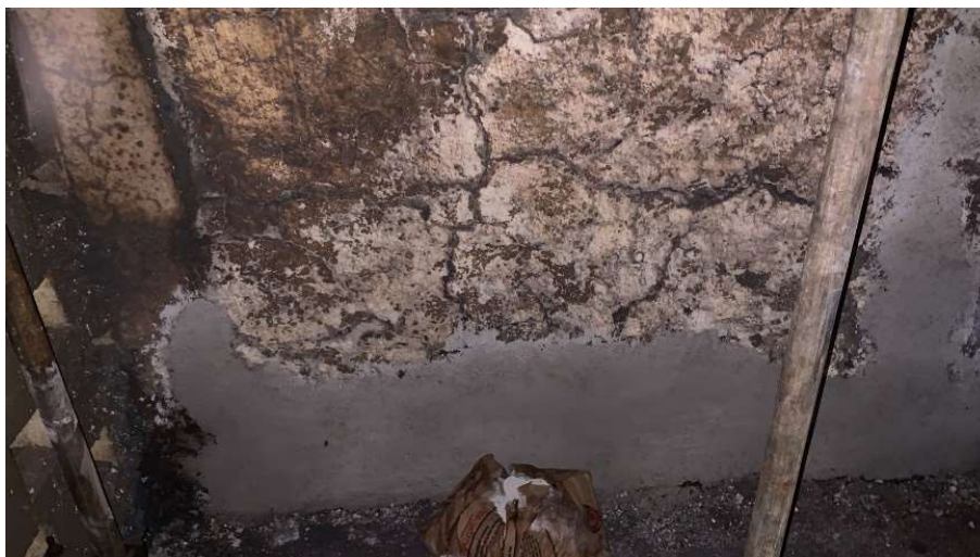
Imagem 31 - Aplicação de concreto Thermbond 6-P na câmara de combustão.
