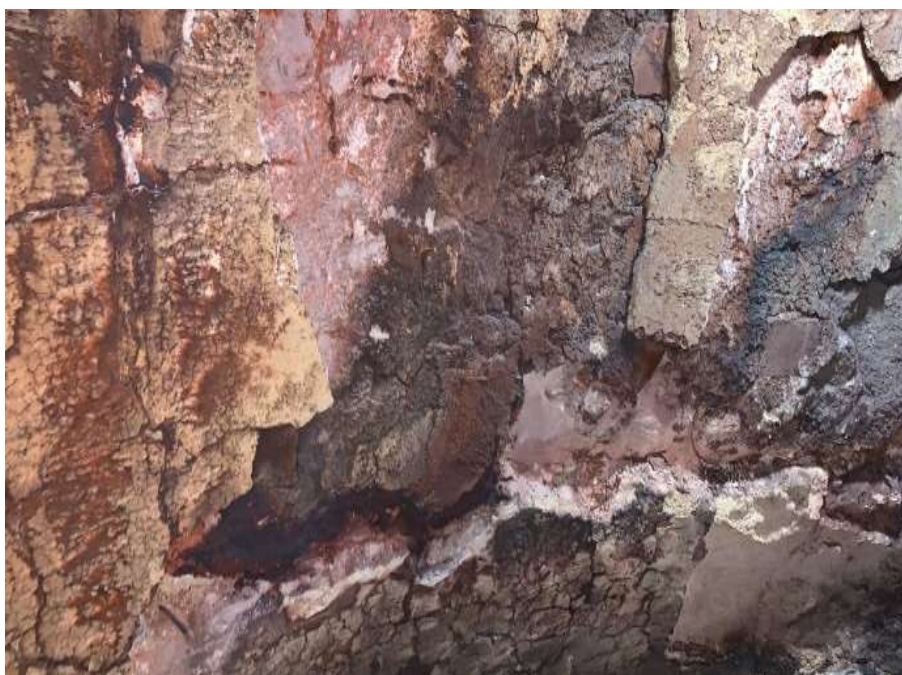
Imagem 22 - Situação do costado da câmara de combustão antes do reparo.
