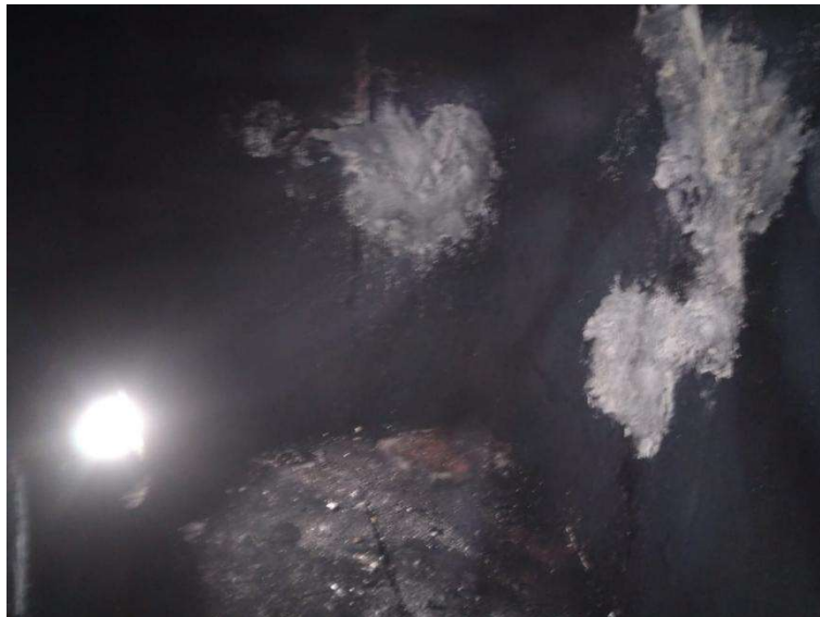
Imagem 52 - Reparo do revestimento refratário na região do duto de entrada de gases.
