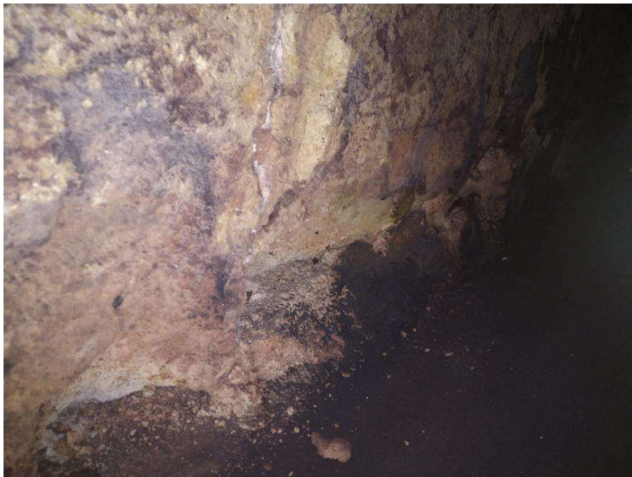
Imagem 7 – Situação do costado da câmara de combustão antes do reparo.
