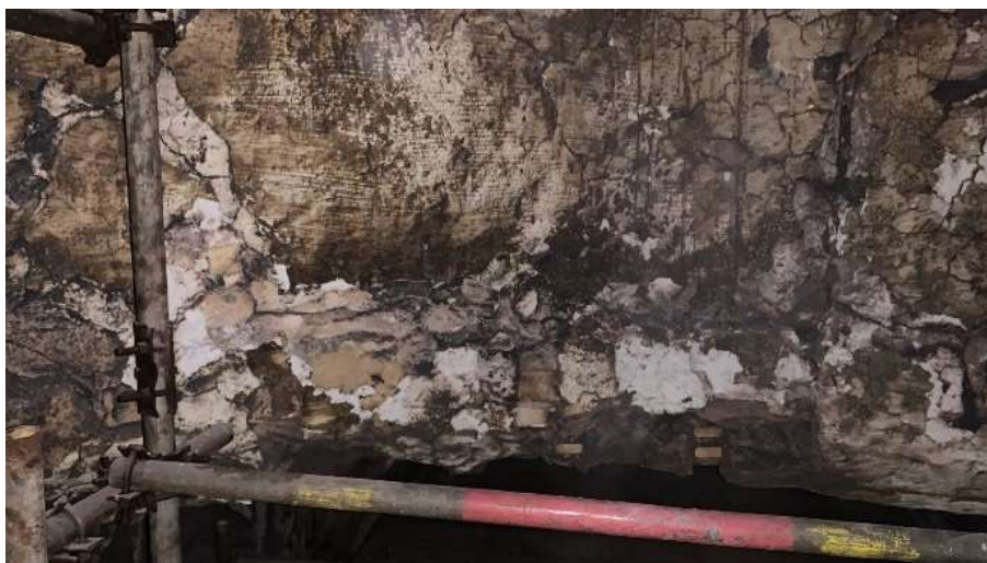
Imagem 10 - Situação do costado da câmara de combustão antes do reparo.
