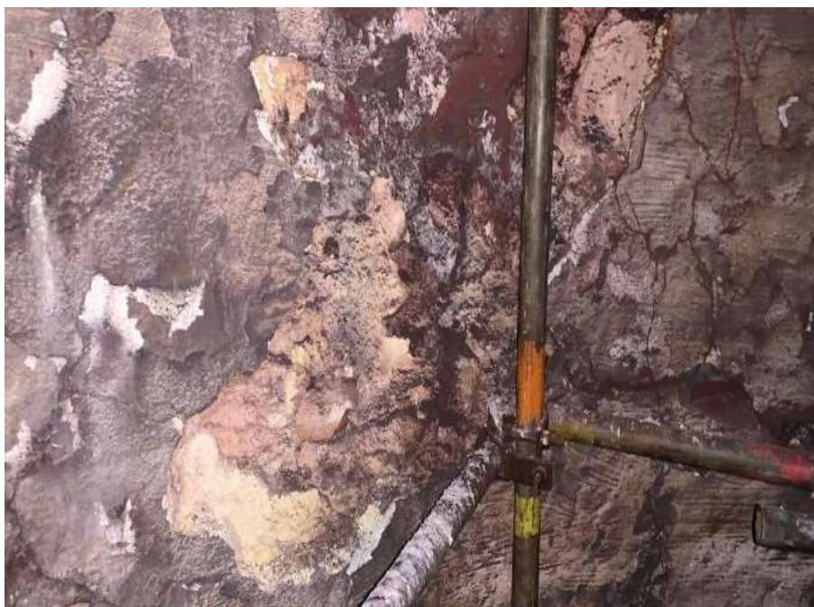
Imagem 20 - Situação do costado da câmara de combustão antes do reparo.
