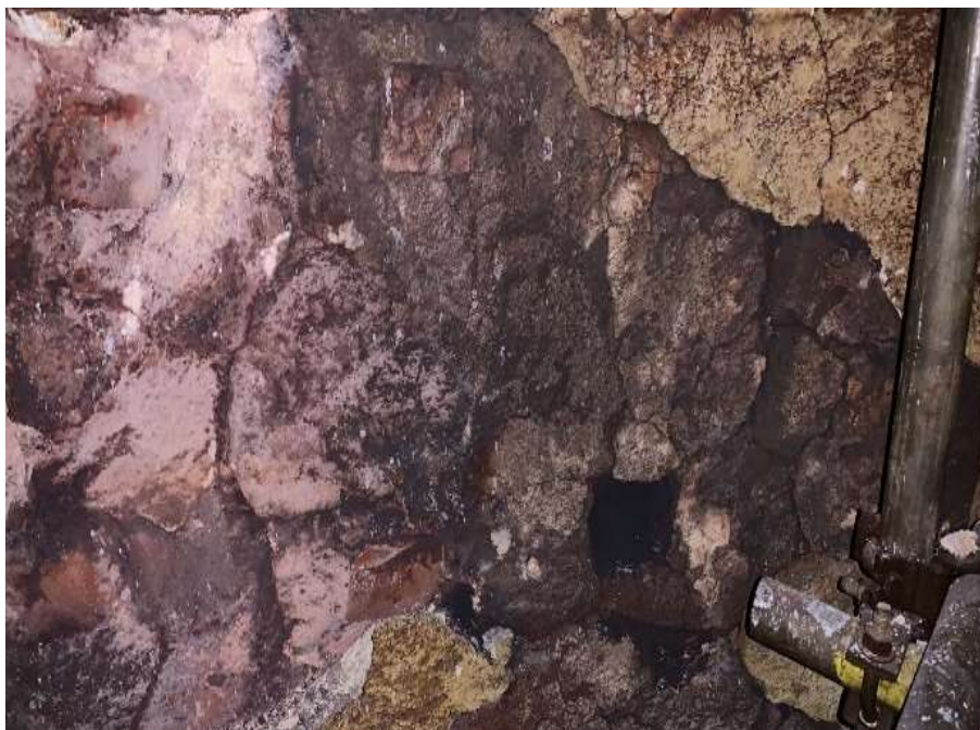
Imagem 19 - Situação do costado da câmara de combustão antes do reparo.
