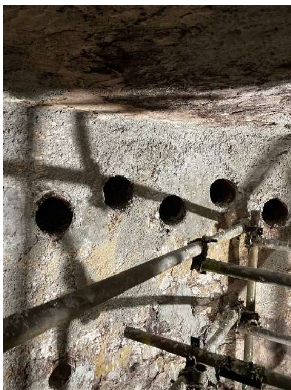
Imagem 28 - Situação do costado da câmara de combustão após do reparo.
