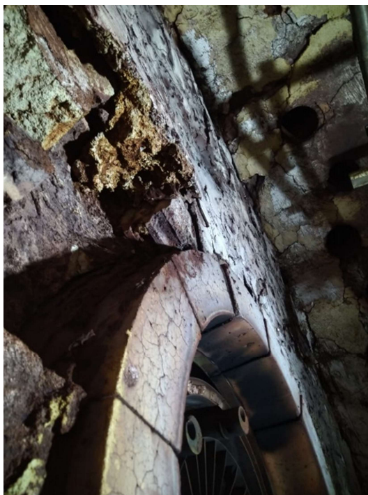
Imagem 25 - Situação do teto da câmara de combustão na região do queimador antes do reparo.
