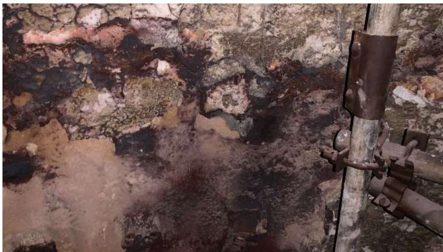
Imagem 9 - Situação do costado da câmara de combustão antes do reparo.
