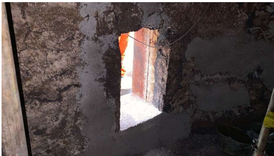
Imagem 33 - Aplicação de concreto Thermbond 6-P na câmara de combustão.
