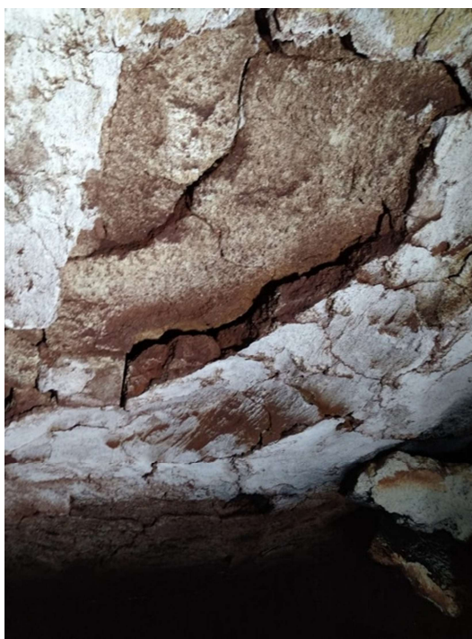
Imagem 24 - Situação do costado da câmara de combustão antes do reparo.
