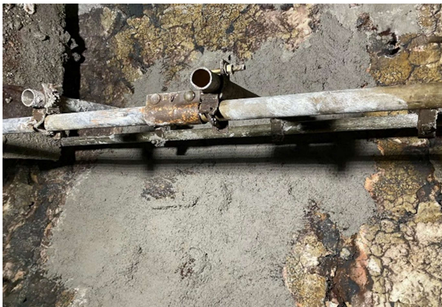
Imagem 37 - Aplicação de concreto Thermbond 6-P na câmara de combustão.
