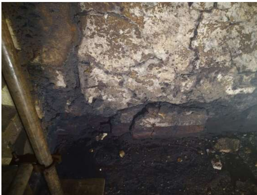
Imagem 3 – Situação do costado da câmara de combustão antes do reparo.
