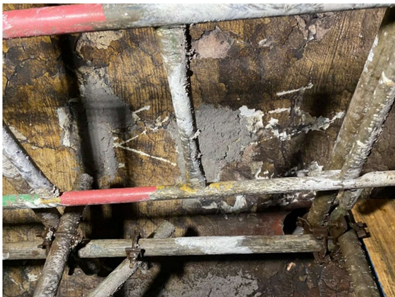
Imagem 48 - Aplicação de concreto Thermbond 6-P na câmara de combustão.
