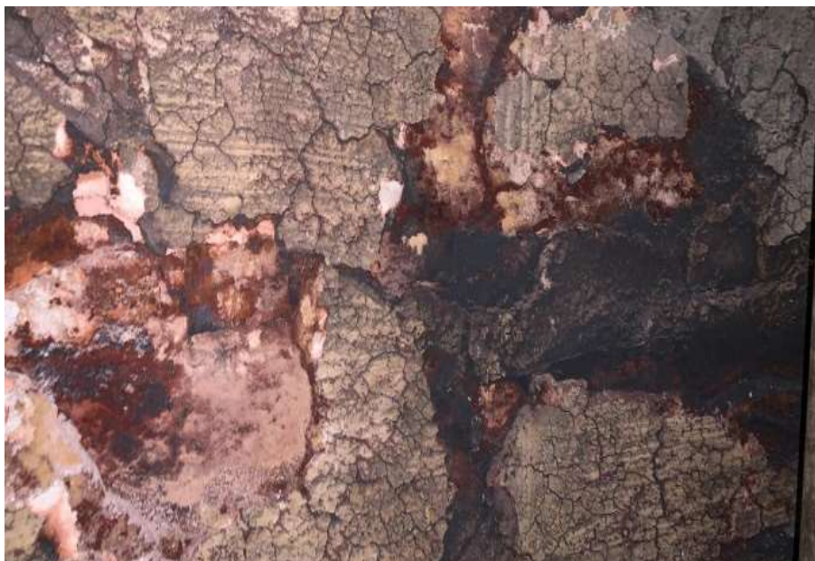
Imagem 15 - Situação do costado da câmara de combustão antes do reparo.
