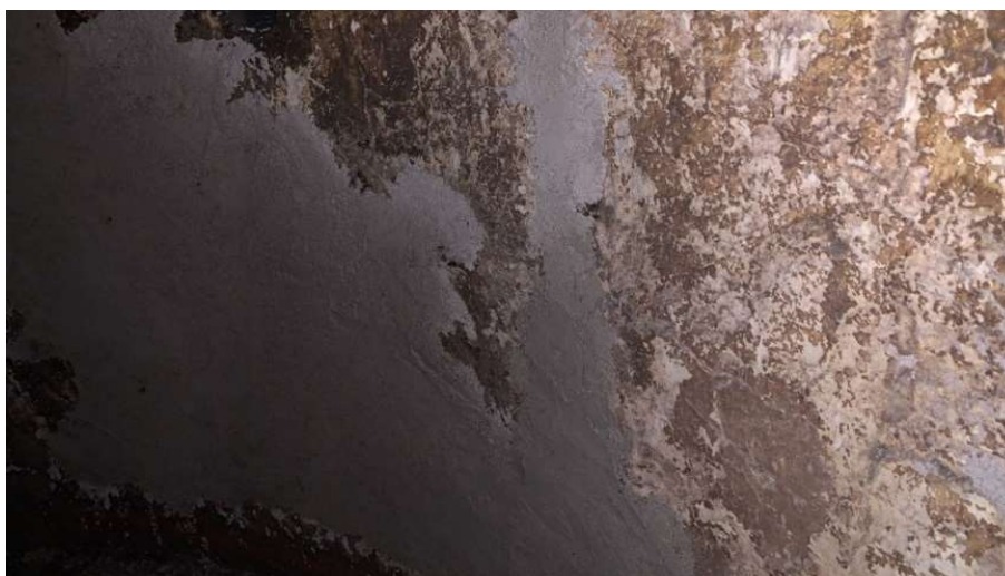
Imagem 32 - Aplicação de concreto Thermbond 6-P na câmara de combustão.
