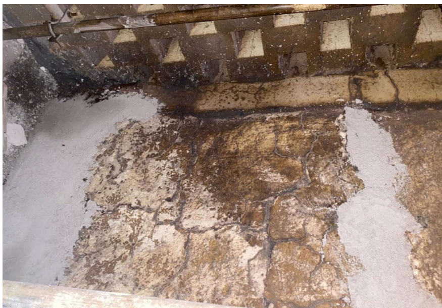
Imagem 38 - Aplicação de concreto Thermbond 6-P na câmara de combustão.
