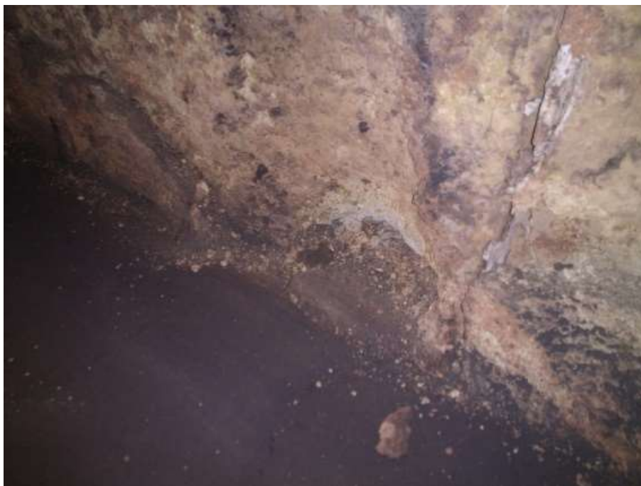
Imagem 5 - Situação do costado da câmara de combustão antes do reparo.
