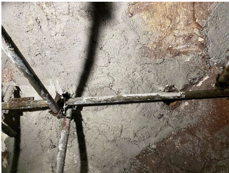
Imagem 41 - Aplicação de concreto ThermoBond 6-P na câmara de combustão.
