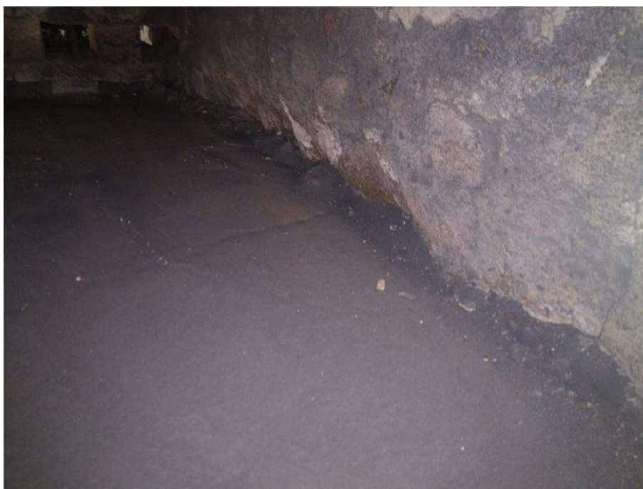
Imagem 6 - Situação do costado da câmara de combustão antes do reparo.
