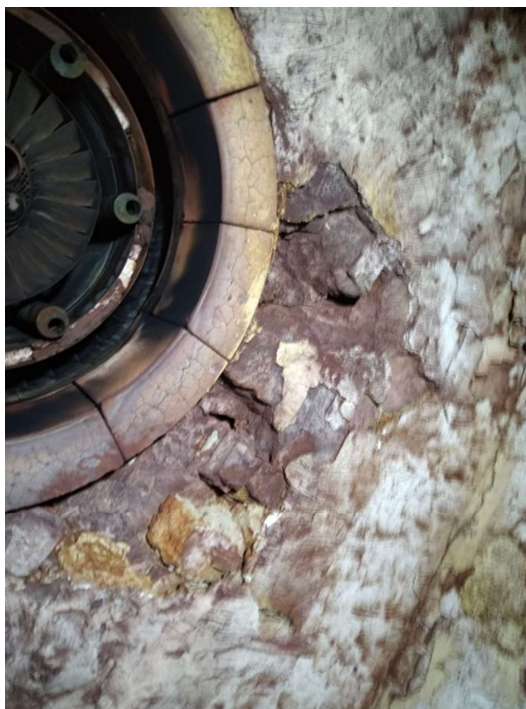
Imagem 23 - Situação do teto da câmara de combustão na região do queimador antes do reparo.
