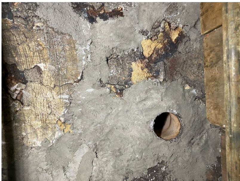
Imagem 47 - Aplicação de concreto Thermbond 6-P na câmara de combustão.
