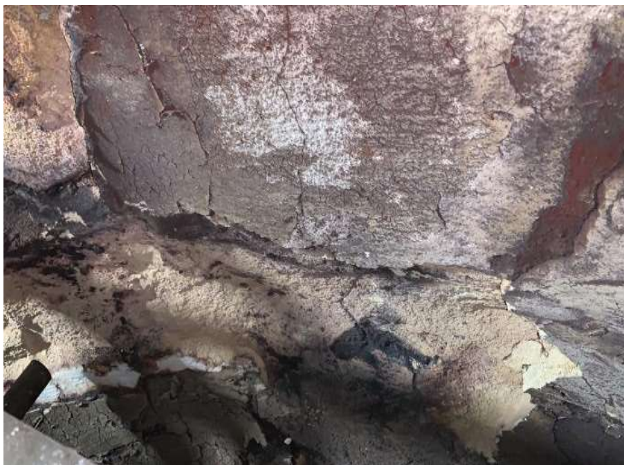
Imagem 21 - Situação do costado da câmara de combustão antes do reparo.
