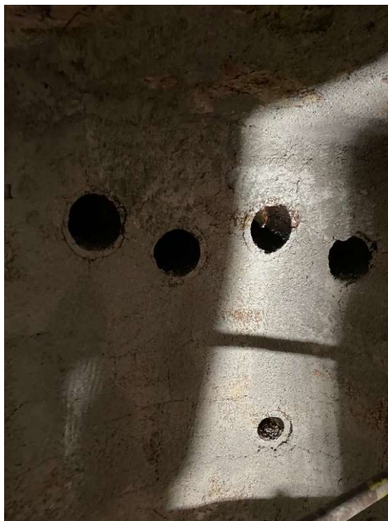
Imagem 27 - Situação do costado da câmara de combustão após o reparo.
