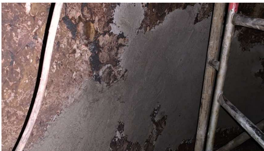
Imagem 30 - Aplicação de concreto Thermbond 6-P na câmara de combustão.
