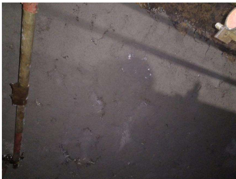
Imagem 55 - Reparo do revestimento refratário da segunda câmara de vapor com Castibar N.
