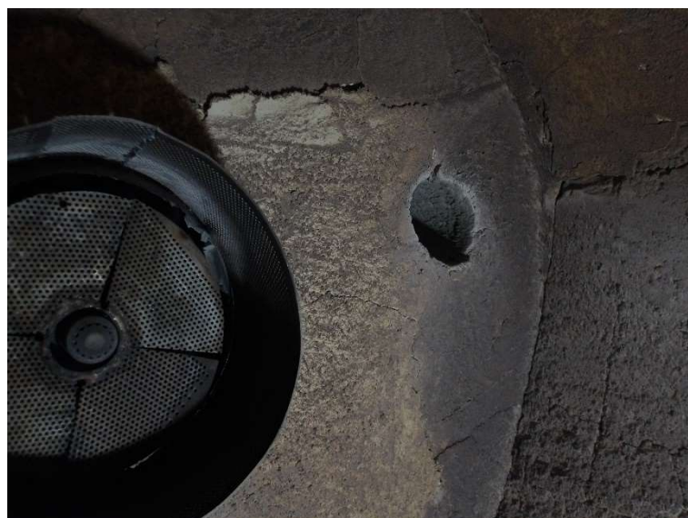
Imagem 14 - Identificação do desprendimento do revestimento refratário da parede do queimador.
