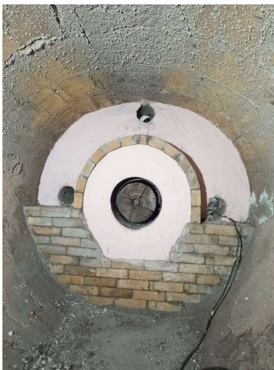
Imagem 19 - Finalização da recuperação da parede do queimador com aplicação de Silplate.
