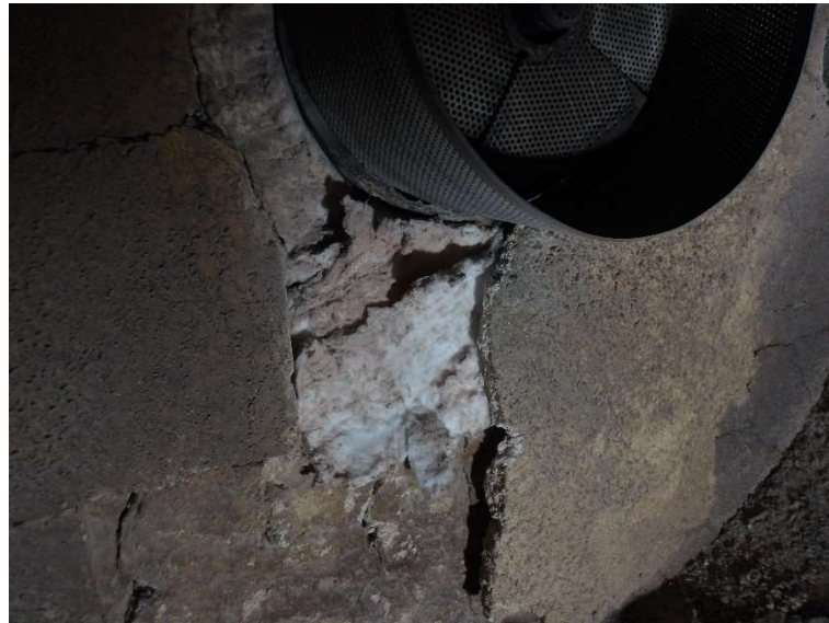
Imagem 13 - Identificação do desprendimento do revestimento refratário da parede do queimador.
