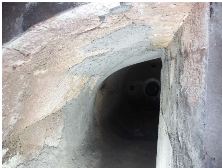
Imagem 6 - Aplicação de concreto para recuperação do revestimento refratário.
