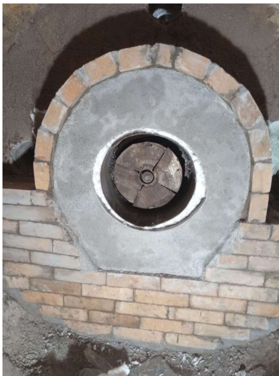
Imagem 18 – Detalhe do embrechamento do queimador com manta de fibra cerâmica.
