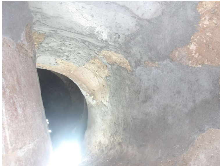
Imagem 10 - Aplicação de concreto para recuperação do revestimento refratário.
