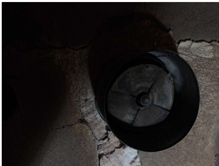
Imagem 15 Identificação do desprendimento do revestimento refratário da parede do queimador.
