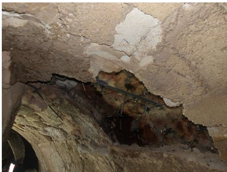
Imagem 4 - Demolição do revestimento refratário com exposição das ancoragens para inspeção dos pontos necessários de intervenção.
