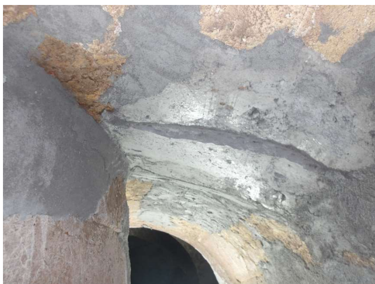
Imagem 7 - Aplicação de concreto para recuperação do revestimento refratário.
