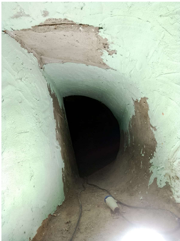
Imagem 12 - Aplicação de Silplate para recuperação do revestimento refratário.
