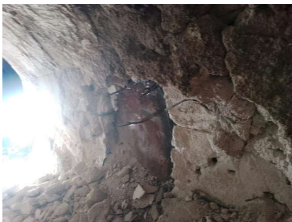
Imagem 2 – Demolição do revestimento refratário com exposição das ancoragens para inspeção dos pontos necessários de intervenção.
