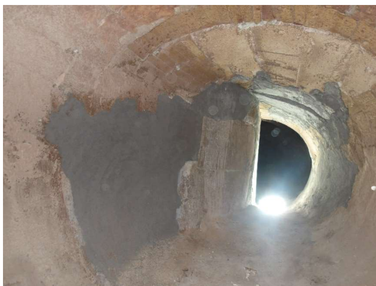
Imagem 9 - Aplicação de concreto para recuperação do revestimento refratário.
