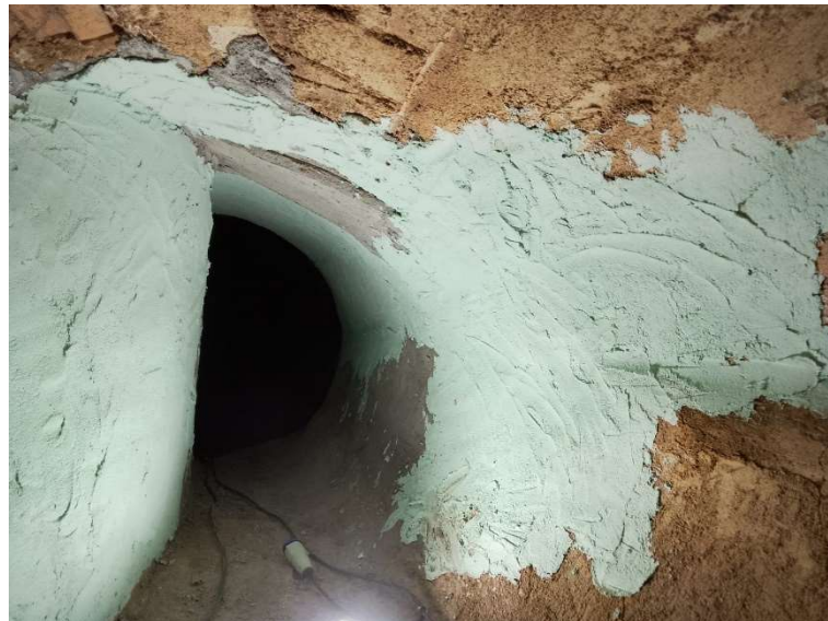
Imagem 11 - Aplicação de Silplate para recuperação do revestimento refratário.
