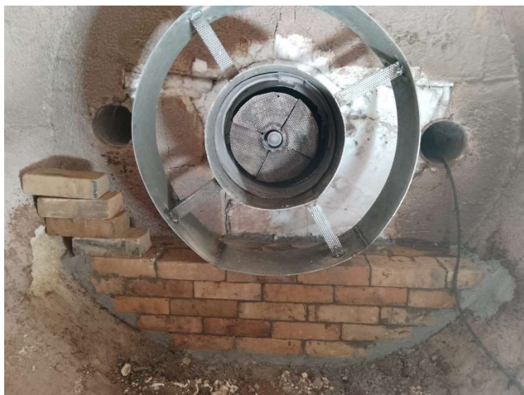
Imagem 16 - Recuperação do revestimento refratário da parede do queimador através da montagem de parede com tijolos.
