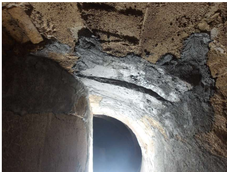
Imagem 8 - Aplicação de concreto para recuperação do revestimento refratário.
