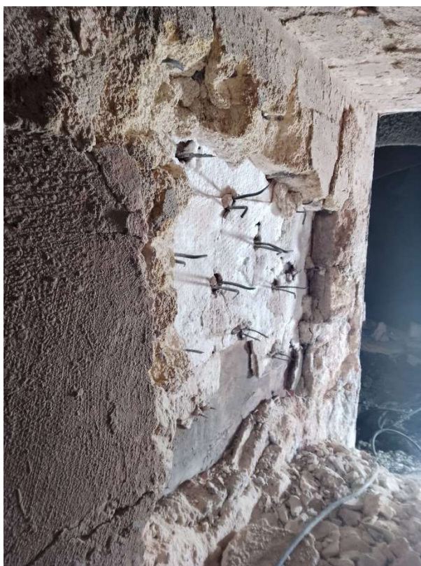
Imagem 3 - Demolição do revestimento refratário com exposição das ancoragens para inspeção dos pontos necessários de intervenção.
