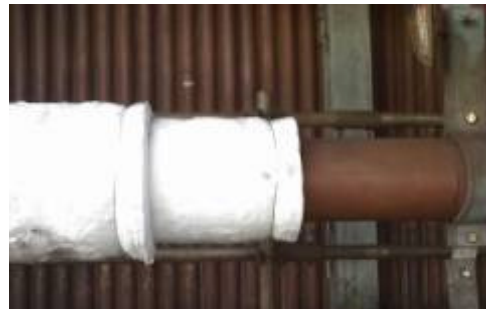
Isolamento em 2 camadas
