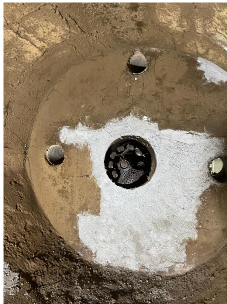
Imagem 3 - Parede do queimador com embrechamento em manta de fibra cerâmica.
