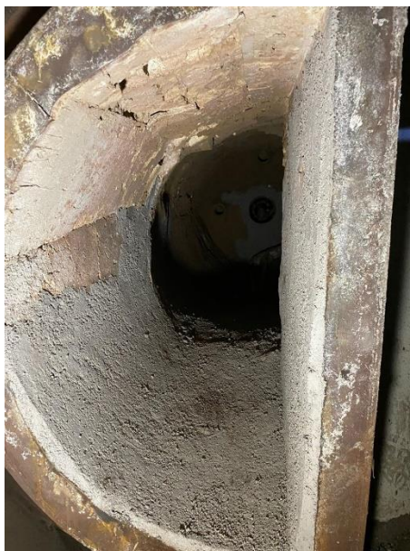
Imagem 1 - Aplicação de Castibar N para reparo do revestimento na entrada do equipamento.
