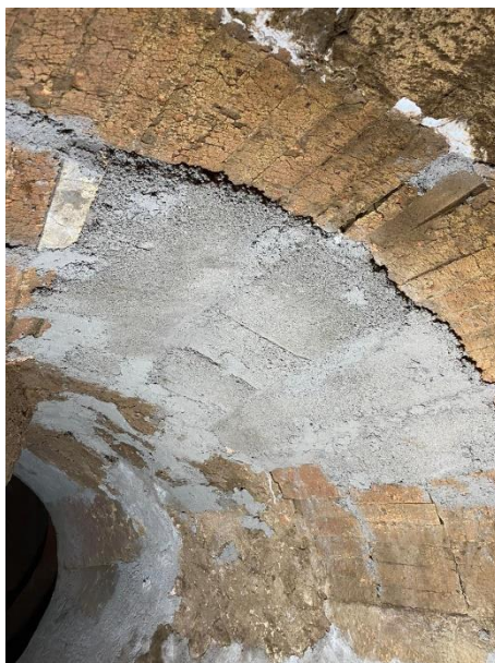
Imagem 4 - Troca de tijolo refratário pelo Castibar N na geratriz superior.
