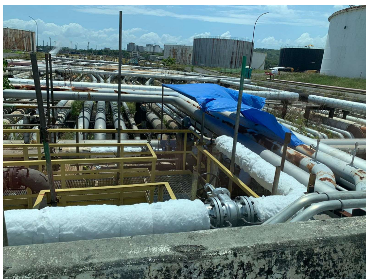
Imagem 2 - Vista das linhas após a instalação do isolamento fibroso.
