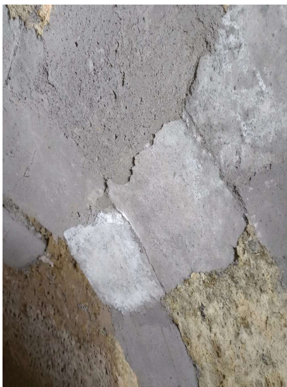
Imagem 10 - Reparo de regiões do teto com perda de espessura com Petrobond 70.
