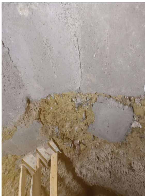
Imagem 08 - Reparo de regiões do teto com perda de espessura com Petrobond 70.
