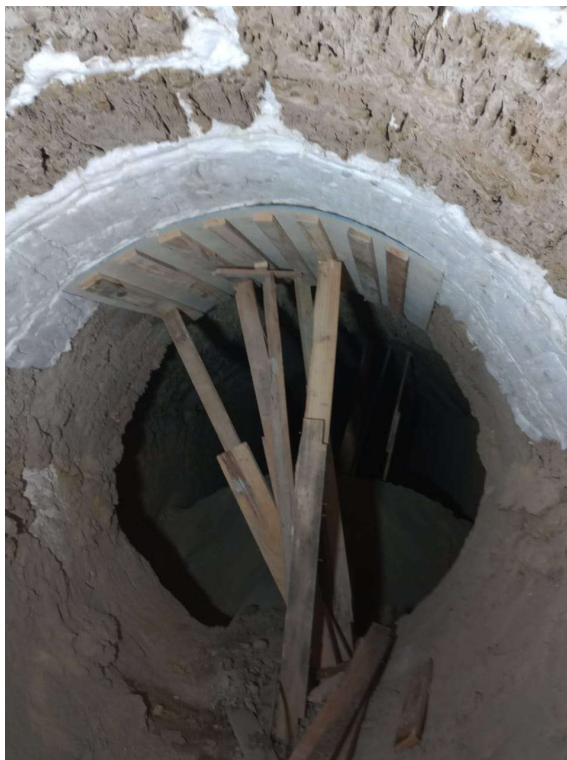
Imagem 05 - Instalação dos módulos na zona de transição.
