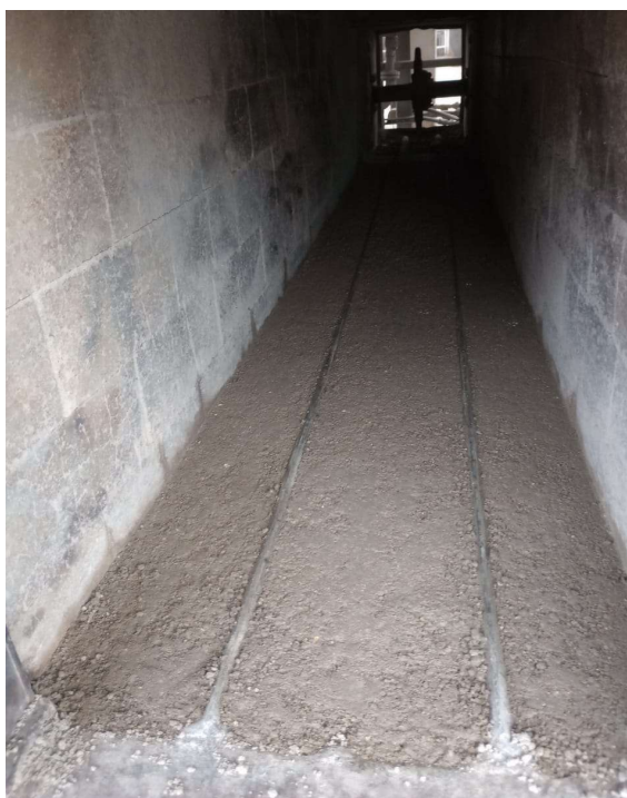
Imagem 11 - Concretagem do trilho do header entre a fornalha e o duto.
