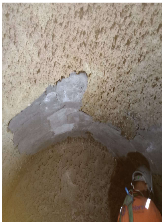
Imagem 09 - Reparo de regiões do teto com perda de espessura com Petrobond 70.
