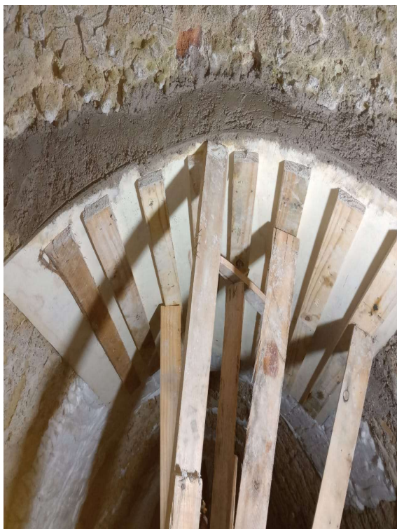
Imagem 04 – Concretagem na junção da zona de transição e Fornalha..
