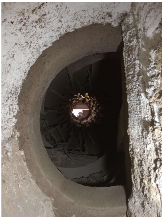
Imagem 02 - Concretagem na região da meia lua na zona de transição.
