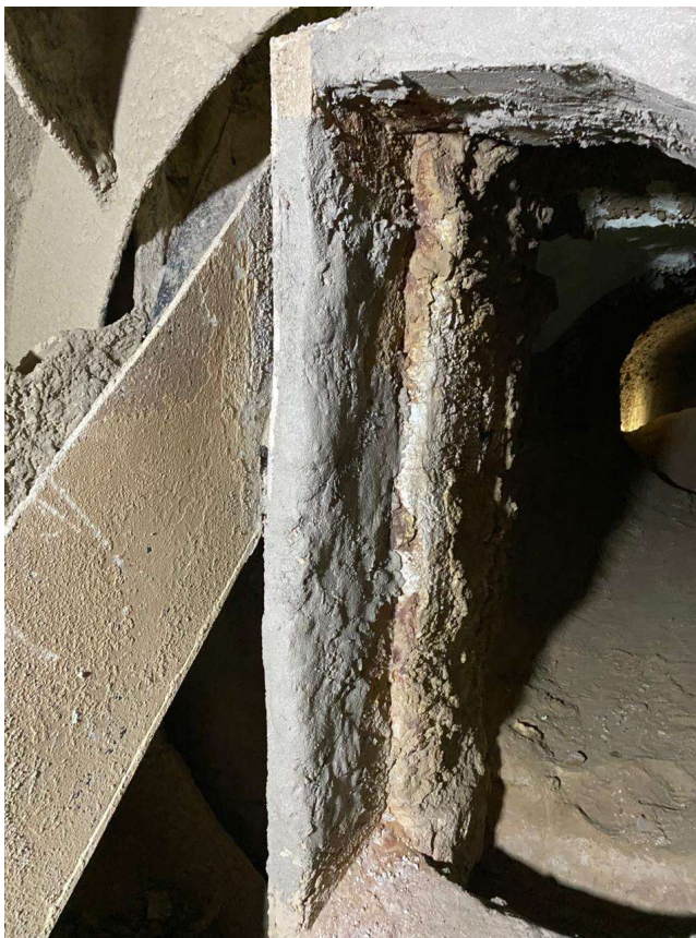
Foto 3: - Concretagem na região da meia lua na zona de transição.
