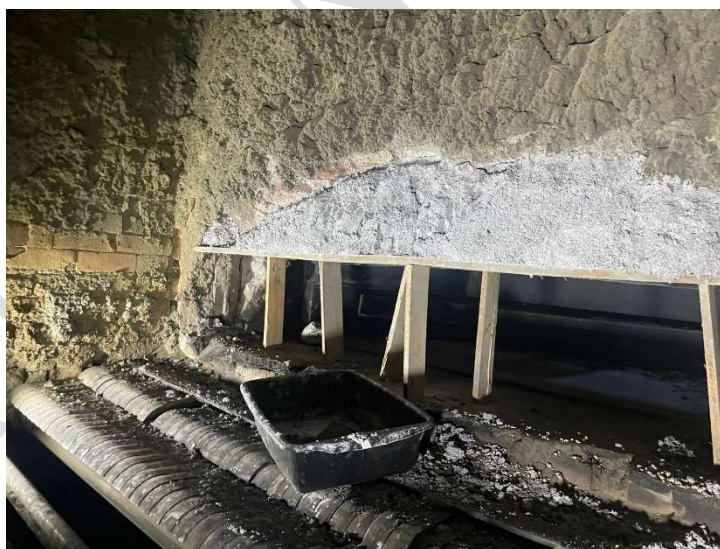
Foto 6: Aplicação de concreto na fornalha.
