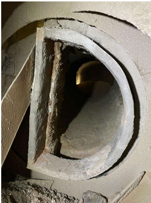
Foto 2: - Concretagem na região da meia lua na zona de transição.
