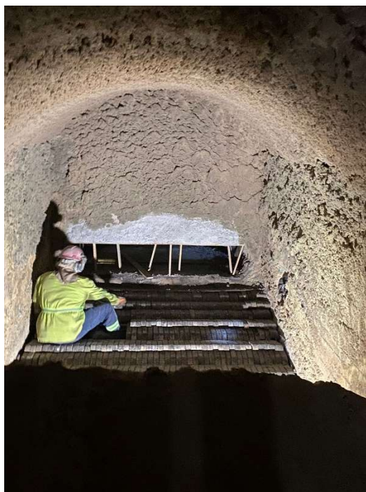
Foto 7: aplicação de concreto thermonbond na fornalha.
