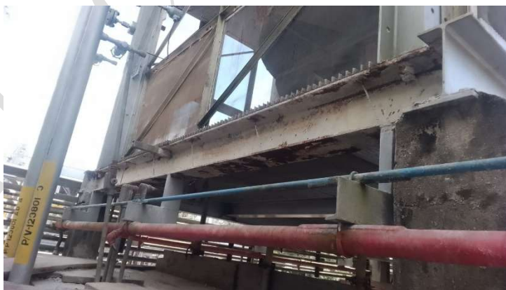
Foto 3: demolição de vigas.
