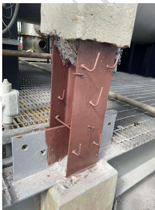
Foto 5: grampos soldados na estrutura.
