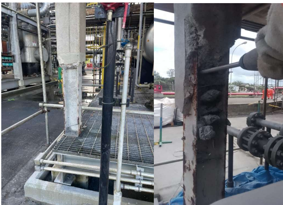
Foto 2: demolição de pilar.
