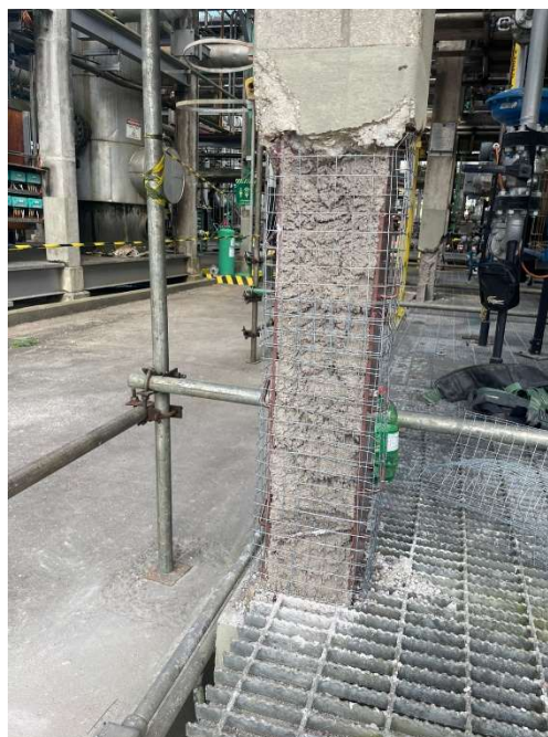
Foto 6: concretagem da alma do pilar
