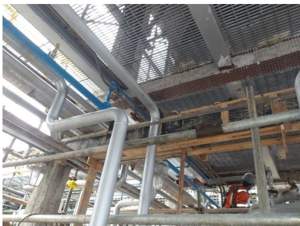
Figura 6 - Concretagem da alma dos elementos estruturais no skid de glicol com instalação da tela de fixação.
