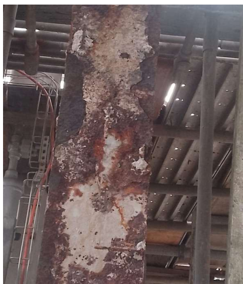
Figura 4 – Perfil de pilar do skid de condensado após demolição do fireproofing existente
