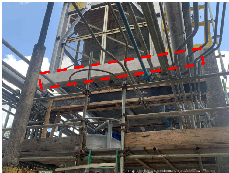
Figura 12 - Elementos estruturais do skid de condensado após concretagem total.
