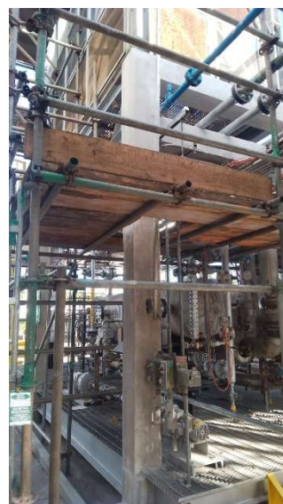
Figura 12 - Elementos estruturais do skid de condensado após concretagem total.
