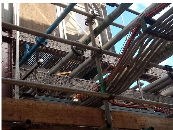
Figura 5 - Concretagem da alma dos elementos estruturais com instalação da tela de fixação no skid de condensado .
