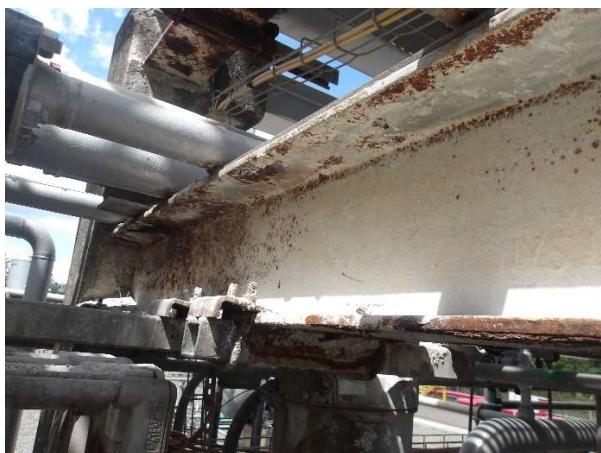
Figura 2 – Perfil no skid de glicol após demolição do fireproofing existente
