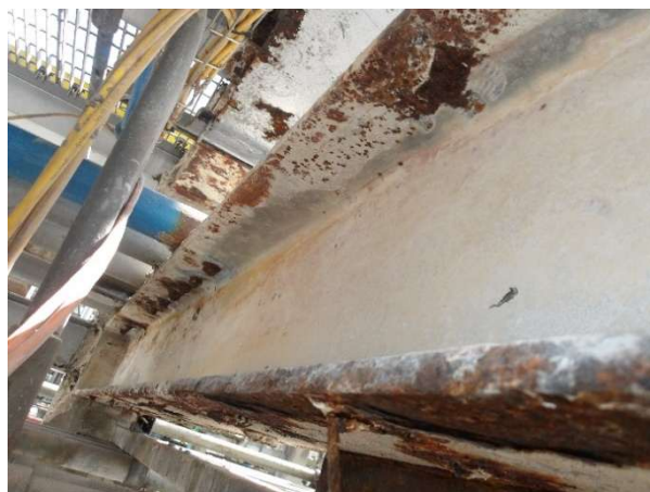
Figura 2 – Perfil no skid de glicol após demolição do fireproofing existente
