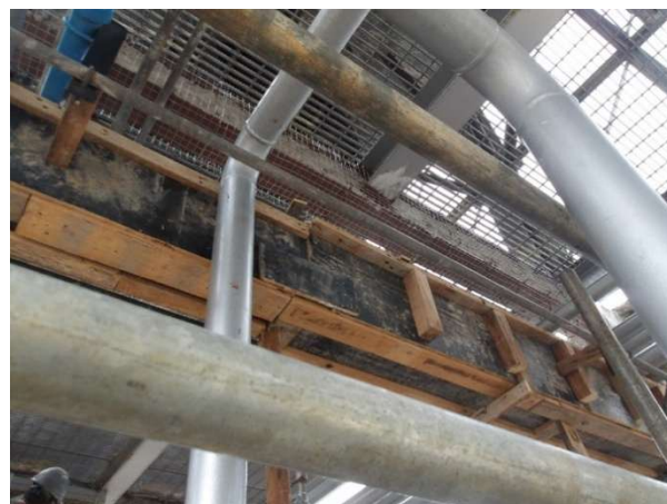
Figura 6 - Concretagem da alma dos elementos estruturais no skid de glicol com instalação da tela de fixação.
