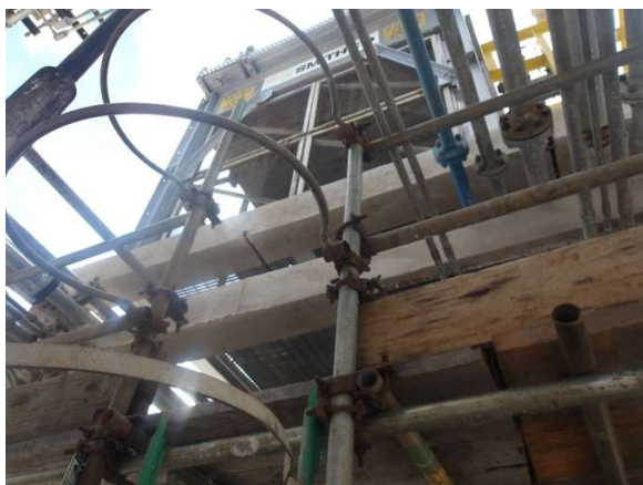
Figura 7 - Elementos estruturais do skid de glicol após concretagem total.
