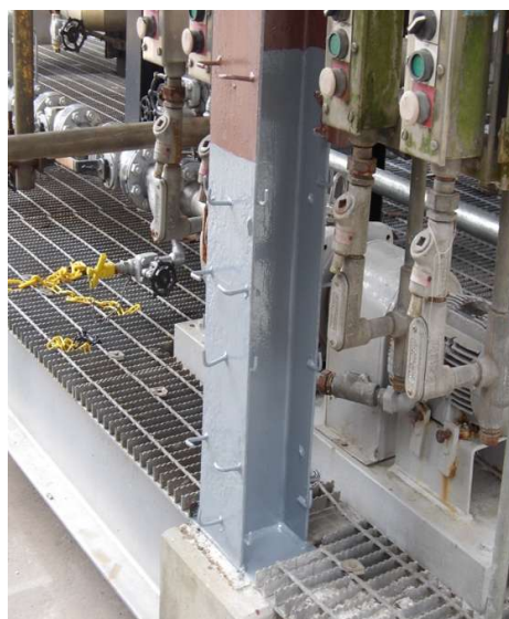
Figura 4 – Perfil de pilar do skid de condensado após demolição do fireproofing existente
