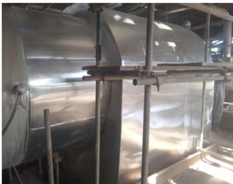
FOTO 06 INSTALAÇÃO DE ISOLAMENTO TÉRMICO NA CAPELA.
