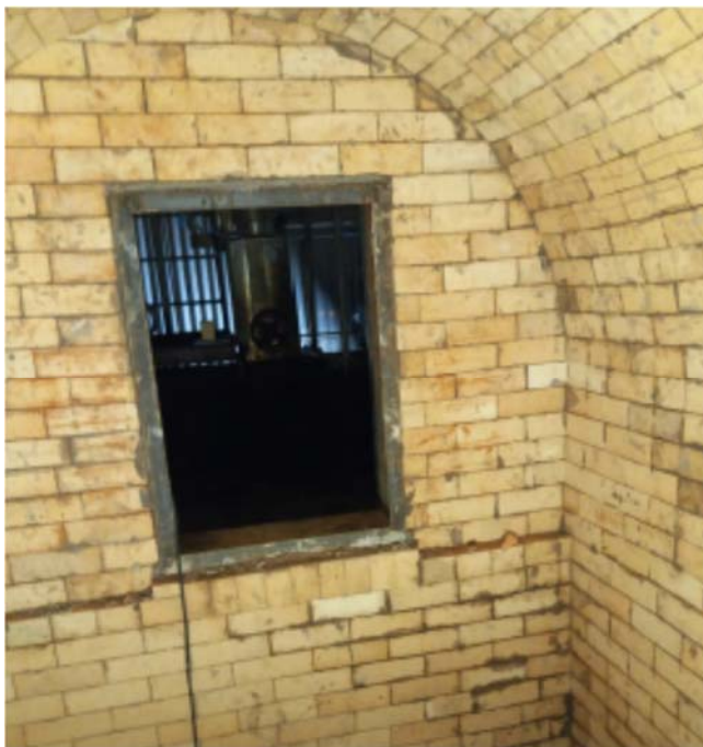
FOTO 01 INSTALAÇÃO DE REVESTIMENTO REFRAATÓRIO NA CAPELA.
