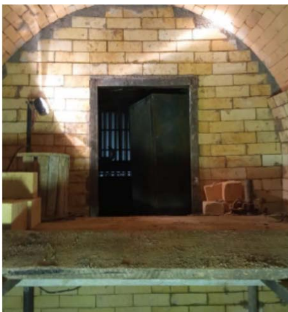
FOTO 03 INSTALAÇÃO DE REVESTIMENTO REFRAATÓRIO NA CAPELA.
