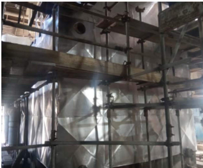
FOTO 05 INSTALAÇÃO DE ISOLAMENTO TÉRMICO NA FORNALHA.
