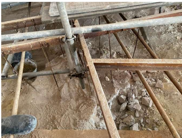
Foto 6: retirada de perlita e material SOP
