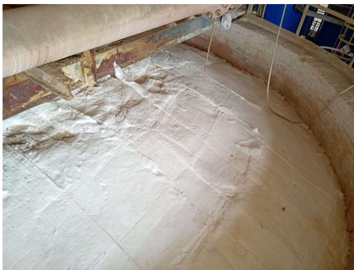
Foto 33: utilização de manta após as camadas de tijolo isolante
