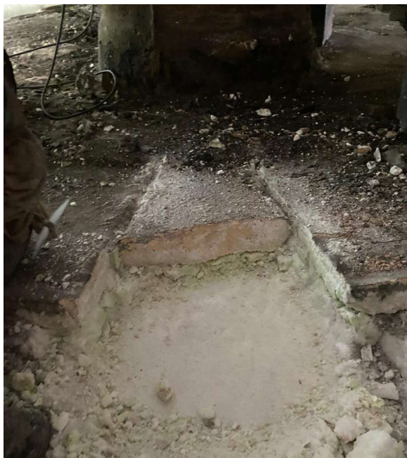
Foto 16: infiltração sob o tijolo C3
