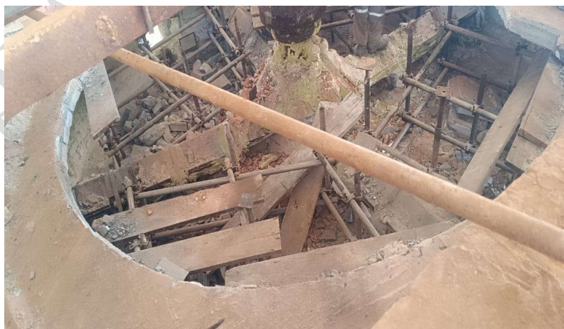
Foto 14: remoção do teto da câmara de reação.
