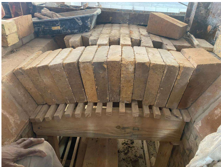
Foto 26: ressalto resultantes na montagem.
