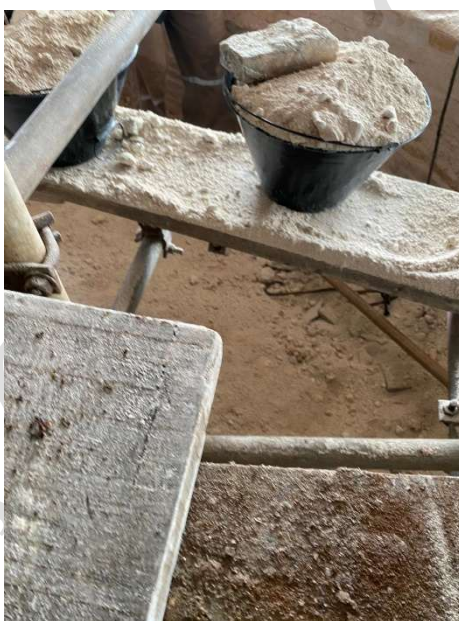
Foto 5: retirada de perlita e material SOP
