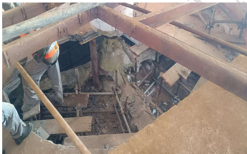
Foto 13: remoção do teto da câmara de reação.
