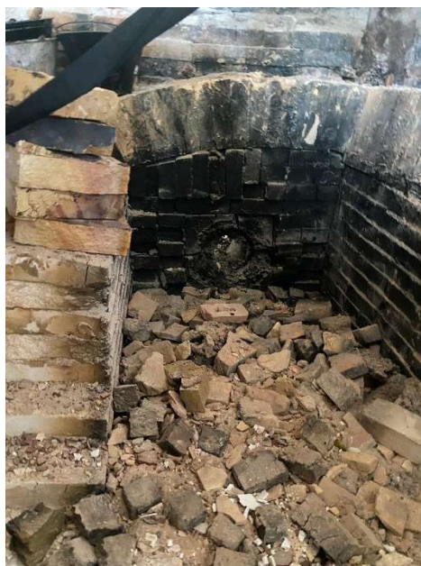
Foto 11: demolição dos queimadores
