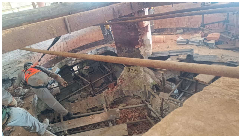
Foto 12: remoção do teto da câmara de reação.
