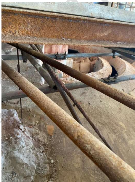
Foto 7: retirada dos tijolos do teto da câmara de combustão
