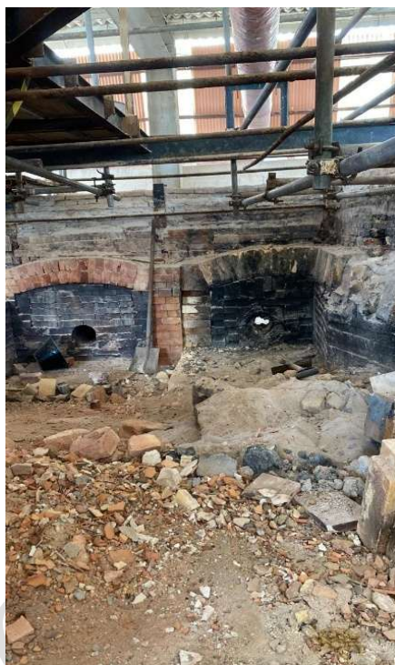
Foto 10: demolição dos queimadores
