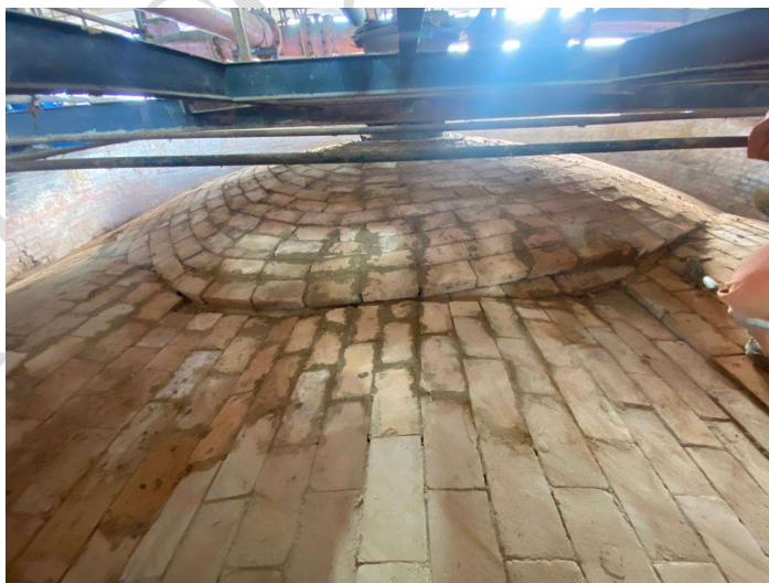
Foto 32: duas camadas de tijolos isolantes sobre câmara de combustão.
