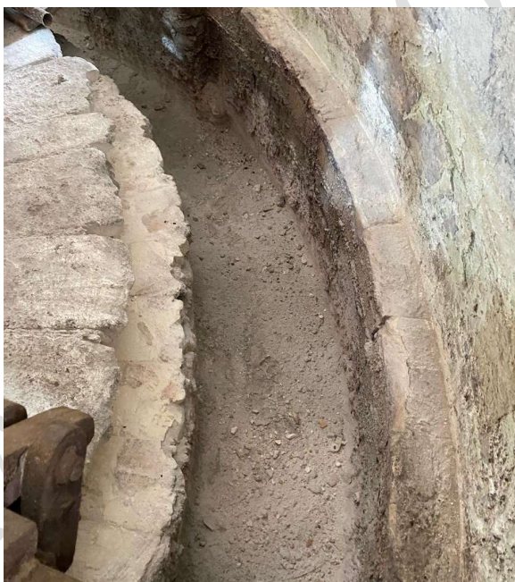
Foto 15: remoção de tijolos do piso da câmara de reação
