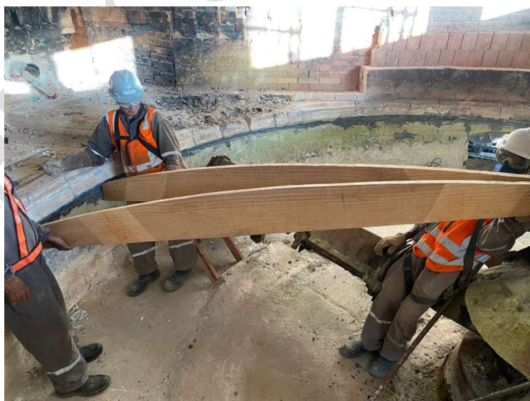
Foto 21: formas do teto da câmara de reação.
