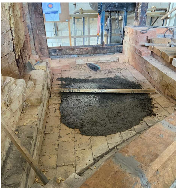
Foto 22: montagem de tijolos dos queimadores.
