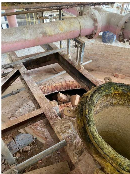
Foto 8: retirada dos tijolos do teto da câmara de combustão
