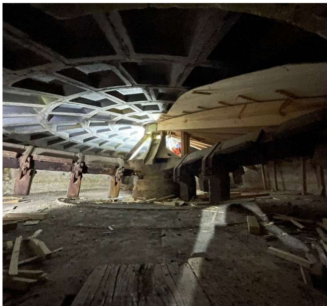
Foto 31: desmontagem da cambota inferior
