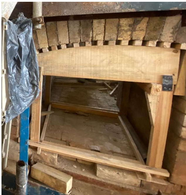
Foto 27: cambota para montagem dos arcos dos queimadores.
