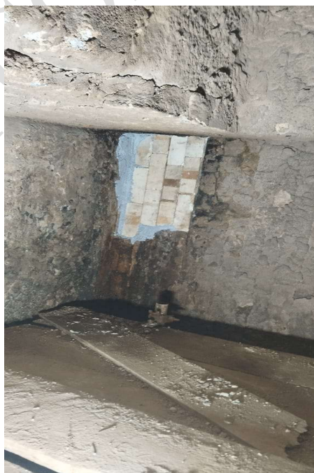
Foto 4: Ponto 3: concretagem na região abaixo da viga da capela.
