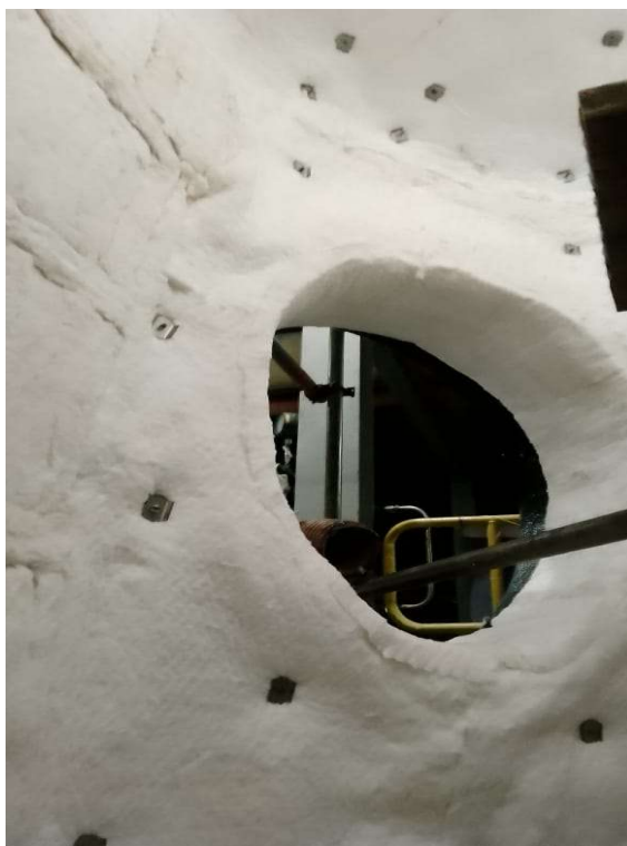
Imagem 12 - Sobreposição de manta em torno da BV
