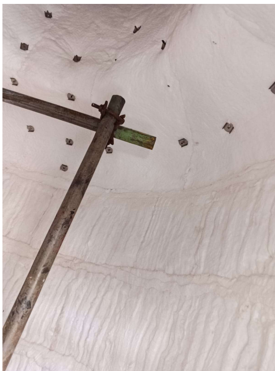
Imagem 10 - Sobreposição de manta na região sobrecabeça.
