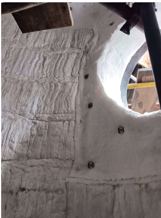
Imagem 13 - Sobreposição de manta em torno da BV
