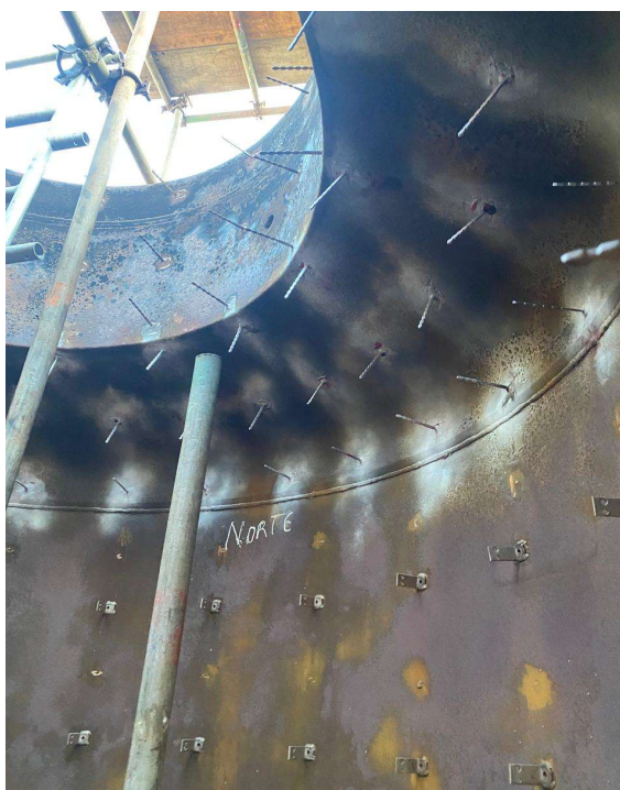
Imagem 5 – Instalação de Pino de ancoragem região da linha de tangência .
