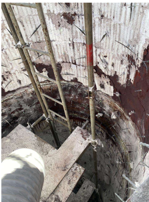
Imagem 1 –Remoção dos Revestimento interno.
