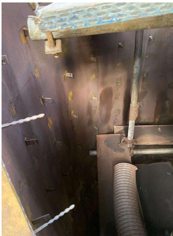
Imagem 4 – Instalação de Pino de ancoragem região do costado.
