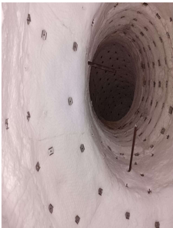
Imagem 9 – Sobreposição de manta na região sobrecabeça.
