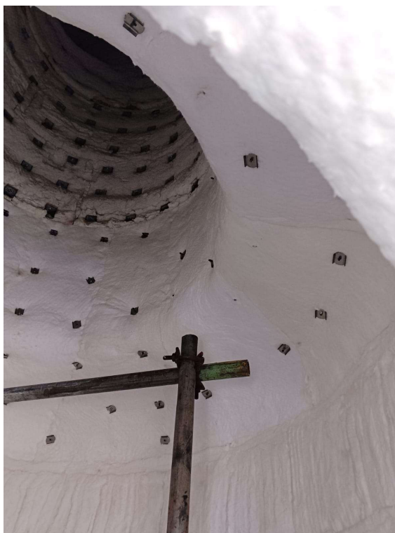
Imagem 11 - Sobreposição de manta na região sobrecabeça..
