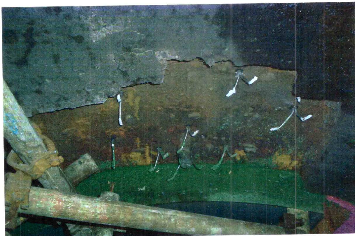
Aplicação do concreto na fôrma
