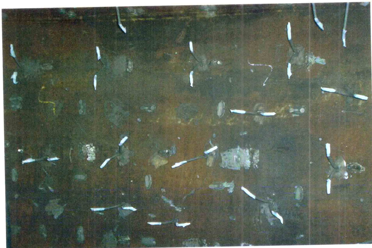
Grampos soldados e isolados com fita
