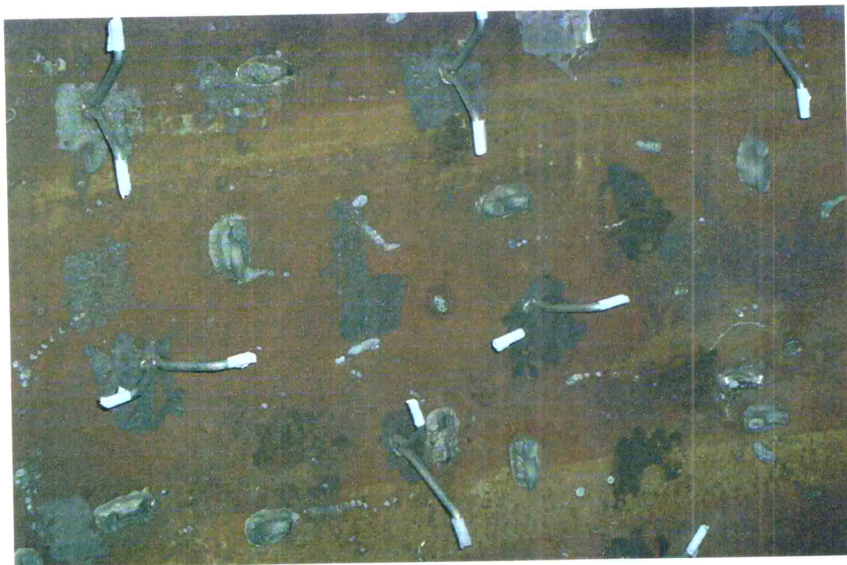
Costado com âncoras soldadas e isoladas
