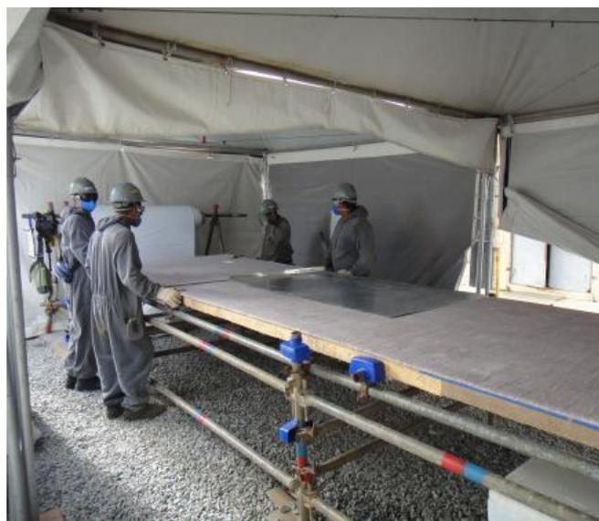
Foto 02: Preparação para corte do Cryogel/Pyrogel.
