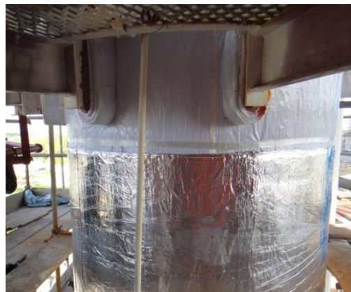
Fotos 09 e 10: Aplicação da barreira de vapor (manta betuminosa aluminizada).
