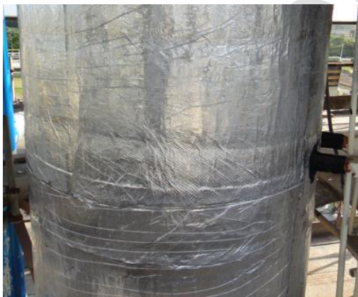
Fotos 09 e 10: Aplicação da barreira de vapor (manta betuminosa aluminizada).
