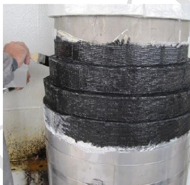
Fotos 13 e 14: Aplicação da Parada de Vapor, composta por tela de poliéster e massa impermeabilizante.
