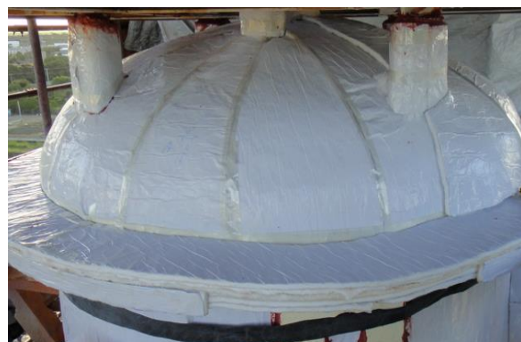
Fotos 05 e 06: Aplicação de Cryogel na calota, fixação utilizando Cola spray e fita filamentosa.
