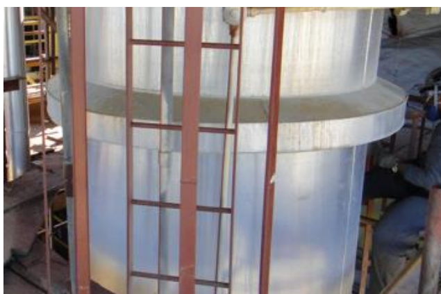
Fotos 19 e 20: Aplicação da Jaqueta de Proteção.
