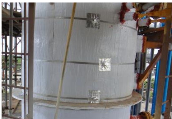
Fotos 11 e 12: Aplicação de camada extra de manta betuminosa nos selos das cintas.
