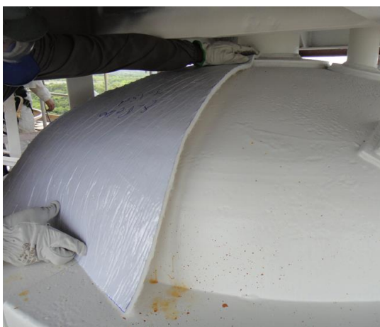
Fotos 03 e 04: Aplicação de Cryogel na calota, fixação utilizando fita filamentosa e cinta de inox.
