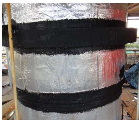
Fotos 17 e 18: Aplicação da Parada de Vapor entre transição de camadas de isolamento e protuberâncias.
