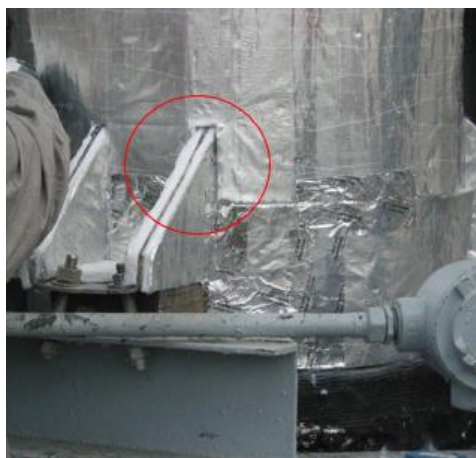
Fotos 15 e 16: Aplicação da Parada de Vapor em geometrias complexas.
