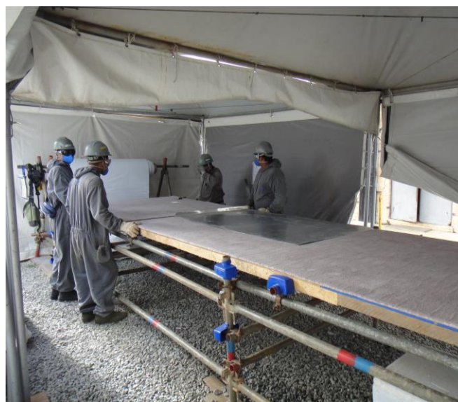
Foto 02: Preparação para corte do Cryogel/Pyrogel.
