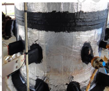
Fotos 17 e 18: Aplicação da Parada de Vapor entre transição de camadas de isolamento e protuberâncias.
