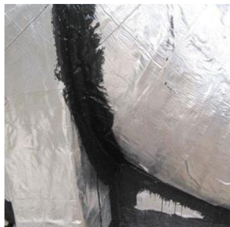
Fotos 15 e 16: Aplicação da Parada de Vapor em geometrias complexas.
