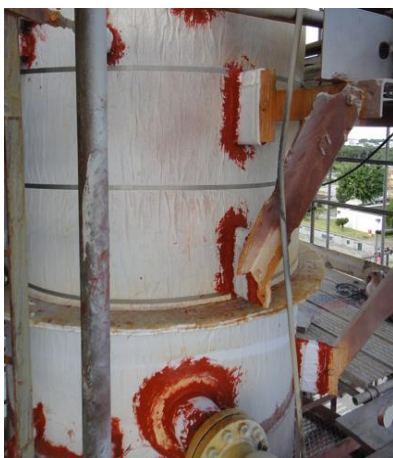
Fotos 07 e 08: Aplicação de silicone de alta temperatura entre o costado e a interseção do equipamento.
