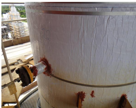
Fotos 07 e 08: Aplicação de silicone de alta temperatura entre o costado e a interseção do equipamento.
