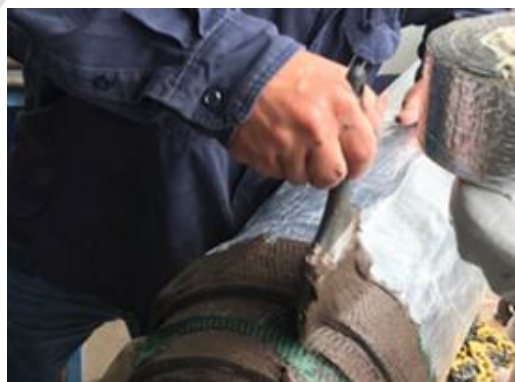
Fotos 13 e 14: Aplicação da Parada de Vapor, composta por tela de poliéster e massa impermeabilizante.
