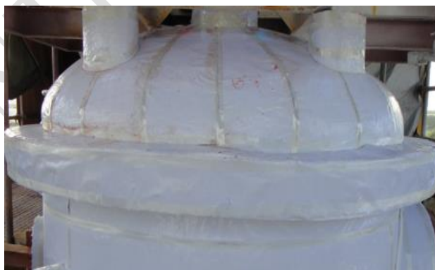
Fotos 05 e 06: Aplicação de Cryogel na calota, fixação utilizando Cola spray e fita filamentosa.
